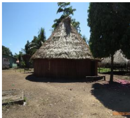
Figura 11.1 – 68 - Construção finalizada da Casa Cultural realizada pelos indígenas Waiwai e a população da TI Arara.
