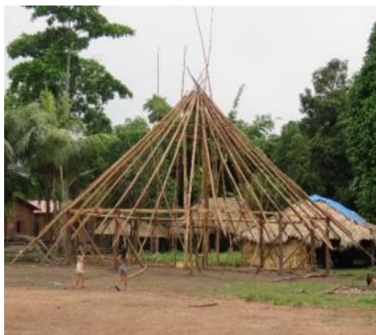
Figura 11.1 – 67 - Casa Cultural em construção em conjunto com os indígenas Arara do Laranjal e os Waiwai.
