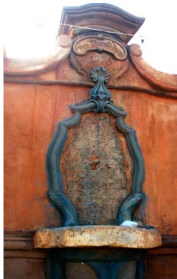
Foto 5.3-6 – Detalhe do Chafariz da Traiana, Paracatu, MG
