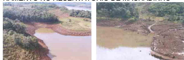
FOTO 3 - ASPECTO DAS MARGENS COM DEPLECIONAMENTO NO RESERVATÓRIO DE MACHADINHO
