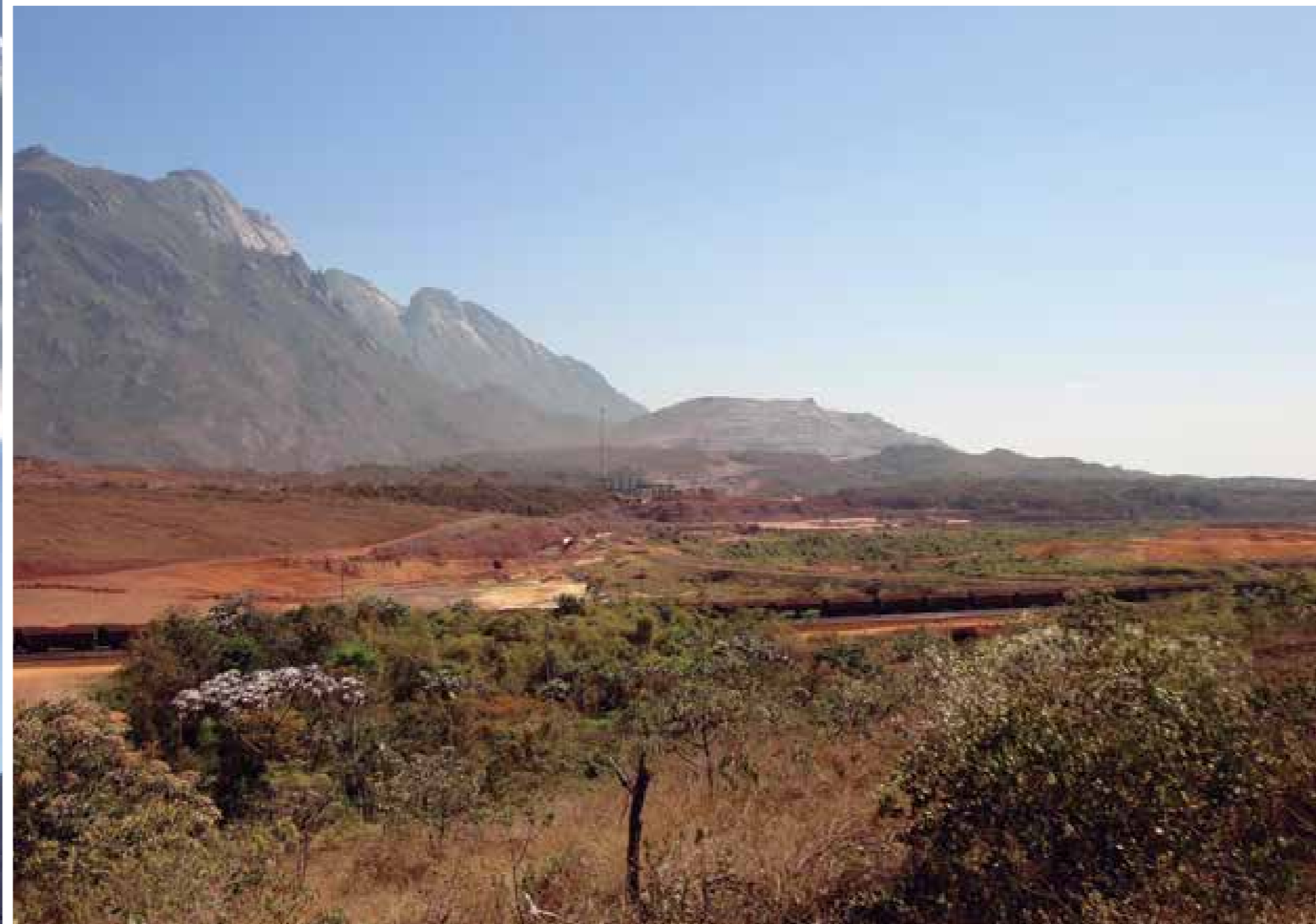
Figura 21: Vista parcial da estrada de ferro (EFVM) próxima da estação de Fazendão e trevo da mina de Fazendão.
