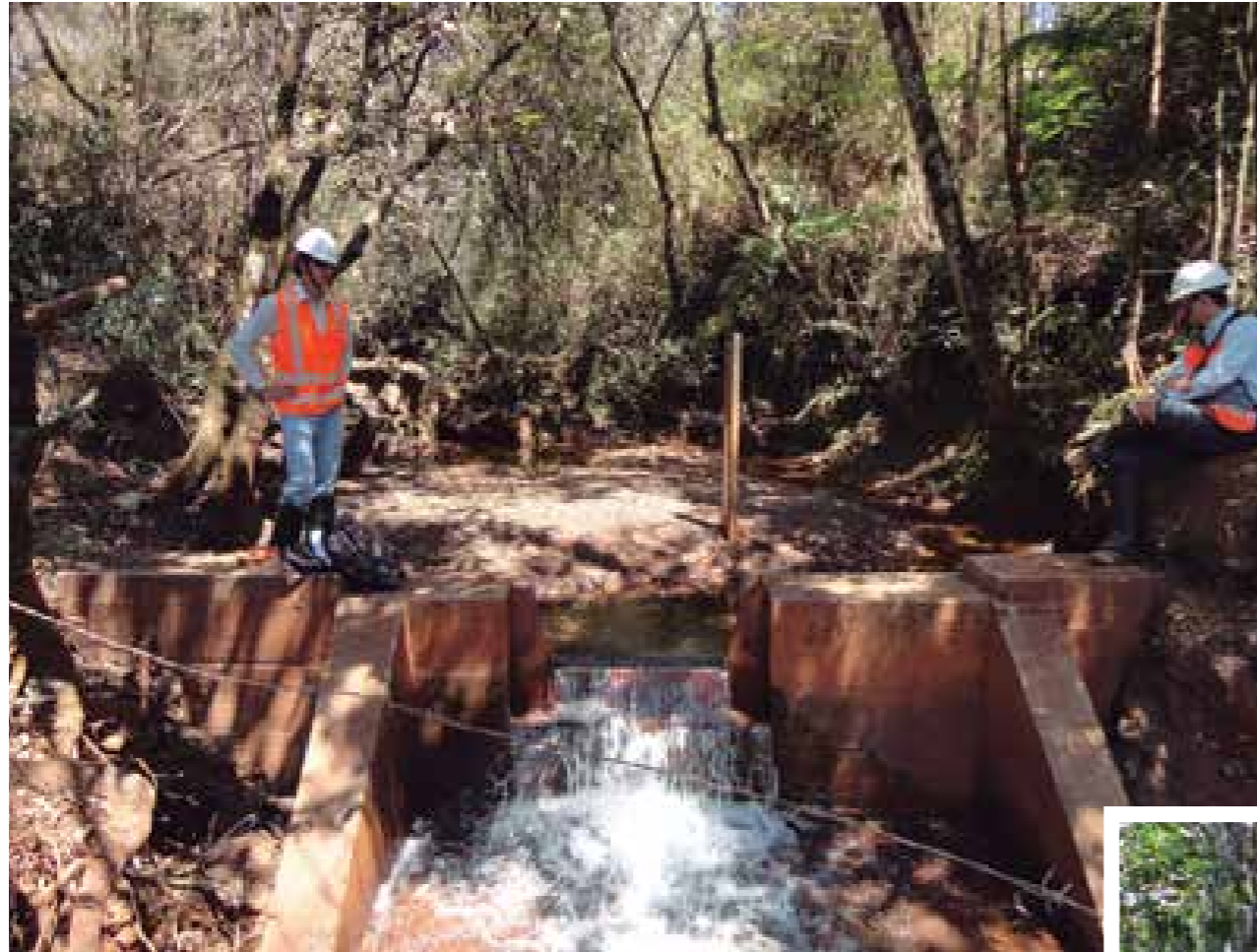
Figura 23: Ribeirão dos Coqueiros – Vertedouro de monitoramento fluviométrico com reservatório assoreado
