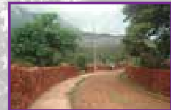
Rua Senhor do Bonfim - muros de cangas (Morro da Água Quente)
