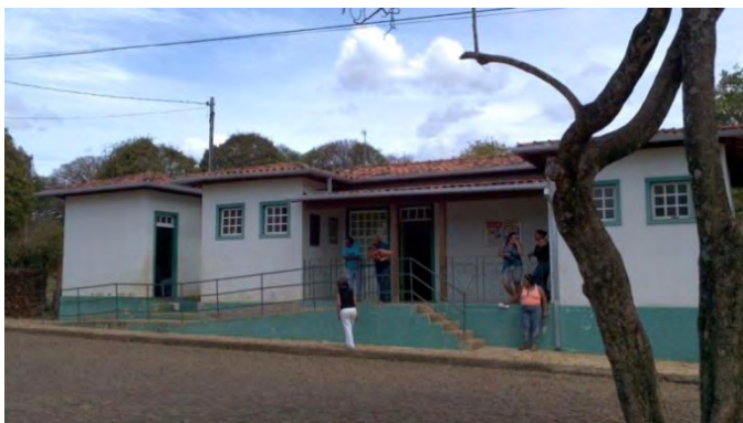
Figura 9.186: Posto de Saúde do Bairro de Morro da Água Quente. Fonte: Golder Associates, 2012.
