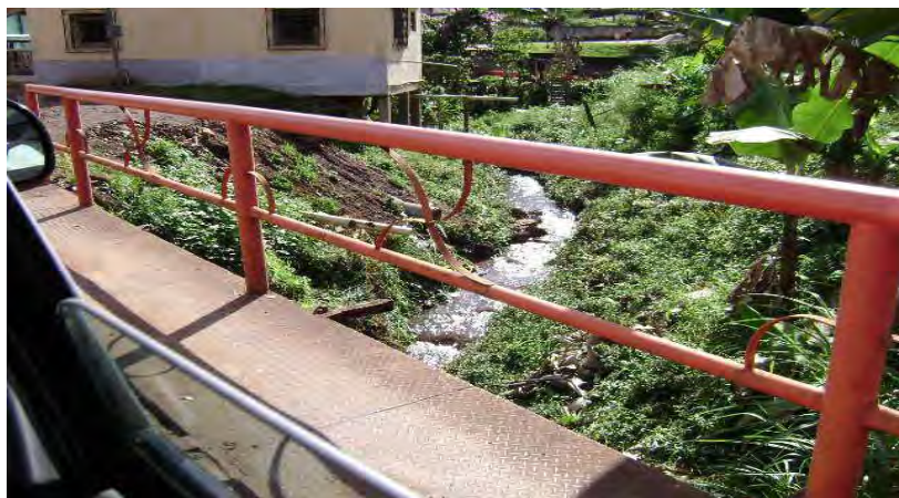
Figura 9.196: Lançamento de esgoto sem tratamento em curso de água no distrito de Santa Rita Durão, Mariana, MG. Fonte: Golder Associates, 2010.
