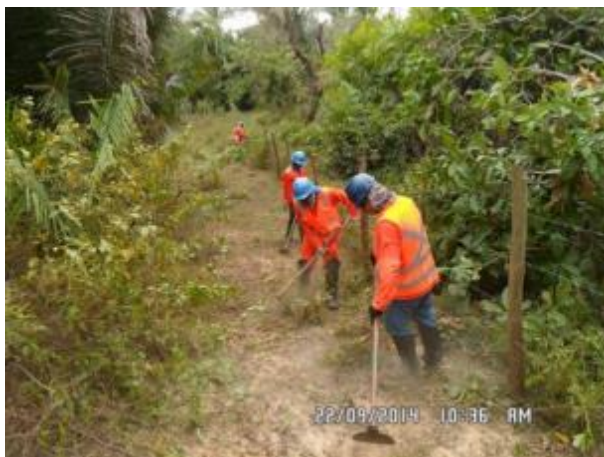
Foto 4-1: Atividade de manutenção das cercas e aceiros, bem como capina manual.
