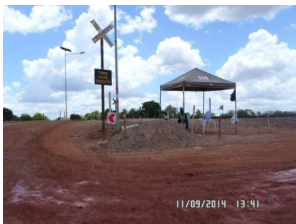
Foto 3-3: Visita à obra do viaduto do km 088+568
