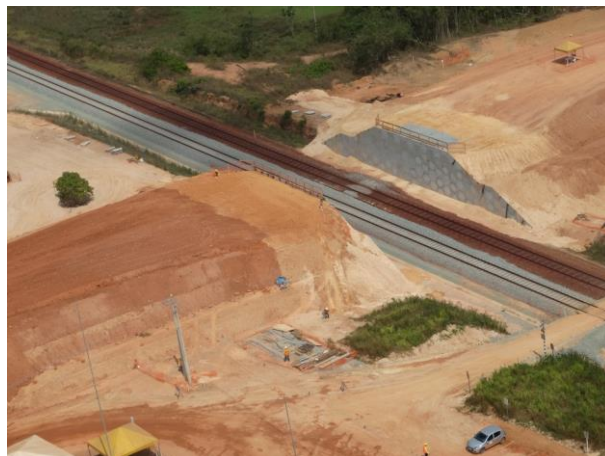
Foto 3-8: Visita à obra do viaduto do km 740+690
