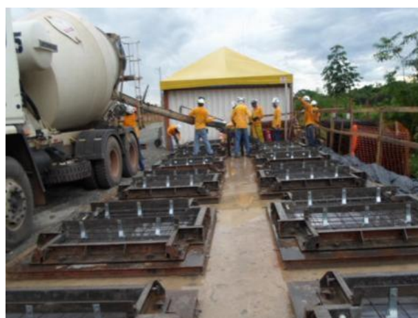
Foto 3-6: Visita à obra do viaduto do km 72+320
