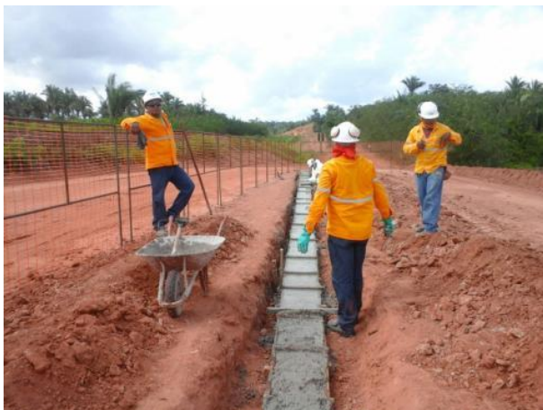
Foto 3-7: Visita à obra do viaduto do km 238+660
