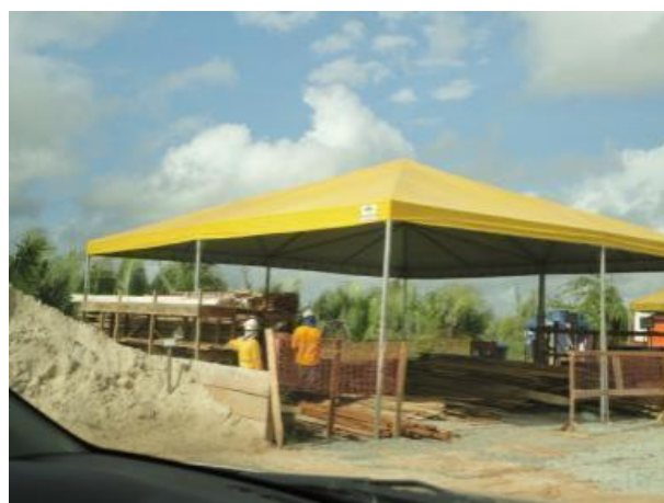
Foto 3-4: Visita à obra do viaduto do km 186+330
