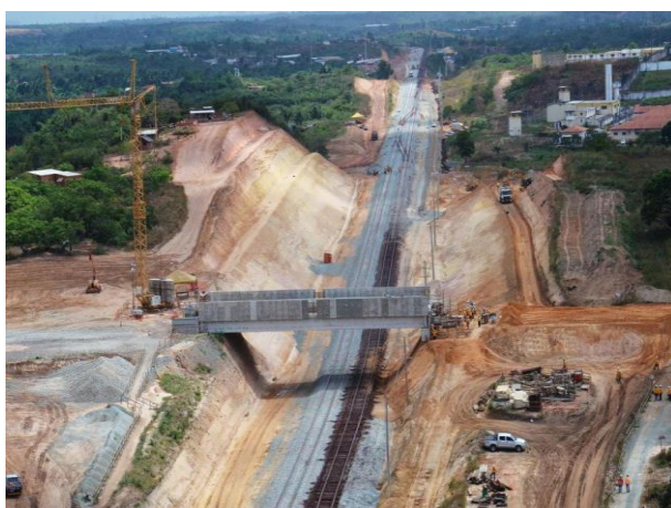
Foto 3-1: Visita à obra do viaduto do km 08+020
