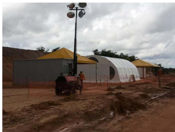
Foto 3-2: Visita à obra do viaduto do km 16+420
