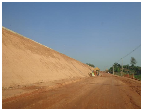
Foto 2-42: Talude construído conforme inclinação projetada (Loc 47).
