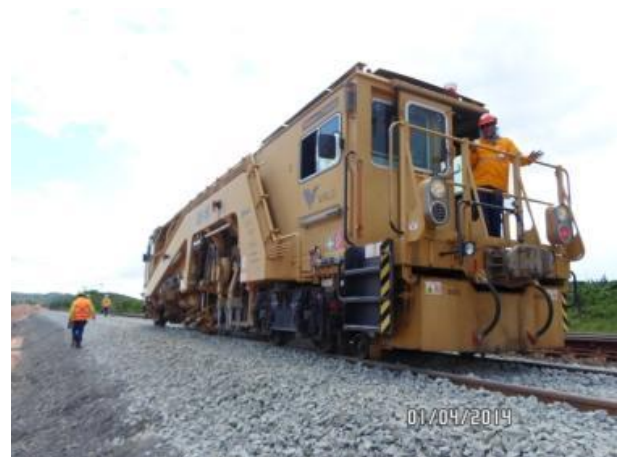
Foto 2-23: Atividade de socagem do lastro de brita (Loc 36).
