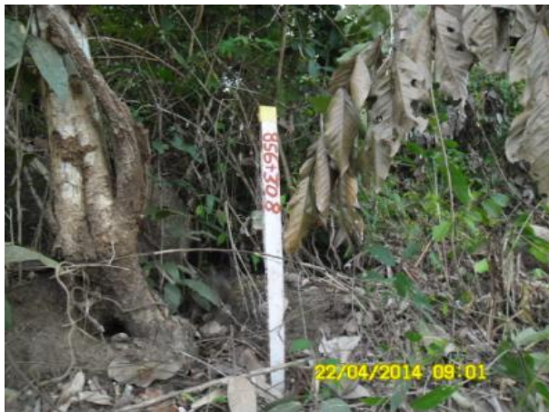
Foto 2-1: Execução de demarcações físicas para posterior atividade de supressão vegetal (Loc 53).
