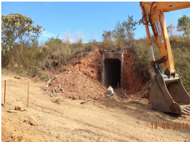
Foto 2-7: Quebra de alas para futura atividade de prolongamento do BSCC (Loc 33)
