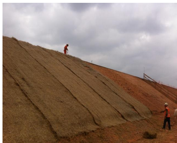
Foto 2-46: Instalação de biomanta em talude conformado para futura revegetação (Loc 47).
