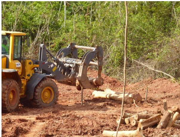
Foto 2-62: Empilhamento mecanizado do material lenhoso para seu armazenamento no pátio de estocagem (Loc 0-2).
