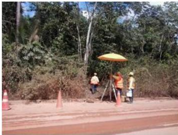
Foto 2-54: Topógrafos realizando delimitações à atividade de supressão vegetal (Loc 48).
