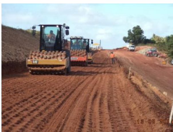
Foto 2-5: Compactação de solo ao eixo ferroviário a ser duplicado (Loc 0-2).
