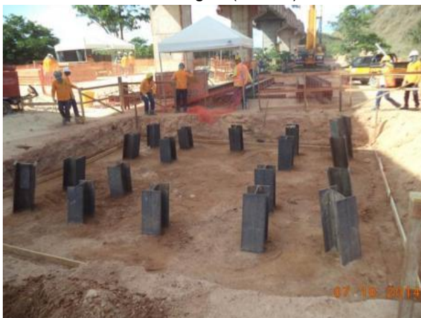
Foto 2-15: Estacas da ponte ferroviária Buriticupu (Loc 22).
