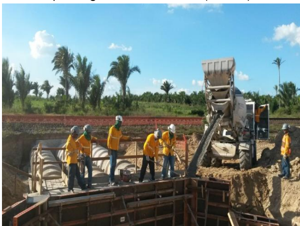
Foto 2-9: Atividade de concretagem da ala do BTTC (Loc 13).
