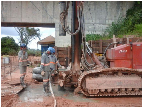
Foto 2-13: Cravação de estacas – ponte ferroviária Olho d’Água (Loc 14).
