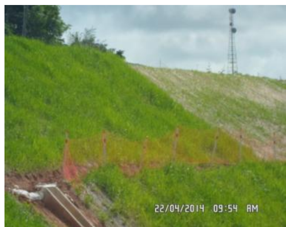
Foto 2-51: Talude em regeneração avançada após aplicação de biomanta (Loc 48).
