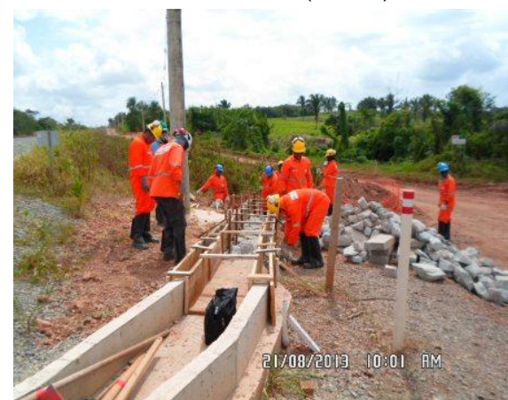
Foto 2-49: Construção de saídas d'água composta por dissipador de energia (Loc 07).
