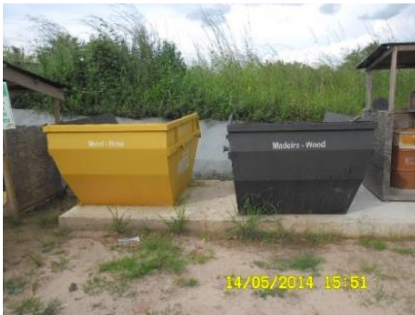
Foto 2-26: Caçambas coletoras identificadas utilizadas nas frentes de obra ao posterior recolhimento por meio de caminhão poliguindaste (Loc 14).
