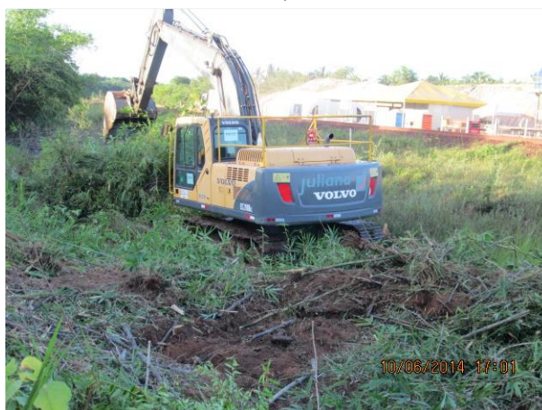
Foto 2-58: Limpeza de sub-bosque; remoção do topsoil para posterior armazenamento (Loc 0-2).
