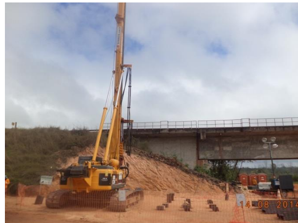
Foto 2-14: Cravação de estacas – ponte ferroviária Pindaré (Loc 25).
