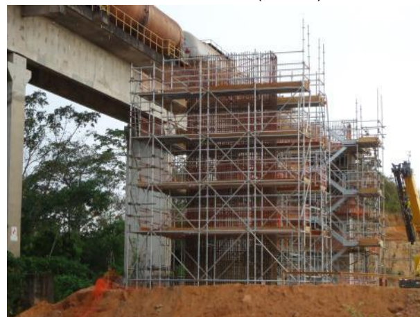
Foto 2-16: Armação do Pilar 04 da ponte ferroviária Presa de Porco (Loc 20).
