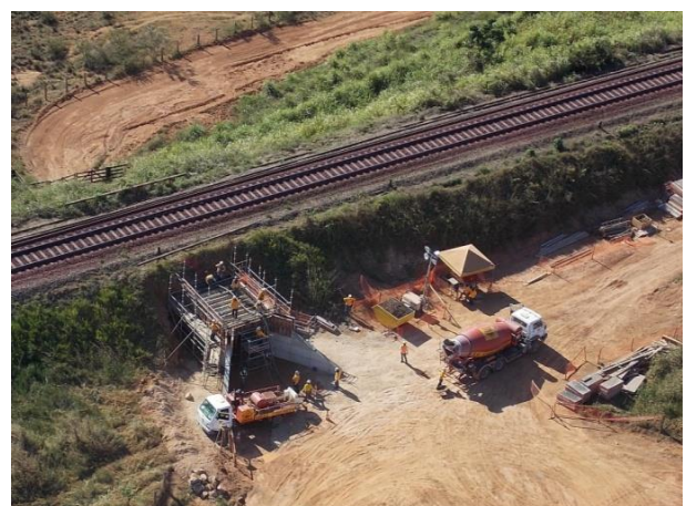
Foto 2-12: Passagem de Veículo em construção (Loc 53).
