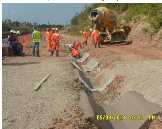
Foto 2-48: Construção de sistema de drenagem pluvial (Loc 07).
