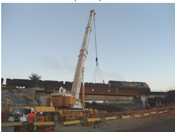
Foto 2-17: Içamento de vigas no viaduto ferroviário PA150 (Loc 47).
