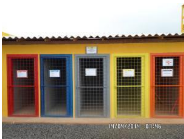
Foto 2-24: Depósito Intermediário de Resíduos (DIR) com identificações ao armazenamento temporário segregado (Loc 33).
