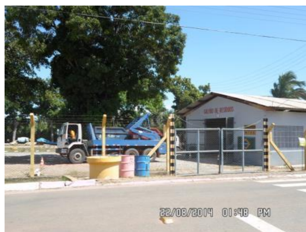
Foto 2-33: Central de Materiais Descartáveis (CMD) de Santa Inês.
