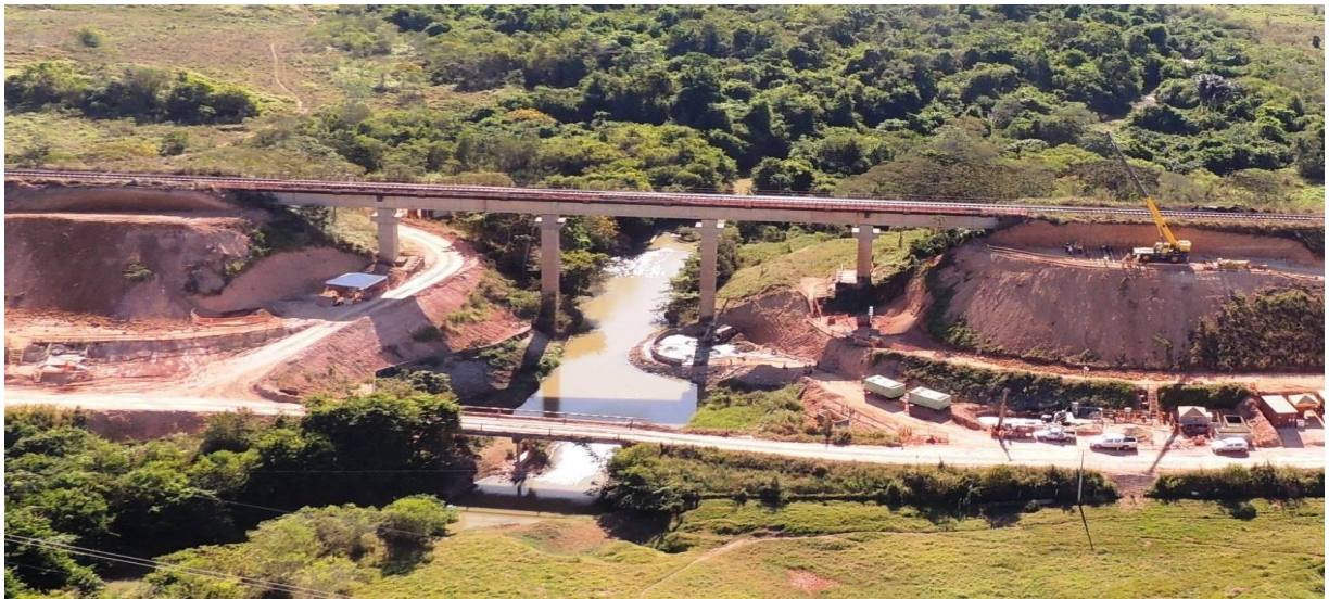
Foto 2-19: Vista geral da construção da ponte ferroviária Castanhas (Loc 53).
