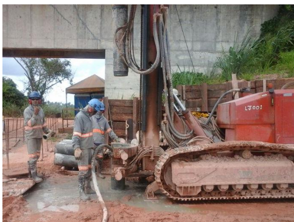
Foto 2-38: Atividade de perfuração de estaca raiz com auxílio de água como fluido (Loc 48).
