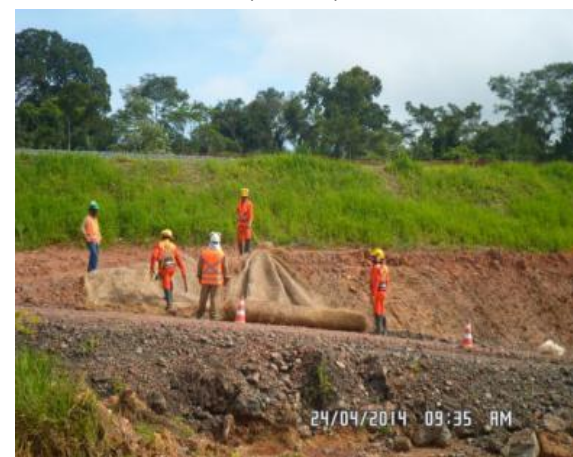
Foto 2-47: Instalação de biomanta em talude de corte em acesso (Loc 48).
