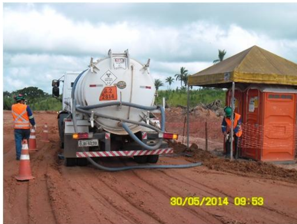
Foto 2-34: Atividade de recolhimento do lodo sanitário na fonte geradora (Loc 13).
