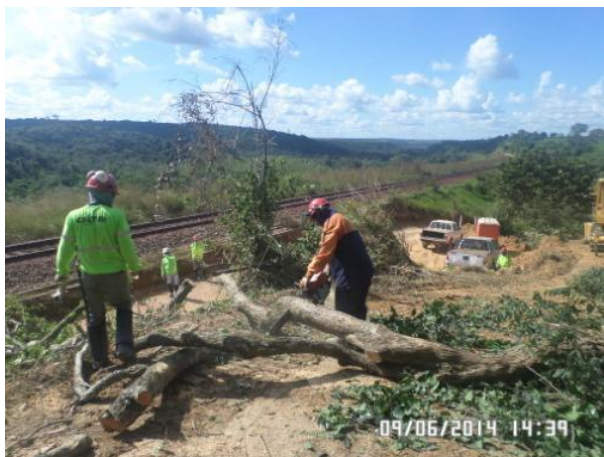
Foto 2-3: Seccionamento de indivíduos arbóreos com DAP acima de 15 centímetros (Loc 25).
