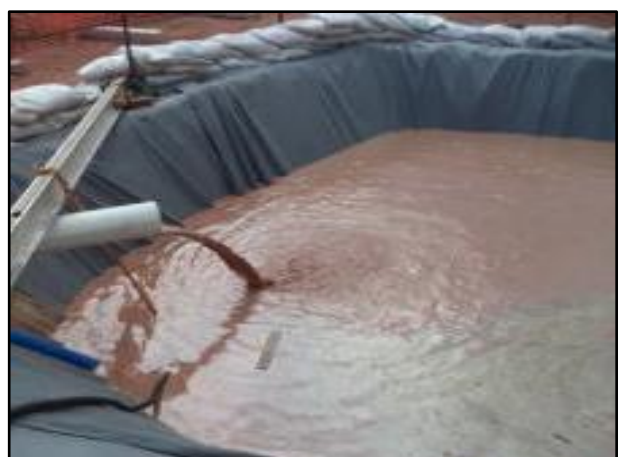
Foto 2-39: Bacia de decantação aos sólidos carregados pela atividade de perfuração para posterior reutilização nas demais perfurações.
