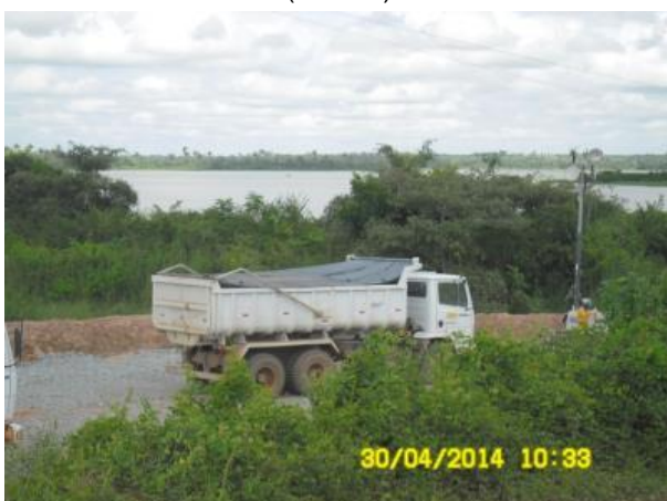
Foto 2-72: Enlonamento/cobrimento das cargas de solo necessárias à terraplanagem (Loc 14).
