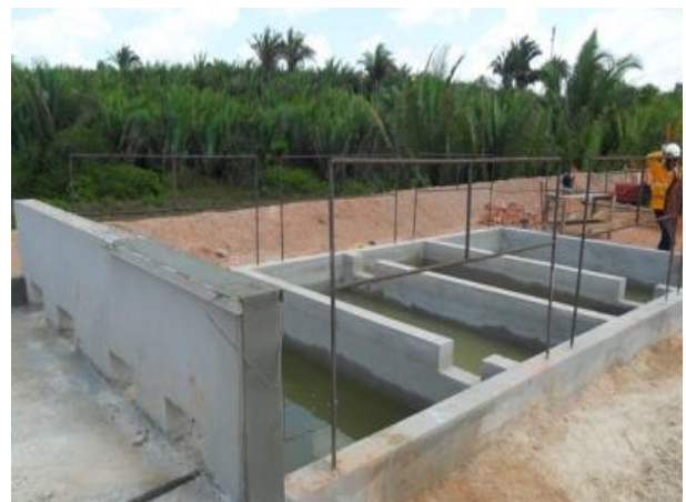
Foto 2-37: Tanques de decantação ainda em construção como sistema de controle às centrais dosadoras de concreto (Loc 15).
