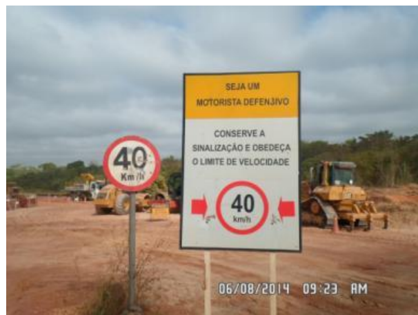
Foto 2-75: Sinalização de velocidade ao tráfego da obra nas frentes de obras (Loc 48).
