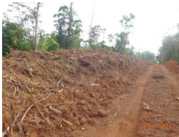
Foto 2-67: Topsoil armazenado temporariamente em leiras de 1,5m de altura (Loc 30).
