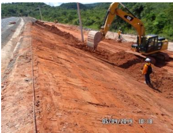
Foto 2-40: Escavadeira realizando atendimento geotécnico quanto inclinação ao talude (Loc 36).
