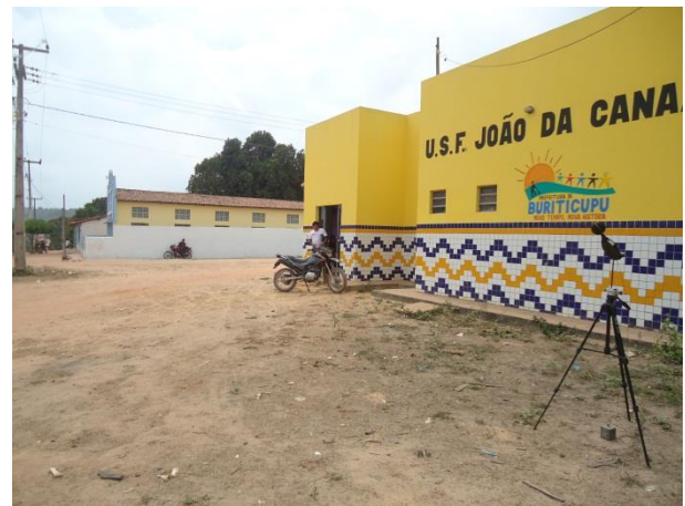
Foto 2-77: Monitoramento ao lado da unidade de saúde; Locação 21 – Povoado Presa de Porco (Buriticupu/MA).
