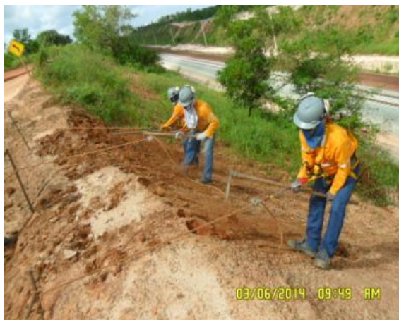
Foto 2-44: Atividade coveamento para posterior aplicação de hidrossemeadura em talude (Loc 0-2).
