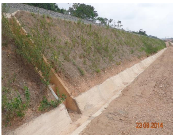
Foto 2-50: Talude provido de sistema de drenagem pluvial e com talude em processo de revegetação (Loc 0-2).
