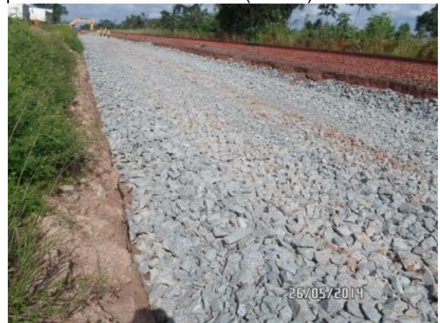
Foto 2-21: Aplicação de camada de rachão para formação do lastro (Loc 07),
