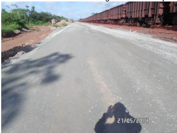
Foto 2-20: Aplicação de camada de bica corrida para formação do sublastro (Loc 07).
