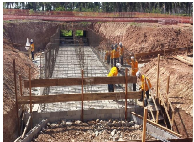
Foto 2-8: Início da armação de laje de fundo do BDCC a ser prolongado (Loc 11).
