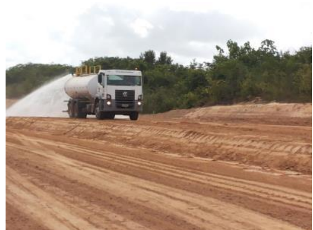
Foto 2-71: Umectação das frentes de obra (Loc 07).
