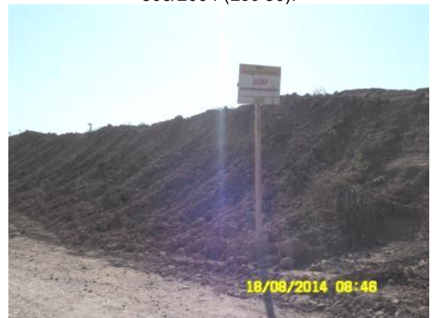
Foto 2-29: Topsoil enleirado em área identificada (Loc 53).
