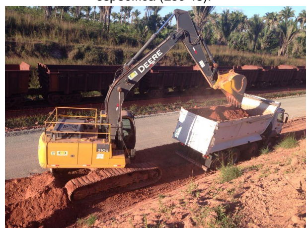
Foto 2-6: Escavação de solo (Loc 15).
