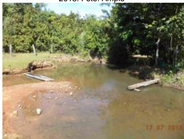
Foto 512: Jusante da travessia 265 em julho de 2013. Foto: Amplo
