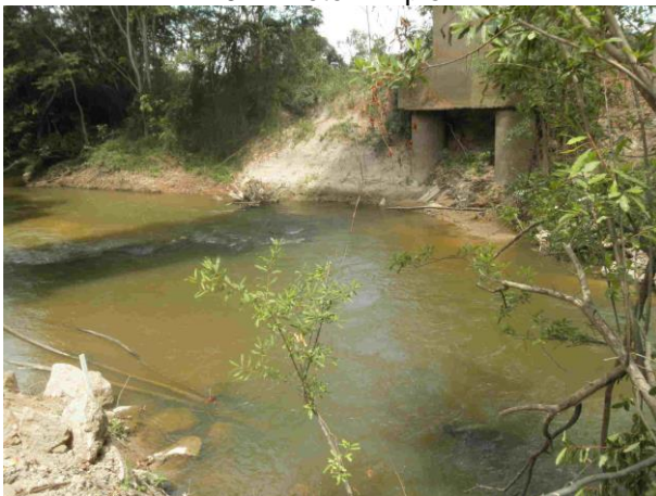
Foto 504: Montante da travessia 260 em julho de 2014. Foto: Amplo
