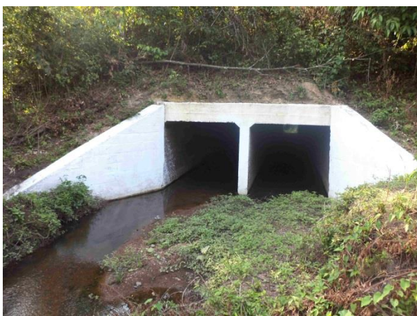
Foto 560: Montante da travessia 281 em outubro de 2013. Foto: Amplo
