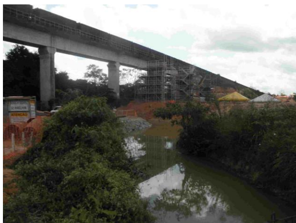
Foto 324: Detalhe da área a ser instalada a ponte ferroviária Presa de Porco, julho de 2014. Foto: Amplo
