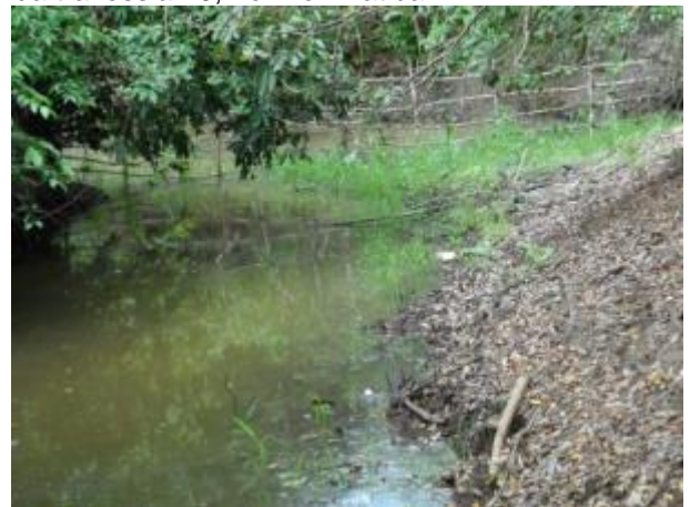
Foto 13: Jusante da travessia 19 em janeiro/13. Foto: Ampla
