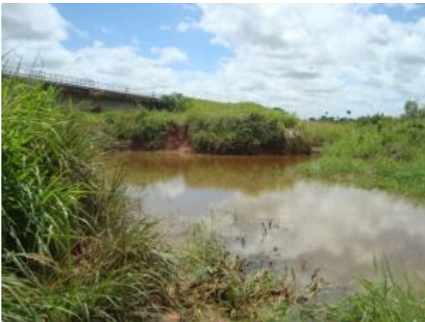
Foto 72: Montante da travessia 60 em abril de 2013. Foto: Amplo
