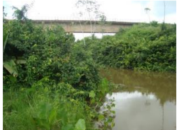
Foto 475: Jusante da travessia 252 em janeiro de 2013. Foto: Amplo
