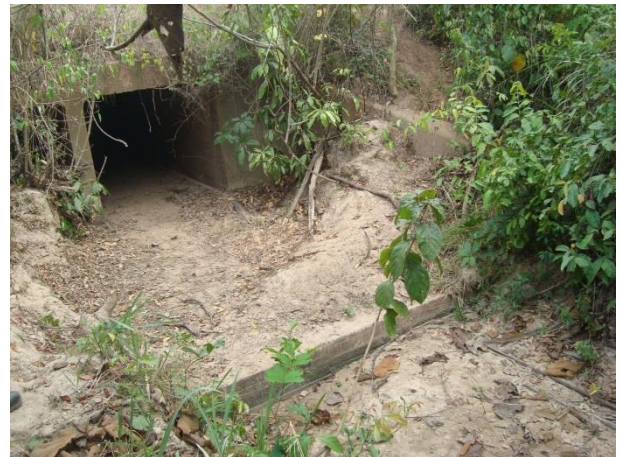
Foto 43: Jusante da travessia 40, no afluente do rio Araguaia, em outubro/13. Foto: Ampla
