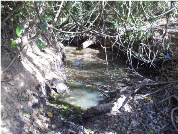
Foto 19: Montante da travessia 19 em outubro de 2013. Foto: Amplo
