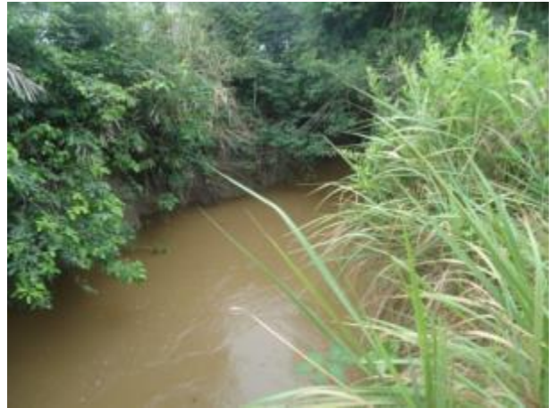
Foto 257: Jusante da Travessia 112 em abril de 2013. Foto: Amplo
