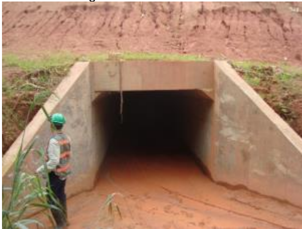
Foto 386: Montante da travessia 175, em janeiro de 2013. Foto: Ampla
