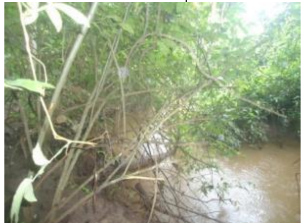
Foto 557: Jusante da travessia 281 em abril de 2013. Foto: Amplo
