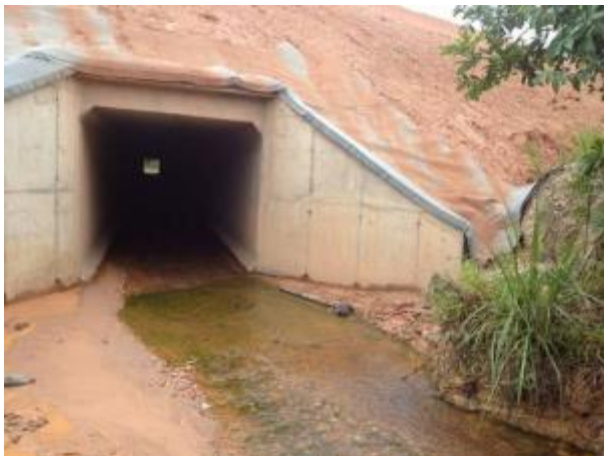
Foto 578: Montante da travessia 286 em janeiro de 2013. Foto: Amplo
