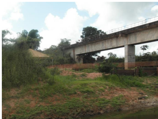
Foto 192: Área de apoio às obras de duplicação da ponte ferroviária Olho d'água dos Carneiros; travessia 83 em julho de 2014. Foto: Ampla
