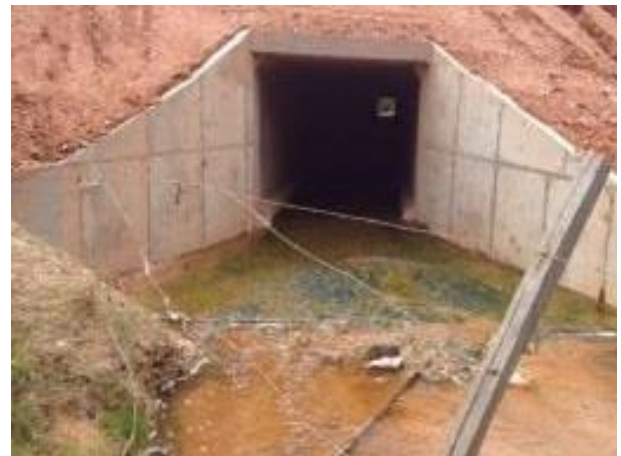
Foto 579: Jusante da travessia 286 em janeiro de 2013. Foto: Amplo
