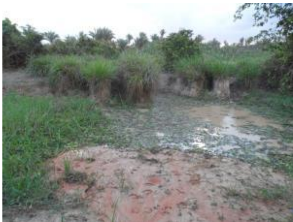
Foto 208: Montante da travessia 96 em janeiro de 2013. Foto: Ampla
