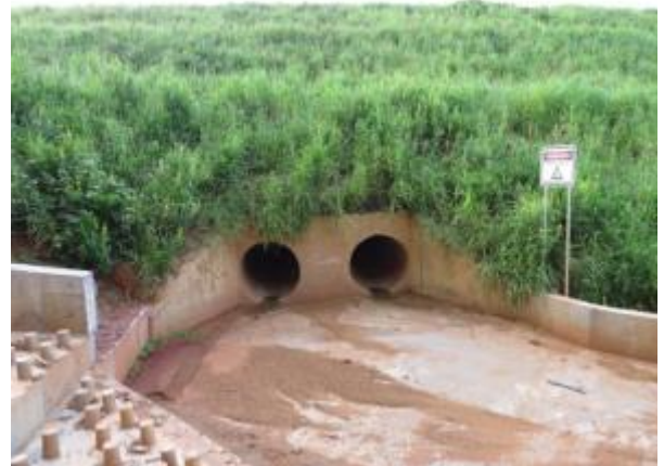
Foto 395: Montante da travessia 177, em abril de 2013. Foto: Ampla
