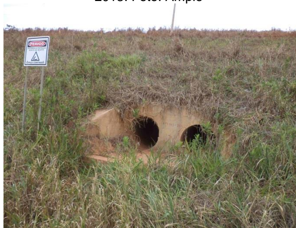
Foto 393: Montante da travessia 176, em outubro de 2013. Foto: Amplo
