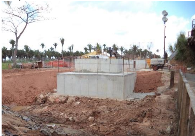
Foto 167: Detalhe das obras a montante da travessia 77, (construção do bloco ao pilar estrutural da ponte ferroviária Bacia 814). Foto: Ampla
