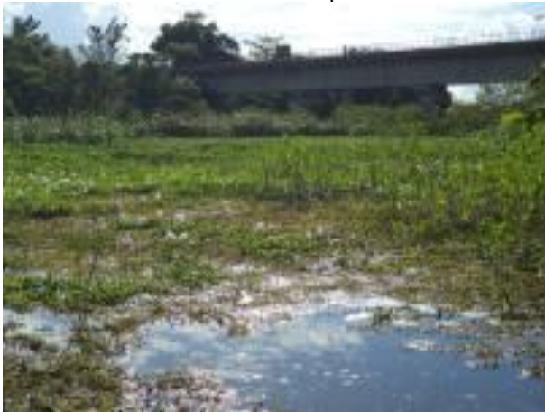
Foto 99: Montante da travessia 359 em julho de 2013. Foto: Amplo
