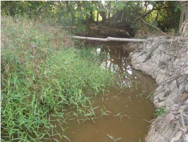
Foto 269: Montante da travessia 113 em outubro de 2013. Foto: Amplo
