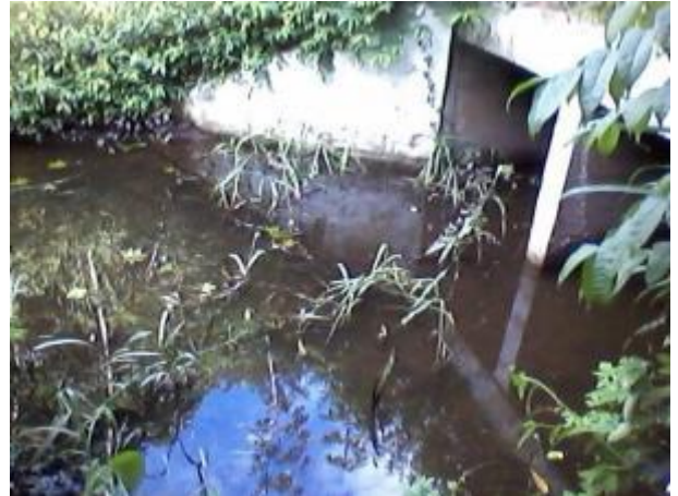
Foto 555: Jusante da travessia 281 em janeiro de 2013. Foto: Amplo
