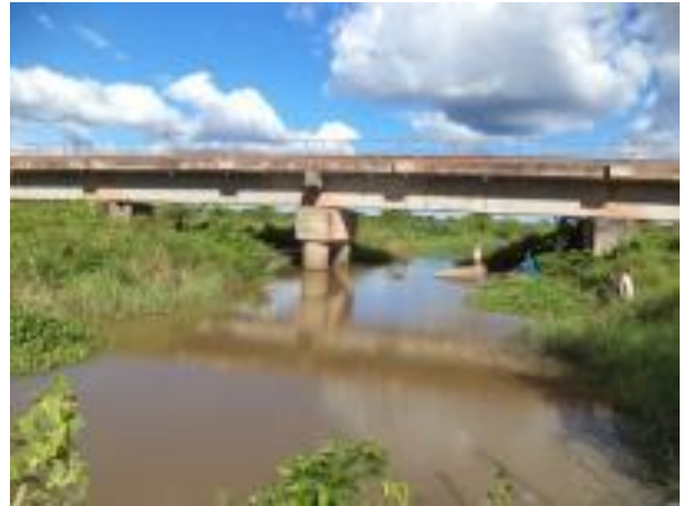
Foto 75: Jusante da travessia 60 em julho de 2013. Foto: Amplo
