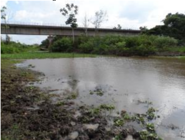
Foto 95: Montante da travessia 359 em janeiro/13. Foto: Ampla
