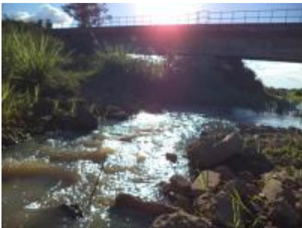
Foto 86: Montante da travessia 61 em julho de 2013. Foto: Amplo
