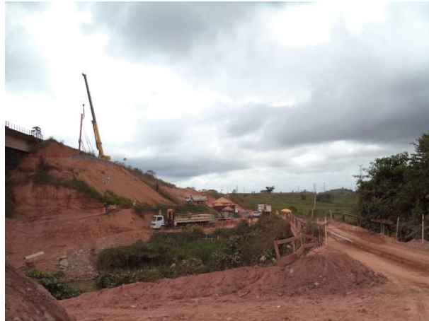
Foto 621: Detalhe das obras da ponte ferroviária em julho/14. Foto: Amplo
