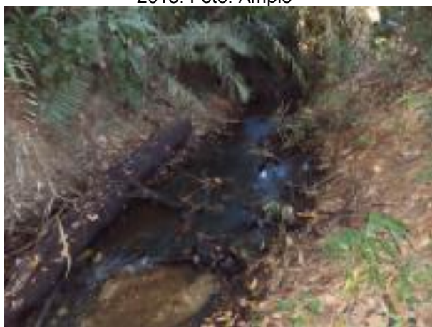
Foto 285: Montante da travessia 124 em julho de 2013. Foto: Ampla
