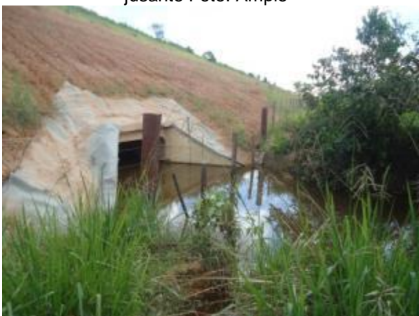
Foto 582: Montante da travessia 286 em abril de 2013. Foto: Ampla
