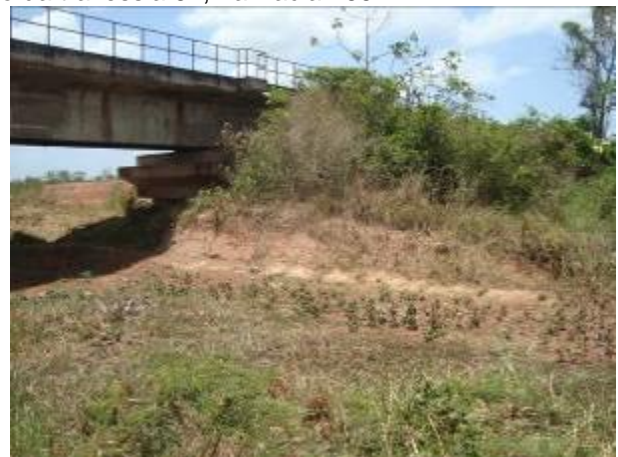
Foto 82: Jusante da travessia 61 em janeiro/13. Foto: Ampla
