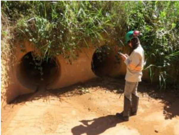
Foto 396: Montante da travessia 177, em julho de 2013. Foto: Amplo
