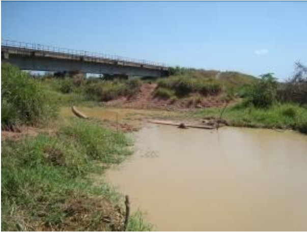
Foto 68: Montante da travessia 60 em janeiro/13. Foto: Amplo
