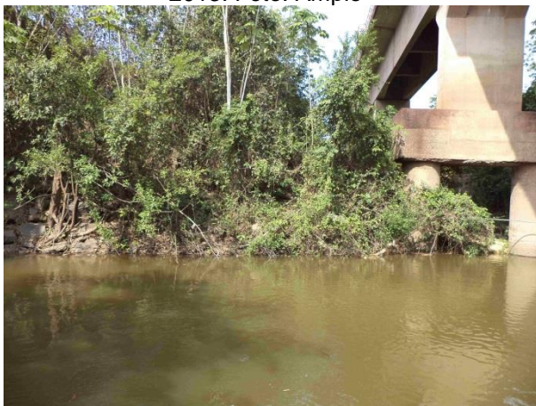
Foto 500: Montante da travessia 260 em outubro de 2013. Foto: Ampla
