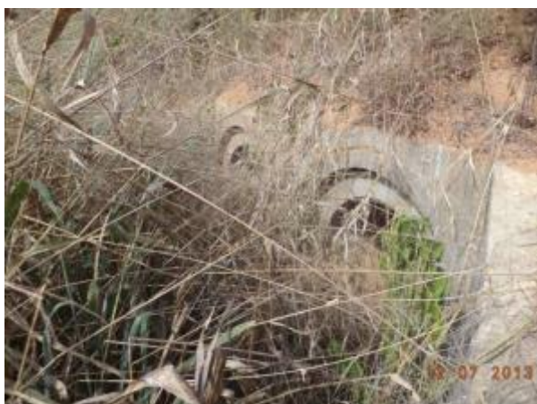
Foto 400: Montante da travessia 179 em julho de 2013. Foto: Amplo
