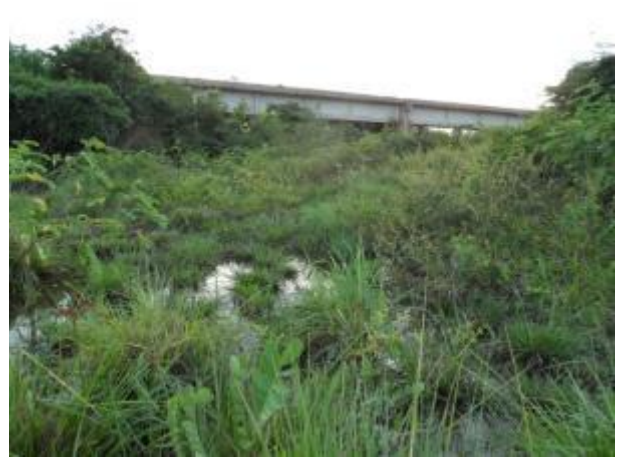
Foto 126: Jusante da travessia 360 em janeiro/13. Foto: Ampla
