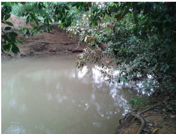
Foto 632: Montante da travessia 344 em julho de 2014. Foto: Ampla
