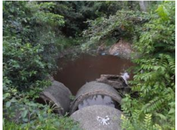
Foto 58: Jusante da travessia 57 em janeiro/13. Foto: Ampla
