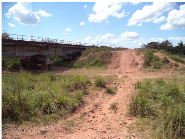
Foto 93: Montante da travessia 61 em julho de 2014. Foto: Amplo
