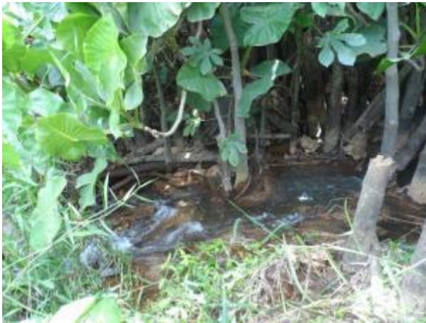
Foto 325: Montante da travessia 152 em janeiro de 2013. Foto: Amplo
