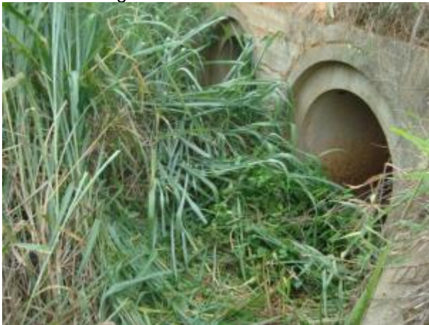
Foto 398: Montante da travessia 179 em janeiro de 2013. Foto: Ampla
