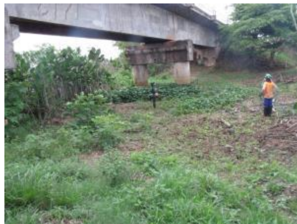
Foto 138: Jusante da travessia 63 em janeiro/13. Foto: Ampla
