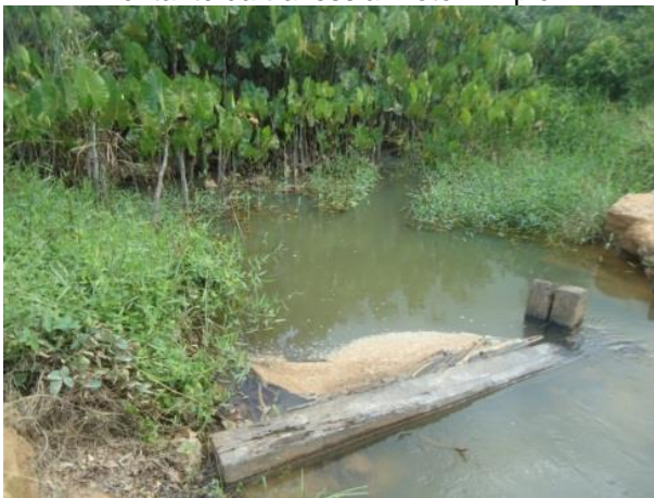
Foto 329: Montante da travessia 152 em abril de 2013. Foto: Ampla
