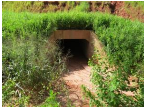
Foto 387: Montante da travessia 175, em abril de 2013. Foto: Ampla
