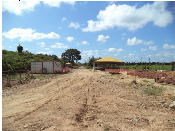
Foto 153: Detalhe das tendas de apoio às obras da ponte ferroviária Praqueú em julho/14. Foto: Amplo
