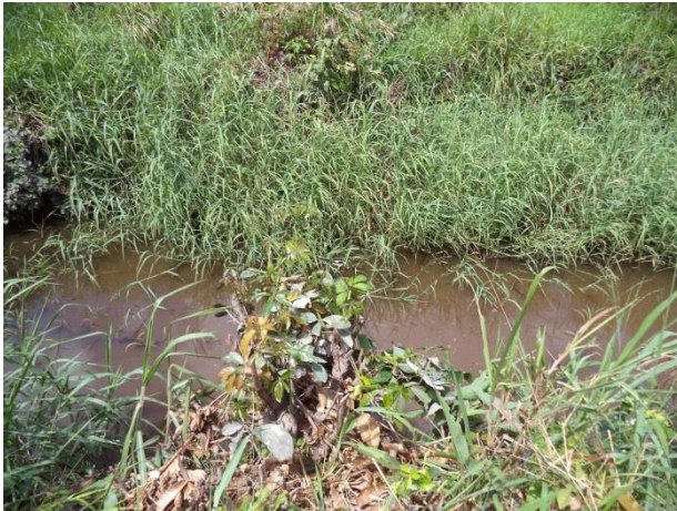
Foto 165: Montante da travessia 77 em julho de 2014. Foto: Ampla
