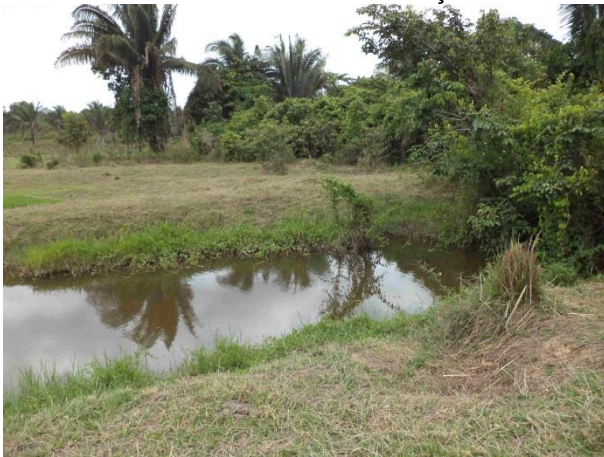
Foto 514: Montante da travessia 265 em outubro de 2013. Foto: Amplo
