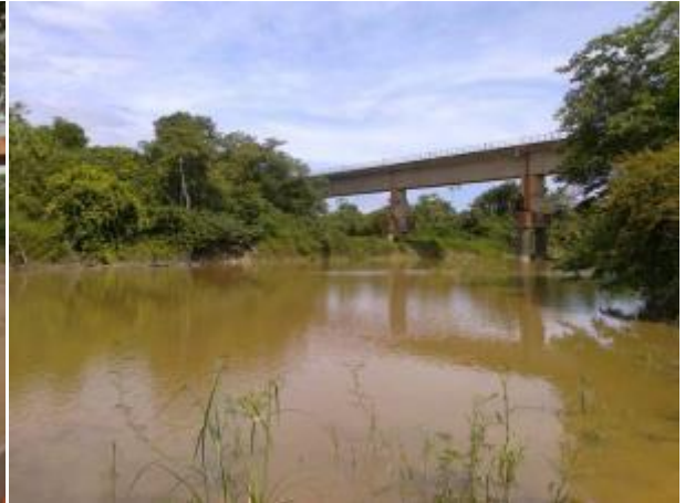
Foto 566: Jusante da travessia 283 em janeiro de 2013. Foto: Amplo
