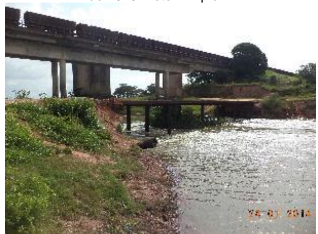
Foto 203: Jusante da travessia 86 na em janeiro de 2014. Foto: Amplo
