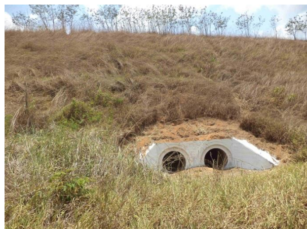
Foto 401: Montante da travessia 179 em outubro de 2013. Foto: Amplo
