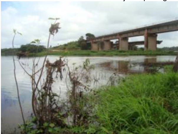
Foto 196: Montante da travessia 86 em abril de 2013. Foto: Amplo
