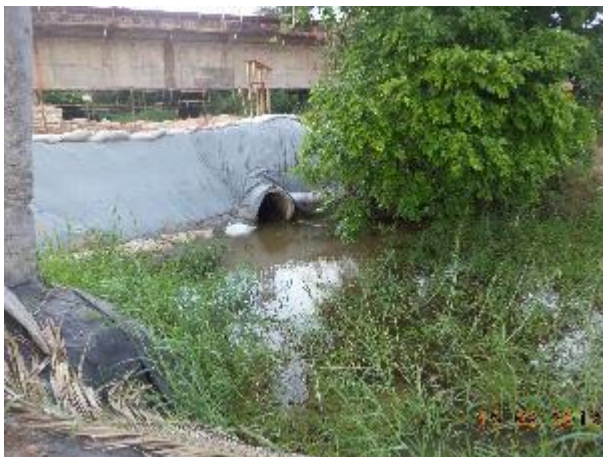
Foto 163: Montante da travessia 77 em janeiro de 2014, com aterro de conquista temporário já instalado, Foto: Amplo
