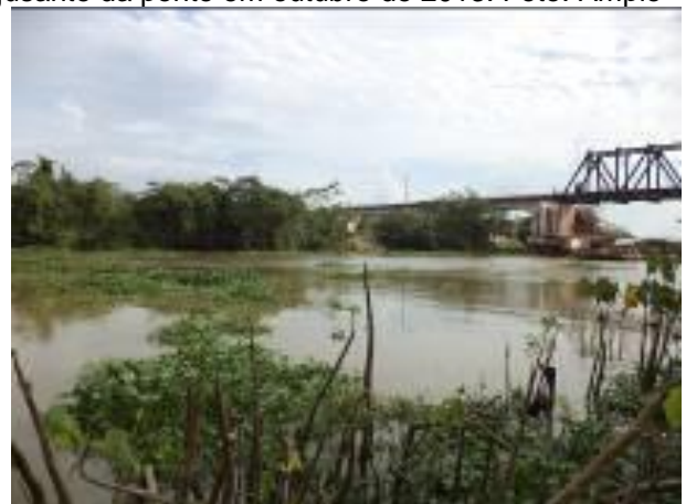
Foto 122: Jusante da travessia 62 em janeiro de 2014. Foto: Amplo
