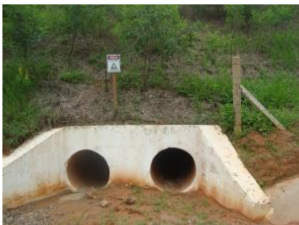
Foto 382: Montante da travessia 174, em janeiro de 2013. Foto: Ampla
