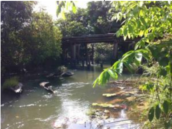
Foto 458: Montante da travessia 243 em julho de 2013. Foto: Amplo
