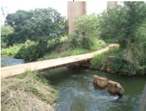
Foto 406: Montante da travessia 191 em abril de 2013. Foto: Amplo
