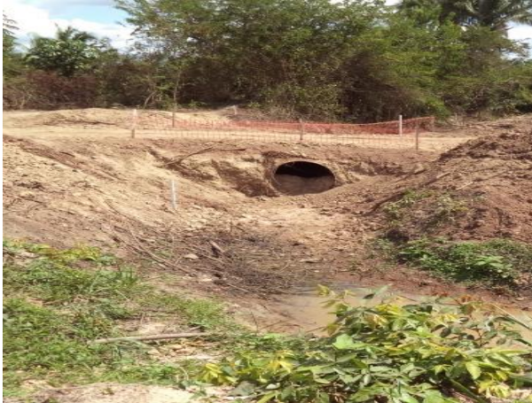
Foto 176: Montante da travessia 78 em julho/14. Foto: Amplo
