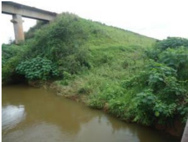
Foto 610: Montante da travessia 316 em abril de 2013. Foto: Ampla
