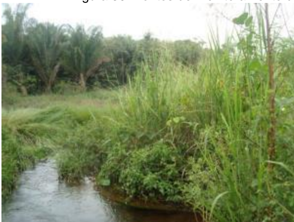
Foto 353: Montante da travessia 164 em janeiro de 2013. Foto: Ampla
