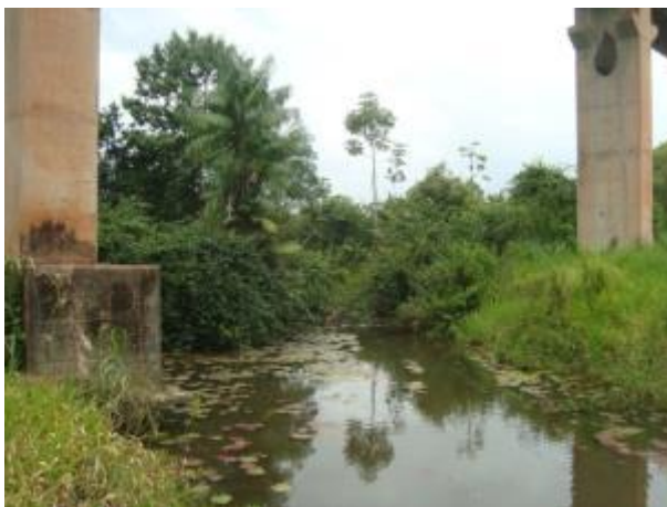
Foto 443: Montante da travessia 240 em janeiro de 2013. Foto: Amplo
