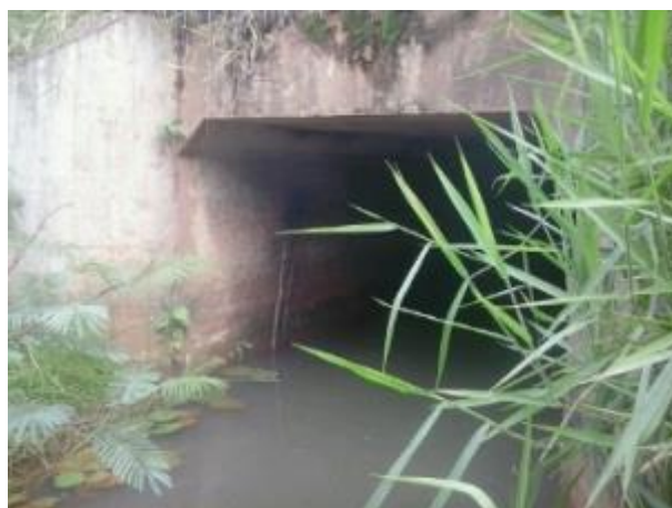
Foto 417: Jusante da travessia 197 em janeiro de 2013. Foto: Ampla
