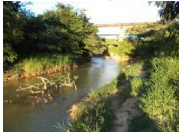
Foto 295: Jusante da Travessia 132 em julho de 2013. Foto: Amplo
