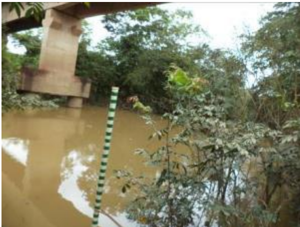
Foto 502: Montante da travessia 260 em janeiro de 2014. Foto: Amplo
