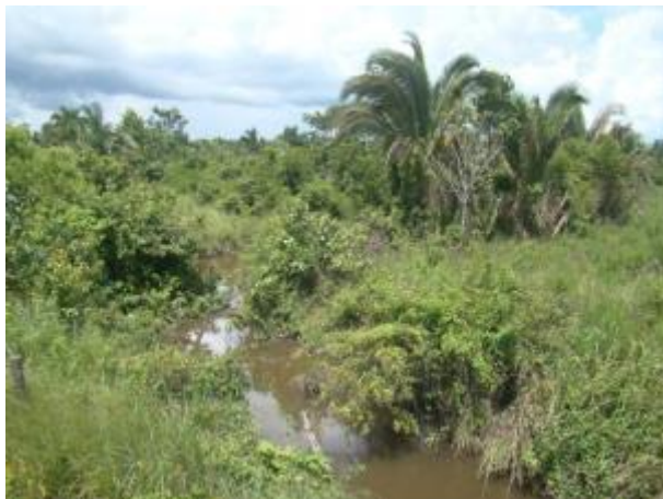
Foto 507: Montante da travessia 265 em janeiro de 2013. Foto: Amplo
