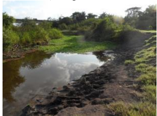
Foto 224: Jusante da Travessia 100 em janeiro de 2013. Foto: Ampla
