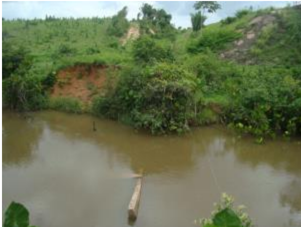
Foto 474: Montante da travessia 252 em janeiro de 2013. Foto: Amplo
