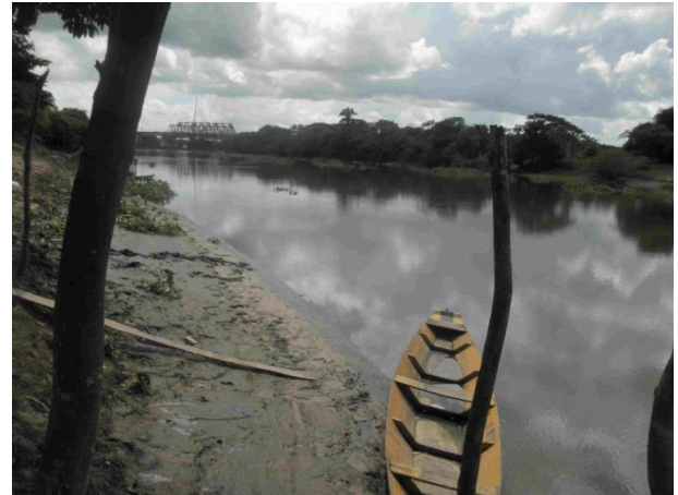
Foto 124: Jusante da travessia 62 em julho de 2014. Foto: Amplo
