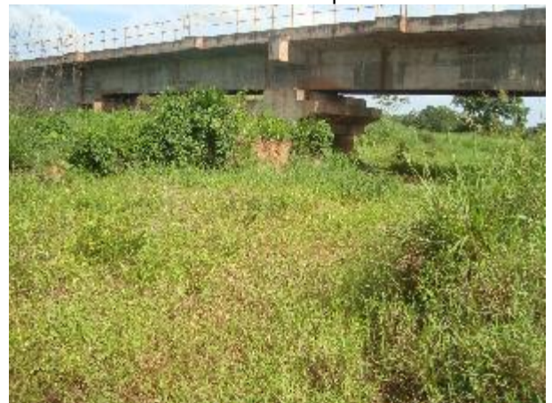
Foto 92: Jusante da travessia 61 em janeiro de 2014. Foto: Amplo
