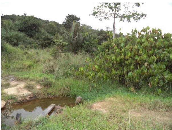
Foto 338: Montante da travessia 152 em julho de 2014. Foto: Amplo
