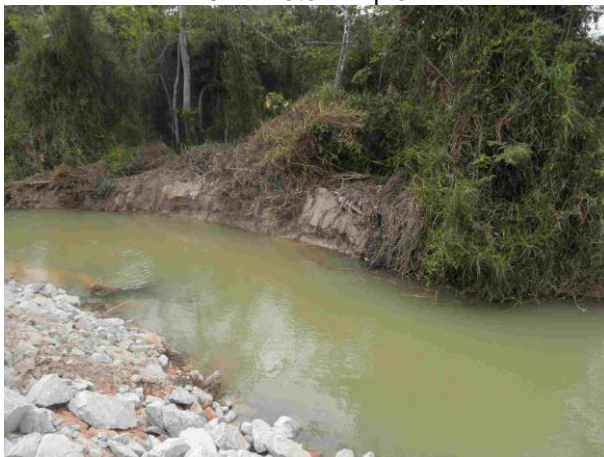
Foto 379: Montante da travessia 172 em julho de 2014. Foto: Amplo
