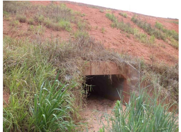
Foto 389: Montante da travessia 175, em outubro de 2013. Foto: Ampla
