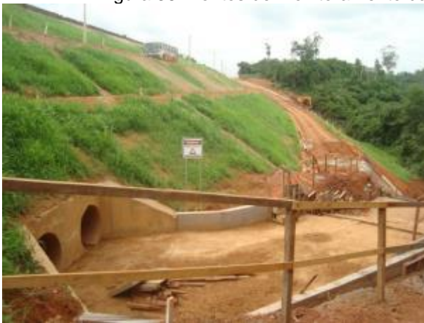
Foto 394: Montante da travessia 177, em janeiro de 2013. Foto: Ampla
