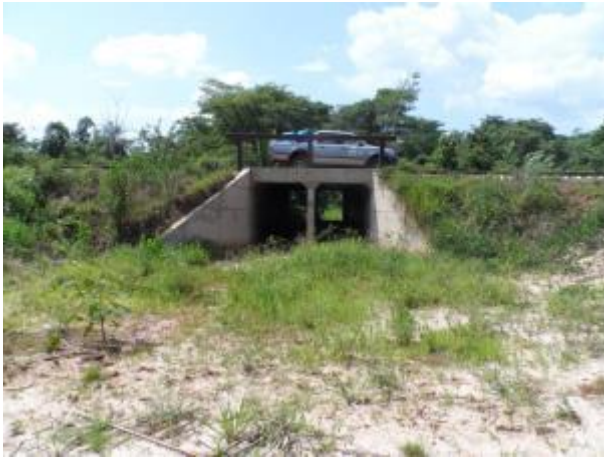
Foto 46: Montante da travessia 48 em janeiro/13. Foto: Amplo
