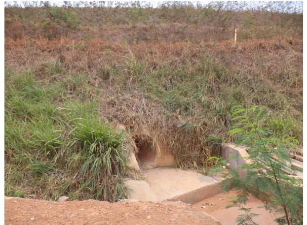
Foto 397: Montante da travessia 177, em outubro de 2013. Foto: Amplo
