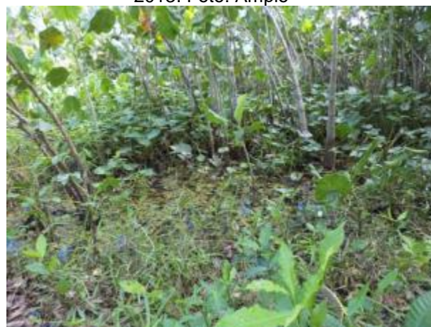
Foto 142: Jusante da travessia 63 em julho de 2013. Foto: Ampla
