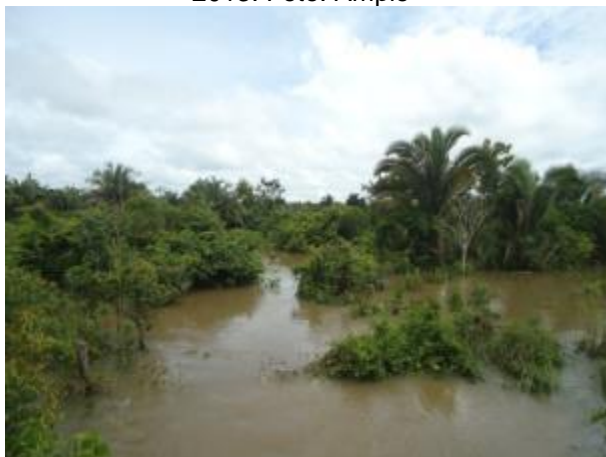
Foto 509: Montante da travessia 265 em abril de 2013. Foto: Amplo
