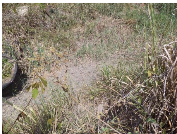
Foto 280: Montante da Travessia 116 em outubro de 2013. Foto: Amplo
