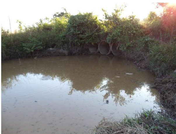
Foto 34: Montante da travessia 35 no Igarapé Carema, em julho /14. Foto: Amplo
