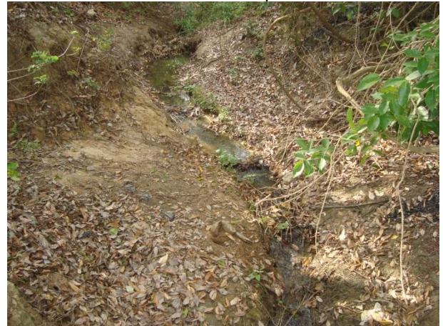
Foto 120: Detalhe do córrego que deságua a jusante da ponte em outubro de 2013. Foto: Amplo
