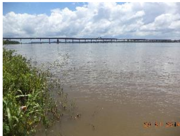
Foto 551: Jusante da Travessia 275 em janeiro de 2014. Foto: Amplo
