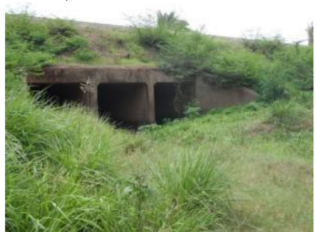
Foto 169: Jusante da travessia 78 em janeiro/13. Foto: Ampla
