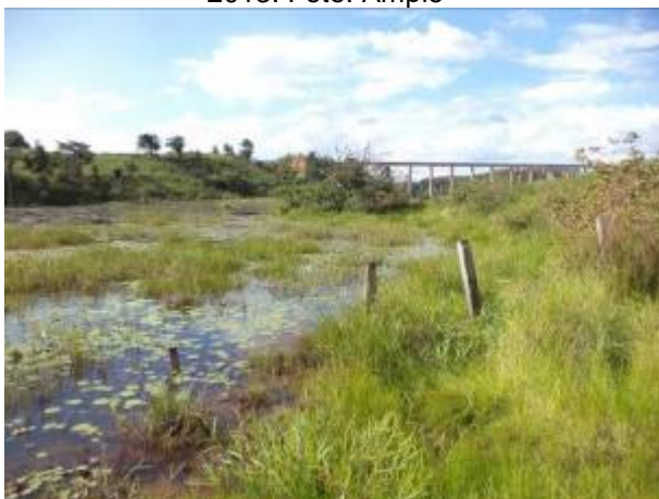
Foto 412: Montante da travessia 191 em janeiro de 2014. Foto: Amplo
