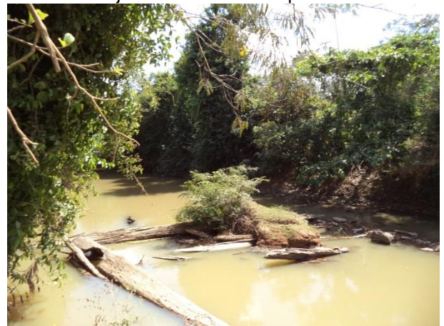
Foto 620: Jusante da travessia 316 em julho de 2014. Foto: Amplo
