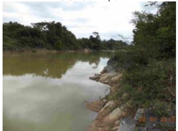
Foto 596: Jusante da travessia 290 em julho de 2013. Foto: Ampla
