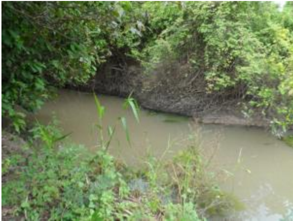
Foto 244: Montante da travessia 108 em janeiro de 2013. Foto: Amplo
