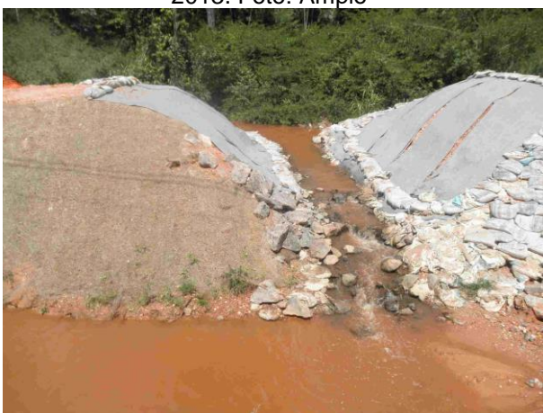
Foto 562: Montante da travessia 281 em julho de 2014. Foto: Amplo
