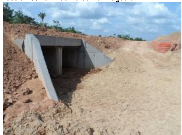
Foto 37: Montante da travessia 40 em janeiro/13. Foto: Ampla
