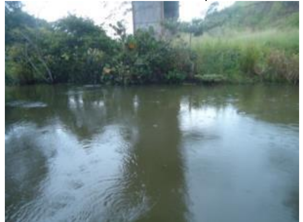
Foto 345: Jusante da travessia 156 em abril de 2013. Foto: Ampla
