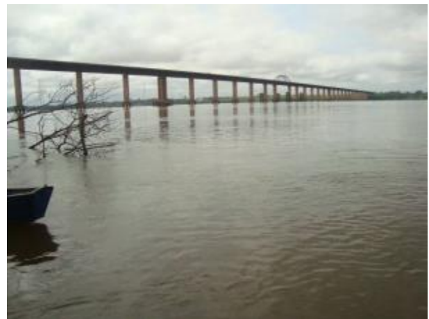
Foto 541: Jusante da Travessia 275 em janeiro de 2013. Foto: Amplo
