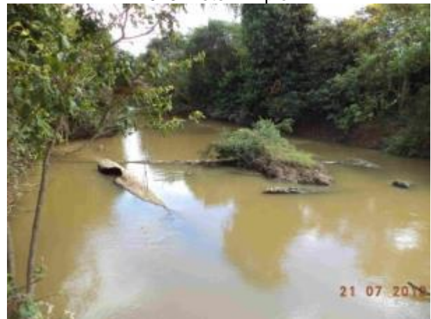
Foto 613: Jusante da travessia 316 em julho de 2013. Foto: Ampla
