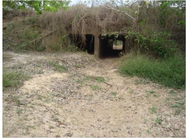
Foto 54: Jusante da travessia 48, em outubro/13. Foto: Ampla
