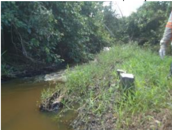
Foto 275: Montante da travessia 116 em abril de 2013. Foto: Amplo
