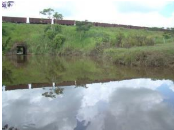
Foto 508: Jusante da travessia 265 em janeiro de 2013. Foto: Amplo
