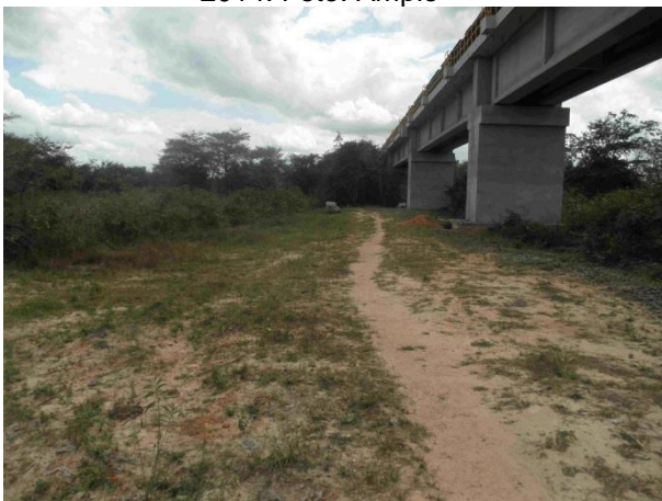
Foto 135: Montante da travessia 360 em julho de 2014. Foto: Ampla
