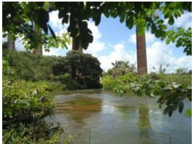
Foto 407: Jusante da travessia 191 em abril de 2013. Foto: Amplo
