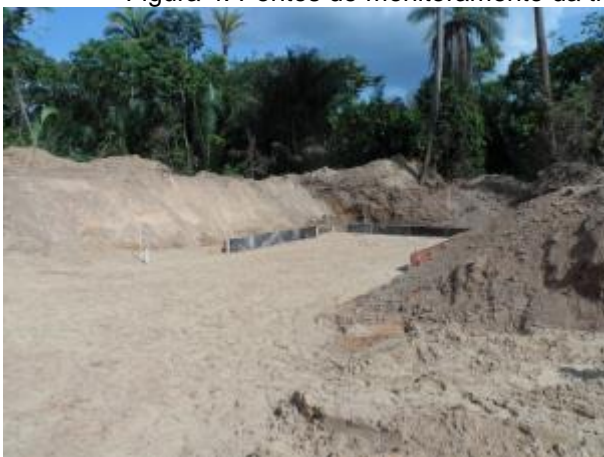
Foto 36: Montante da travessia 40 em janeiro/13. Foto: Ampla
