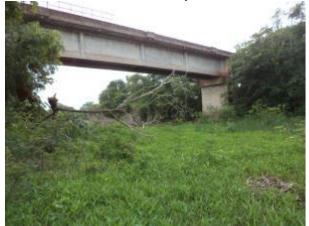
Foto 134: Jusante da travessia 360 em janeiro de 2014. Foto: Ampla
