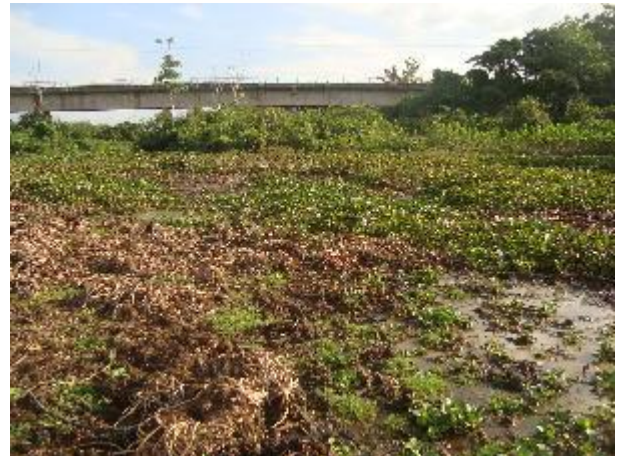
Foto 107: Jusante da travessia 359 em janeiro de 2014 Foto: Amplo.
