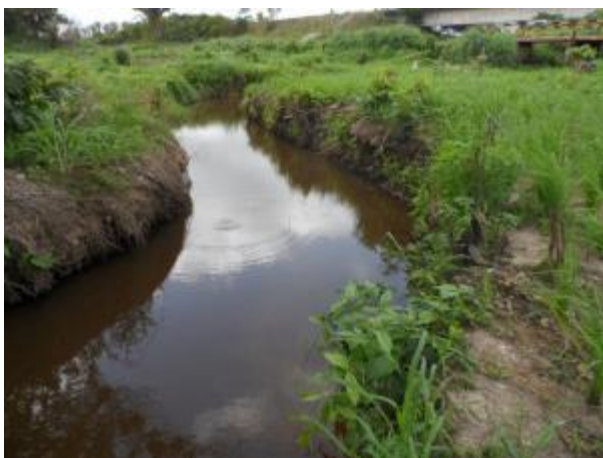
Foto 272: Montante da travessia 116 em janeiro de 2013. Foto: Ampla
