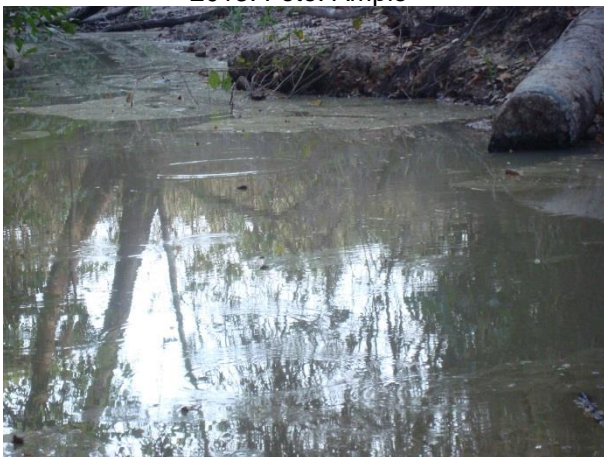
Foto 260: Detalhe da camada de óleo a montante da ponte. Foto: Amplo
