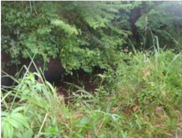
Foto 170: Montante da travessia 78 em abril/13. Foto: Amplo
