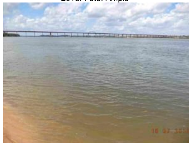
Foto 547: Jusante da Travessia 275 em julho de 2013. Foto: Ampla
