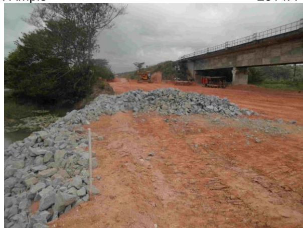
Foto 381: Detalhe da terraplanagem da área de instalação dos pilares para duplicação da ponte ferroviária Pindaré, julho de 2014. Foto: Amplo
