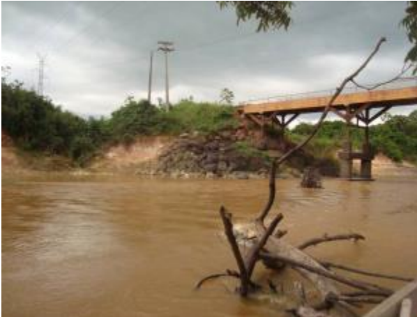
Foto 565: Montante da travessia 283 em janeiro de 2013. Foto: Amplo
