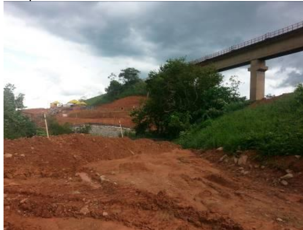
Foto 618: Detalhe das obras da ponte ferroviária em janeiro/14. Foto: Amplo
