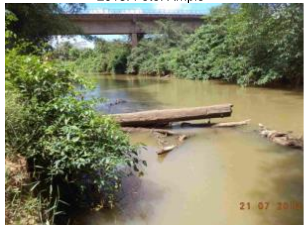
Foto 627: Jusante da travessia 329 em julho de 2013. Foto: Ampla
