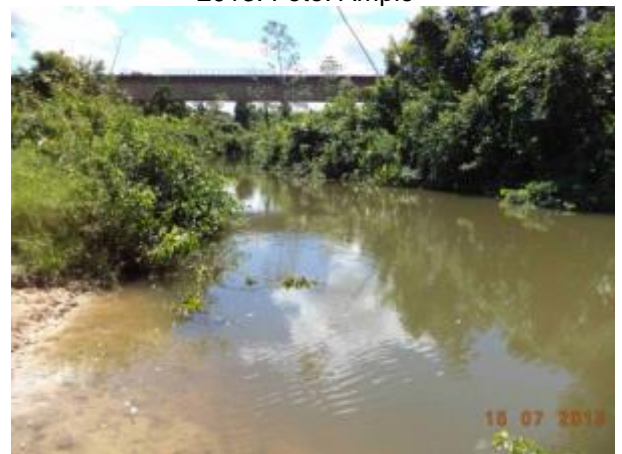
Foto 479: Jusante da travessia 252 em julho de 2013. Foto: Amplo
