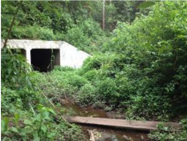
Foto 554: Montante da travessia 281 em janeiro de 2013. Foto: Amplo
