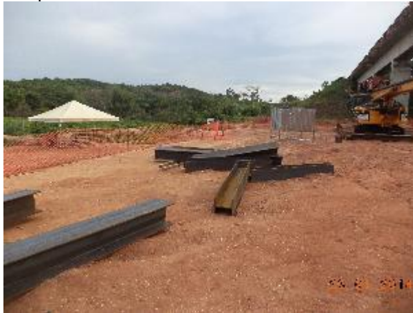
Foto 321: Detalhe da área a ser instalada a ponte ferroviária Presa de Porco, janeiro de 2014. Foto: Amplo
