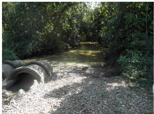
Foto 24: Jusante da travessia 19 em julho de 2014. Foto: Amplo
