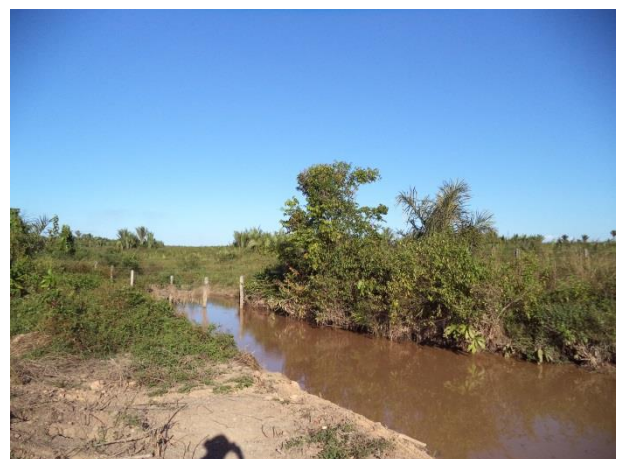
Foto 35: Jusante da travessia 35, no Igarapé Carema, em julho /14. Foto: Amplo
