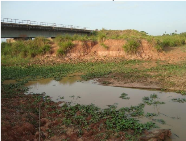
Foto 76: Montante da travessia 60 em outubro de 2013. Foto: Amplo
