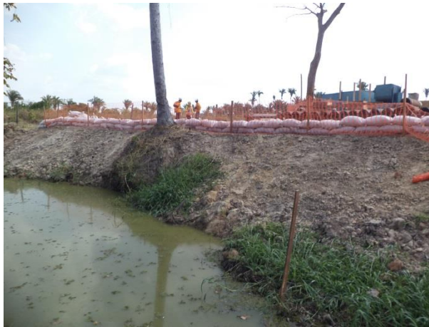
Foto 162: Detalhe das obras a montante da travessia 77, com presença de sistema de contenção temporária (rip rap). Foto: Amplo
