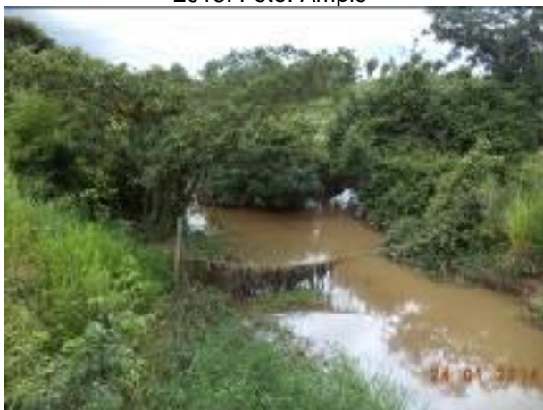
Foto 219: Jusante da travessia 96 em janeiro de 2014. Foto: Ampla
