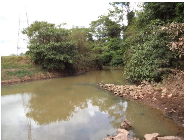
Foto 619: Montante da travessia 316 em julho de 2014. Foto: Amplo
