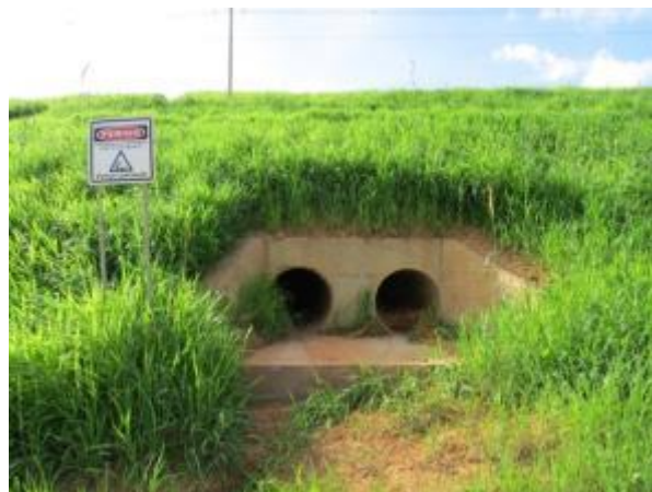
Foto 391: Montante da travessia 176, em abril de 2013. Foto: Amplo
