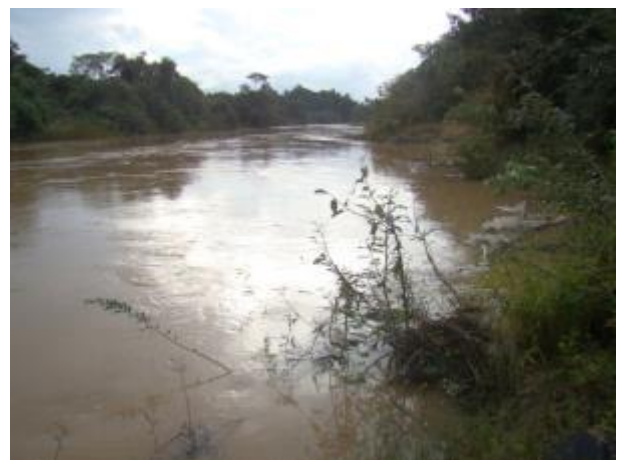
Foto 592: Jusante da travessia 290 em janeiro de 2013. Foto: Amplo
