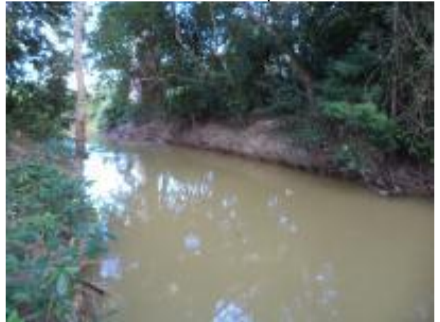
Foto 316: Jusante da Travessia 139 em julho de 2013. Foto: Amplo
