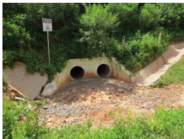
Foto 383: Montante da travessia 174, em abril de 2013. Foto: Ampla
