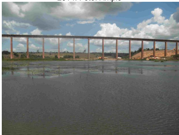
Foto 415: Jusante da travessia 191 em julho de 2014. Foto: Amplo
