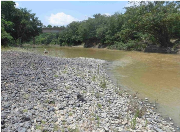
Foto 571: Montante da travessia 283 em outubro de 2013. Foto: Ampla
