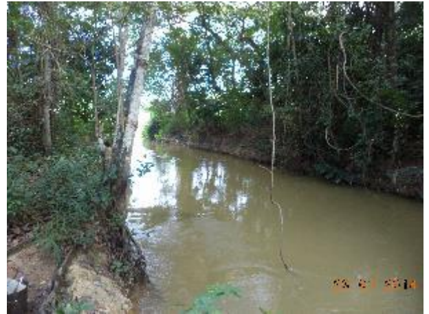
Foto 320: Jusante da Travessia 139 em janeiro de 2014. Foto: Amplo
