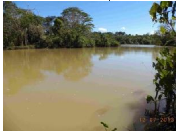
Foto 374: Jusante da travessia 172 em julho de 2013. Foto: Amplo
