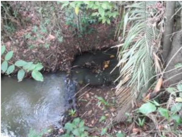
Foto 281: Montante da travessia 124 em janeiro de 2013. Foto: Amplo
