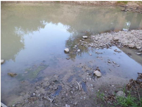
Foto 242: Montante da travessia 107 em outubro de 2013. Foto: Amplo
