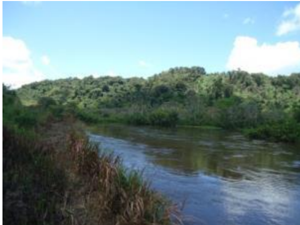
Foto 371: Montante da travessia 172 em abril de 2013. Foto: Amplo
