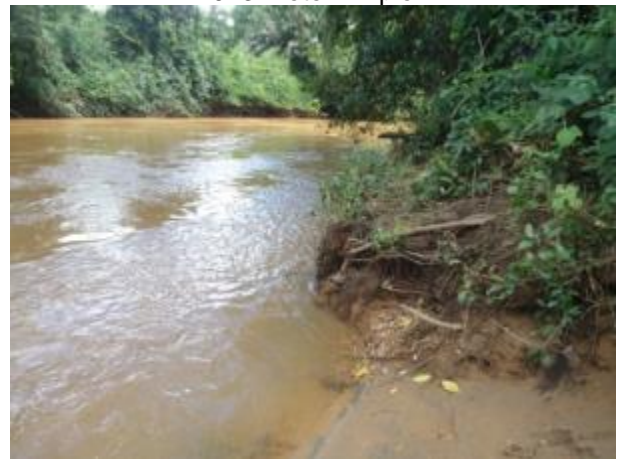
Foto 625: Jusante da travessia 329 em abril de 2013. Foto: Ampla
