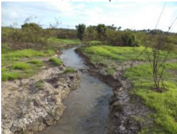
Foto 227: Montante da travessia 100 em julho de 2013. Foto: Amplo
