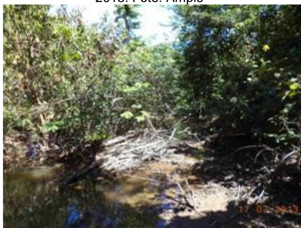
Foto 511: Montante da travessia 265 em julho de 2013. Foto: Amplo
