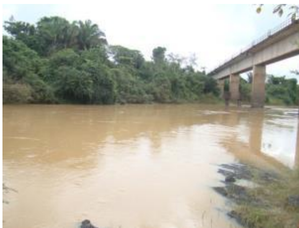
Foto 591: Montante da travessia 290 em janeiro de 2013. Foto: Amplo
