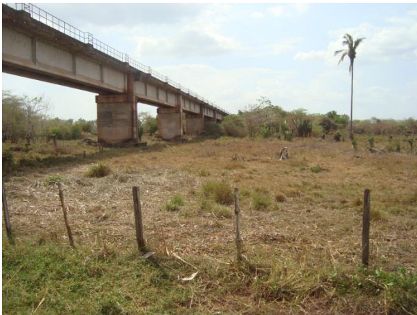
Foto 131: Montante da travessia 360 em outubro de 2013. Foto: Ampla
