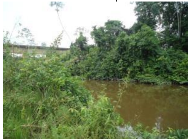
Foto 477: Jusante da travessia 252 em abril de 2013. Foto: Amplo
