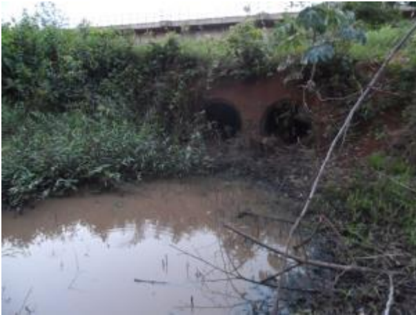
Foto 57: Montante da travessia 57 em janeiro/13. Foto: Ampla
