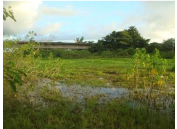
Foto 98: Jusante da travessia 359 em abril de 2013. Foto: Amplo
