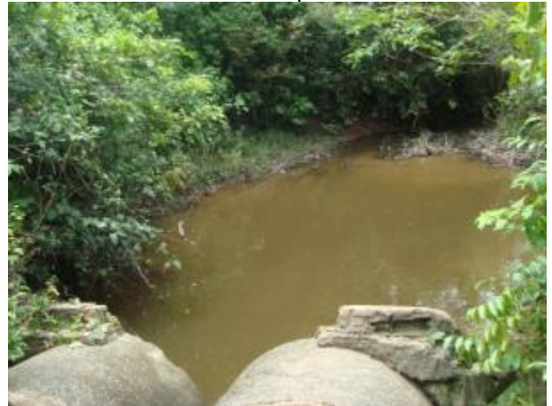
Foto 60: Jusante da travessia 57 em abril de 2013. Foto: Ampla
