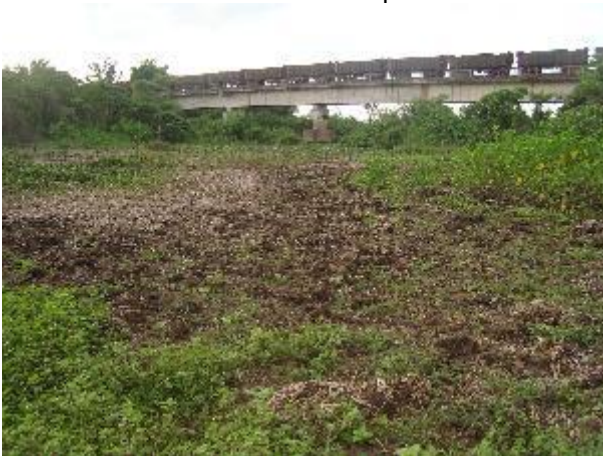
Foto 106: Montante da travessia 359 em janeiro de 2014 Foto: Amplo.
