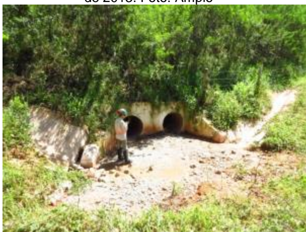
Foto 384: Montante da travessia 174, em julho de 2013. Foto: Ampla
