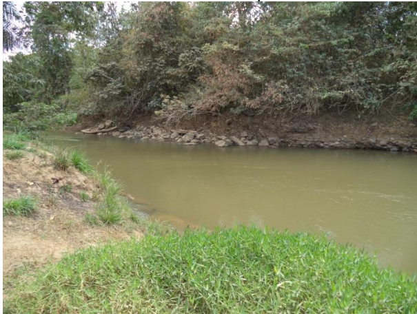
Foto 630: Montante da travessia 329 em julho de 2014. Foto: Ampla
