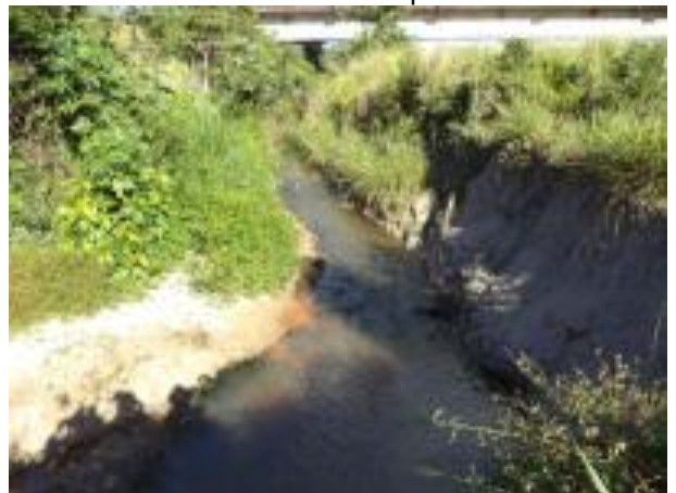
Foto 278: Montante da Travessia 116 em julho de 2013. Foto: Amplo
