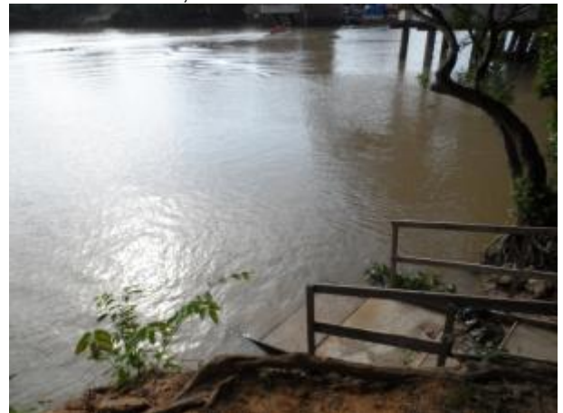
Foto 111: Jusante da travessia 62 em janeiro/13. Foto: Ampla
