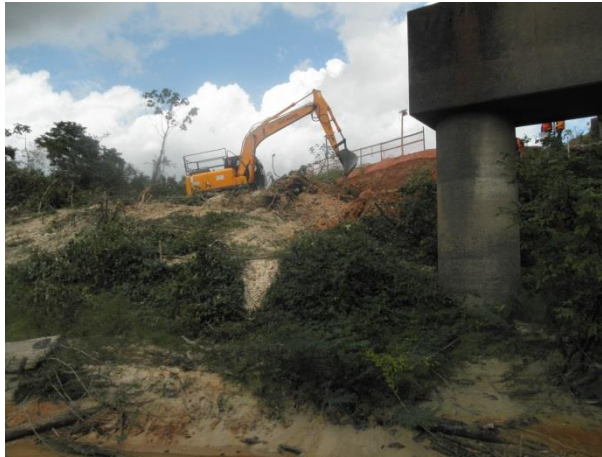
Foto 577: Obras na travessia 283 em julho de 2014. Foto: Ampla
