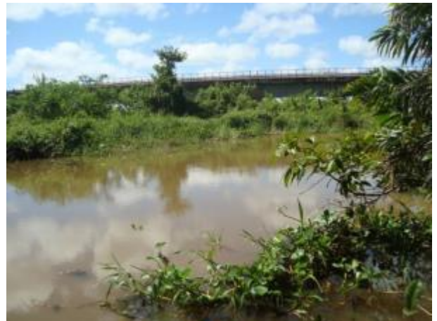
Foto 73: Jusante da travessia 60 em abril de 2013. Foto: Amplo
