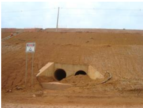
Foto 390: Montante da travessia 176, em janeiro de 2013. Foto: Amplo
