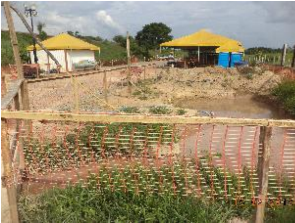
Foto 149: Detalhe das tendas de apoio às obras da ponte ferroviária em janeiro/14. Foto: Amplo
