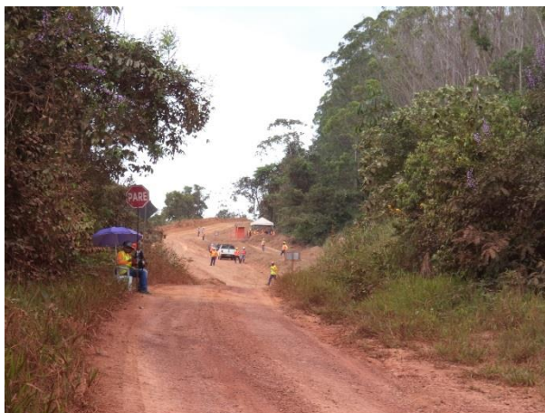
Foto 428: Obras a montante da travessia 197 em julho de 2014. Foto: Amplo
