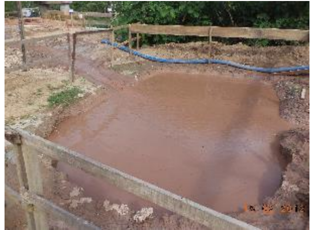
Foto 150: Detalhe da drenagem da água utilizada na perfuração das estacas raiz da ponte ferrov. Praqueú. Foto: Amplo
