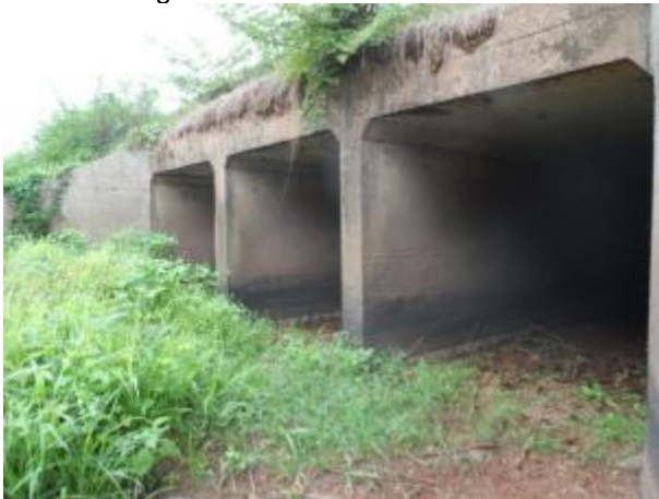
Foto 168: Montante da travessia 78 em janeiro/13. Foto: Ampla
