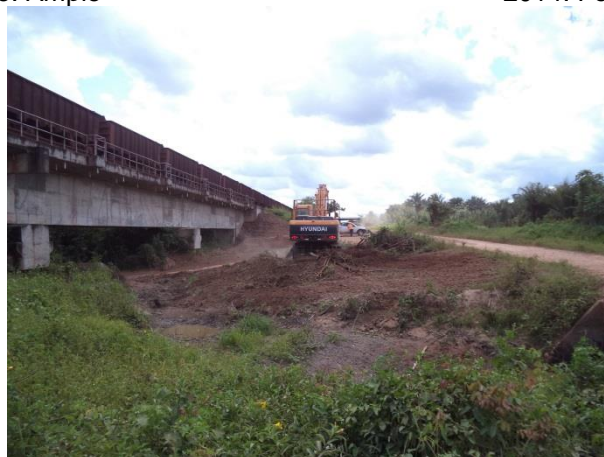
Foto 67: Detalhe dos equipamentos de obras na travessia 57 em julho de 2014; Obra de duplicação da ponte ferroviária Bacía 420. Foto: Amplo
