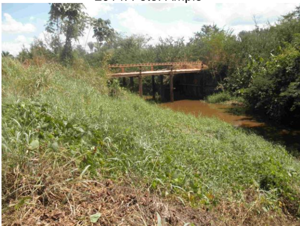
Foto 220: Montante da travessia 96 em julho de 2014. Foto: Ampla
