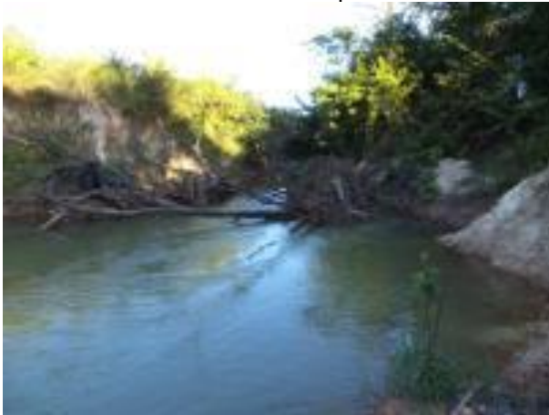
Foto 294: Montante da travessia 132 em julho de 2013. Foto: Amplo
