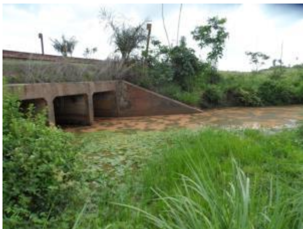
Foto 25: Montante da travessia 35 em janeiro/13. Foto: Amplo
