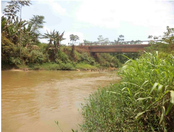
Foto 628: Montante da travessia 329 em outubro de 2013. Foto: Ampla
