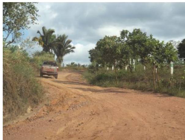
Foto 18: Ausência de sinalização e veículos trafegando na via de Acesso PA02, Parauapebas - PA.
