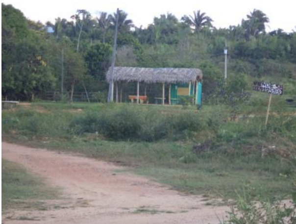
Foto 11: Empreendimento comercial estabelecido às margens do Acesso PA01C, Parauapebas - PA.
