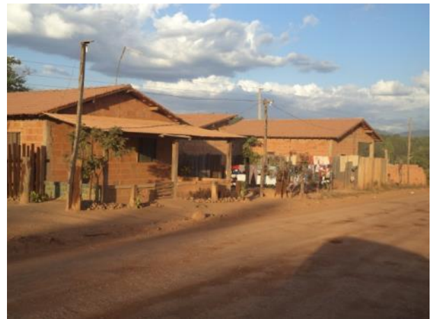
Foto 6: Moradias estabelecidas às margens do Acesso PA01A , Parauapebas - PA.
