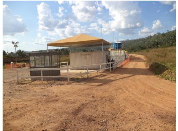
Foto 14: Canteiro de obras presente no Acesso PA01C, Parauapebas - PA.
