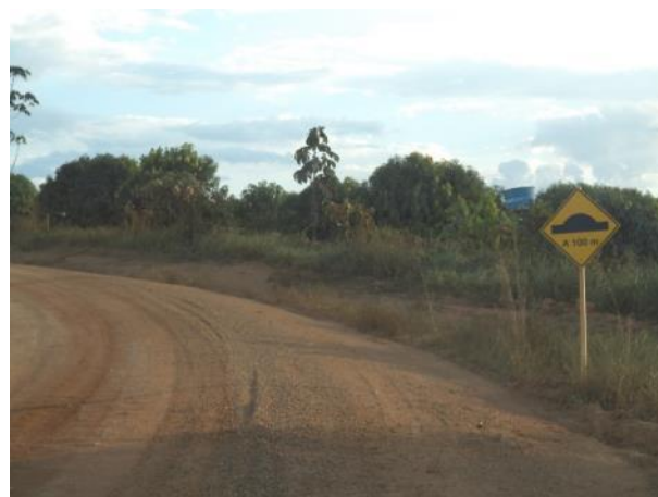
Foto 4: Condições de pavimentação e sinalização presentes no Acesso PA01A , Parauapebas - PA.
