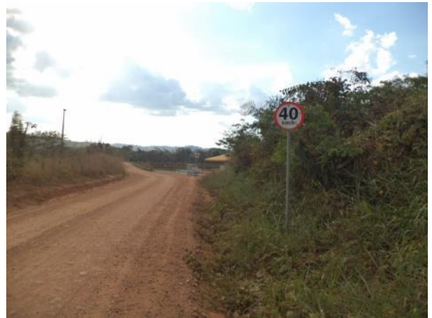
Foto 16: Sinalização e condição de pavimentação da via de Acesso PA01C, Parauapebas - PA.
