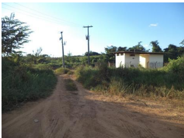
Foto 1: Condições de pavimentação e rede de transmissão de energia , Parauapebas - PA.
