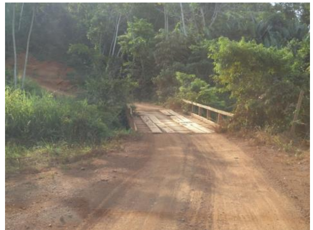
Foto 28: Ponte presente na via de Acesso PA03B, Parauapebas - PA.
