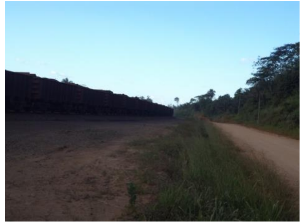
Foto 10: Condições de pavimentação do Acesso PA01B, Parauapebas - PA.
