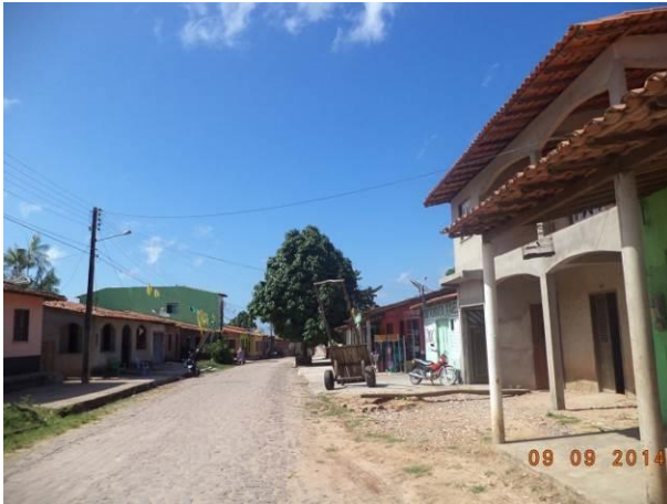
Foto 37: Condições de pavimentação de via da localidade de Coque, Vitória do Mearim - MA.
