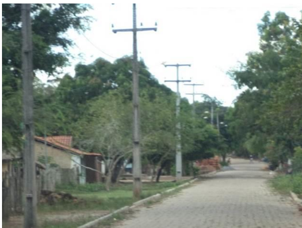
Foto 71: Trecho pavimentado com paralelepípedos na via de Acesso VM03, Arari - MA.
