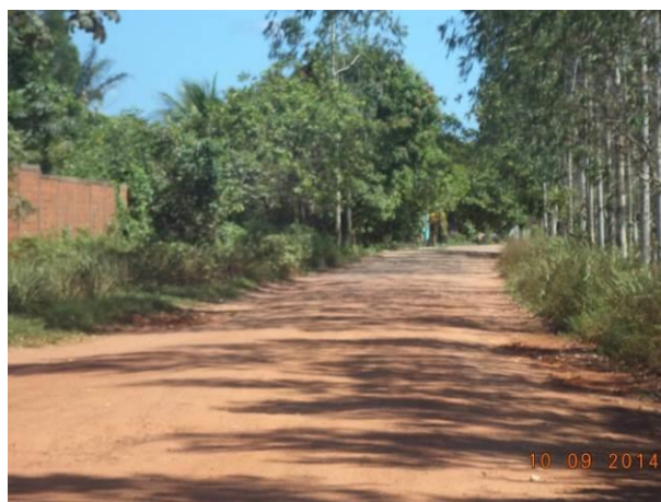
Foto 54: Condições de pavimentação de via da localidade de Tirirical, Vitória do Mearim - MA.
