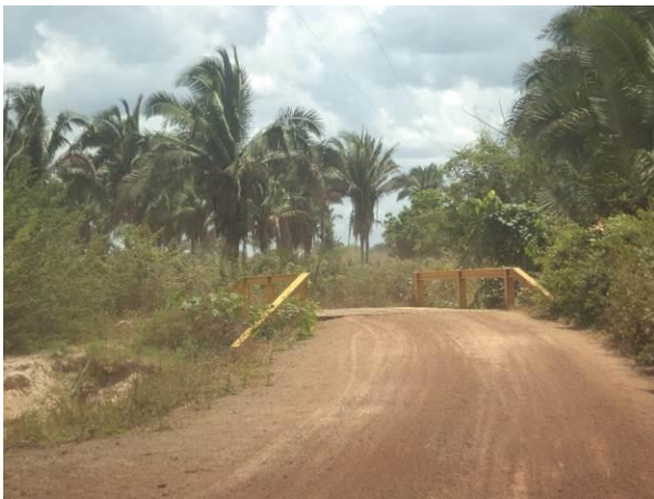
Foto 63: Ponte situada na via de Acesso VM02, Arari - MA.
