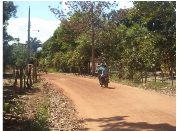
Foto 80: Moradores trafegando na via de Acesso VM05, Arari - MA.
