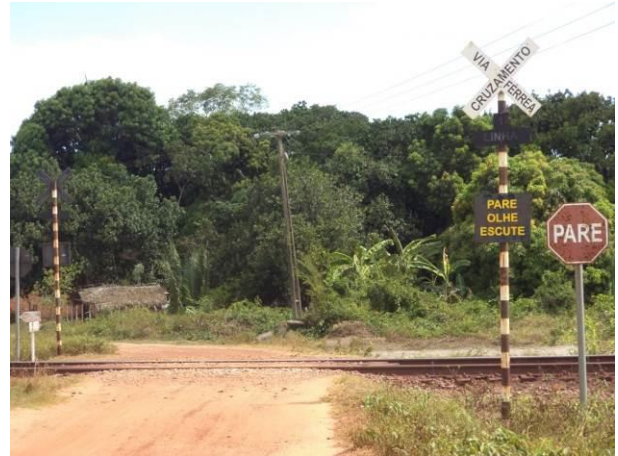
Foto 82: Sinalização presente na via de Acesso VM05, Arari - MA.
