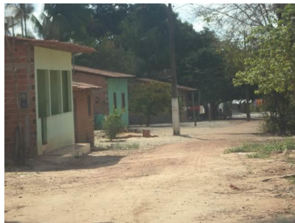
Foto 16: Iluminação pública e condições da via na localidade de Boa Vista, Vitória do Mearim - MA.
