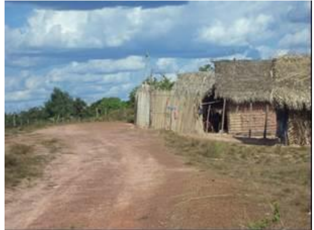
Foto 74: Presença de casas com padrão construtivo de taipa ao final da via de Acesso VM03, Arari - MA.
