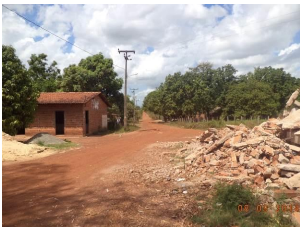
Foto 47: Iluminação pública e condições de pavimentação de via da localidade de Gancho, Arari - MA.
