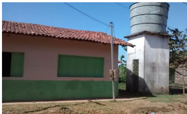
Foto 60: Escola e caixa d'água presente na via de Acesso VM01, Miranda do Norte - MA.
