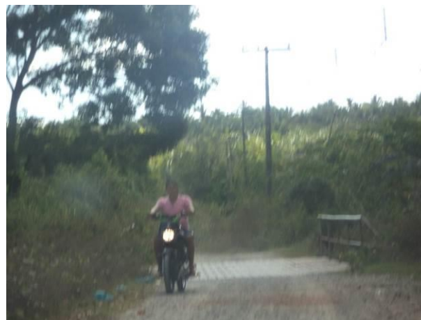
Foto 92: Ponte situada na via de Acesso VM07, Vitória do Mearim, MA.
