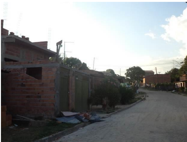
Foto 103: Construção de residência situada na via de Acesso VM09A, Vitória do Mearim, MA.
