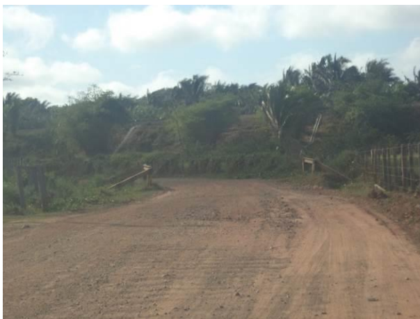
Foto 87: Ponte situada na via de Acesso VM06, Vitória do Mearim, MA.
