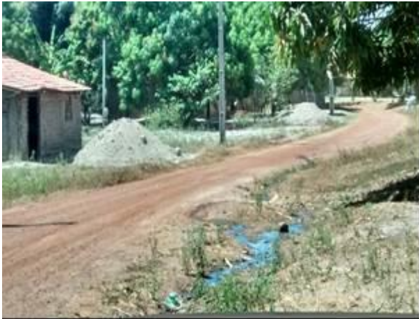
Foto 61: Esgotamento sanitário lançado a céu aberto na via de Acesso VM01, Miranda do Norte - MA.
