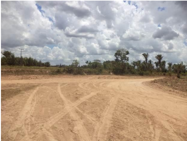
Foto 65: Ausência de sinalização na via de Acesso VM02, Arari - MA.
