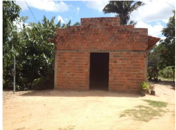
Foto 50: Construção realizada na localidade de Gancho, Arari - MA.
