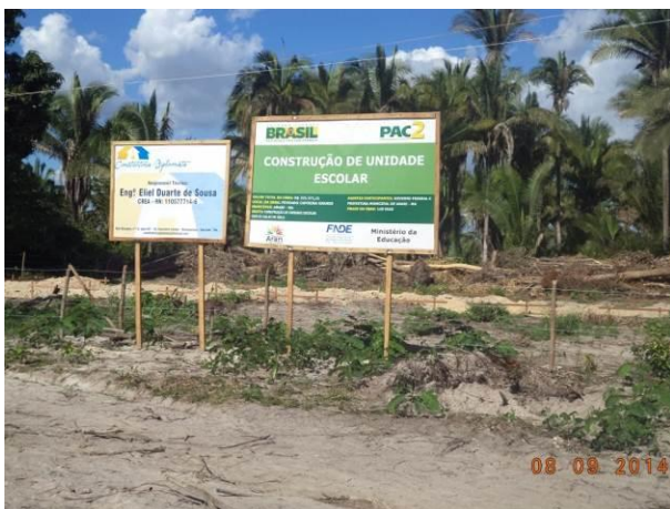
Foto 29: Construção de unidade escolar na localidade de Capoeira Grande, Arari - MA.
