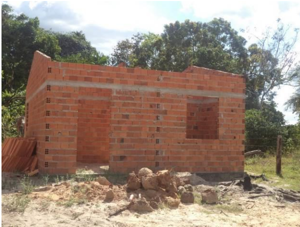
Foto 17: Construção de residência realizada na localidade de Boa Vista, Vitória do Mearim - MA.
