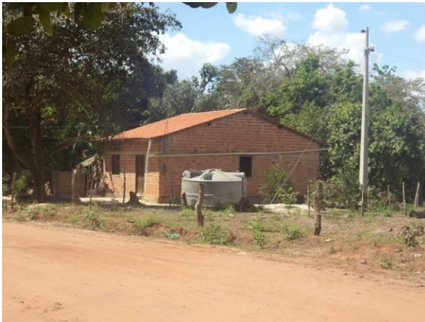
Foto 7: Sistema utilizado para abastecimento de água na localidade de Atijolado, Arari - MA.
