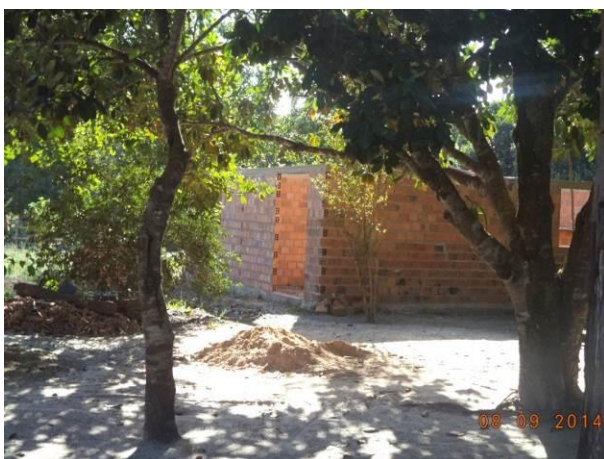
Foto 33: Construção de residência realizada na localidade de Capoeira Grande, Arari - MA.
