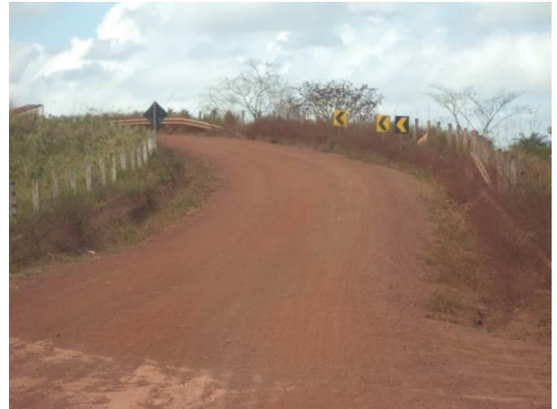
Foto 78: Sinalização e condições de pavimentação da via de Acesso VM04, Arari - MA.
