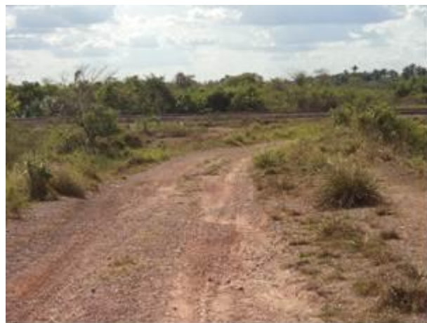
Foto 72: Condições de pavimentação do trecho do Acesso VM03 situado nas proximidades da linha férrea, Arari - MA.
