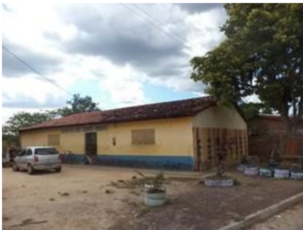
Foto 69: Escola Municipal situada na via de Acesso VM03, Arari - MA.
