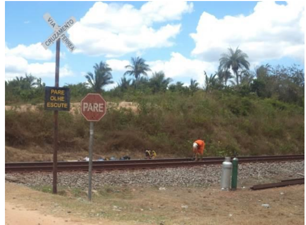
Foto 18: Homens trabalhando na manutenção da linha férrea na localidade de Boa Vista, Vitória do Mearim - MA.
