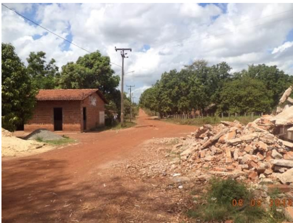
Foto 75: Resíduos sólidos lançados às margens da via de Acesso VM04, Arari - MA.
