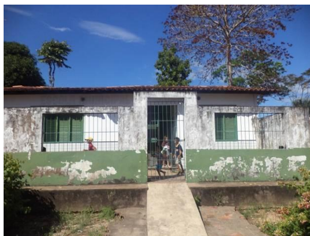
Foto 44: Escola situada na localidade de Escondido, Vitória do Mearim - MA.
