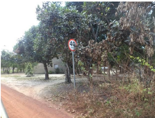
Foto 83: Sinalização parcialmente coberta por vegetação na via de Acesso VM05, Arari - MA.
