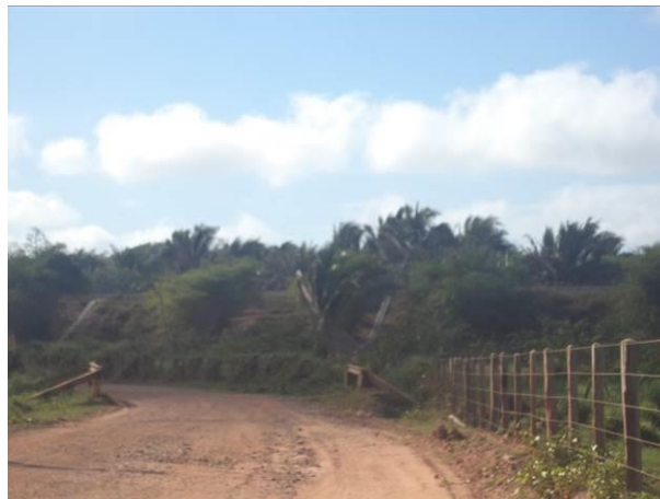
Foto 42: Ponte situada na localidade de Escondido, Vitória do Mearim - MA.
