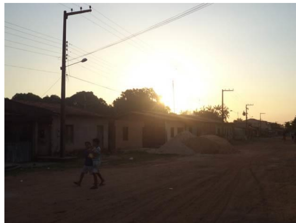
Foto 106: Condições da pavimentação, iluminação pública e tráfego de pedestres na via de Acesso VM09B, Vitória do Mearim, MA.
