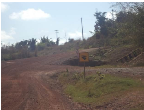
Foto 43: Presença de sinalização em via da localidade de Escondido, Vitória do Mearim - MA.
