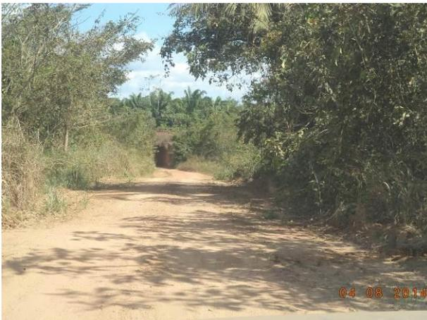
Foto 27: Ausência de sinalização e condições de pavimentação do Acesso SP05, São Pedro da Água Branca - MA.
