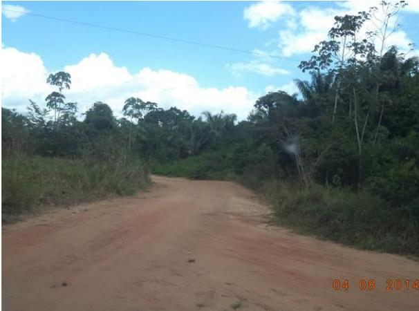
Foto 23: Condições de pavimentação e ausência de sinalização ao longo da via de Acesso SP04, São Pedro da Água Branca - MA.
