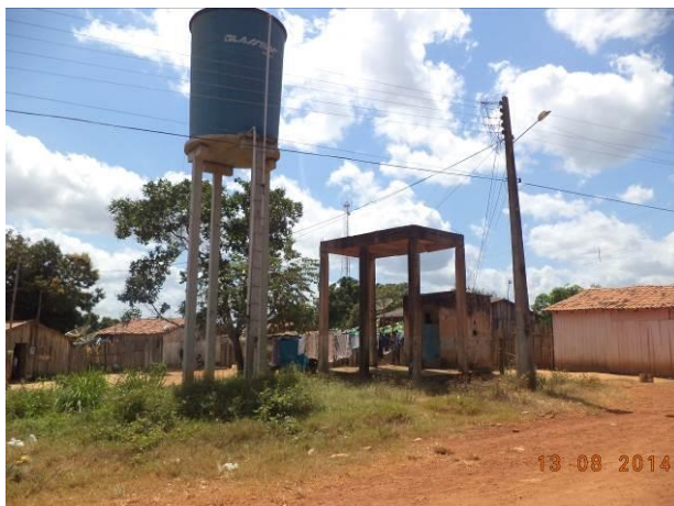
Foto 9: Poço artesiano e reservatório de água da localidade Vila Tropical, Bom Jesus das Selvas - MA.
