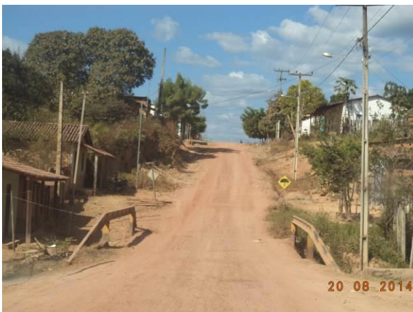
Foto 51: Ponte que perpassa a localidade Vila Pindaré, Buriticupu - MA.
