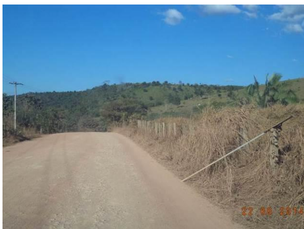
Foto 77: Placa caída no Acesso BU01, Buriticupu - MA.
