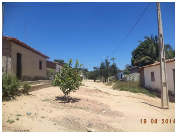
Foto 46: Residências com padrão construtivo predominante de alvenaria, localizadas na Vila Concórdia, Buriticupu - MA.
