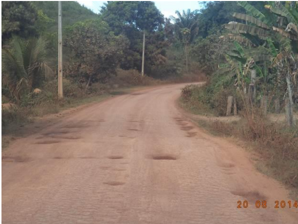
Foto 79: Condições de pavimentação do Acesso BU01, Buriticupu - MA.
