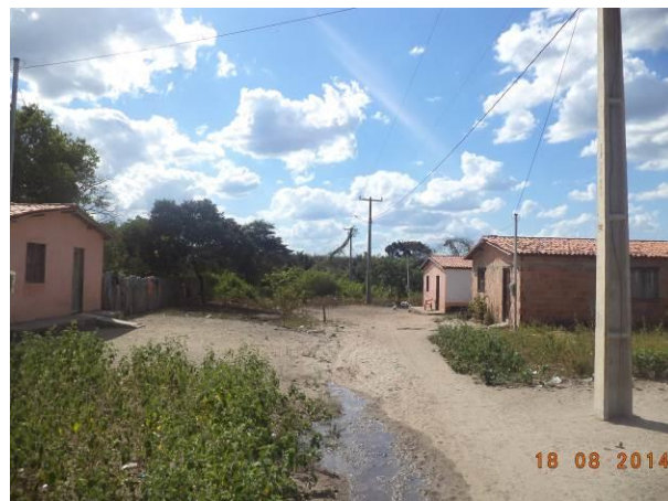
Foto 70: Esgotamento sanitário lançado a céu aberto na localidade Vila La Bote, Buriticupu - MA.
