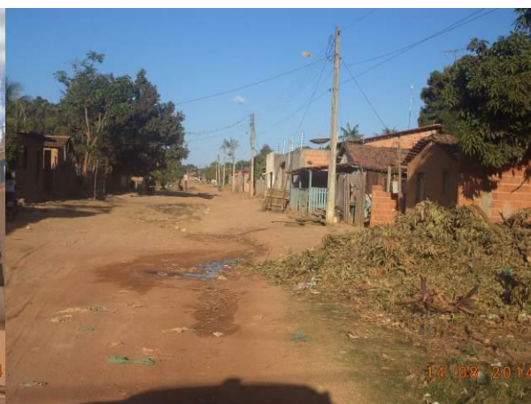
Foto 4: Condições de pavimentação de via da Sede Municipal de Buriticupu.
