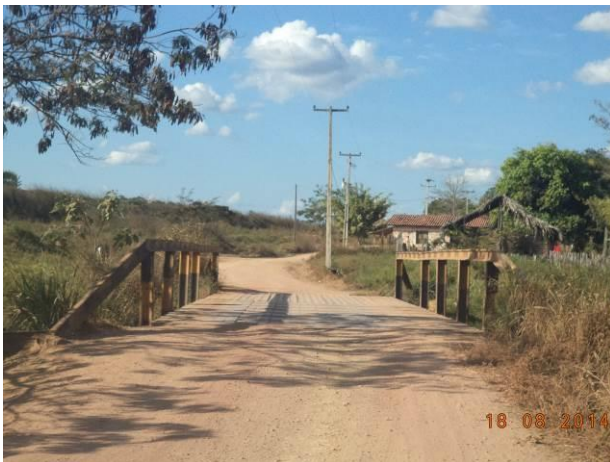
Foto 83: Ponte presente no Acesso BU02, Buriticupu - MA.
