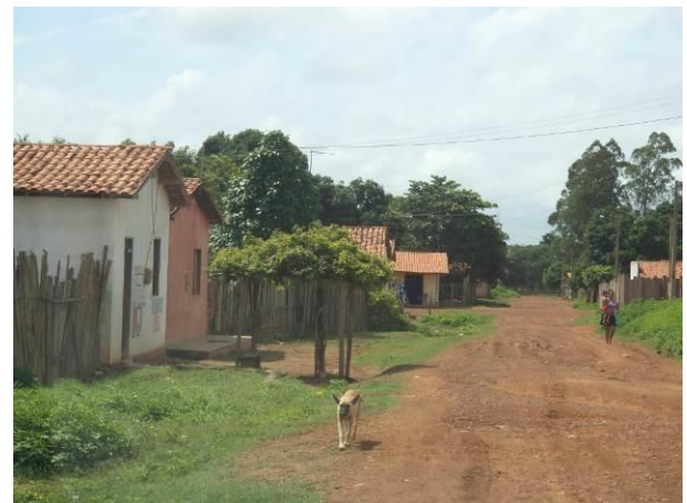
Foto 16: Condições de pavimentação de via da localidade Vila 21 de Maio, Buriticupu - MA.
