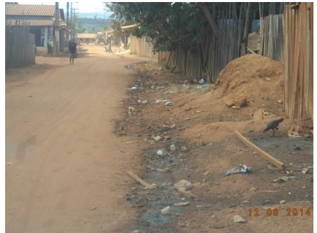
Foto 92: Esgoto lançado a céu aberto na via de acesso inserida na Vila Tropical, Bom Jesus das Selvas - MA.
