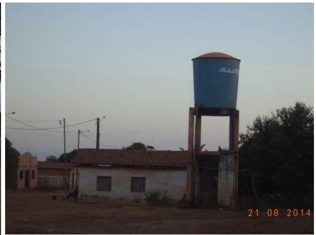
Foto 32: Caixa d'água existente na localidade Vila Pau Ferrado, Buriticupu - MA.
