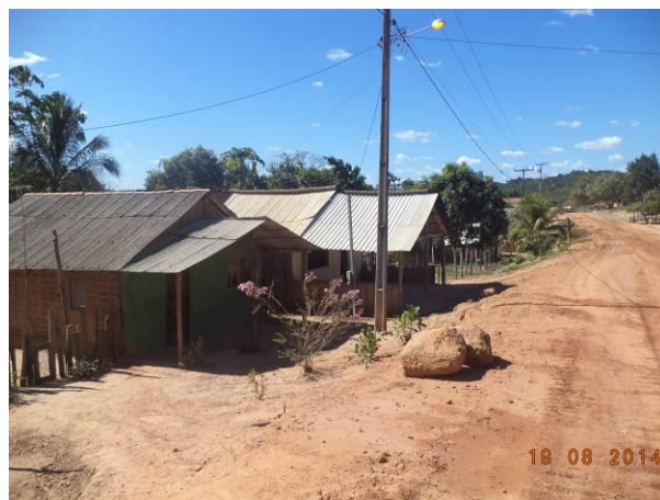
Foto 60: Iluminação pública na localidade Vila Presinha, Buriticupu - MA.
