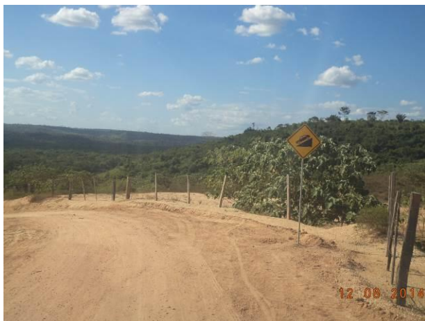
Foto 87: Sinalização existente na via de acesso, Bom Jesus das Selvas - MA.
