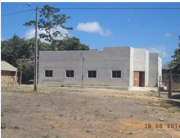
Foto 67: Construção na localidade Centro dos Farias, Buriticupu - MA.
