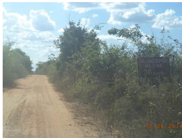
Foto 88: Placa encoberta por vegetação na via de acesso, Bom Jesus das Selvas - MA.
