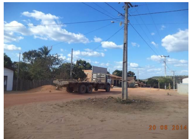
Foto 52: Iluminação Pública presente na localidade Vila Pindaré, Buriticupu - MA.
