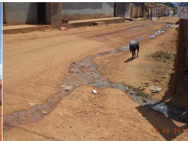
Foto 10: Esgoto lançado a céu aberto na localidade Vila Tropical, Bom Jesus das Selvas - MA.
