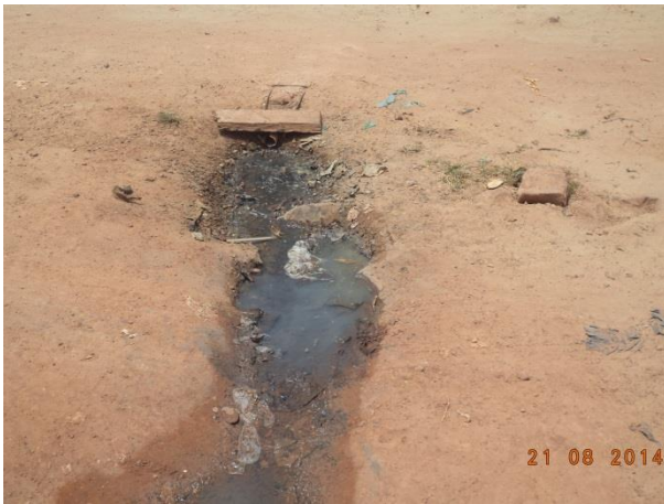
Foto 53: Esgoto lançado a céu aberto na localidade Vila Pindaré, Buriticupu - MA.
