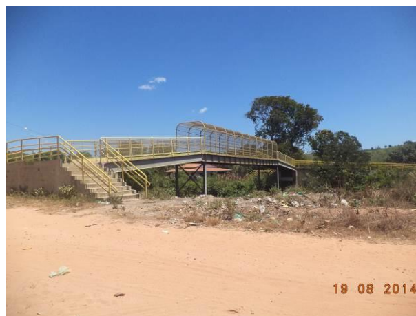
Foto 48: Passarela existente na localidade Vila Concórdia, Buriticupu - MA.
