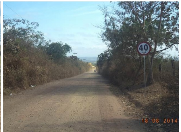
Foto 84: Sinalização existente no Acesso BU02, Buriticupu - MA.
