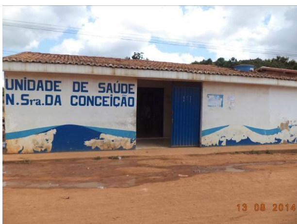
Foto 11: Unidade de Saúde Nossa Senhora da Conceição, localizada na Vila Tropical, Bom Jesus das Selvas - MA.
