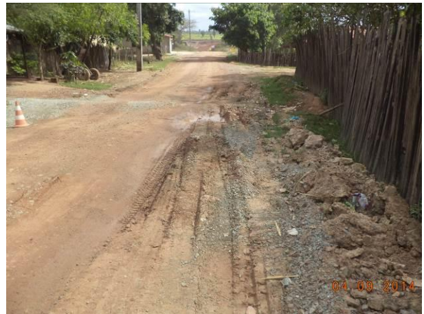
Foto 53: Condições de pavimentação da via de Acesso SI04, Igarapé do Meio - MA.
