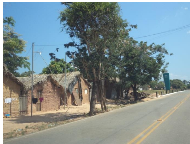
Foto 86: Residências com padrão construtivo de taipa, predominante ao longo do Acesso SI10, Santa Inês - MA.
