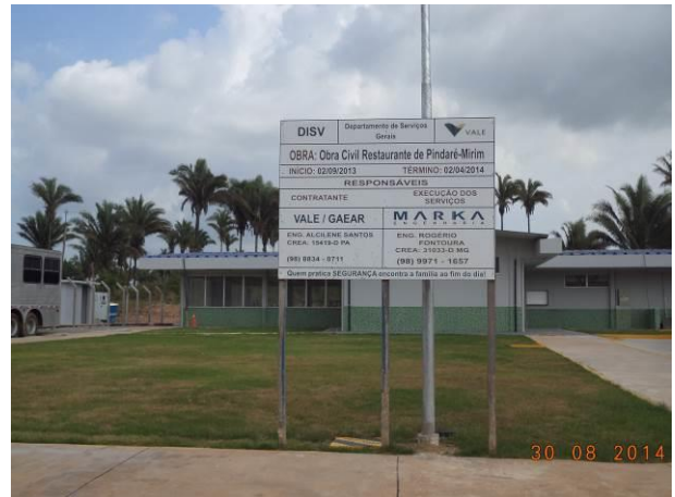
Foto 88: Obra Civil do Restaurante de Pindaré-Mirim no Acesso S110, Santa Inês - MA.
