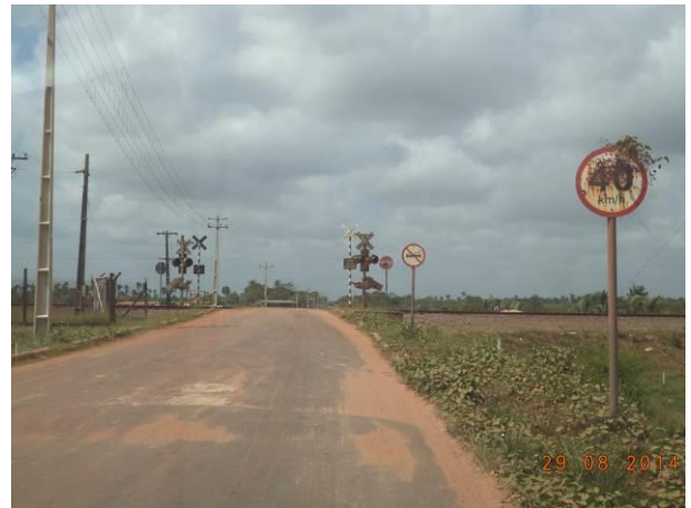
Foto 80: Condições da sinalização vertical no Acesso SI09, Santa Inês - MA.
