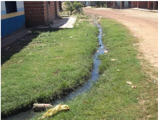
Foto 24: Esgotamento sanitário lançado a céu aberto na localidade de São Vicente, Igarapé do Meio - MA.
