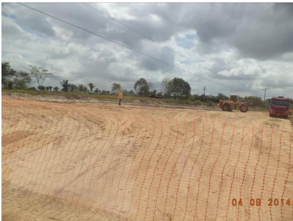
Foto 42: Canteiro de Obras localizado na Acesso SI02, Igarapé do Meio - MA.
