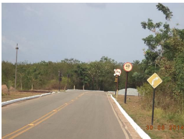
Foto 83: Sinalização existente no Acesso SI10, Santa Inês - MA.
