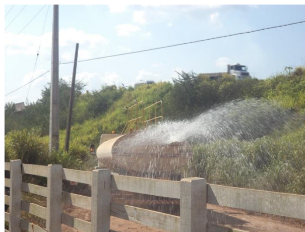
Foto 72: Caminhão Pipa molhando a via de Acesso SI08, Santa Inês - MA.
