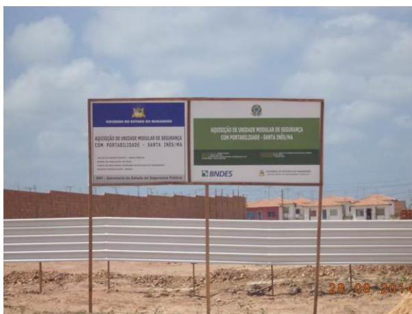
Foto 3: Construção de unidade modular de segurança com portabilidade na Sede Municipal de Santa Inês.
