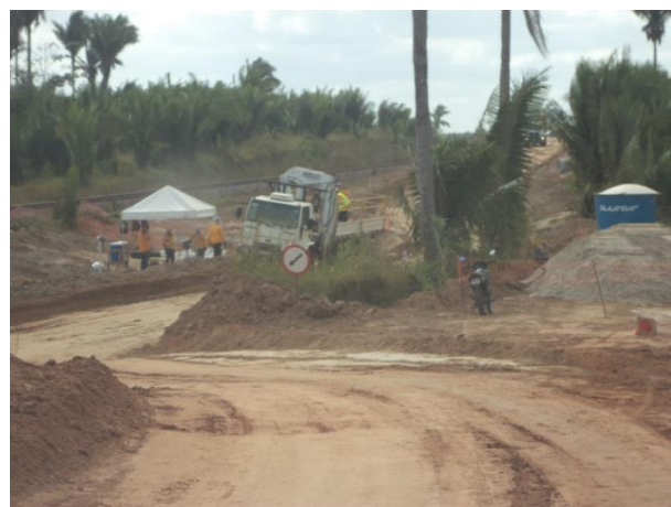
Foto 59: Canteiro de Obras (EEFC) presente ao final da via de Acesso SI05, Igarapé do Meio - MA.
