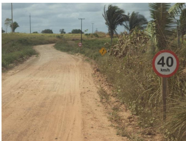
Foto 60: Sinalização presente na via de Acesso SI06, Igarapé do Meio - MA.
