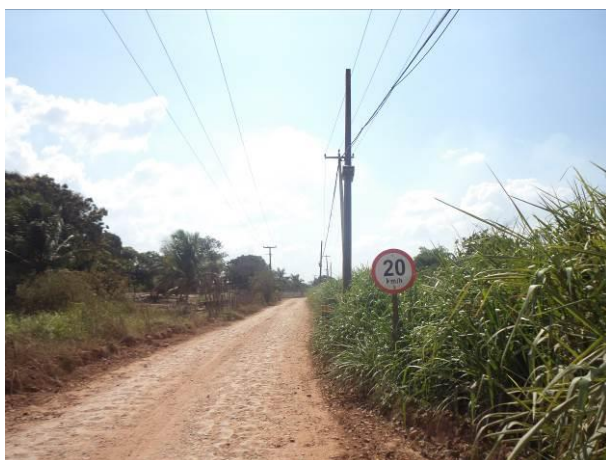
Foto 71: Sinalização existente no Acesso SI08, Santa Inês - MA.
