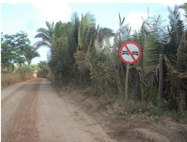
Foto 66: Sinalização existente no Acesso SI07, Monção - MA.
