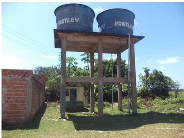
Foto 22: Poço artesiano e reservatórios de água presentes na localidade de São Vicente, Igarapé do Meio - MA.
