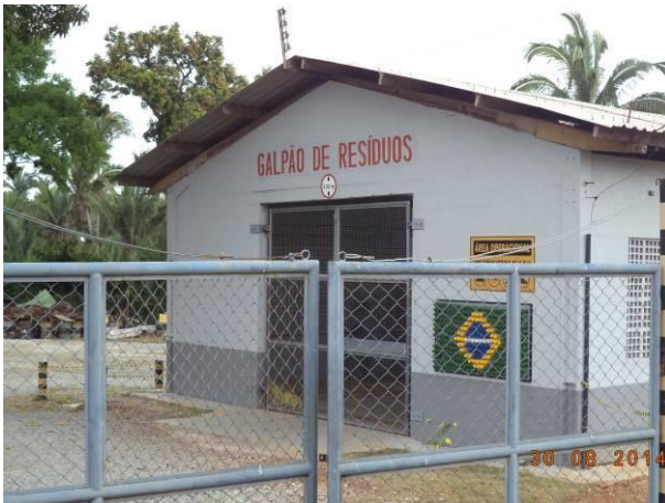
Foto 87: Galpão de Resíduos da EEFC no Acesso S110, Santa Inês - MA.
