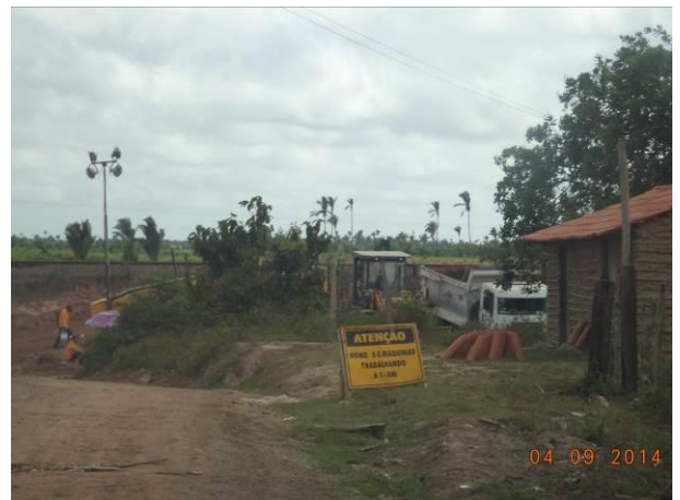
Foto 51: Canteiro de Obras presente no Acesso SI04, Igarapé do Meio - MA.
