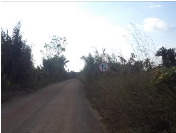
Foto 68: Sinalização vertical parcialmente coberta pela vegetação na via de Acesso SI07, Monção - MA.
