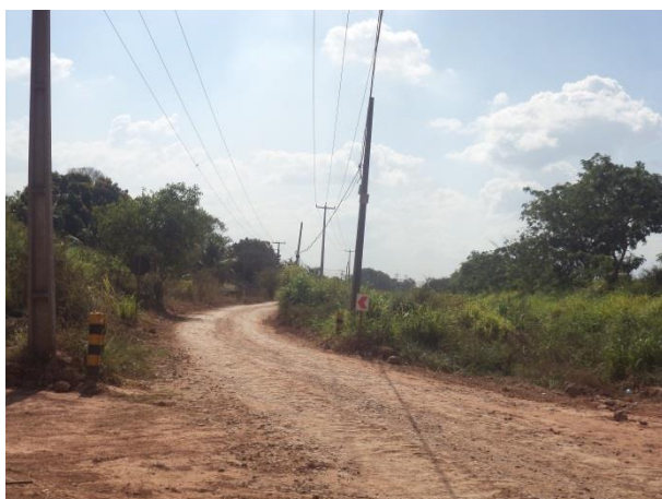
Foto 73: Condições de pavimentação do Acesso SI08, Santa Inês - MA.
