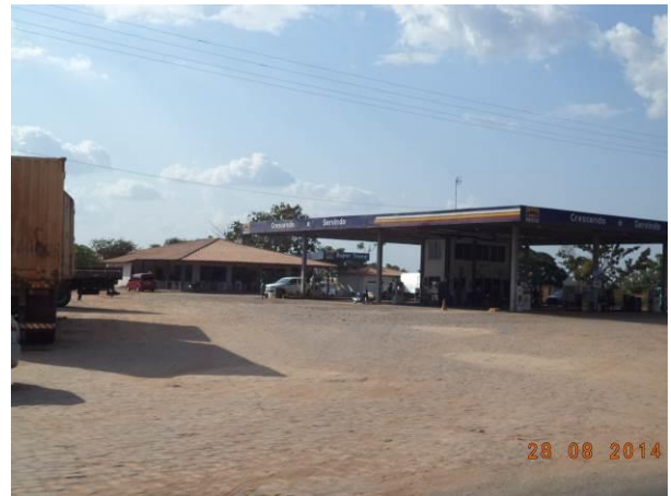
Foto 14: Posto de Combustível na localidade de Santa Filomena, Santa Inês - MA.
