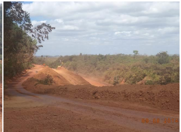
Foto 48: Trecho em obras no Acesso AC01B, Açailândia - MA.
