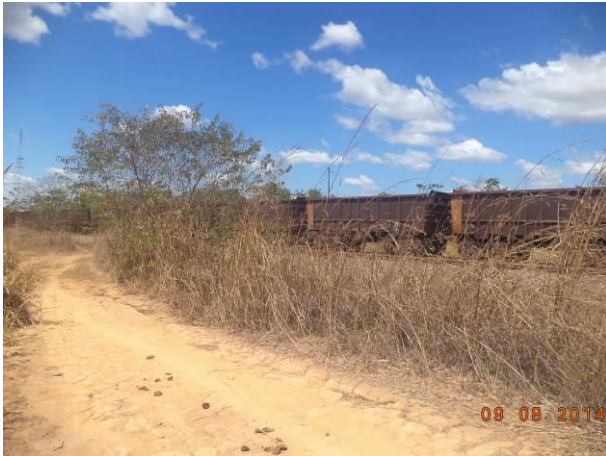
Foto 77: Término da via de Acesso AC03, Açailândia - MA.
