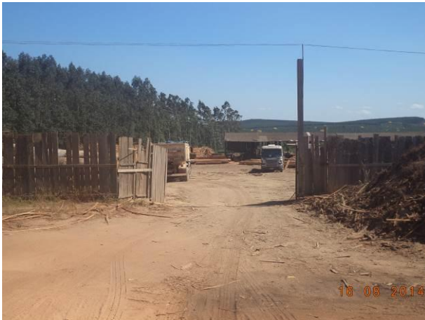
Foto 65: Madeira localizada Acesso AC02.1, Açailândia - MA.
