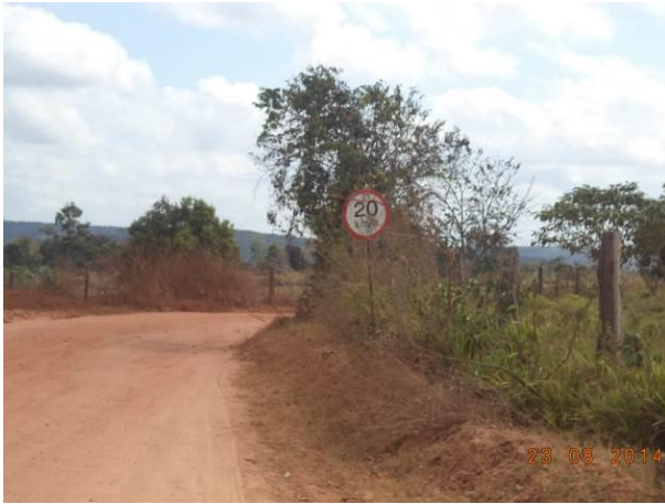
Foto 9: Sinalização parcialmente coberta pela vegetação na via de Acesso BJ03, Bom Jesus das Selvas, MA.
