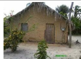
Residência a ser substituída
