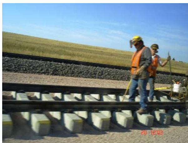
Foto 15: Verificação e correção manual do posicionamento dos trilhos longos soldados sobre dormentes de concreto
