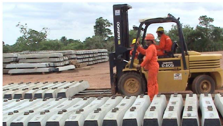
Foto 12: Dormentes em concreto protendido
