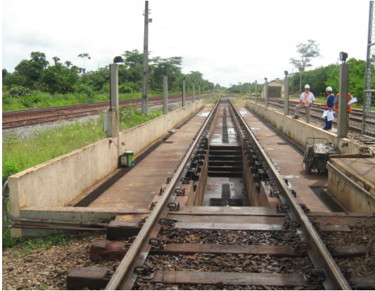
Foto 26: Plataforma de manutenção existente
