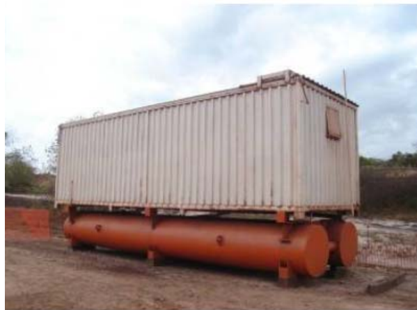
Foto 7: Modelo de tanques estanques para armazenamento de efluentes sanitários dos canteiros avançados
