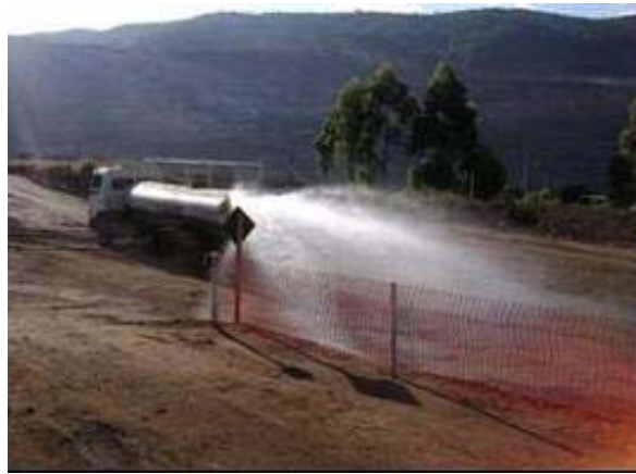
Foto 38: Aspersão de vias para minimização de suspensão de material particulado
