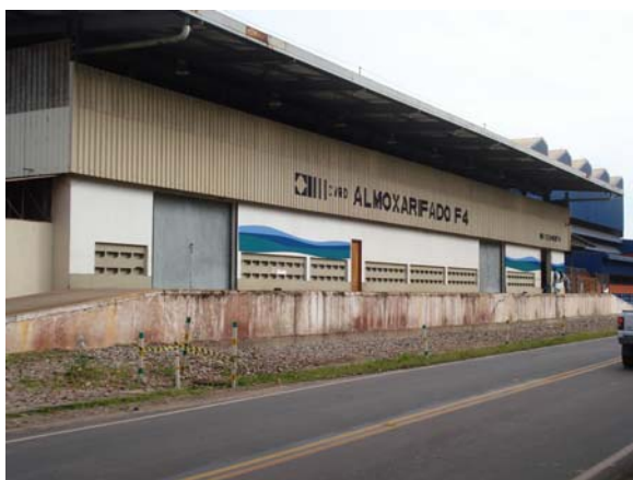
Foto 28: Armazém de peças existente em Marabá, que será ampliado
