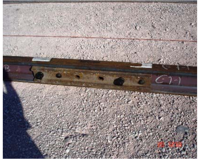
Foto 17: Visão das talas/ juntas de trilhos
