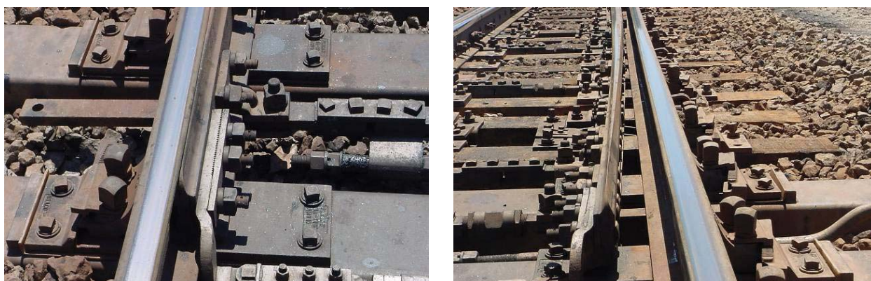
Foto 19 e Foto 20: Detalhes de uma agulha de AMV (exemplo)
