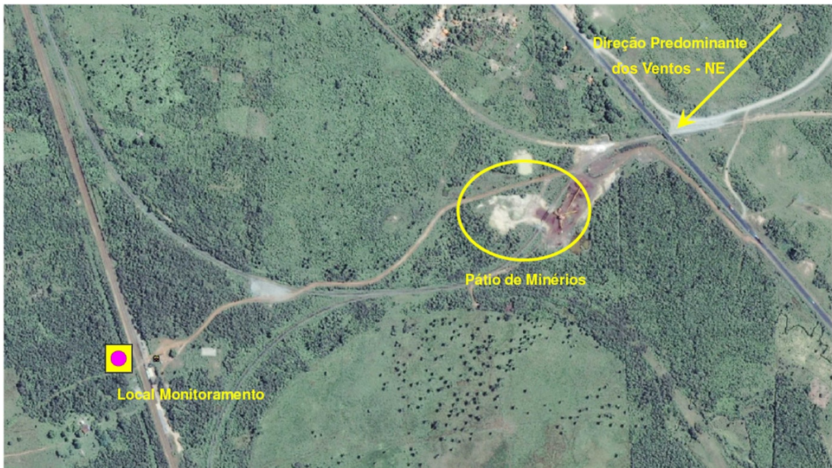
Figura 43: Estação de Monitoramento de Qualidade do Ar e Meteorologia – Entreposto Rosário
