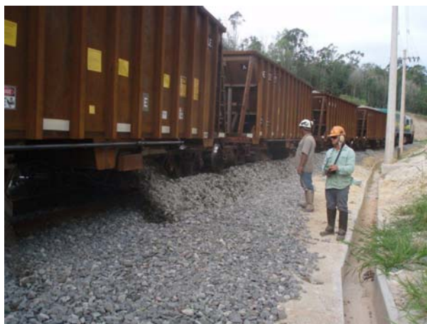
Foto 22: Lançamento do lastro via vagões com abertura inferior
