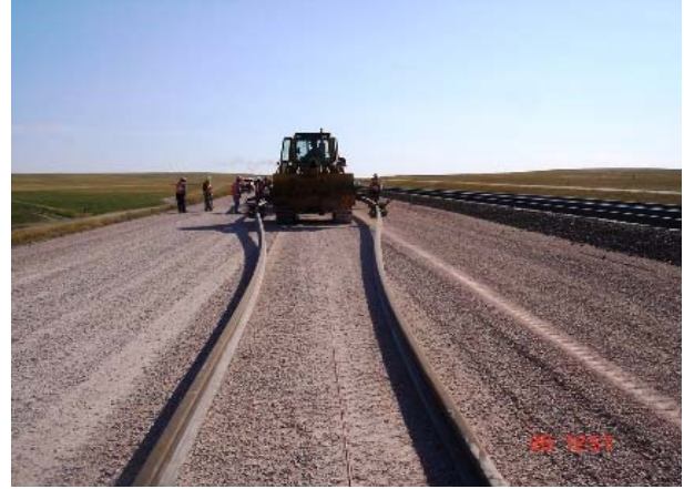
Foto 11: Sublastro concluído e lançamento dos trilhos na diretriz do projeto geométrico
