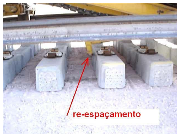
Foto 14: Exemplo de aplicação e re-espçamento de dormentes para montagem da grade ferroviária
