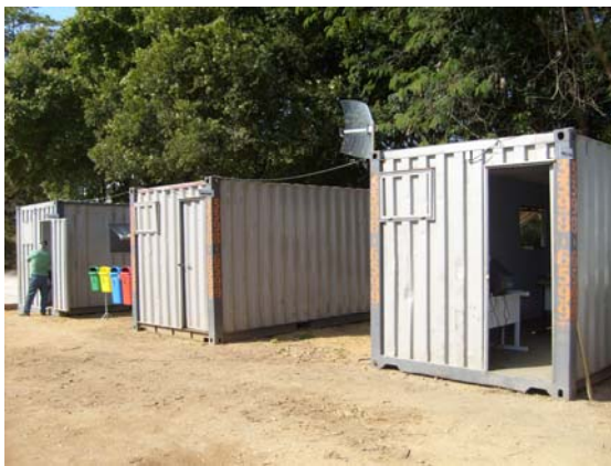
Foto 1 e Foto 2: Canteiro avançado com a utilização de containeres metálicos
