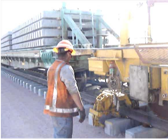
Foto 16: Fixação dos trilhos nos dormentes
