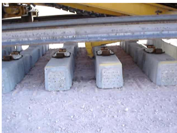
Foto 13: Exemplo de aplicação de dormentes de concreto sob trilhos guia
