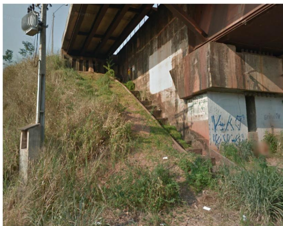
Figura 19. Escada de acesso dos canteiros de apoio a viga caixão
