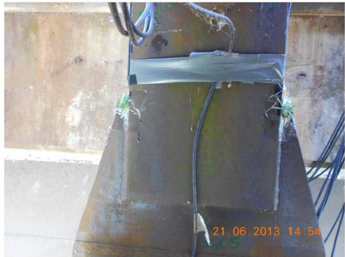
Figura 51 – Visão geral dos extensômetros instalados na solda.
