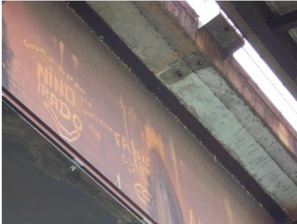
Figura 13 - Dreno jogando sobre o caixão.
