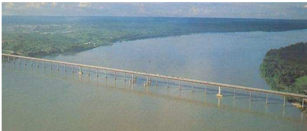
Figura 1 - Vista geral da Ponte
