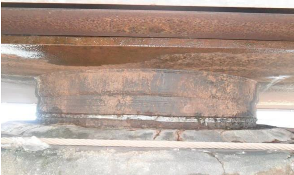
Figura 13 – Vista de um aparelho de apoio
