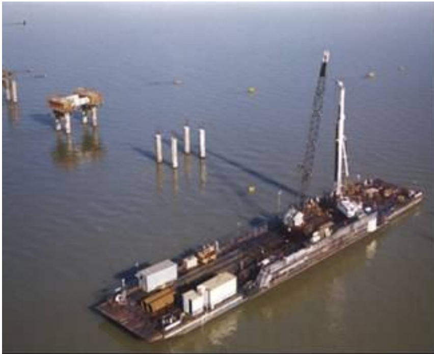
Figura 53 – Vista 1 do canteiro sobre flutuante
