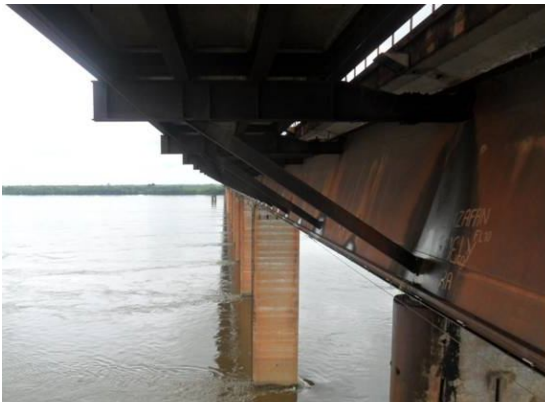
Figura 11 – Foto com vista da viga caixão metálico, travessas e diagonais do suporte rodoviário
