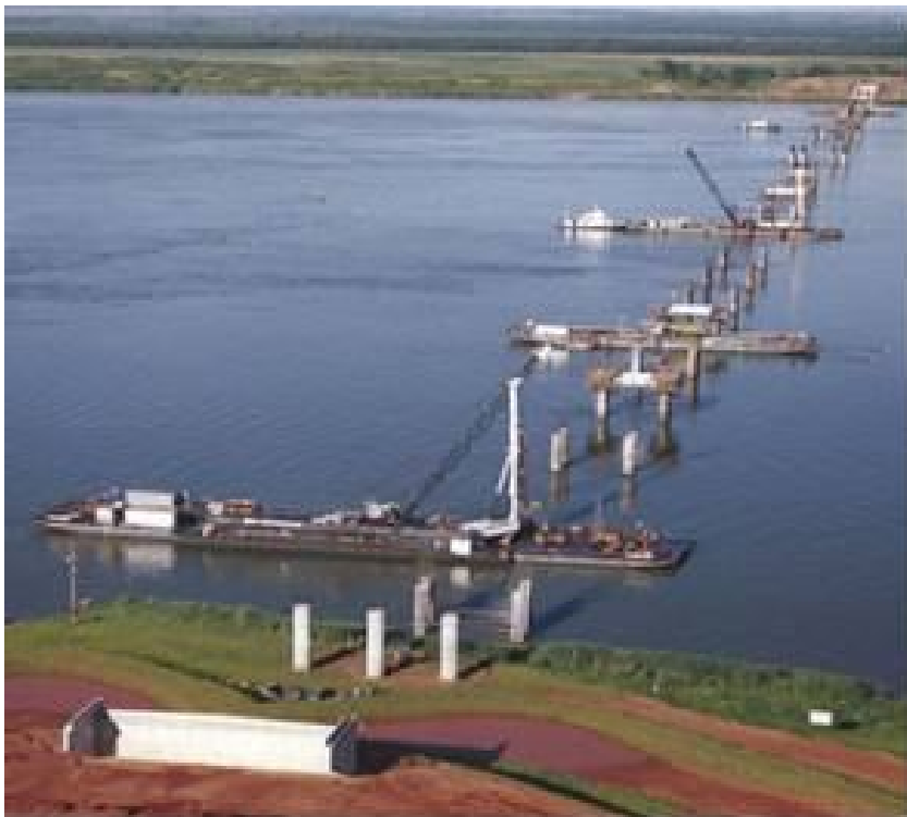
Figura 54 – Vista 2 do canteiro sobre flutuante
