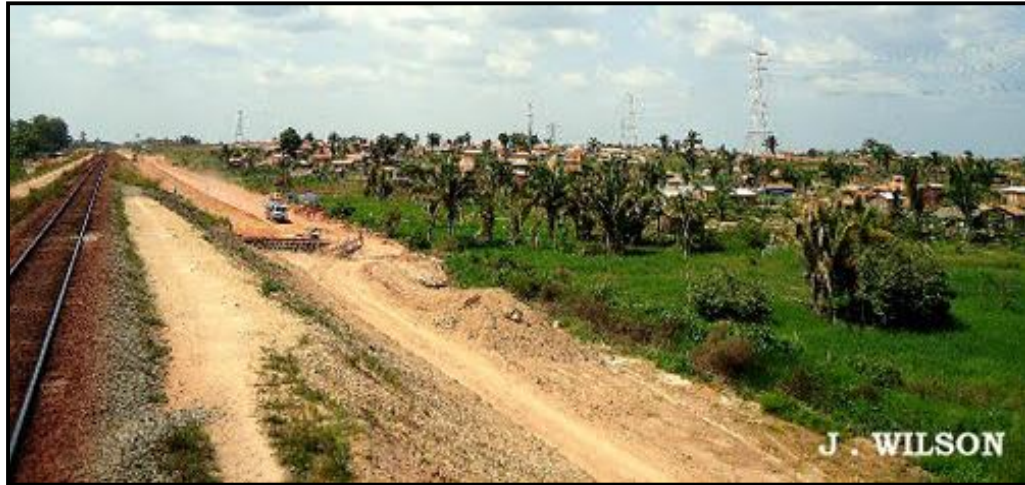
Figura 58 – Obras de Duplicação da Capacitação Logística Norte
