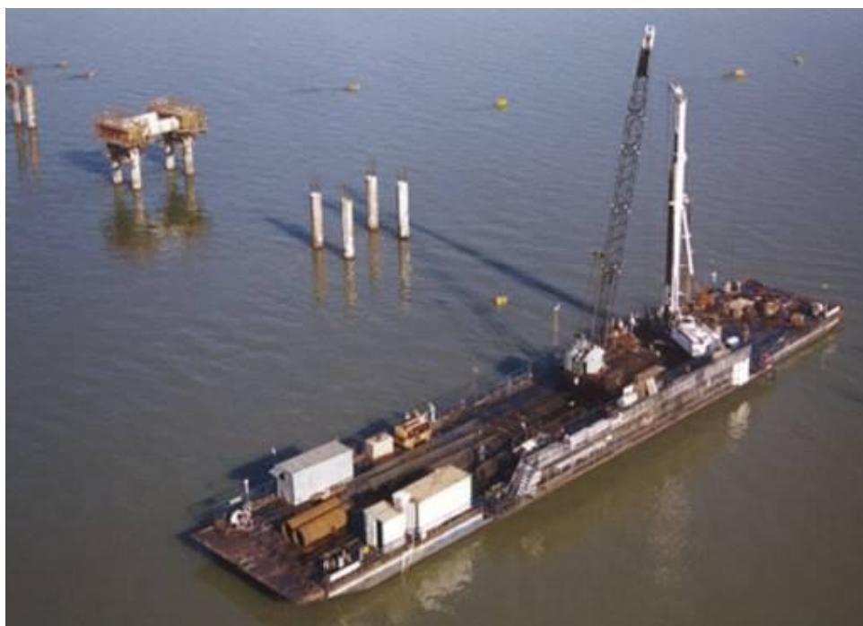
Figura 37 – Balsa da equipe de estaqueamento.
