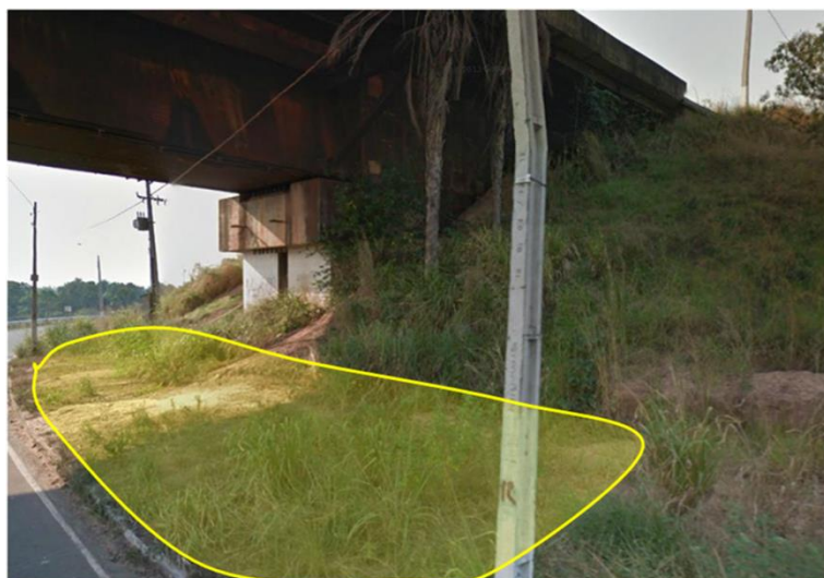
Figura 20. Área do Canteiro Avançado C3
