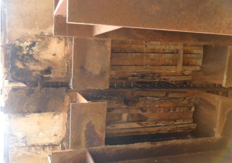
Figuras 11 e 12. Juntas de dilatação ferroviária
