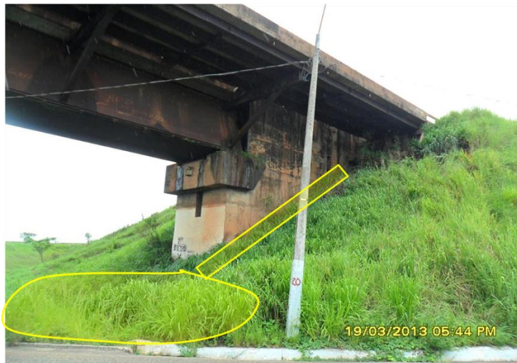
Figura 18. Área do Canteiro Avançado C2
