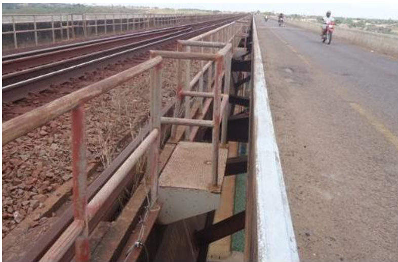
Figura 02. Vista do tabuleiro ferroviário e rodoviário
