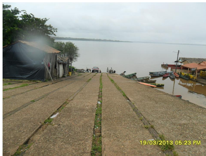
Figura 21. Vista da área de Apoio Fluvial C5
