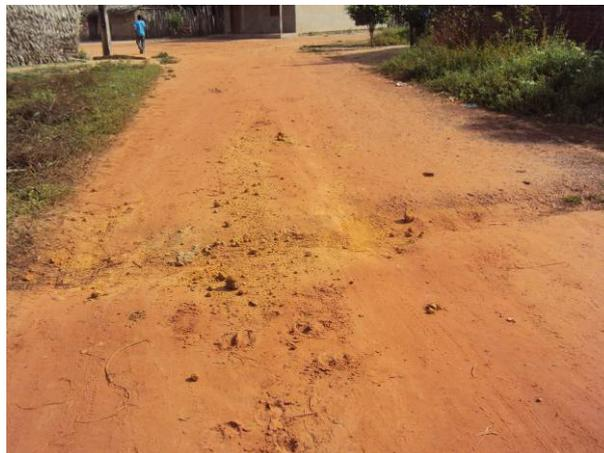
Foto 5.3-443: Vala feita na via pública para escoamento do esgoto. Três Bocas, Alto Alegre/MA. Fonte: Amplo, 2011.
