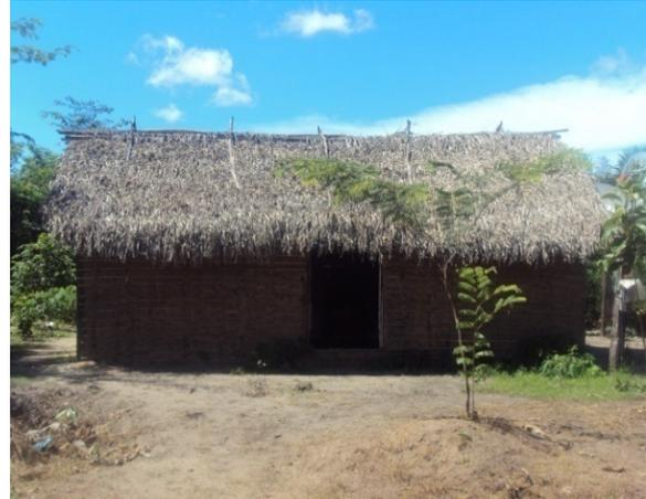
Foto 5.3-144: Tipologia construtiva de taipa. Boca do Campo, Arari/MA. Fonte: Amplo, 2011.
