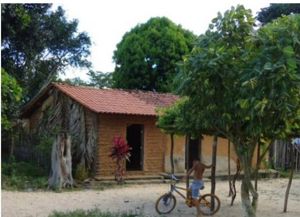
Foto 5.3-158: Casa de taipa com condições de risco. Escondido, Vitória do Mearim. Fonte: Amplo, 2011.
