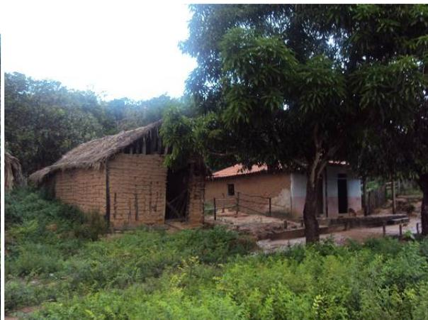
Foto 5.3-513: Habitação de taipa em condições precárias. Presinha, Alto Alegre do Pinaré/MA. Fonte: Amplo, 2011.
