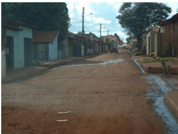
Foto 5.3-574: Rua calçada de bloquete. Detalhe para as águas servidas a céu aberto. Vila Ildemar, Açailândia/MA. Fonte: AMPLO, 2011.
