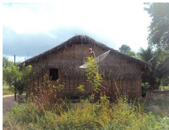
Foto 5.3-441: Casa com frestas na parede e na cobertura. Três Bocas, Alto Alegre do Pindaré/MA. Fonte: Amplo, 2011.
