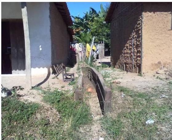
Foto 5.3-493: Canal aberto entre habitações para escoar o esgoto sanitário. Roça Grande, Alto Alegre do Pindaré/MA. Fonte: Amplo, 2011.
