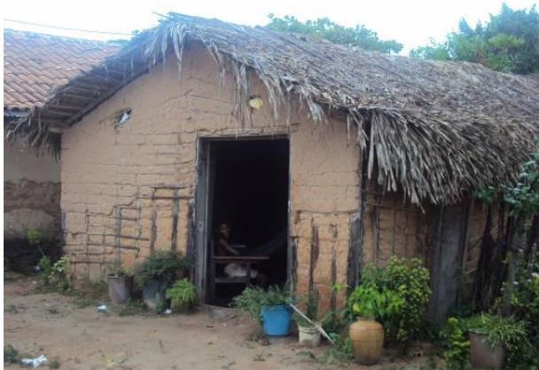
Foto 5.3-512: Habitação de taipa em precárias condições. Presinha, Alto Alegre do Pinaré/MA. Fonte: Amplo, 2011.
