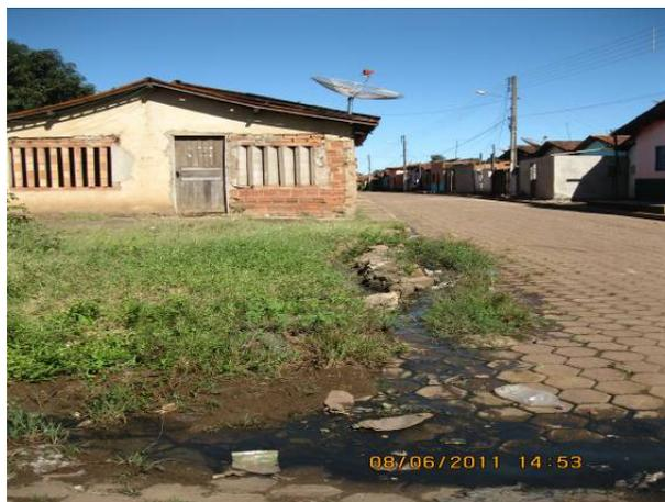
Foto 5.3-562: Esgoto a céu aberto. Pequía, Açailândia/MA. Fonte: Amplo, 2011.
