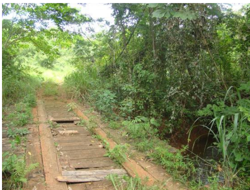
Foto 15 – Ponte na estrada de acesso às unidades amostrais da área 1.
