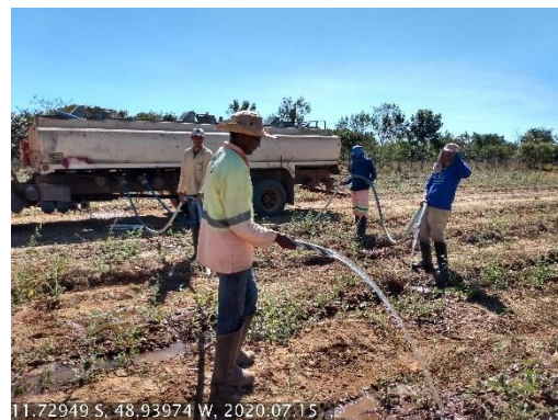
Foto N° 12: Irrigação na área 0103, TO 365, km 0924+000 - 0938+100, Data 15/07/20, Coordenadas Geográficas Decimais 11.72949 S; 48.93974 W
