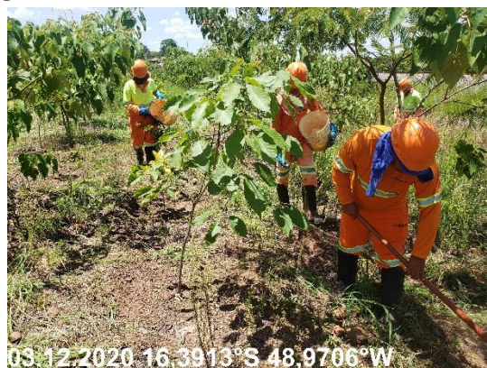
Foto N° 62: Coroamento da área 0302, Parque da Cidade, km 0045+900 - 0042+600, Data 03/12/20, Coordenadas Geográficas Decimais 16, 3913 S; 48,9706 W
