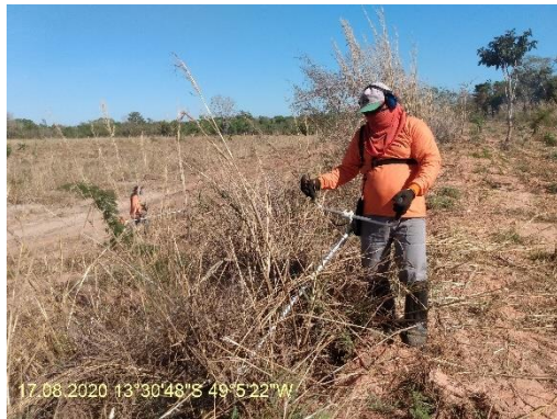
Foto N° 43: Roçada manual na área 0202, Mutunópolis, km 1112+500 - 1142+200, Data 17/08/20, Coordenadas Geográficas Decimais 13°30'48" S; 49°5'22" W
