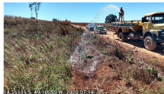
Foto N° 52: Irrigação de mudas na área , 0204C Uruaçu 2, km 1290+100 - 1350+000, Data 14/07/20, Coordenadas Geográficas Decimais 14,56131 S; 49,10059
