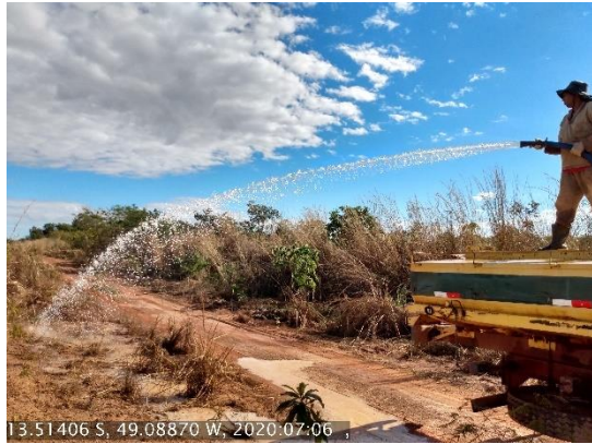
Foto N° 41: Irrigação da área 0202, Mutunópolis, km 1112+500 - 1142+200, Data 06/07/2020, Coordenadas Geográficas Decimais 13.51406 S; 49,08870 W
