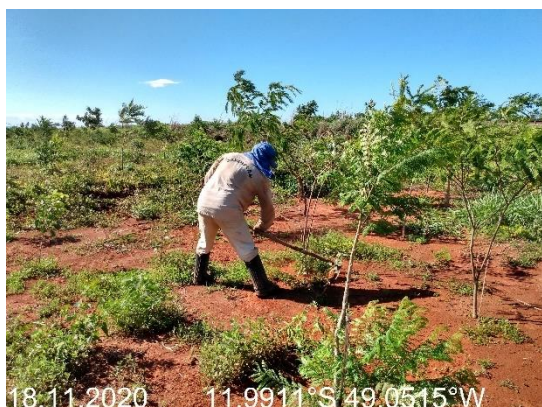
Foto N° 17: Coroamento na área 0105 Cariri, km 0962+800 - 0978+500, Data 18/11/20, Coordenadas Geográficas Decimais 11,9911 S; 49,0515 W
