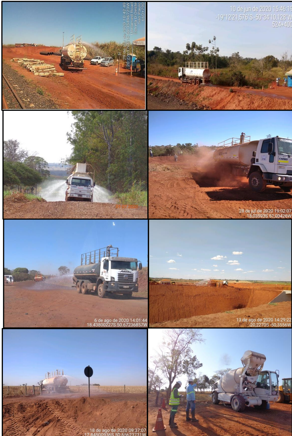
Figura 219 - Exemplos de controle de eventos críticos de emissões fugitivas de poeira com aspersão de água ao longo deste semestre (março – agosto/2020)
