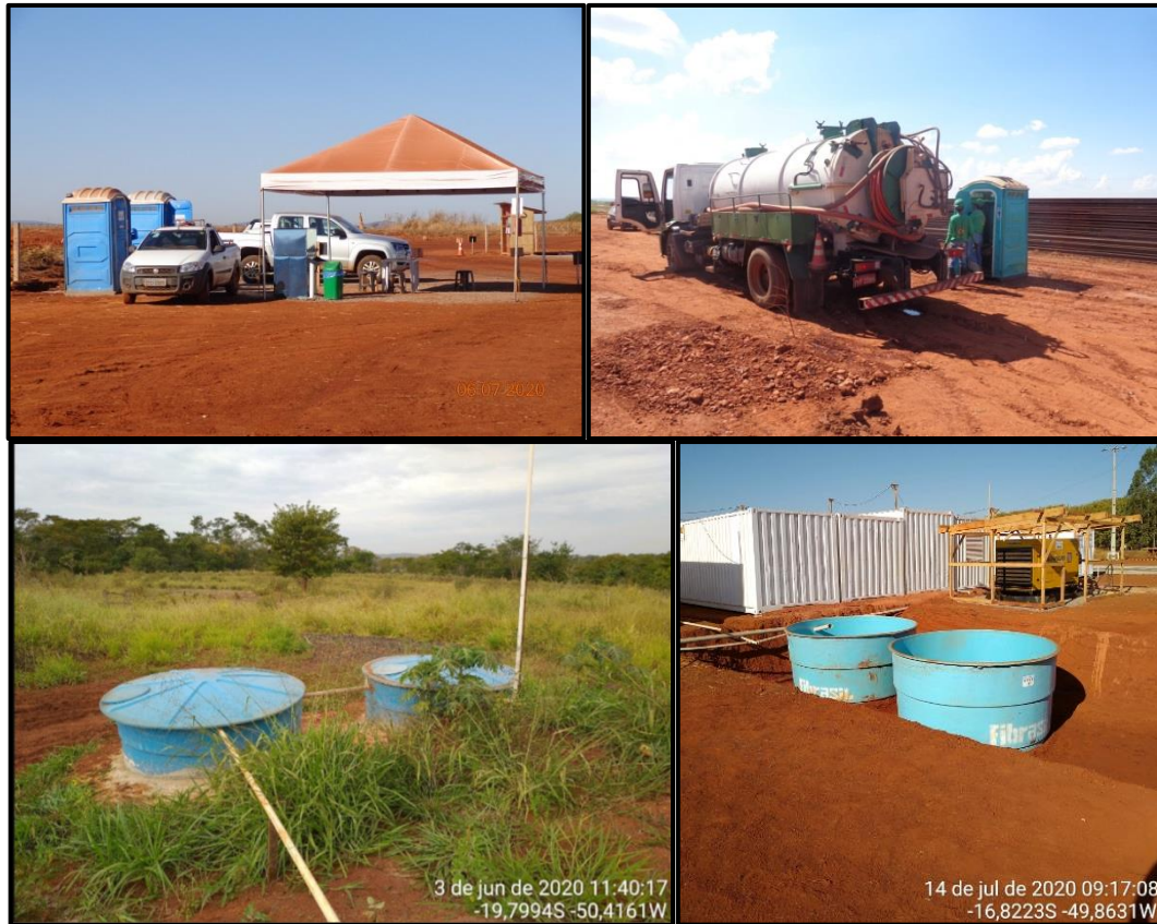
Figura 228 - Registros fotográficos relacionados ao programa de efluentes (banheiros químicos, limpeza sanitária e estruturas de armazenamento temporário de efluentes).
