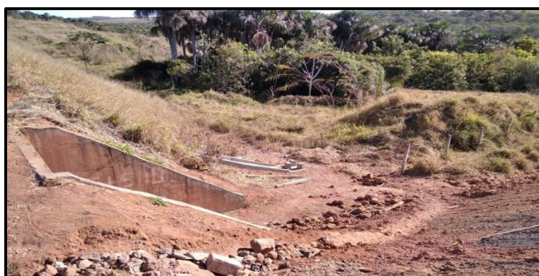
Figura 16 - Registro de acompanhamento 28/07/2020, trecho2(km 345 + 500).
