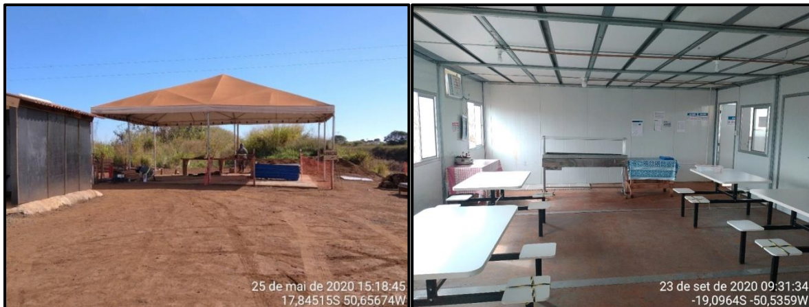
Figura 34 – Área de vivência do canteiro avançado PI Santa Helena (esquerda) e refeitório do canteiro avançado da Ponte Rio Paranaíba (direita).
