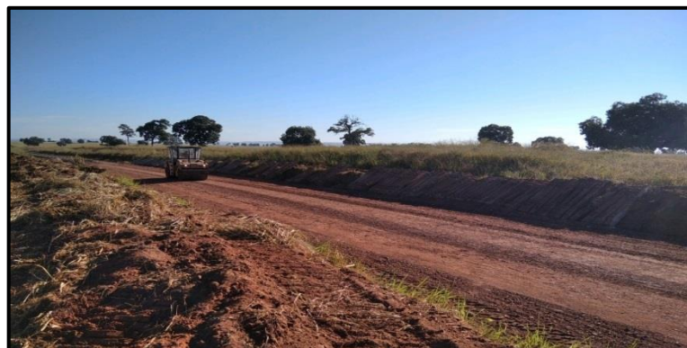
Figura 8 - Registro de acompanhamento 19/05/2020, trecho 2 (km 459 + 200).
