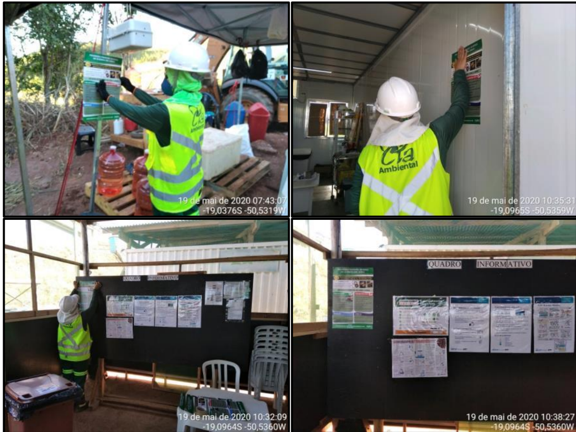
Figura 255 – Fixação de cartazes nos canteiros e frentes de obra (1).
