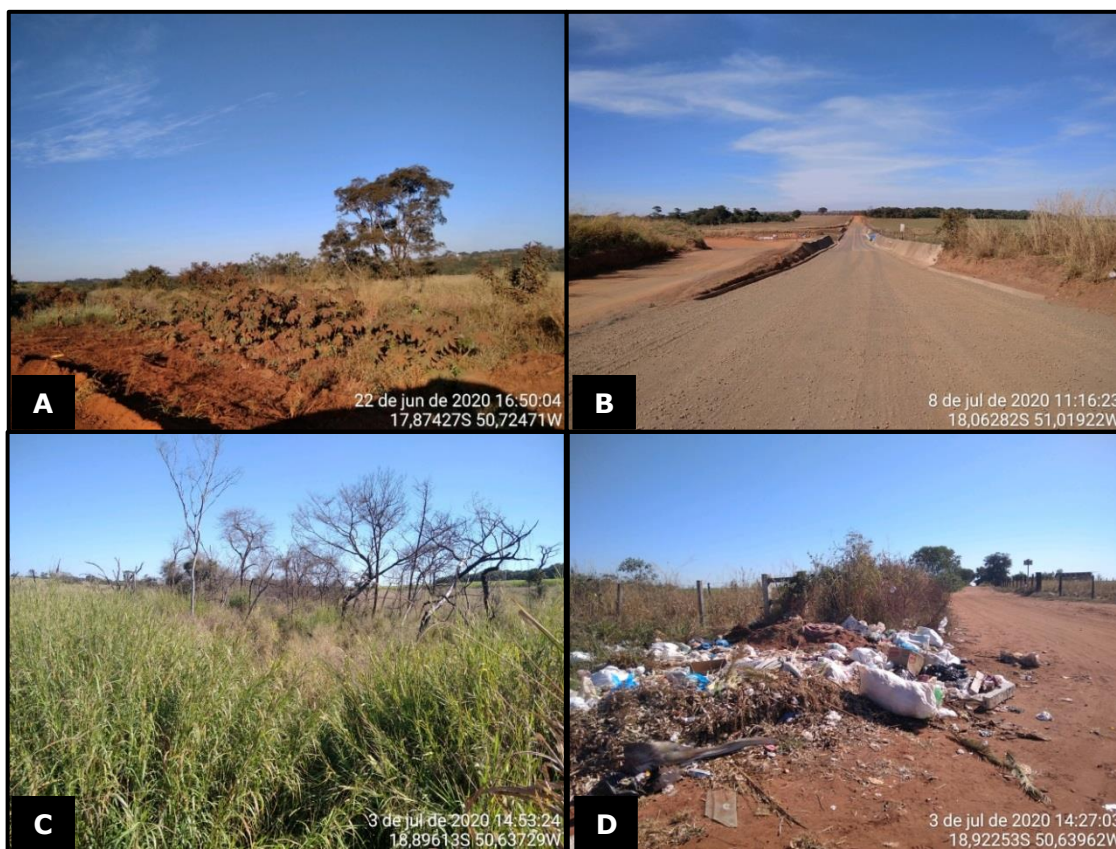
Figura 41 – Registro fotográfico dos pontos monitorados no trecho 2. A – Acompanhamento de revegetação no km 295+179. B – Construção de passagem inferior com sistema de drenagem no km 342+900. C – Corpo hídrico assoreado no km 473+060. D – Disposição inadequada de resíduos no km 476+580.
