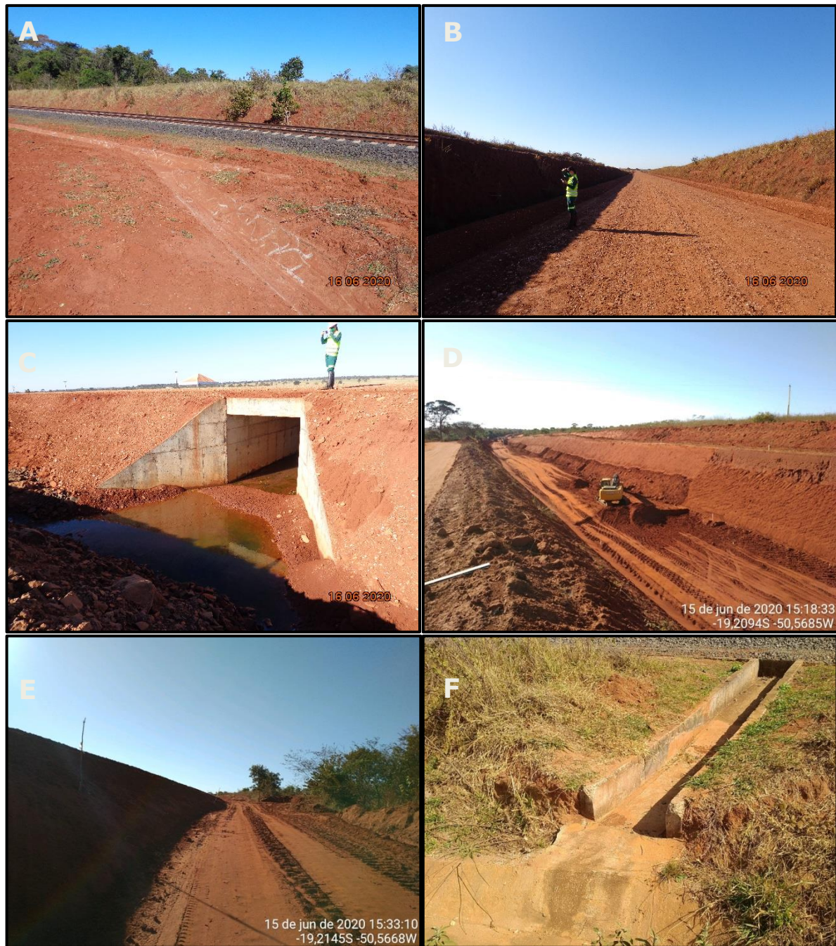
Figura 209 - Medidas executadas nas obras. Foto A - desobstrução de canaleta; foto B - retaludamento e reconformação de talude; foto C - desobstrução parcial de galeria; foto D - melhoria na via de acesso, retaludamento e reconformação de talude; foto E - retaludamento e reconformação de talude para preparação de revegetação (hidro-semeadura); foto F - desobstrução de canaleta.
