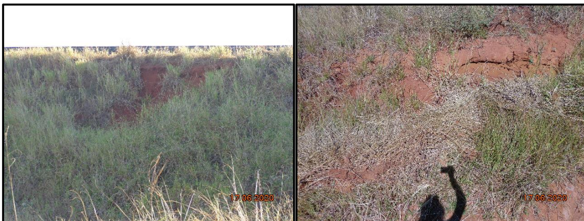
Figura 218 - Registro de fotográfico das condições de talude. Notar desenvolvimento da vegetação nos taludes.
