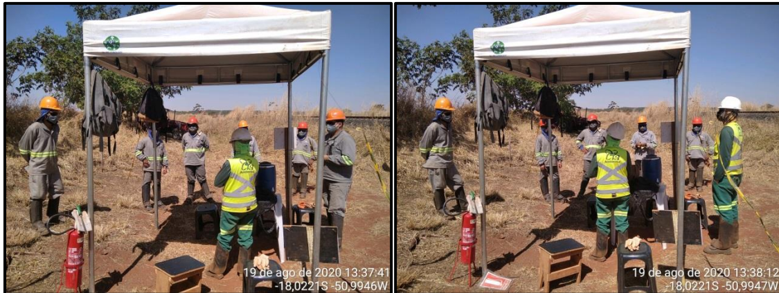
Figura 251 – DDS realizado na frente de obras (km 335+800) no dia 19/08/2020 em Rio Verde/GO.
