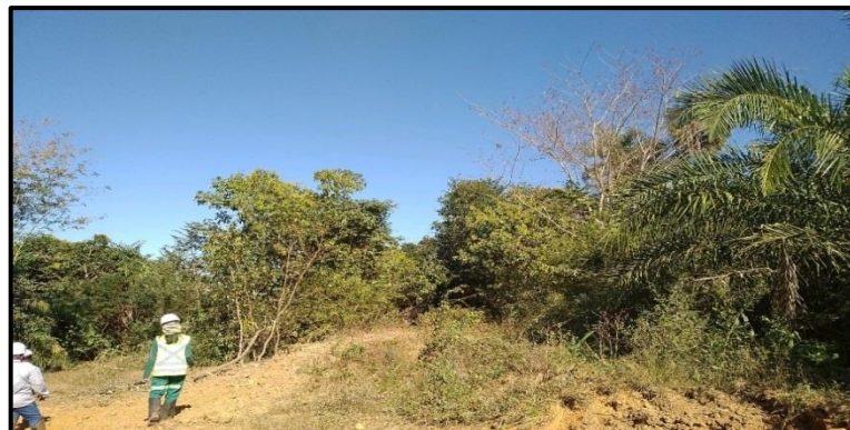
Figura 14 - Registro de acompanhamento 07/07/2020, trecho3(km 104 + 800).
