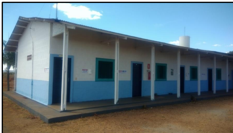
Figura 36 – Alojamento implantado no canteiro de obras de Goianira.
