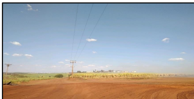
Figura 19 - Registro de acompanhamento 13/08/2020, trecho1(km 660 + 800).
