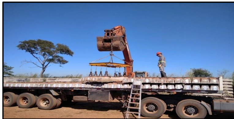
Figura 7 - Registro de acompanhamento 08/05/2020, trecho 2 (km 490 + 550).
