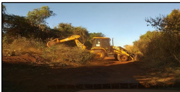
Figura 17 - Registro de acompanhamento 05/08/2020, trecho2(km 291 + 800).
