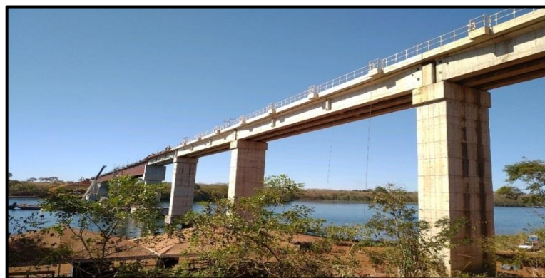
Figura 13 - Registro de acompanhamento 01/07/2020, trecho1(km 603 + 700).
