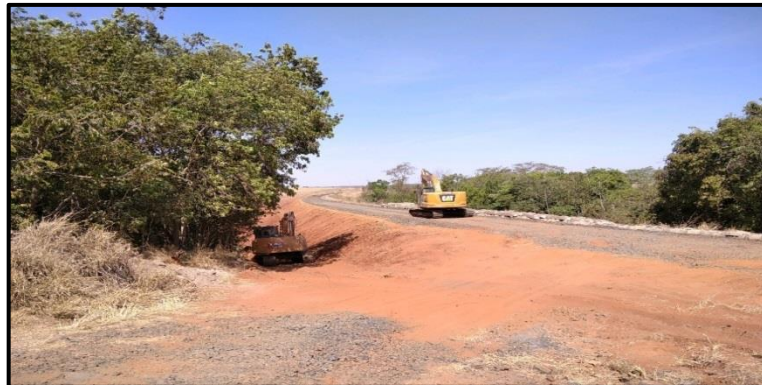
Figura 18 - Registro de acompanhamento 06/08/2020, trecho2(km 369 + 600).
