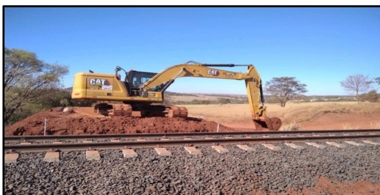
Figura 11 - Registro de acompanhamento 24/06/2020, trecho 2 (km 338 + 920).
