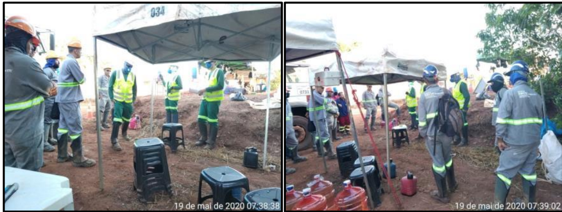
Figura 244 – DDS realizado na frente de obras (km 500+200) no dia 19/05/2020 em São Simão/GO.
