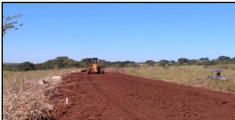
Figura 9 - Registro de acompanhamento 27/05/2020, trecho 2 (km 435 + 400).
