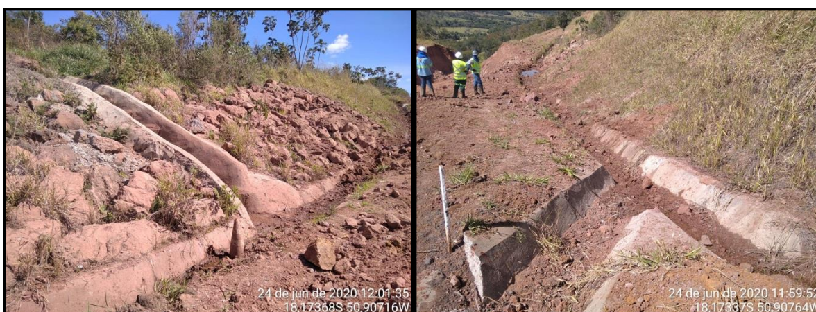
Figura 208 - Registro fotográfico do sistema de drenagem.
