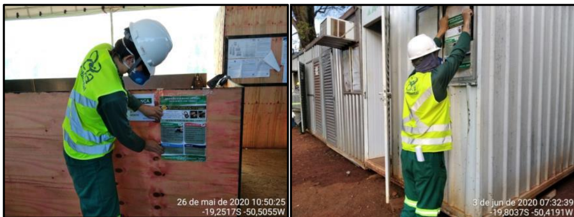
Figura 256 – Fixação de cartazes nos canteiros e frentes de obra (2).
