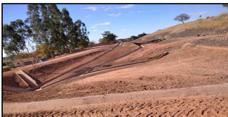
Figura 10 - Registro de acompanhamento 03/06/2020, trecho 2 (km 345 + 500).
