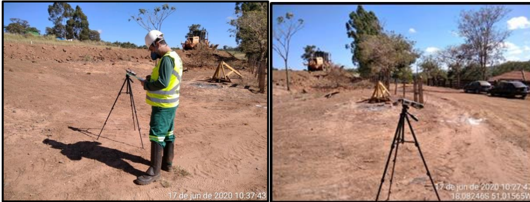
Figura 242 – Registro do monitoramento de ruído realizado no ponto F174 – P01 durante operação de maquinário da obra.
