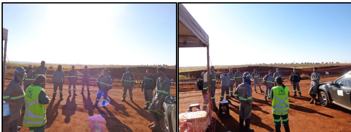
Figura 252 – DDS realizado no Pátio de Paranaiguara (km 456+300) no dia 27/08/2020 em Quirinópolis/GO.
