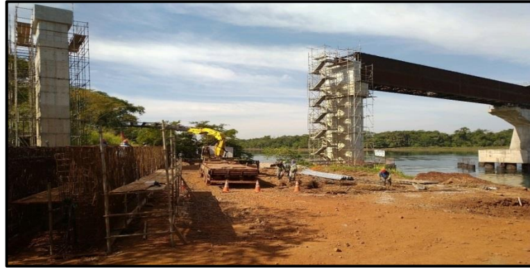
Figura 6 - Registro de acompanhamento 05/05/2020, trecho 1 (km 603 + 200).
