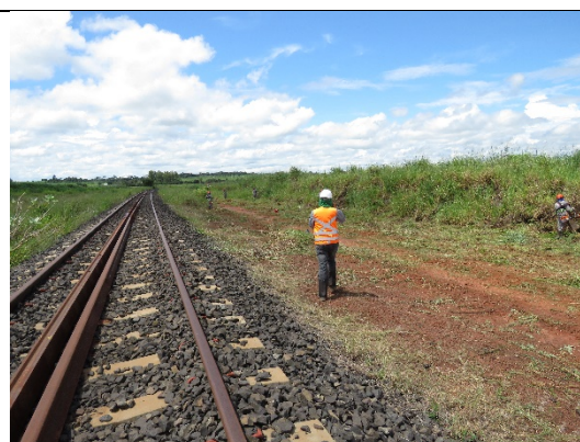
Foto 08. Equipe percorrendo trecho na faixa de domínio para a realização de limpeza de vegetação.
