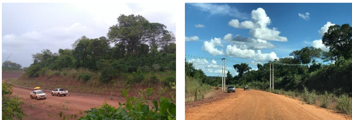
Figura 2.2.1- Passagem aérea de fauna instalada no Lote 4S (km 508+800).
