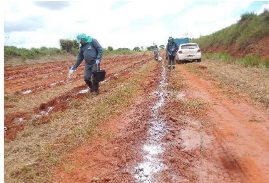
Figura 3.3.2 - Correção do solo em linha, km 646+500, Data 11/18, Datum SIRGAS 2000, Fuso: 22 L, Coordenadas 567032/7765192
