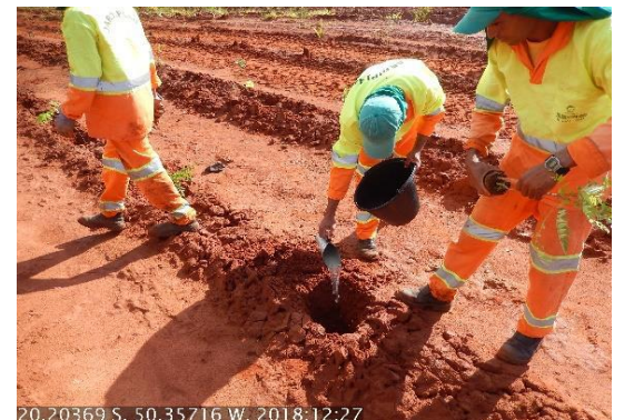
Figura 3.3.6 - Aplicação de gel de plantio na cova, Km 645+500, Data 27/12/18, Datum SIRGAS 2000, Fuso: 22 L, Coordenadas 567219/7766555
