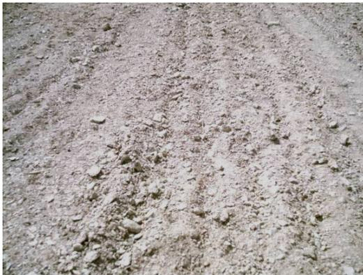
**Foto 4-11** Recuperação ambiental dos acessos utilizados pela obra, onde foi realizada a escarificação do terreno
