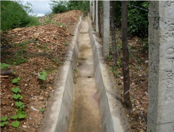
**Foto 3-7** Padrão de valeta de crista construída em área de corte, para proteção dos taludes de processos erosivos.
