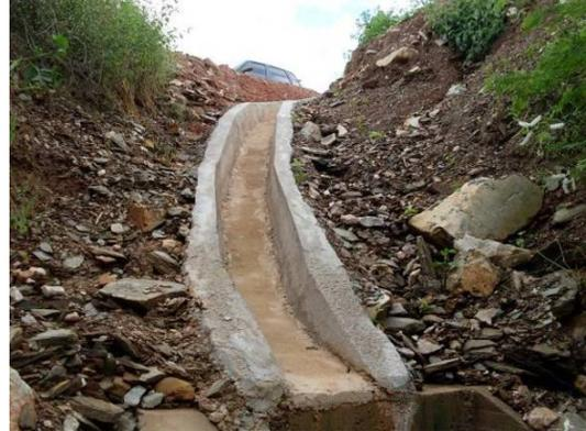
**Foto 3-6** Padrão de descida d' água construída para direcionamento das águas pluviais
