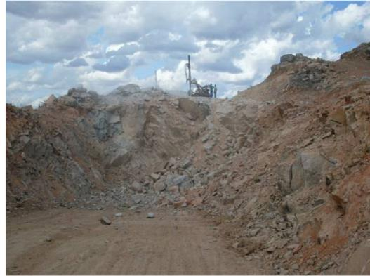
**Foto 3-3** Corte para abertura do túnel sob a CE 293, com desmonte de rochas por explosivos, estaca 16.797, Abaiara/CE.
