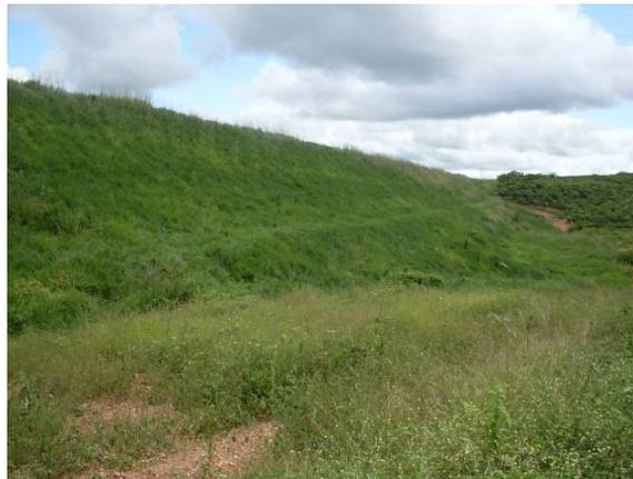
**Foto 3-11** Talude de aterro com a revegetação implantada no trecho 1.
