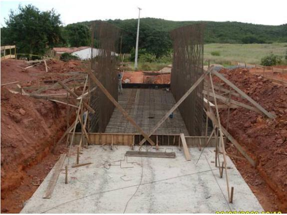
**Foto 3-9** Lançamento de concreto para base de viaduto.
