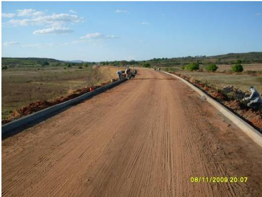
**Foto 3-4** Construção de meio fio no Trecho 1.
