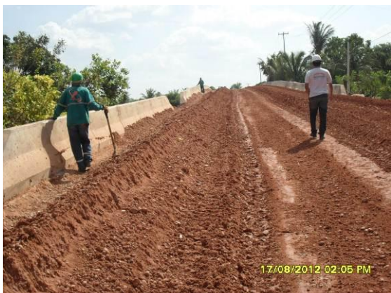
Foto 3-11 Preparação do solo para colocação de asfalto no viaduto de Porteiras-CE. Estaca 15448.
