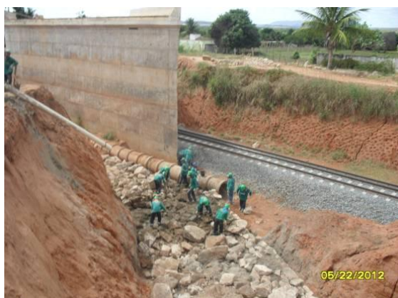
Foto 4-9 Construção do muro de arrimo no viaduto com que dá acesso a cidade de Porteiras-CE, estaca 15436.
