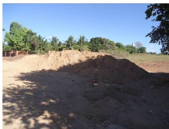
Foto 4-75 Areia sem uso na frente de serviço do viaduto de Porteiras.
