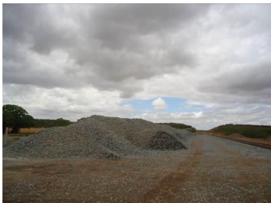
Foto 4-72 Brita estocada próxima a estaca 16936.
