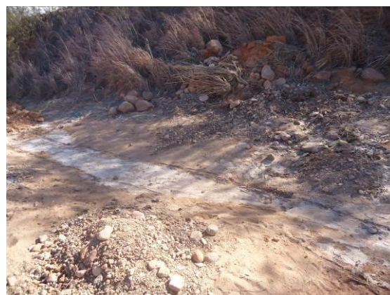
Foto 4-57 Resíduos de cimento contaminando o solo próximo à estaca 16924.
