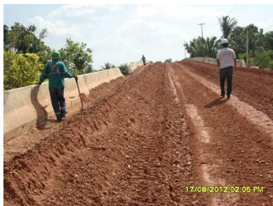
Foto 4-8 Aterramento do viaduto de Porteiras, estaca 15448.
