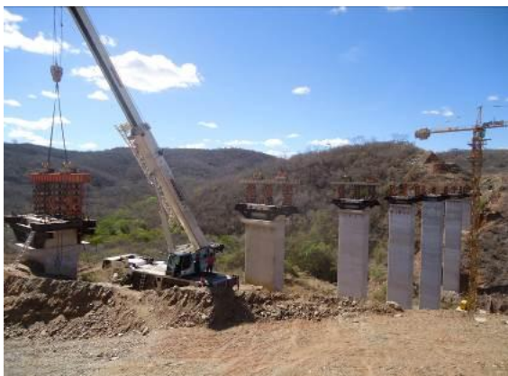
Foto 4-11 Preparação para instalação das vigas de ligação na ponte do riacho Jardim, estaca 14395.
