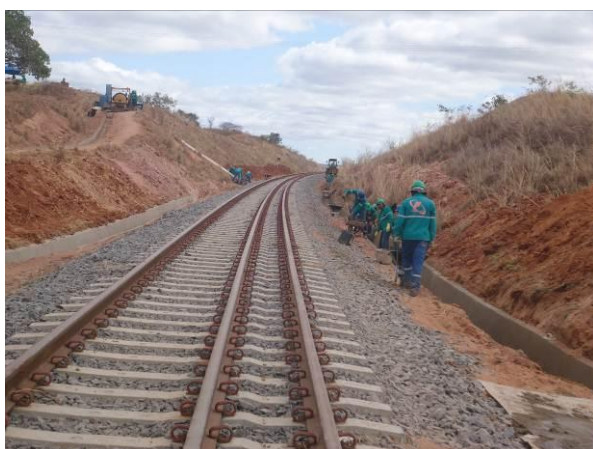
Foto 3-7 Construção das canaletas na estaca 16103.
