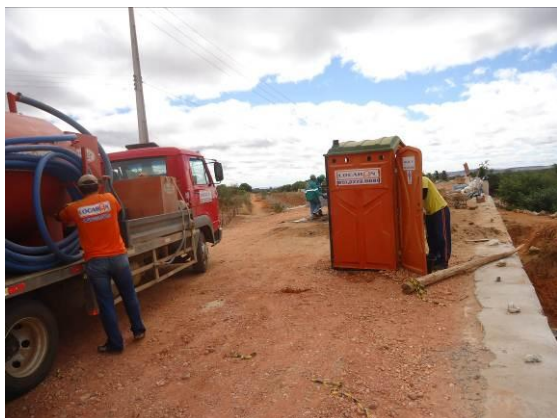
Foto 4-38 Colaboradores realizando a higienização do banheiro químico próximo a estaca 15448.
