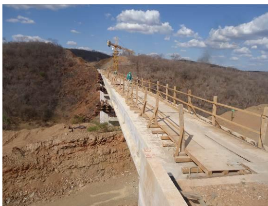
Foto 4-14 Preparação da estrutura para colocação das pré-lajes, estaca 14395.
