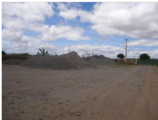
Foto 4-77 Insumo (brita) depositado no canteiro avançado do Consórcio TIISA/CMC, em Brejo Santo-CE
