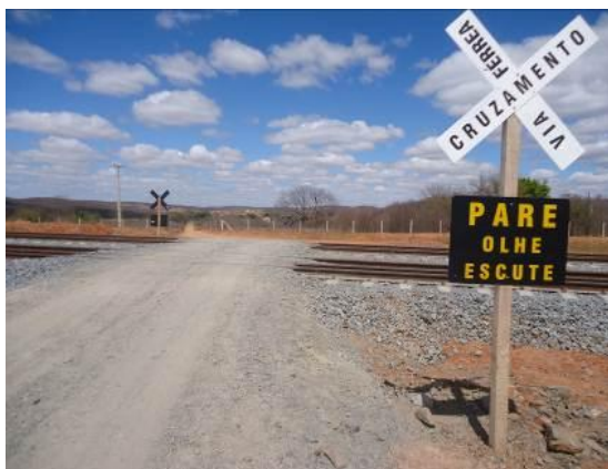
Foto 3-22 Passagem de Nível (PN) com sinalização na estaca 14736.
