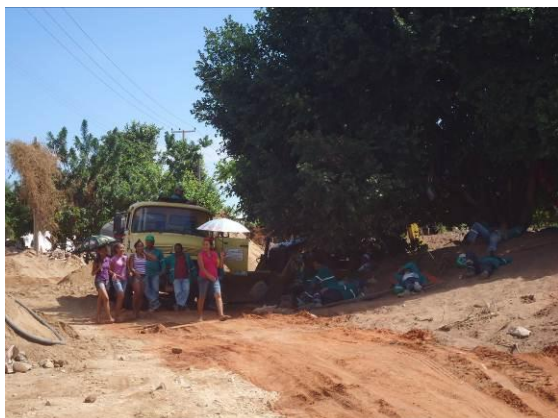
Foto 4-24 Frente de serviço da POLLIAN para a construção do viaduto de Porteiras, estaca 15448 .
