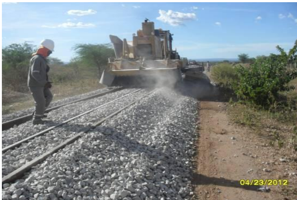
Foto 3-19 Máquina realizando o socamento da brita, estaca 13510.
