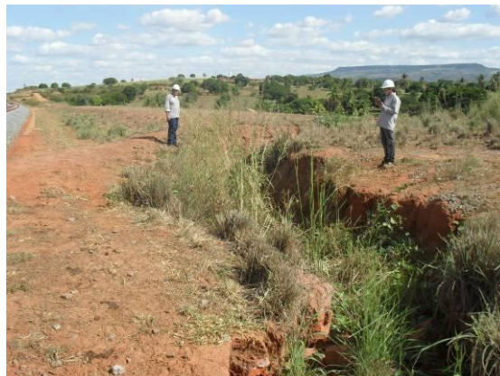
Foto 4-6 Vistoria no trecho MVS pela equipe da ARCADIS logos para atualização dos pontos erosivos.
