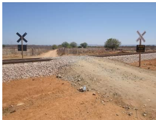
Foto 3-23 Vista da PN instalada na estaca 13641, destacando-se a sinalização vertical.
