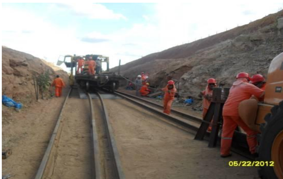
Foto 3-20 Frente de serviços da superestrutura, estaca 14085.
