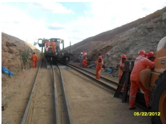
Foto 4-83 Frente de serviços da superestrutura, estaca 14085.
