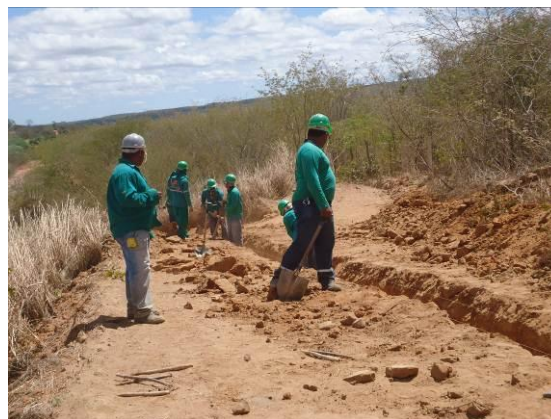
Foto 3-4 Construção de canaletas de drenagem de águas superficiais na estaca 16913.
