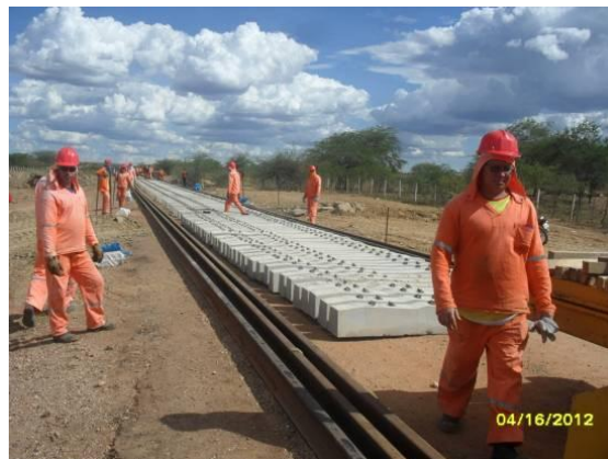
Foto 4-81 Frente de serviços da superestrutura, estaca 13520.
