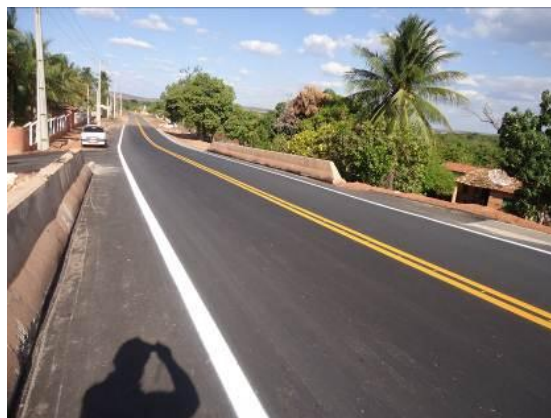
Foto 3-25 Obra concluída no viaduto de Porteiras-CE, estaca 15448.
