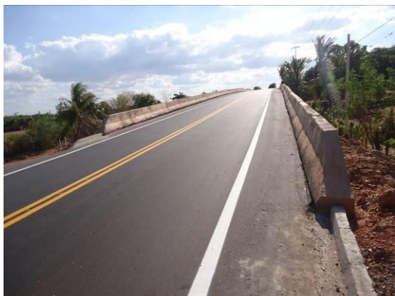
Foto 3-24 Conclusão dos serviços de construção do viaduto de Porteiras-CE com asfalto e sinalização horizontal, estaca 15448.
