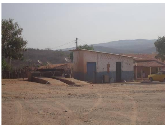
Foto 4-32 Vista parcial das instalações da Oficina Mecânica (SUPEQ) da EIT no Café da Linha-CE.
