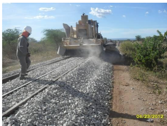
Foto 4-82 Máquina realizando o socamento da brita, estaca 13510.
