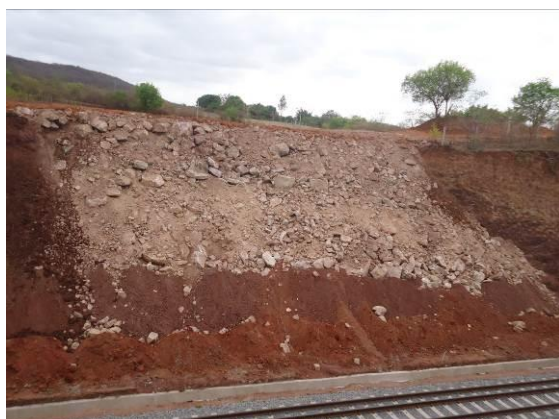
Foto 3-13 Trabalho de contenção de processo erosivo na estaca 15804.
