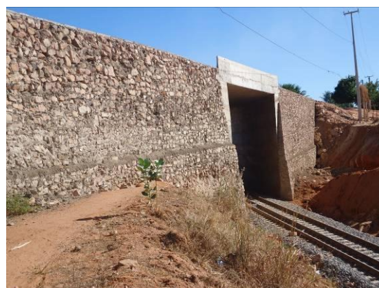
Foto 4-10 Muro de arrimo do viaduto de Porteiras, estaca 15448, concluído.
