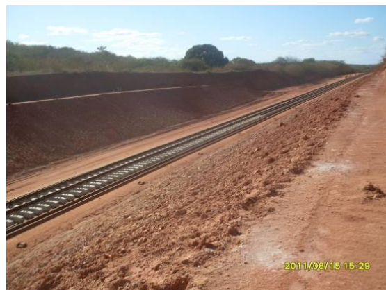
Foto 4-84 Andamento da obra da superestrutura, estaca 16167.
