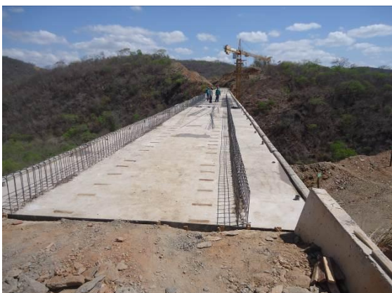
Foto 3-26 Preparação da estrutura para colocação de concreto, estaca 14395.
