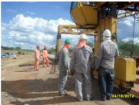
Foto 4-80 Frente de serviços da superestrutura, estaca 13516.
