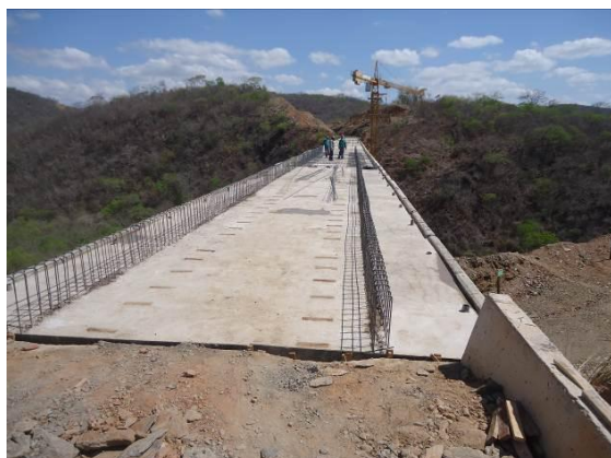
Foto 3-9 Preparação da estrutura para colocação de concreto. Estaca 14395
