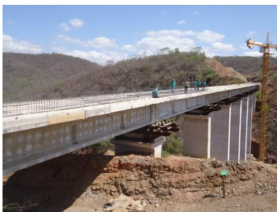
Foto 4-16 Instalação das lajes e montagem das ferragens na ponte sobre o riacho Jardim, Jati-CE, estaca 14395.
