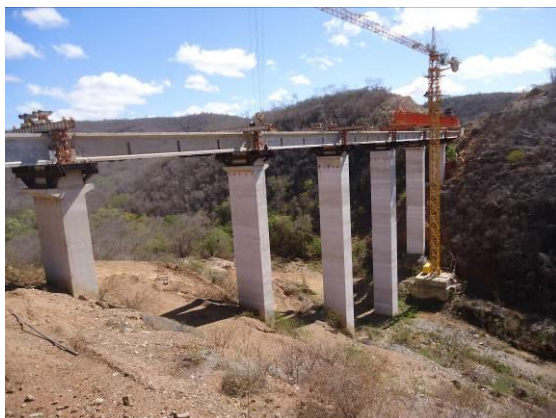
Foto 3-5 Instalação das vigas de ligação na ponte sobre o riacho Jardim. Estaca 14395
