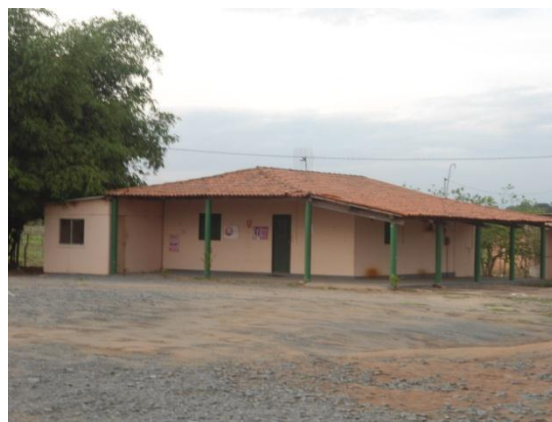
Foto 4-35 Canteiro administrativo da TIISA/CMC após a limpeza da área em Brejo Santo-CE.
