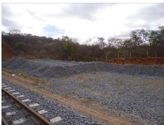
Foto 4-78 Insumo (brita) depositado na estaca 14476.
