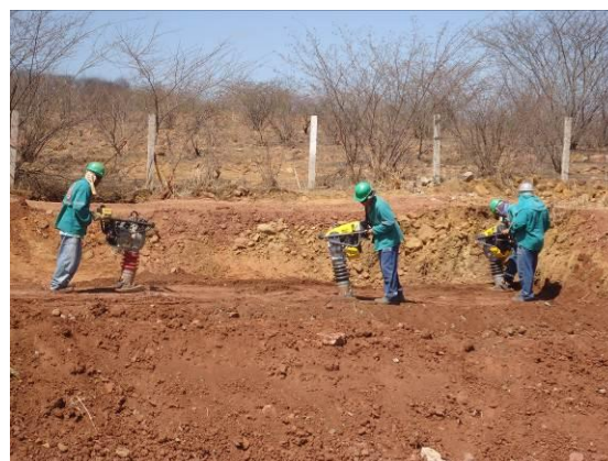
Foto 3-14 Compactação do solo em recuperação de erosão na estaca 16963.
