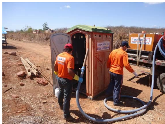
Foto 4-39 Limpeza de banheiro químico na estaca 16963.
