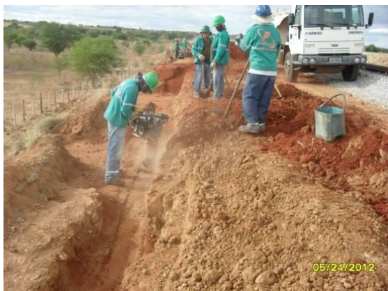
Foto 3-15 Recuperação de taludes danificados pelas chuvas, estaca 13764.
