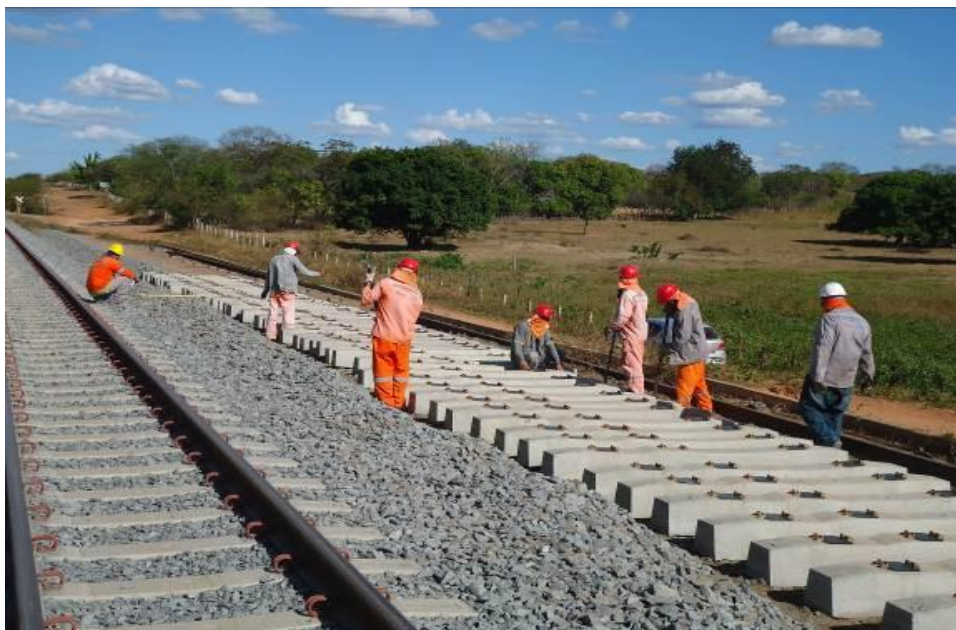
Foto3-21 Atividades na superestrutura no trecho MVS, próximo a estaca 17457.
