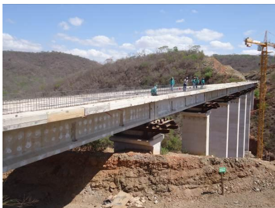
Foto 3-27 Instalação das lajes e montagem das ferragens na ponte sobre o riacho Jardim, Jati-CE. Estaca 14395.
