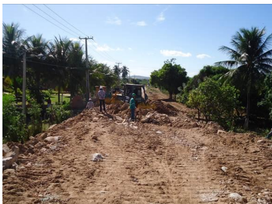
Foto 4-7 Aterro para ligação entre a rodovia e o viaduto, estaca 15448.
