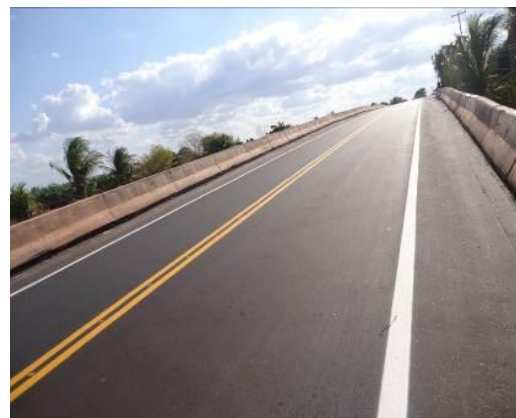
Foto 3-12 Colocação de asfalto e sinalização horizontal no viaduto de Porteiras-CE, estaca 15448.
