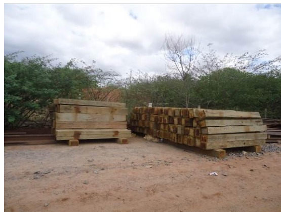
Foto 4-73 Dormentes estocados próximos a estaca 16936.
