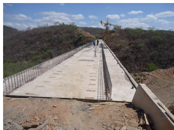
Foto 4-15 Preparação da estrutura para colocação de concreto, estaca 14395.
