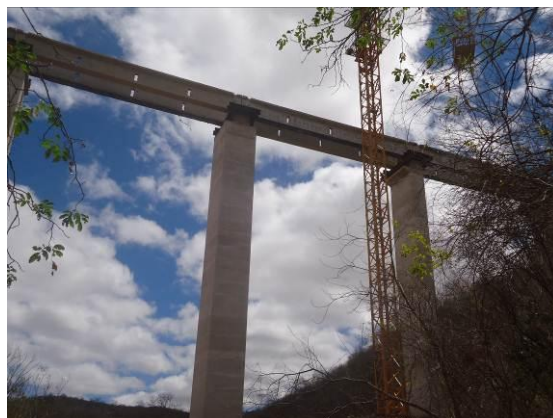
Foto 3-6 Instalação das vigas de ligação na ponte sobre o riacho Jardim. Estaca 14395.
