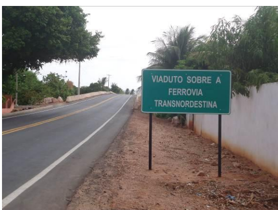
Foto 3-17 Obra concluída no viaduto de Porteiras-CE. Estaca 15448.
