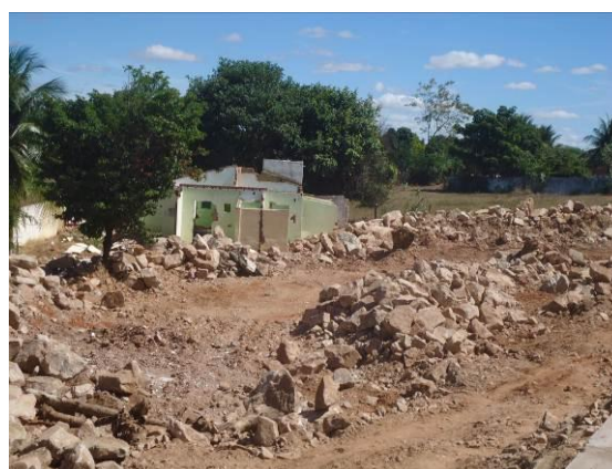
Foto 4-76 Sobra de material próximo a estaca 15432
