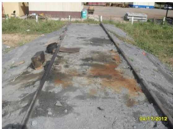
Foto 4-89 Solo contaminado no local de estacionamento de locomotiva, estaca 15722.
