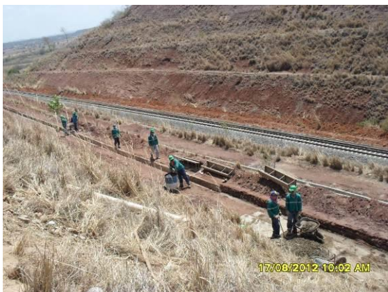
Foto 3-3 Construção de canaletas de drenagem de águas superficiais na estaca 16576.
