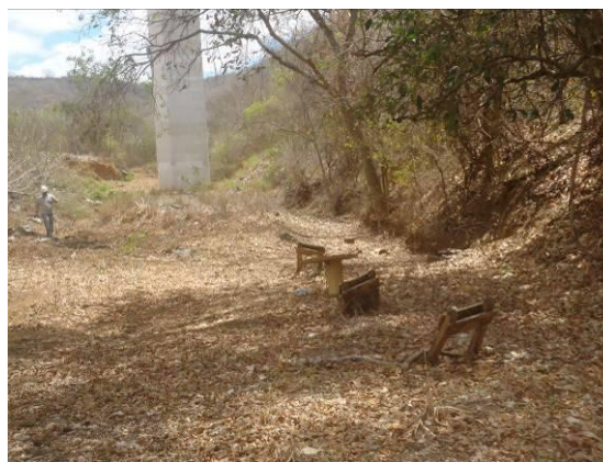
Foto 4-59 Estrutura para armação de ferragem dentro do leito do riacho Jardim/CE estaca 14403.
