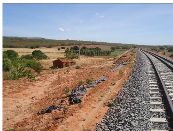
Foto 4-49 Lonas plásticas espalhadas ao longo do trecho de atuação da TIISA.
