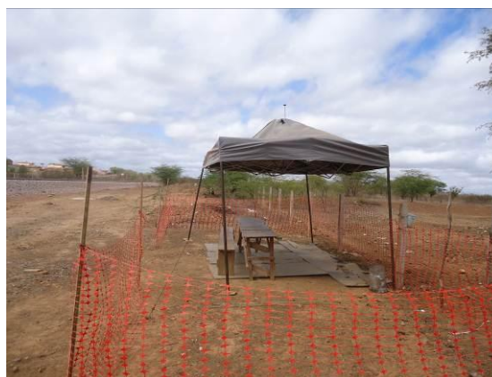
Foto 4-18 Tenda para refeições dos colaboradores da TIISA, fora dos padrões da NR 18 próximo à estaca 13513.
