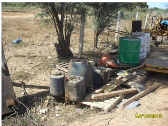
Foto 4-44 Baldes e tambores contendo óleo lubrificante sem bandeja de contenção juntos com madeiras na faixa de domínio, estaca 13514.
