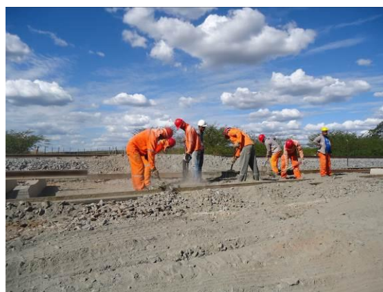
Foto 4-86 Atividades na superestrutura no trecho MVS, próximo à estaca 17457.
