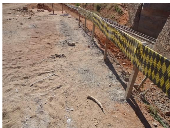
Foto 4-51 Contaminação do solo na área de estoque de cimento no canteiro de obras do viaduto de Porteiras.
