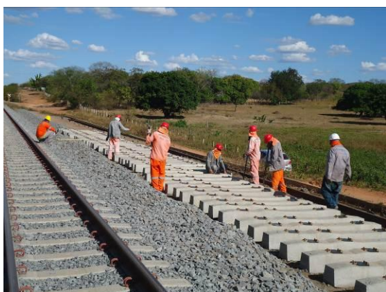
Foto 4-85 Atividades na superestrutura no trecho MVS, próximo à estaca 17457.
