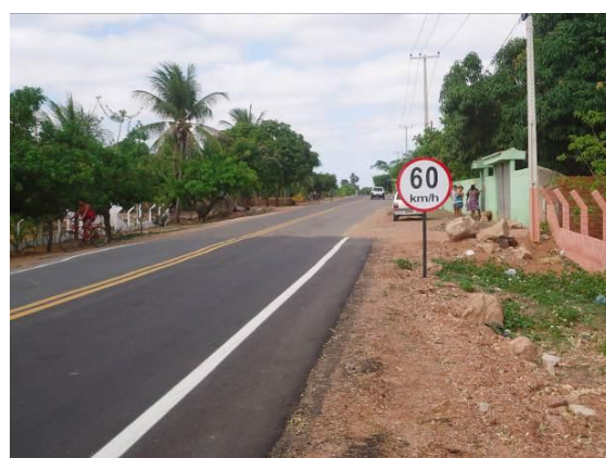
Foto 3-18 Colocação de asfalto, sinalização vertical e horizontal no viaduto de Porteiras-CE. Estaca 15448.
