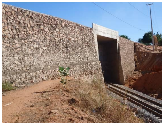
Foto 3-2 Viaduto de Porteiras, estaca 15448.
