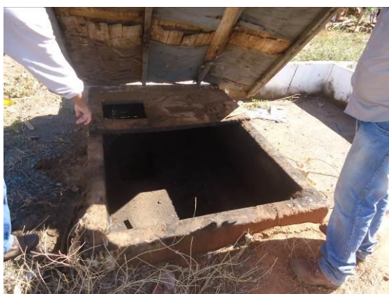
Foto 4-62 Depósito com óleo no antigo canteiro de obras da EIT em Café da Linha/CE.
