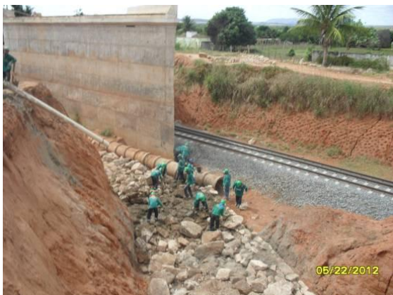
Foto 3-1 Construção do muro de arrimo no viaduto na rodovia CE-397, que dá acesso a cidade de Porteiras-CE, estaca 15436.
