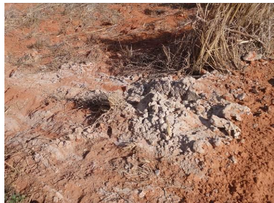
Foto 4-67 Solo contaminado por resto de concreto na estaca 16566.
