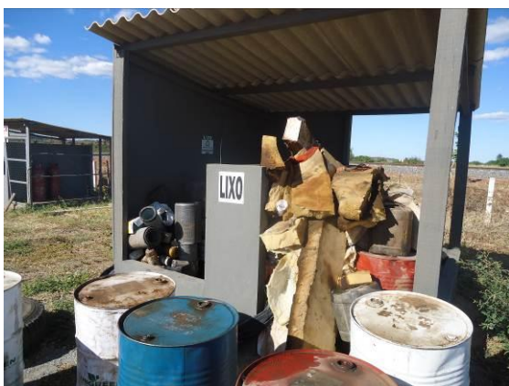
Foto 4-52 Resíduos estocados de forma incorreta no canteiro avançado da TIISA.
