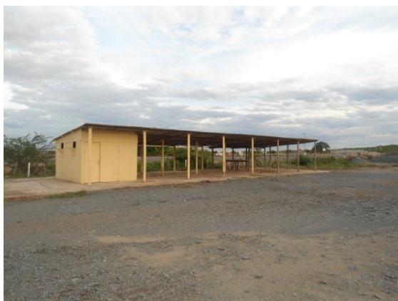
Foto 4-34 Vista parcial do canteiro da TIISA/CMC após a limpeza da área em Brejo Santo-CE.
