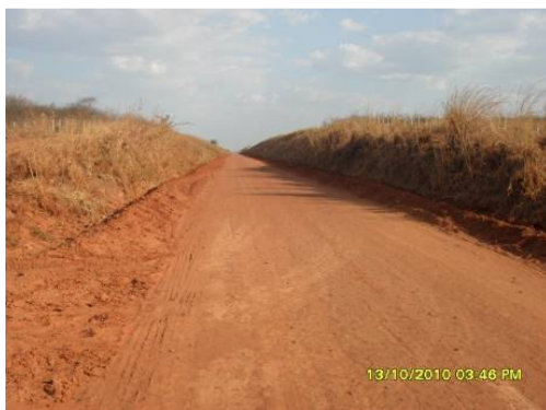
Foto 3-1- Retaludamento do corte concluído e com revestimento vegetal na E- 16940 a 17105
