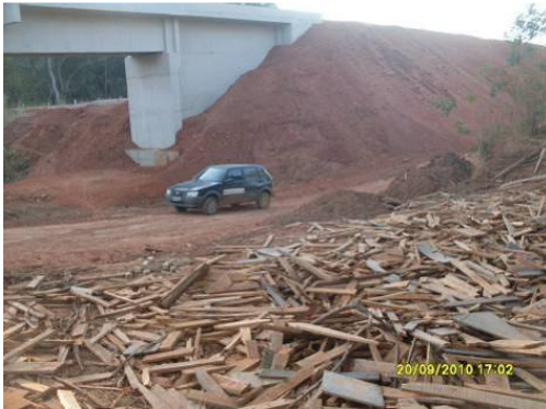
Foto 4-15 - Materiais deixados na obra
