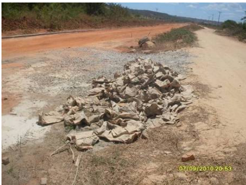
Foto 4-13- Embalagens de cimento espalhadas na obra Foto 4-14- Correção da não conformidade na obra
