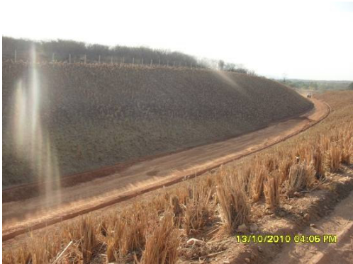
Foto 3-3- Retaludamento de corte concluído e com revestimento vegetal E- 17118 a 17142
