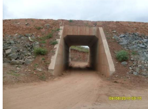
Foto 3-10 - Concluído o viaduto e o aterro superior na E- 14517
