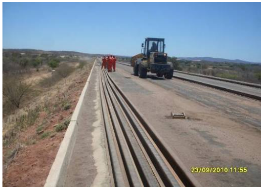
Foto 3-17- Colocação de Trilhos
