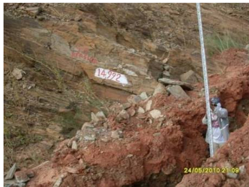
Foto 4-11- Construção de canaletas na lateral da plataforma
