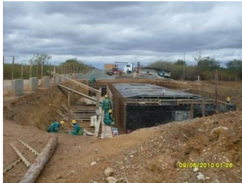
Foto 4-10- Viaduto rodoviário, passagem do Cedro E- 13327.
