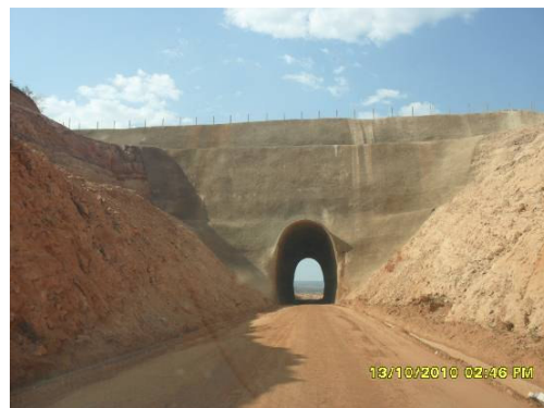
Foto 3-14 - Conclusão do túnel e da terraplanagem sob a estrada CE-293
