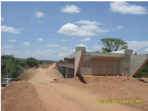
Foto 3-11 - Ponte do riacho Porteiras concluída, faltando apenas os aterros E- 15362.
