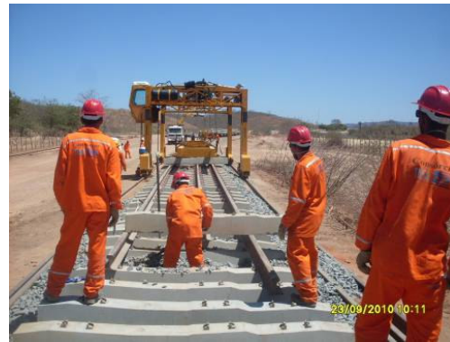
Foto 3-18- Colocação de dormentes
