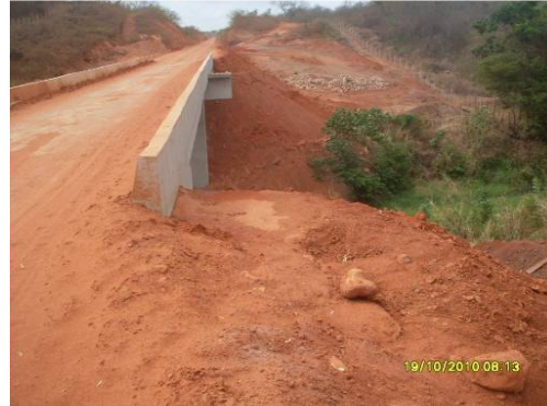
Foto 4-7- Correção da inconformidade
