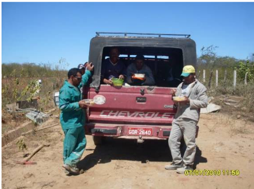
Foto 4-8- Operários realizando suas refeições em local inadequado
