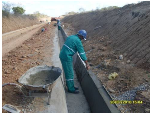
Foto 4-12- Construção de canaletas.
