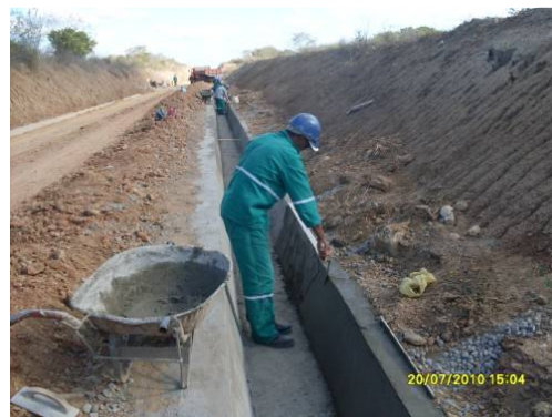
Foto 4-31 - Construção de canaletas.
