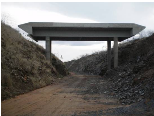
Foto 3-7 - Estaca – 13012 Ponte concluída, falta apenas as ligações com os aterros.
