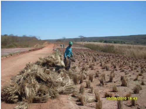
Foto 4-29-Revegetação dos taludes com o plantio de mudas
