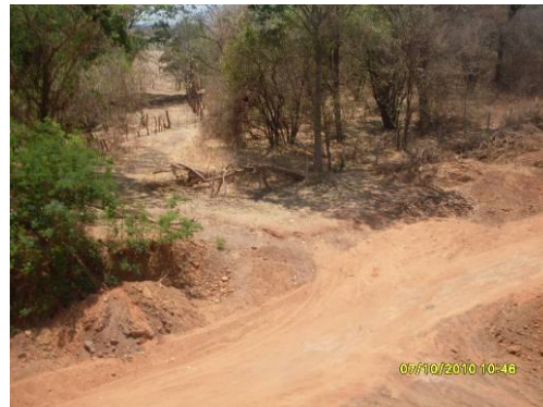
Foto 4-18 - Coleta dos resíduos deixados na obra.
