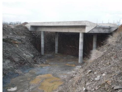
Foto 3-8- Estaca – 12817 Ponte concluída falta apenas as ligações com os aterros.
