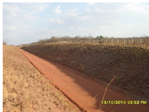
Foto 3-2 -Retaludamento de corte concluído e com revestimento vegetal E- 17118 a 17142
