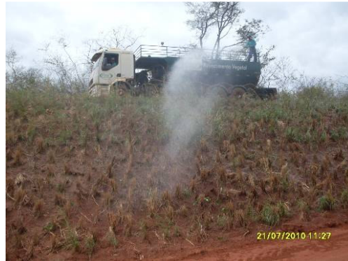
Foto 4-32- Irrigação do plantio do capim nas estacas: 17124 a 17150
