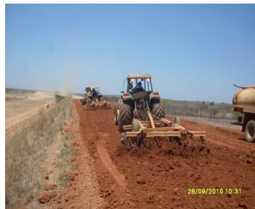
Foto 3-20 - Compactação do sublastro
