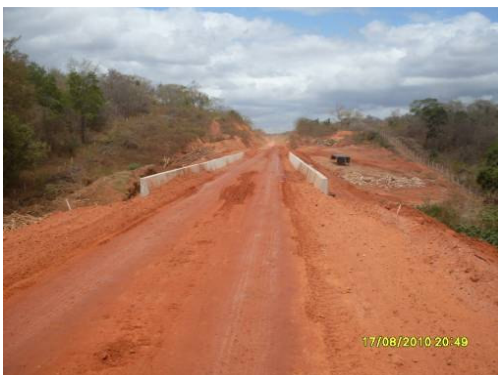
Foto 3-13 - Concluída a ponte e a terraplanagem sobre o riacho Boqueirão E- 16433
