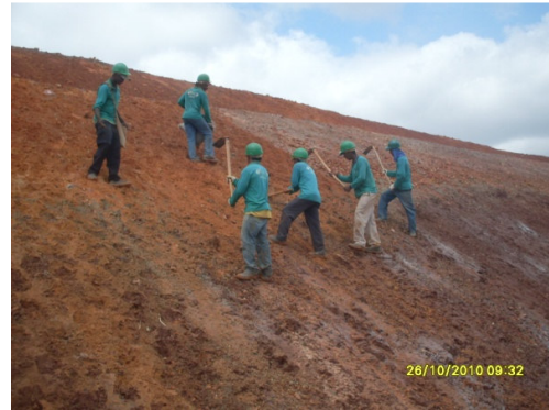
Foto 4-30- Revegetação dos taludes com o plantio de sementes
