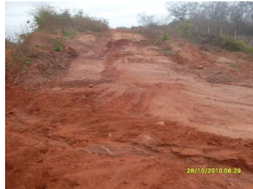
Foto 4-20- Recolhimento dos materiais e correção do solo contaminado
