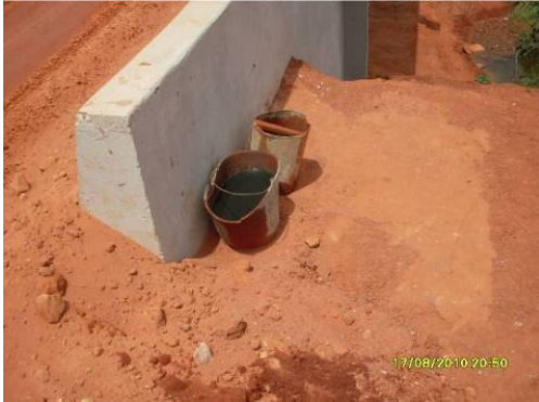
Foto 4-6- Solo contaminado por óleo diesel
