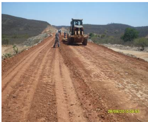
Foto 3-19- Compactação do sublastro
