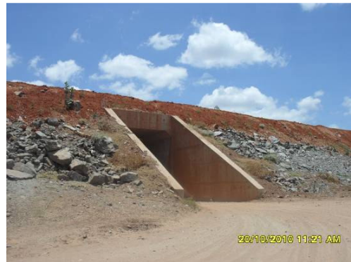
Foto 3-6 -Reaterro da passagem superior concluído E- 14516
