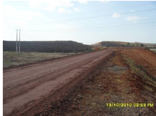
Foto 3-4- Reaterro da passagem superior concluído E- 16862
