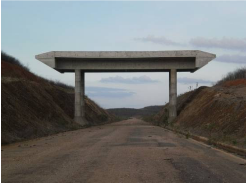
Foto 3-15- Estaca - 12817 Ponte concluída, falta apenas as ligações com o aterros.
