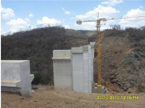
Foto 3-9 - Ponte do rio Jardim, conclusão da fundação, pilares e consolas E- 14406.
