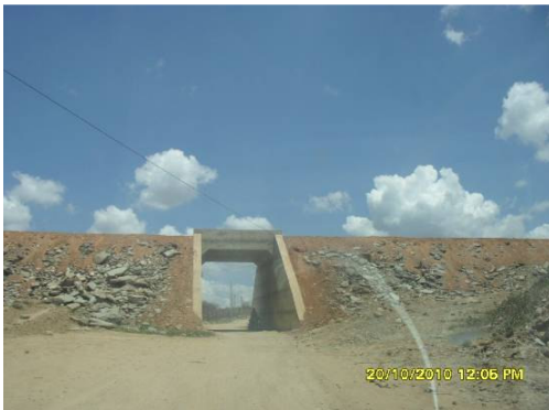
Foto 3-5- Reaterro da passagem superior concluído E- 14292
