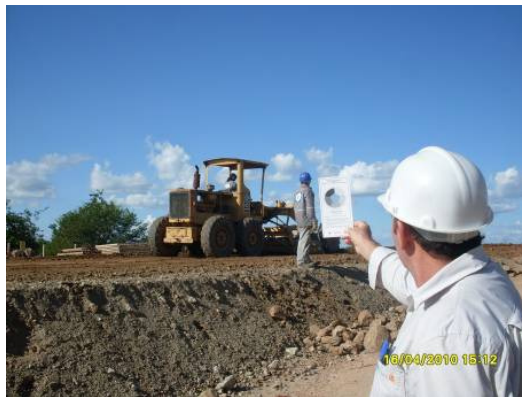
Foto 4. 17– Emissão de fumaça negra (Estaca 1406).
