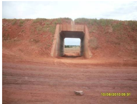
Foto 4. 24– Implantação da passagem de fauna (Estaca 16598).
