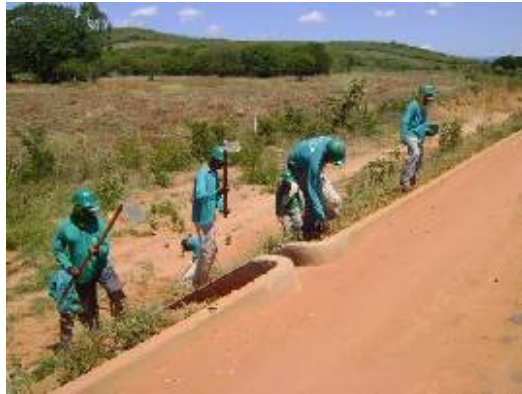
Foto 4. 22– Revegetação do capim no talude da ferrovia (Estaca 14827).
