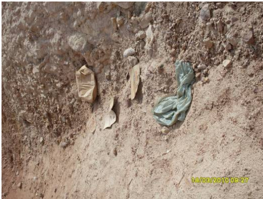
Foto 4. 8 Resíduos sólidos alocados de forma inadequada (Estaca 16796).
