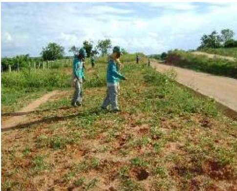
Foto 4. 20– Adubação e replantio do capim no talude da ferrovia (Estaca 15480).
