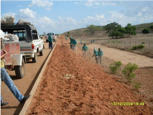
Foto 4. 5: Revegetação dos taludes. (Estaca 15560 a 15564).
