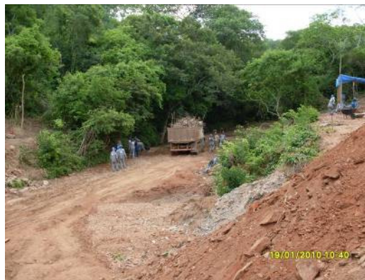
Foto 4. 19 - Retirada do material lenhoso da faixa de domínio.
