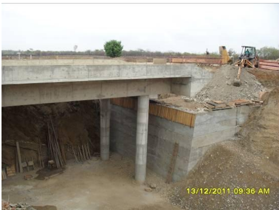
Foto 4.1.13 Construção do muro de arrimo do viaduto da rodovia CE, que dará acesso a Cidade do Cedro/PE, estaca 13326.
