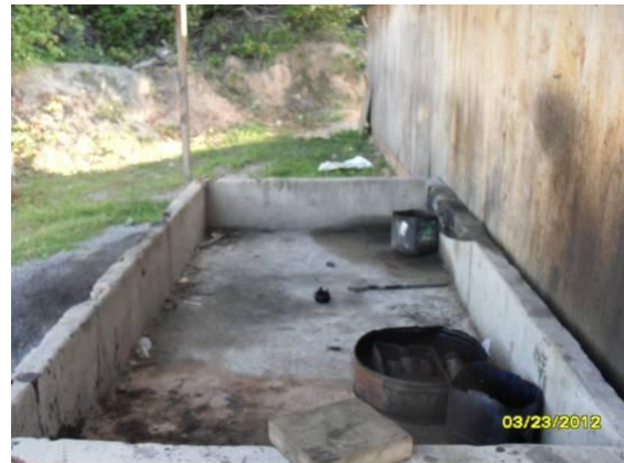
Foto 4.1.192 Baía onde armazenavam temporariamente os resíduos gerados no britador Olho D'Água Cercado, município de Milagres-CE.
