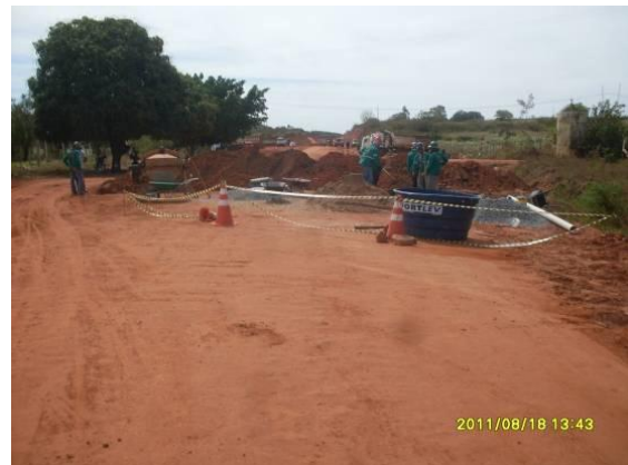
Foto 4.1.70 Sinalização próximo aos serviços de terraplanagem e aterros, estaca 16082.
