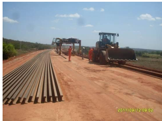
Foto 4.1.200 Frente de serviços da superestrutura, estaca 15963.
