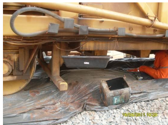
Foto 4.1.102 Mecânico do consórcio TIISA/CMC realizando manutenção da máquina, tomando as medidas adequadas para que não haja contaminação do solo, estaca 16182.
