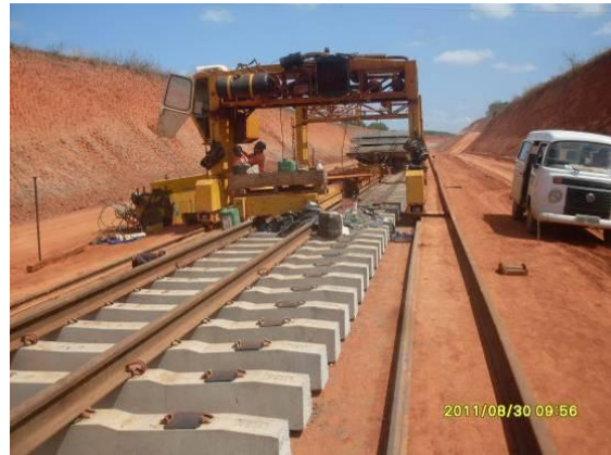
Foto 4.1.204 Colaboradores realizando serviços da superestrutura, estaca 16076.
