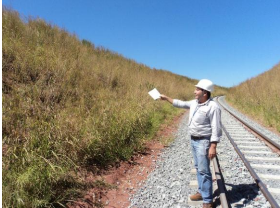
Foto 4.1.243 Talude de corte estabilizado na estaca 17200
