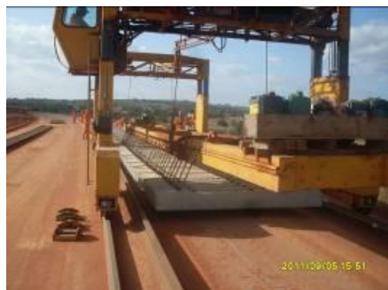
Foto 4.1.202 Colaboradores realizando serviços da superestrutura, estaca 16020.
