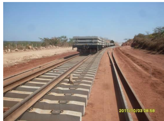
Foto 4.1.214 Composição transportando dormentes, estaca 15811.
