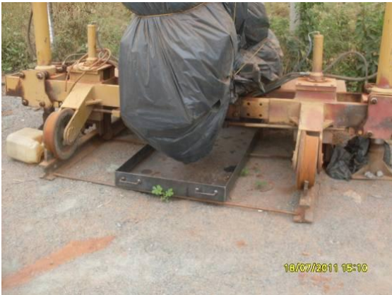
Foto 4.1.105 Equipamento do consórcio TIISA/CMC com badeira de contenção, estaca 16182.
