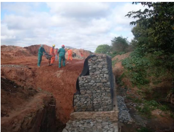
Foto 3.2.15 Muro de gabião, próximo à ponte do Riacho de Porteiras, estaca 15361.
