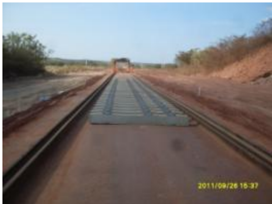
Foto 4.1.211 Frente de serviços da superestrutura, estaca 15854.
