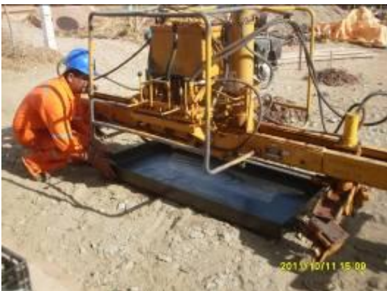
Foto 4.1.159 Colaborador colocando a bandeja de contenção para evitar novas contaminações do solo, estaca 15721.
