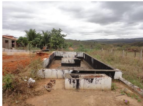
Foto 4.1.130 Canteiro de obras, município de Abaiara/CE (Antiga oficina da SUPEC).
