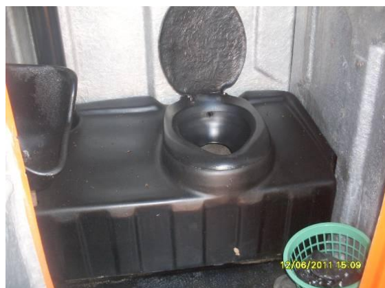
Foto 4.1.52 Instalação de apoio para os colaboradores
