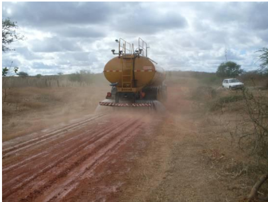
Foto 4.1.225 Caminhão pipa realizando a umectação, estaca 13372.
