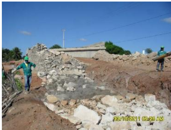
Foto 4.1.17 Construção do muro de arrimo no viaduto sobre a rodovia CE, que dará acesso a cidade de Porteiras, estaca 15436.
