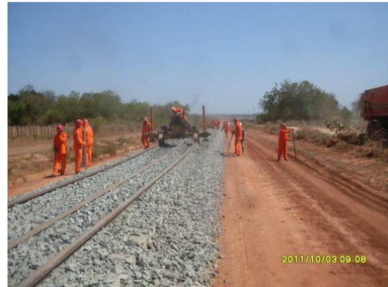
Foto 4.1.210 Colaboradores realizando serviços da superestrutura, estaca 15811.
