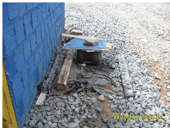
Foto 4.1.170 Lona plástica contaminada por óleo e recipiente com óleo, estaca 16934.
