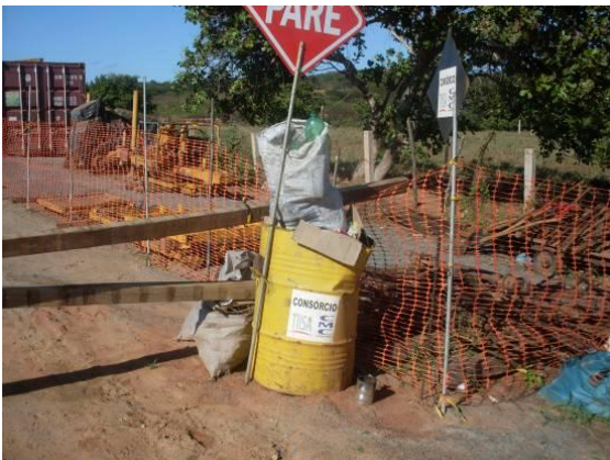
Foto 4.1.117 Resíduos sólidos gerados na obra, estaca 16183.
