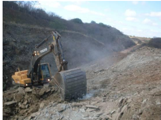
Foto 4.1.12 Máquinas da CNO realizando o retaludamento dos cortes nas proximidades à estaca 12996.
