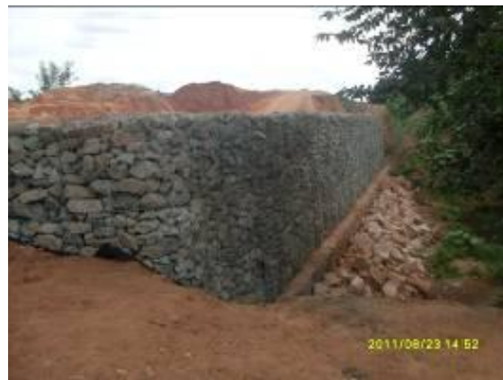
Foto 3.2.16 Conclusão da construção muro de gabião, próximo à ponte do Riacho de Porteiras, estaca 15361.
