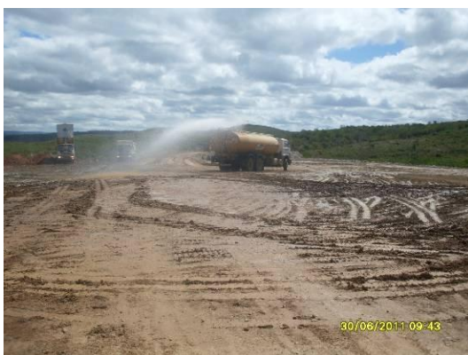
Foto 4.1.223 Caminhão pipa da CNO, realizando a umectação na via de acesso do bota fora ao
