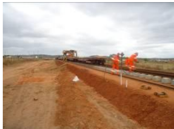
Foto 4.1.208 Frente de serviços da superestrutura, estaca 15681.
