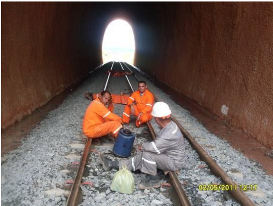
Foto 4.1.21 Túnel de Café da Linha na estaca 16796 utilizado com ponto de apoio.
