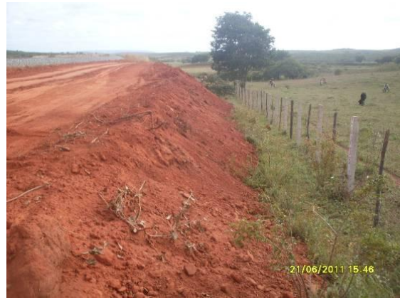
Foto 3.2.8 Bota fora, estaca 16232 à 16259, onde está sendo acomodado o solo do retaludamento.
