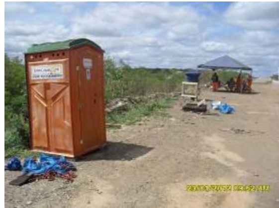
Foto 4.1.61 Falta de higienização dos banheiros químicos, estaca 13267.
