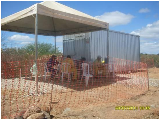
Foto 4.1.30 Instalações de apoio para refeições dos colaboradores da CNO, estaca 13328, com as adequações.
