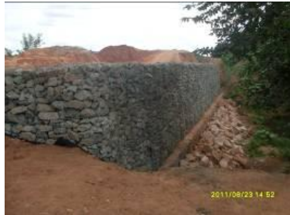
Foto 4.1.16 Conclusão da construção muro de gabião, próximo à ponte do riacho Porteiras, estaca 15361.
