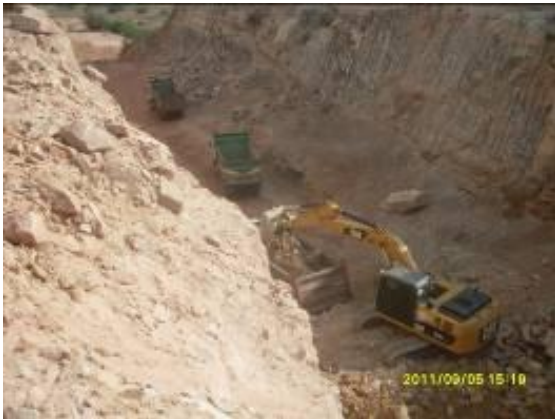
Foto 3.2.1 Retaludamento do corte Serrote Pedra do Urubu, estaca 15660.
