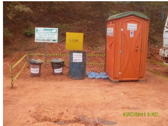
Foto 4.1.54 Instalações sanitárias da POLLIAN, estaca 15759.
