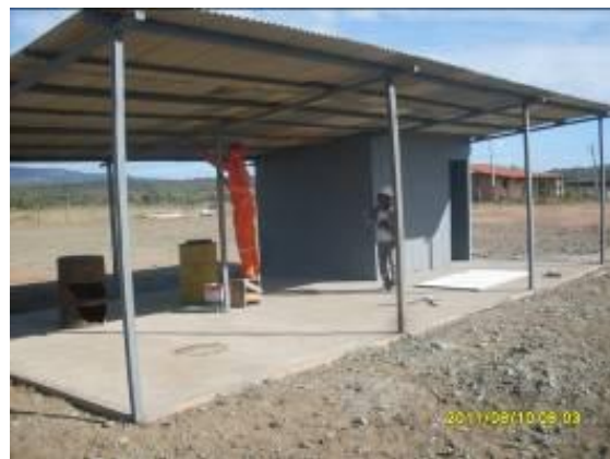
Foto 4.1.38 Instalações de apoio do Consórcio TIISA/CMC, estaca 15521.
