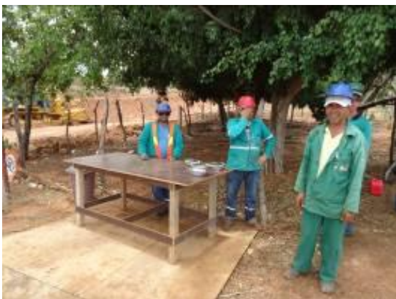
Foto 4.1.47 Instalações de apoio precárias para refeições dos colaboradores da POLLIAN, estaca 15439.
