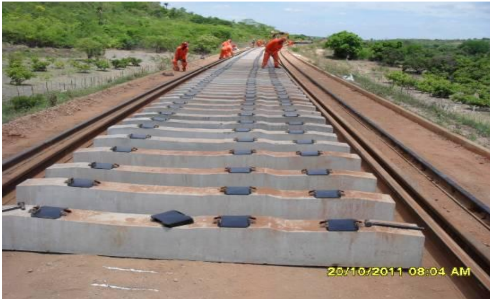
Foto3.2.23 Instalação da superestrutura lote 1, estaca 12882.
