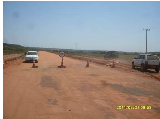
Foto 4.1.74 Sinalização com cones e fita zebraada isolando a área de trabalhos com máquinas, estaca 15917.
