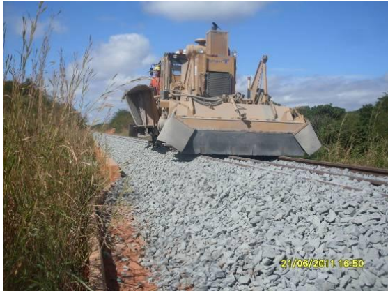
Foto 4.1.194 Compactação de brita entre as estacas 16170 e 16216.
