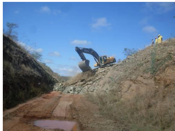
Foto 3.2.4 Máquinas da CNO realizando o retaludamento dos cortes nas proximidades da estaca 12996.
