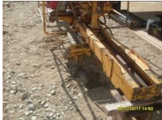
Foto 4.1.158 Solo contaminado por óleo nas proximidades da oficina, no ponto de apoio do Consórcio TIISA/CMC, estaca 15721.
