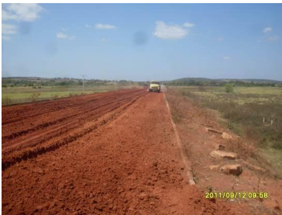
Foto 3.2.24 Reforma do lastro, estaca 15945.
