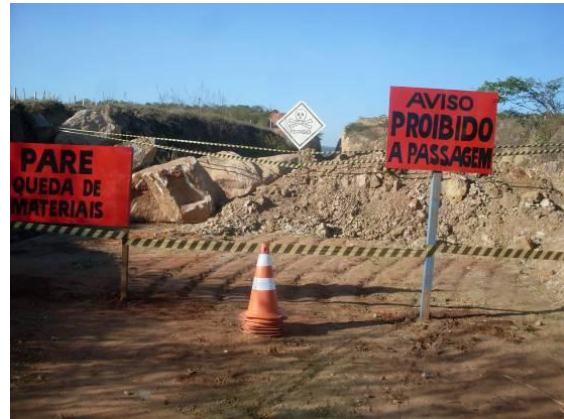
Foto 4.1.68 Sinalização de segurança na estaca 15687 para a atividade de desmonte de rocha.
