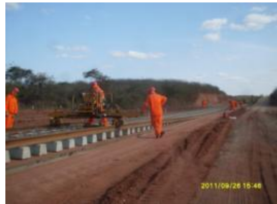
Foto 4.1.212 Colaboradores realizando serviços da superestrutura, estaca 15857.
