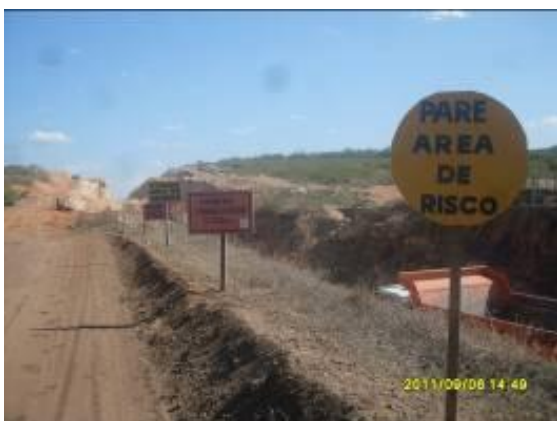
Foto 4.1.71 Sinalização de advertência de segurança, para a atividade de desmonte de rocha, estaca 15693.
