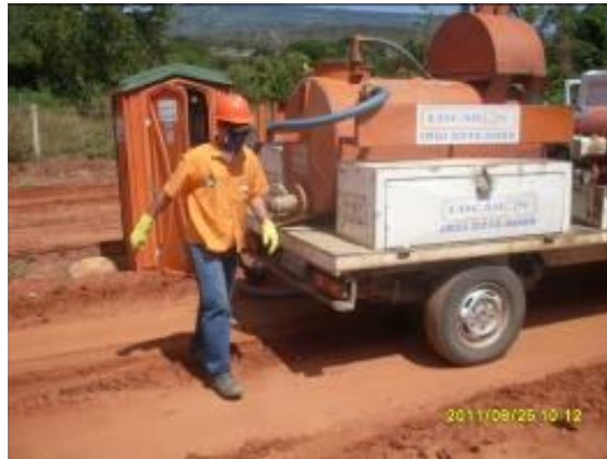
Foto 4.1.57 Colaborador higienizando banheiros químicos no ponto de apoio da POLLIAN estaca 16085.
