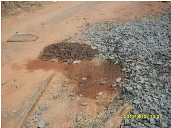
Foto 4.1.135 Solo e britas contaminados por óleo, estaca 16928.
