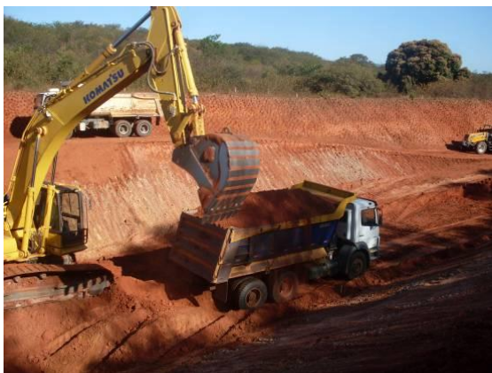
Foto 3.2.5 Máquinas da POLLIAN realizando retaludamento dos cortes, estaca 16128.
