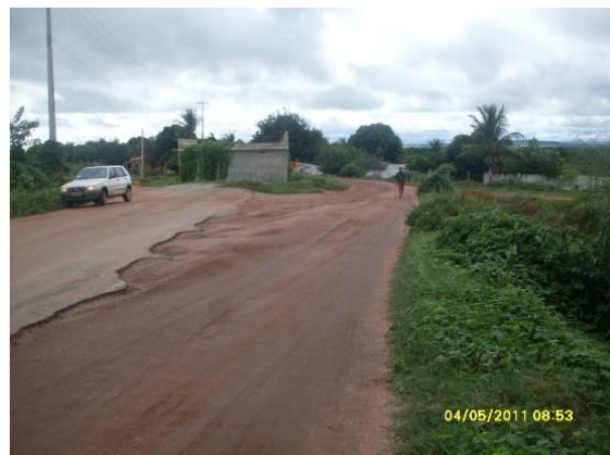
Foto 4.1.63 Desvio da rodovia que dar acesso a cidade de Porteiras/CE, estaca 15436.
