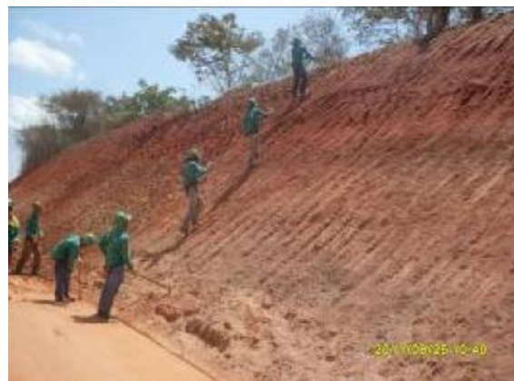
Foto 4.1.239 Revegetação de talude de corte, estaca 16134.
