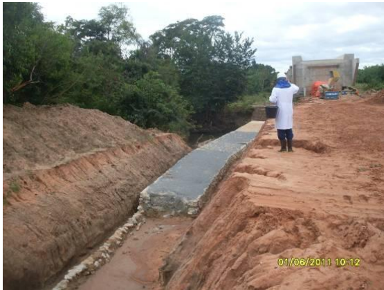
Foto 4.1.15 Construção do muro de gabião na ponte do riacho Porteiras, estaca 15361.
