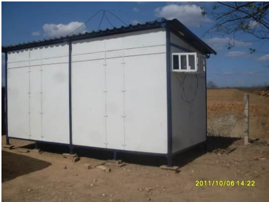
Foto 4.1.43 FP Comércio e Construções instalações de apoio para construção do muro de arrimo do viaduto sobre a rodovia PE-475, estaca 13326.
