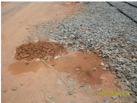
Foto 4.1.151 Solo contaminado por óleo, estaca 16926.
