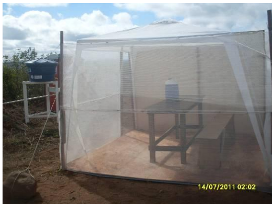
Foto 4.1.28 Instalações de apoio para refeições dos colaboradores da POLLIAN, conforme NR 18 estaca 15759.
