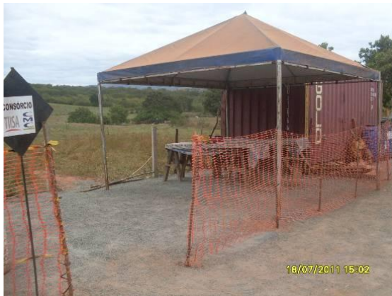
Foto 4.1.32 Instalações de apoio para refeições dos colaboradores do consorcio TIISA/CMC, estaca 16181, já em adequação.
