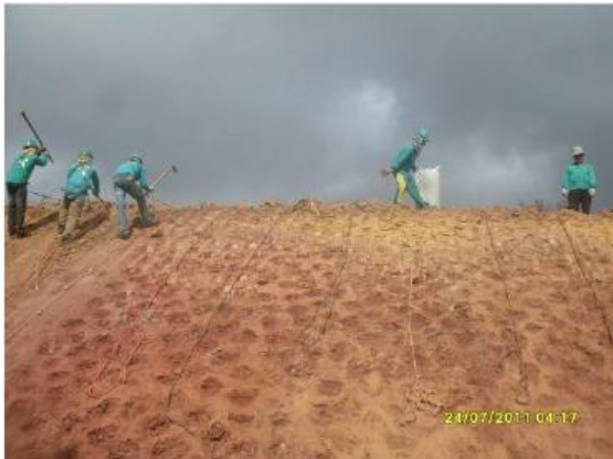
Foto 4.1.236 Preparo para plantio em talude de corte, estacas 15795 -15802.
