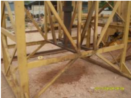
Foto 4.1.149 Máquinas do Consórcio TIISA/CMC na faixa de domínio sem bandeja de contenção, contaminando o solo, estaca 15721.
