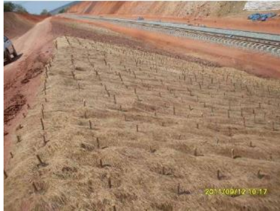
Foto 4.1.240 Instalação de manta geotêxtil para cobertura das sementes plantadas, estaca 16129.
