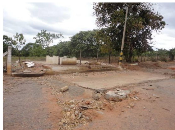
Foto 4.1.126 Canteiro de obras, município de Abaiara/CE (Antiga oficina da SUPEC).
