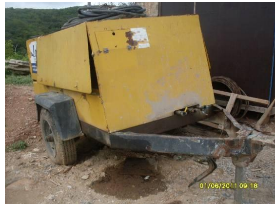
Foto 4.1.94 Gerador com vazamento sem a utilização de bandeja, estaca 14404.
