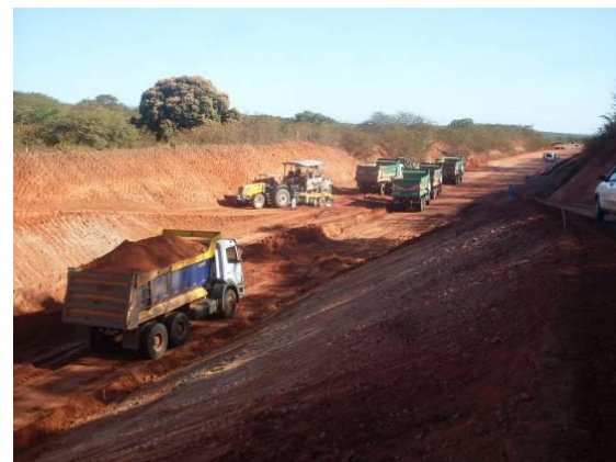
Foto 3.2.6 Retirada do solo proveniente de retaludamento, estaca 16129.
