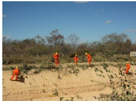
Foto 4.1.234 Escavação de covas para hidrossemeadura, estaca 4331.
