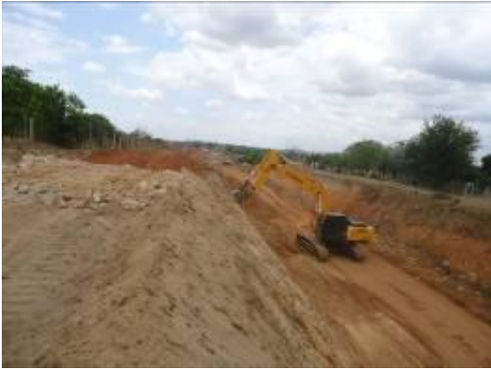
Foto 3.2.26 Conformação do talude de corte, estaca 15459.
