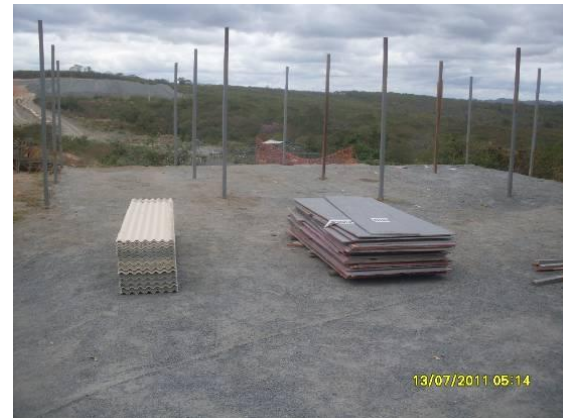
Foto 4.1.33 Desmobilização das instalações de apoio no britador no sitio Olho d'Água Cercado.
