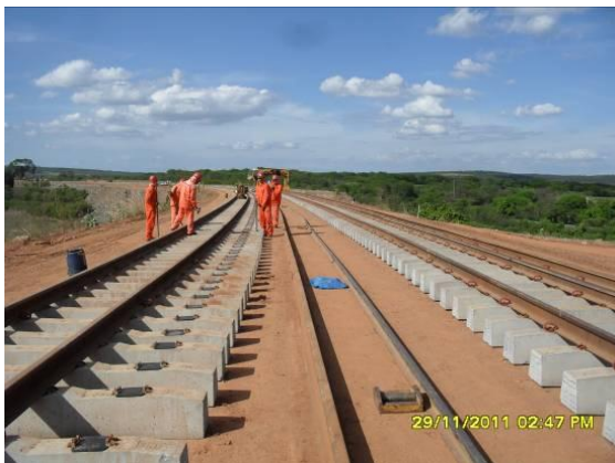
Foto 4.1.219 Frente de serviços da superestrutura, estaca 14709.
