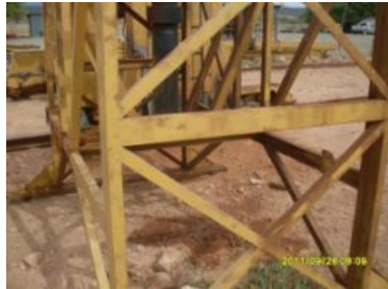
Foto 4.1.150 Máquinas do Consórcio TIISA/CMC na faixa de domínio sem bandeja de contenção, contaminando o solo, estaca 15721.
