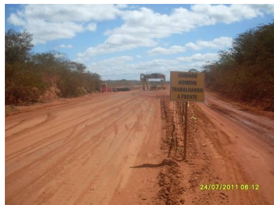
Foto 4.1.66 Sinalização nas vias de acesso entre as estacas 16079 a 16209.
