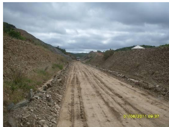
Foto 4.1.10 Retaludamento de corte, próximo à estaca-14340 a 14347.
