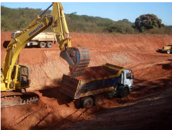
Foto 3.2.11 Máquinas da POLLIAN realizando retaludamento dos cortes, estaca 16128.
