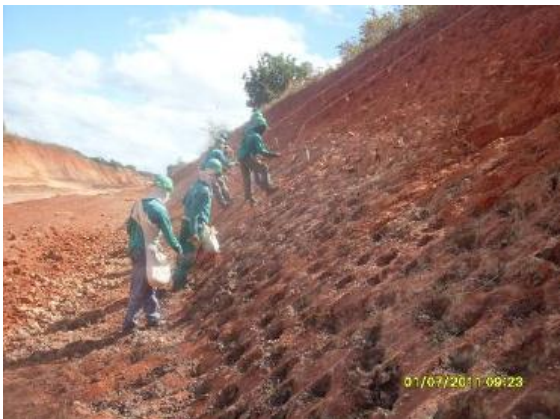
Foto 4.1.233 Colaboradores realizando revegetação no talude de corte, utilizando graminhas, estaca 16209.
