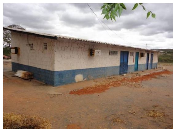
Foto 4.1.132 Canteiro de obras, município de Abaiara/CE (Antiga oficina da SUPEC).
