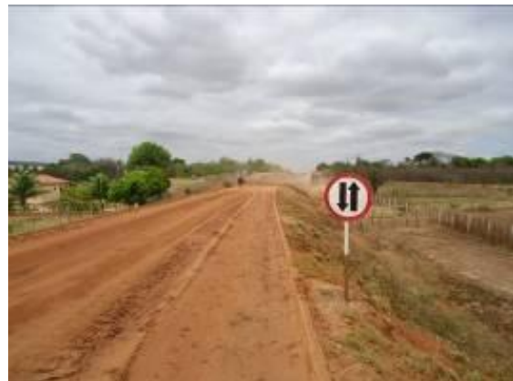
Foto 4.1.80 Sinalização mostrando via de sentido duplo, próxima a estaca 15475.
