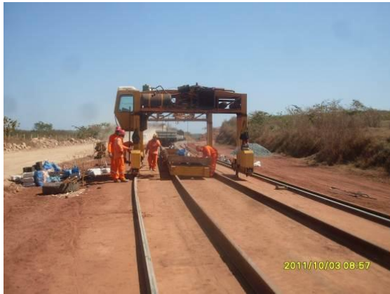
Foto 4.1.209 Frente de serviços da superestrutura, estaca 15791.
