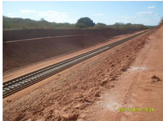
Foto 4.1.198 Andamento da obra da superestrutura, estaca 16167.
