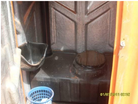
Foto 4.1.53 Falta de higienização no banheiro químico dos colaboradores da POLLIAN, estaca 15759.
