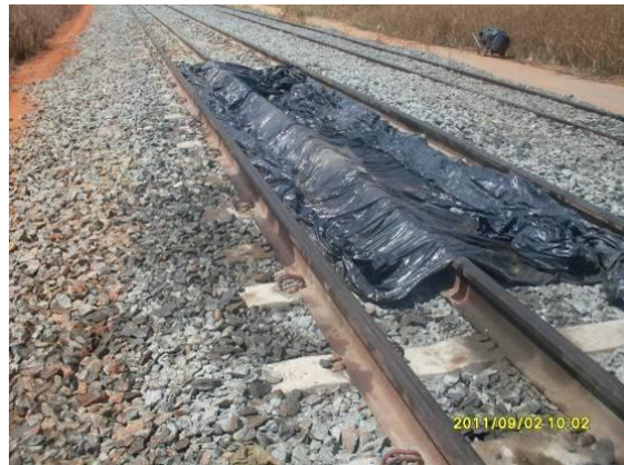
Foto 4.1.136 Brita contaminada no momento da manutenção da máquina, estaca 16927.
