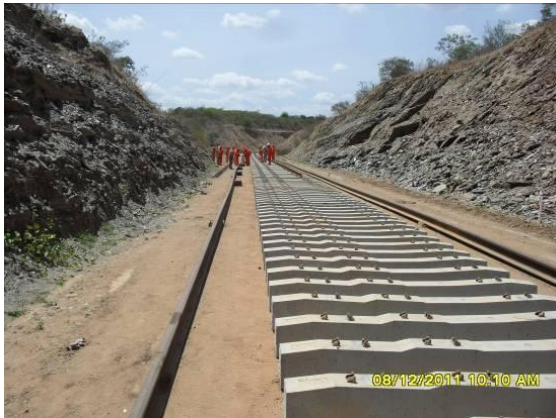
Foto 4.1.217 Frente de serviços da superestrutura, estaca 12985.
