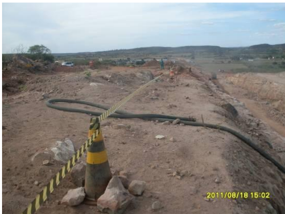
Foto 4.1.69 Sinalização no corte Serrote Pedra do Urubu, estaca 15662.
