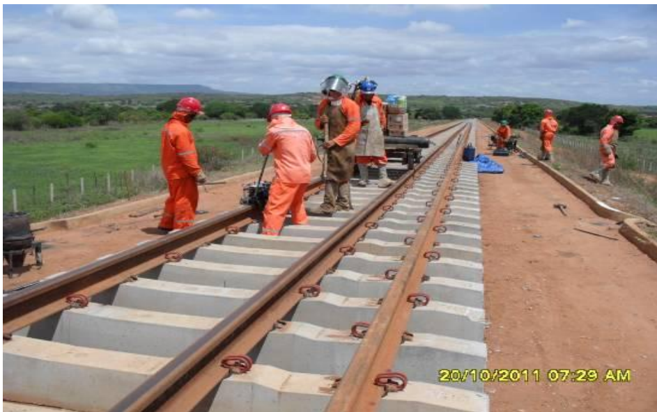
Foto3.2.22 Colaboradores realizando serviço de solda de trilhos, estaca 15283.
