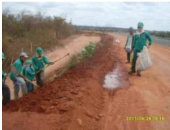
Foto 4.1.241 Revegetação na faixa de domínio, estaca 16003.
