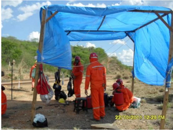
Foto 4.1.49 Ponto de apoio para refeições dos colaboradores do Consórcio TIISA/CMC, estaca 12874.
