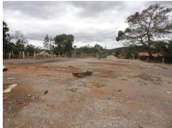
Foto 4.1.128 Canteiro de obras, município de Abaiara/CE (Antiga oficina da SUPEC).
