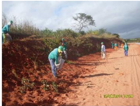
Foto 4.1.232 Instalação de manta geotêxtil para cobertura das sementes plantadas, estaca 16129.
