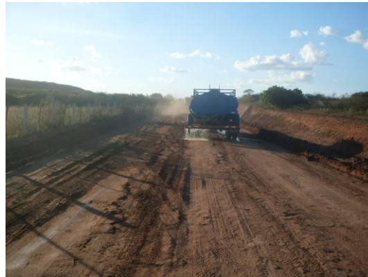
Foto 4.1.226 Caminhão pipa realizando a umectação das vias de acessos, estaca 15784.
