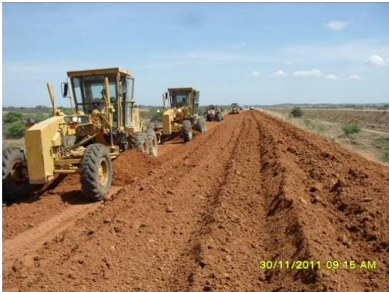
Foto 4.1.7 Reforma do sublastro, estaca 13778.
