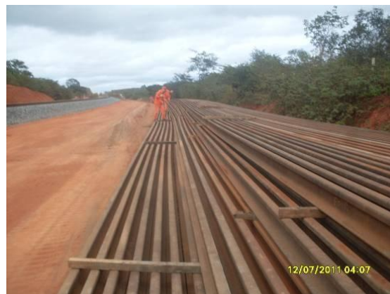
Foto 4.1.196 Estoque de trilhos nas proximidades das estacas 16170 e 16185.
