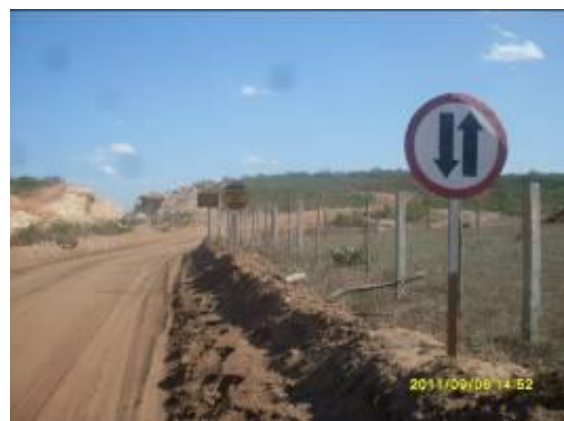
Foto 4.1.72 Placa de sinalização de advertência de mão dupla, estaca 15692.
