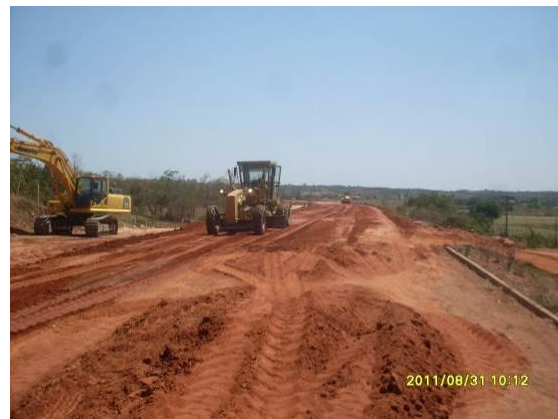
Foto 3.2.25 Reforma do lastro, estaca 15996.
