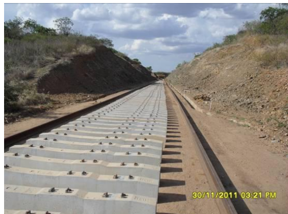
Foto 4.1.220 Frente de serviços da superestrutura, estaca 12981.
