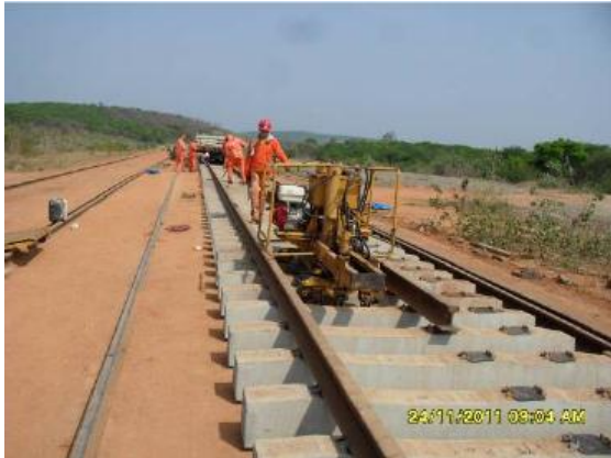
Foto 4.1.215 Frente de serviços da superestrutura, estaca 12927.
