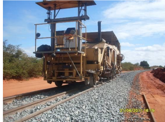
Foto 4.1.195 Serviços de nivelamento e alinhamento dos trilhos, estaca 16196.
