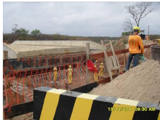
Foto 4.1.14 Construção do muro de arrimo do viaduto da rodovia CE, que dará acesso a Cidade do Cedro/PE, estaca 13326.
