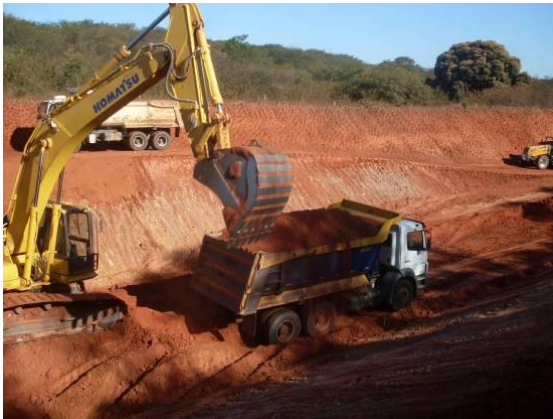
Foto 4.1.11 Máquinas do POLLIAN realizando o retaludamento dos cortes, estaca 16128.
