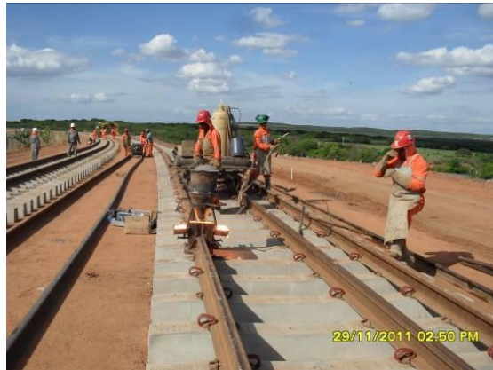
Foto 4.1.221 Serviço de soldagem dos trilhos, estaca 14707.
