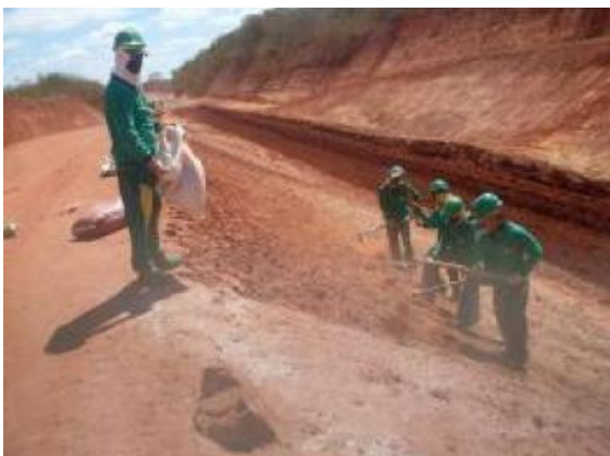
Foto 4.1.238 Adubação e coveamento na revegetação de talude de corte, estacas 16143 -16151.
