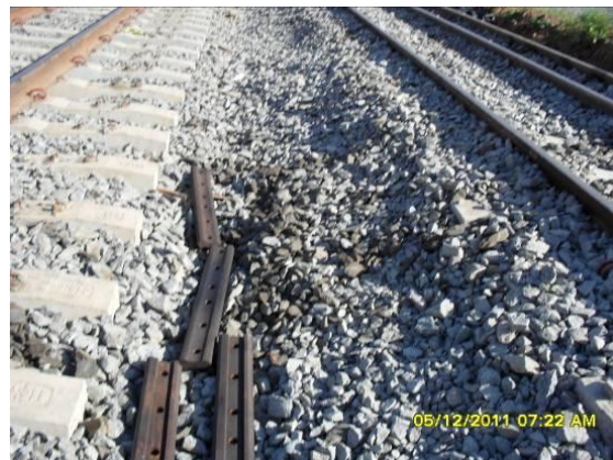
Foto 4.1.174 Britas contaminadas por óleo proveniente da manutenção de máquinas, estaca 15703.
