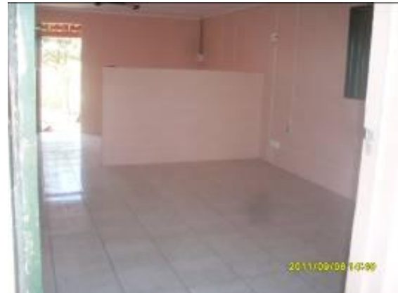
Foto 4.1.42 Novas Instalações de apoio do Consórcio TIISA/CMC, nas proximidades da cidade de Brejo Santo-CE, estaca 15521.
