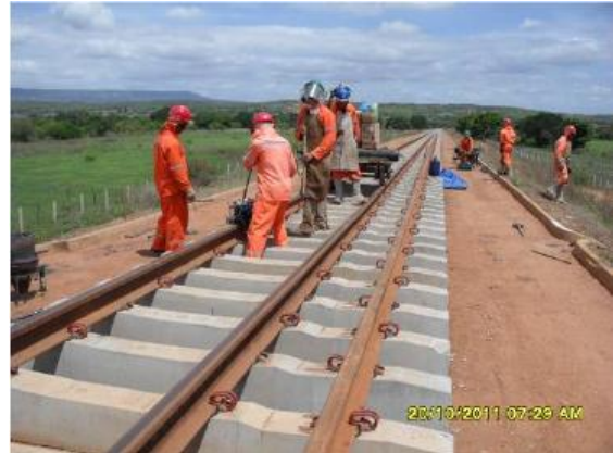
Foto 4.1.216 Colaboradores realizando serviço de solda de trilhos, estaca 15283.
