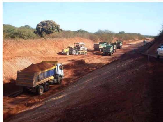
Foto 3.2.12 Retirada do solo proveniente do retaludamento, estaca 16129.
