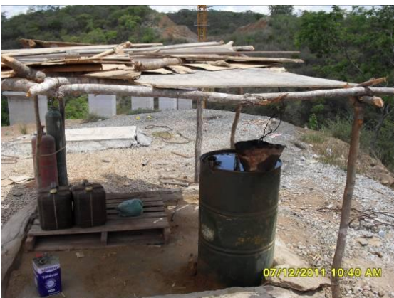
Foto 4.1.179 Baia irregular próxima a Ponte do riacho, Jardim, estaca 14397.
