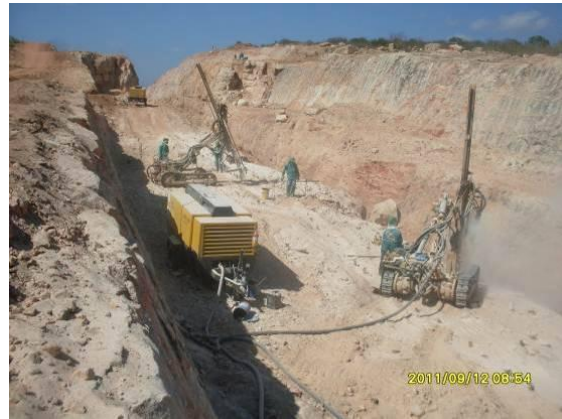
Foto 3.2.2 Retaludamento do corte Serrote Pedra do Urubu, estaca 15605.
