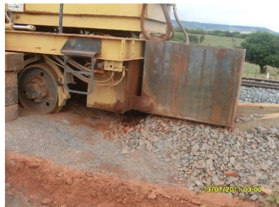
Foto 4.1.110 Máquina da TIISA para manutenção sem bandeja de contenção, estaca 16184.
