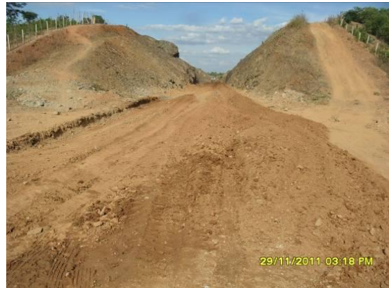
Foto 4.1.8 Reforma do sublastro, estaca 14625.
