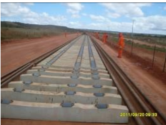
Foto 4.1.207 Colaboradores realizando serviços da superestrutura, estaca 15726.
