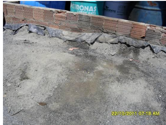
Foto 4.1.172 Mancha de óleo próximo a baia do britador Sítio Olho d'Água Cercado, Milagres/CE.
