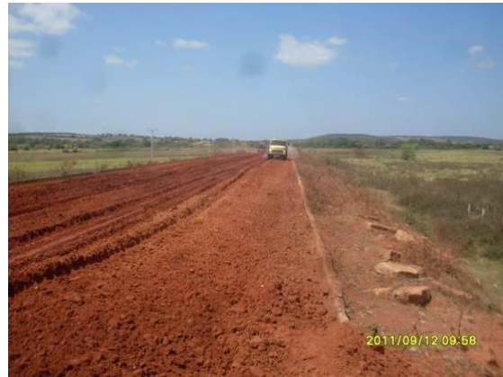
Foto 3.2.14 Reforma do lastro, estaca 15945.
