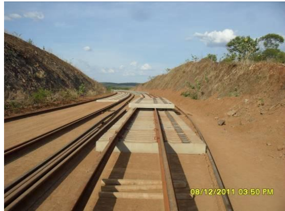
Foto 4.1.218 Frente de serviços da superestrutura, estaca 14688.
