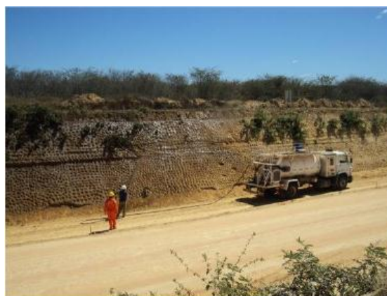
Foto 4.1.235 Hidrossemeadura em talude de corte, estaca 4358.
