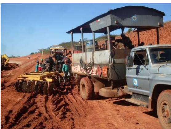
Foto 4.1.119 Abastecimento de máquinas e caminhões no trecho, estaca 16155.
