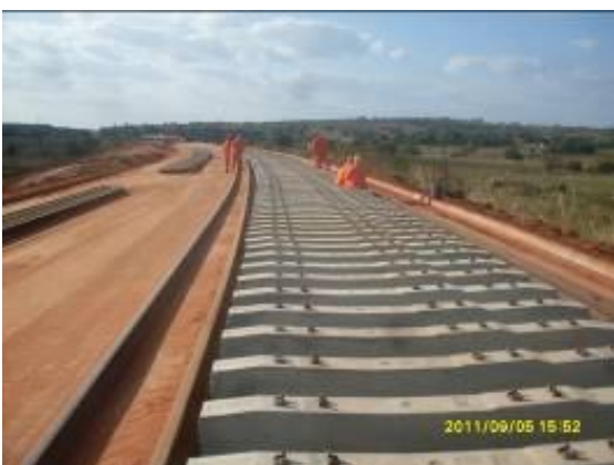
Foto 4.1.201 Colaboradores realizando serviços da superestrutura, estaca 16017.
