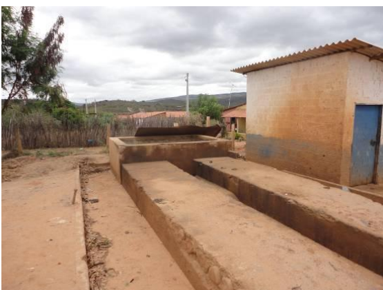
Foto 4.1.131 Canteiro de obras, município de Abaiara/CE (Antiga oficina da SUPEC).
