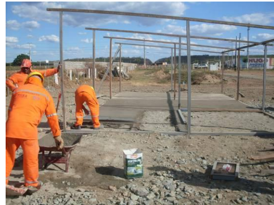
Foto 4.1.36 Colaboradores do consórcio TIISA/CMC construindo as Instalações de apoio, estaca 15521.
