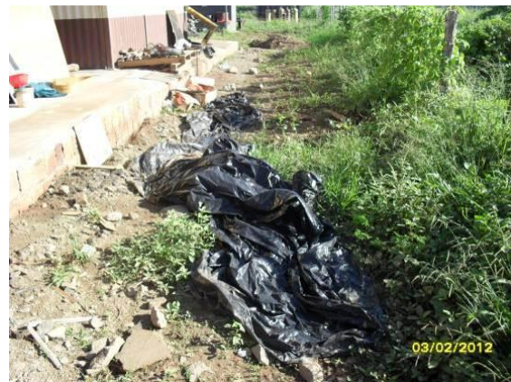
Foto 4.1.188 Plástico contaminado por óleo lubrificante em contato com o solo, próximo a oficina do Consórcio TIISA/CMC, estaca 15727.
