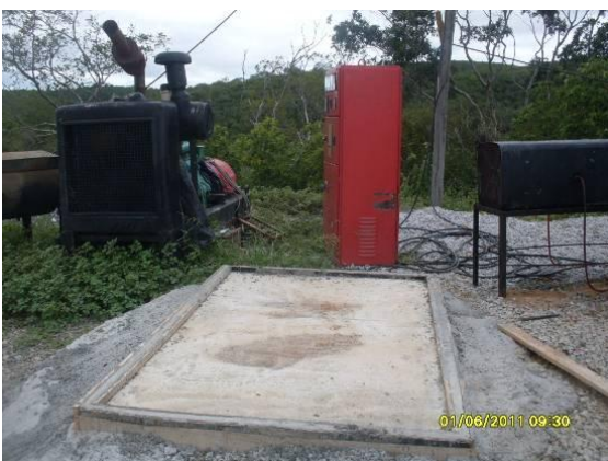
Foto 4.1.95 Baia para o gerador de energia, estaca 14404.
