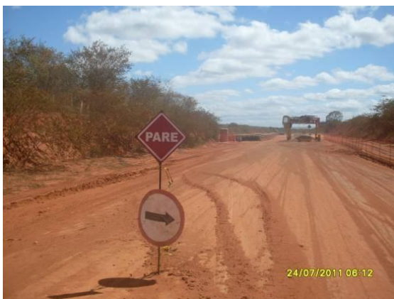
Foto 4.1.65 Sinalização nas vias de acesso entre as estacas 16079 a 16209.
