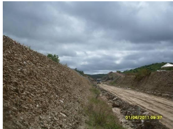
Foto 3.2.10 Retaludamento de corte, próximo às estacas 14340 a 14347.
