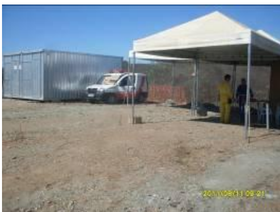
Foto 4.1.39 Ponto de apoio da CNO instalado sobre o
