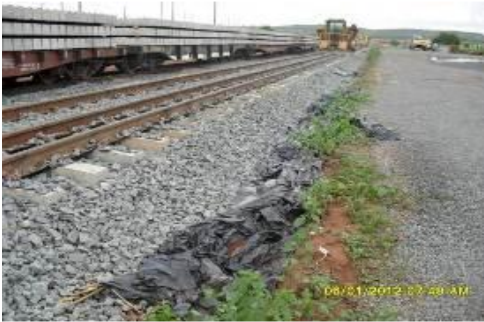
Foto 3.2.21 Máquinas transportando dormentes para a superestrutura, estaca 15703.
