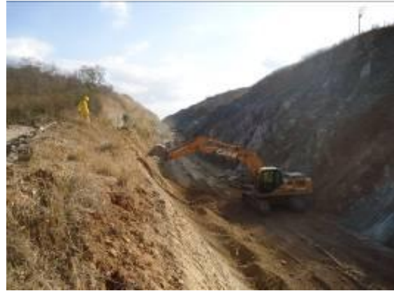
Foto 3.2.27 Máquina da CNO realizando serviço de retaludamento do corte, estaca 14469.
