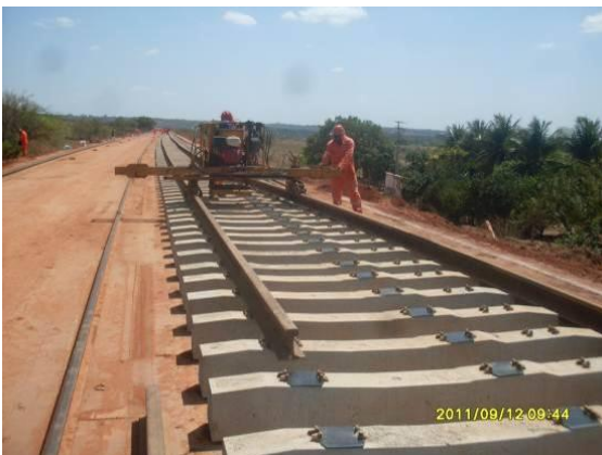
Foto 4.1.199 Colaboradores realizando serviços da superestrutura, estaca 15967.
