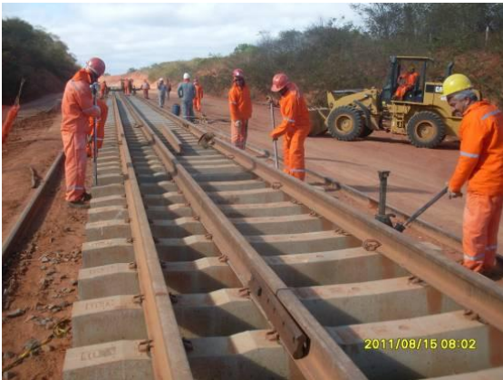
Foto 4.1.197 Colaboradores realizando serviços da superestrutura, estaca 16109.
