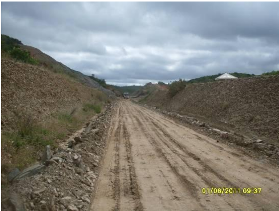
Foto 3.2.13 Retaludamento de corte, próximo às estacas 14340 a 14347.
