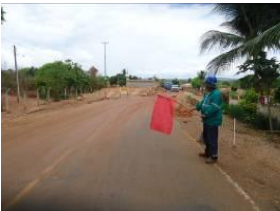
Foto 4.1.79 Desvio da CE acesso para a cidade de Porteiras/CE, estaca 15463.
