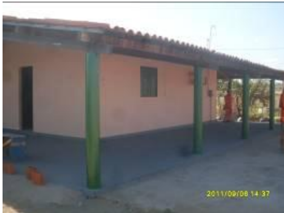
Foto 4.1.41 Instalações de apoio do Consórcio TIISA/CMC.
