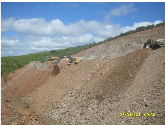
Foto 4.1.9 Retaludamento de corte, estaca-14329.
