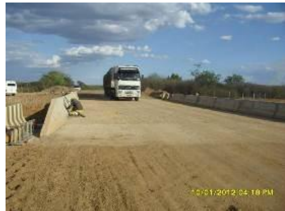
Foto 3.2.29 Conclusão dos serviços do muro de arrimo do viaduto sobre a PE 475, Cedro/PE, estaca 13326.
