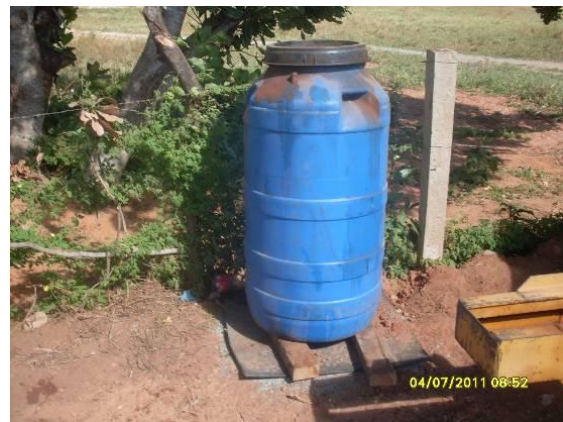
Foto 4.1.104 Tambor com óleo usado sem bandeja de contenção, estaca 16182.
