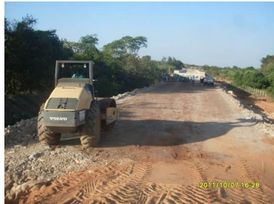
Foto 3.2.18 Serviço de terraplanagem e ligação do lastro com a ponte de Porteiras, estaca 15366.
