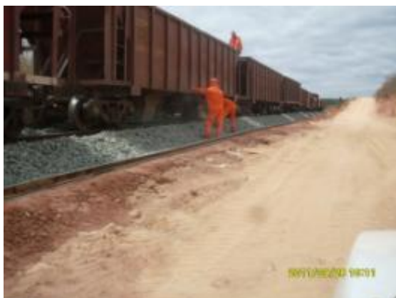
Foto 4.1.213 Disposição de brita sob os trilhos, estaca 15880.
