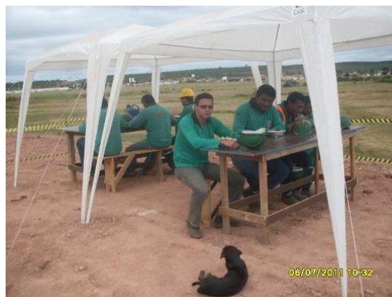
Foto 4.1.34 Instalações de apoio para os colaboradores da POLLIAN, estaca 15759.
