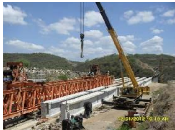
Foto 3.2.20 Vigas para a ponte do riacho Jardim, estaca 14406.
