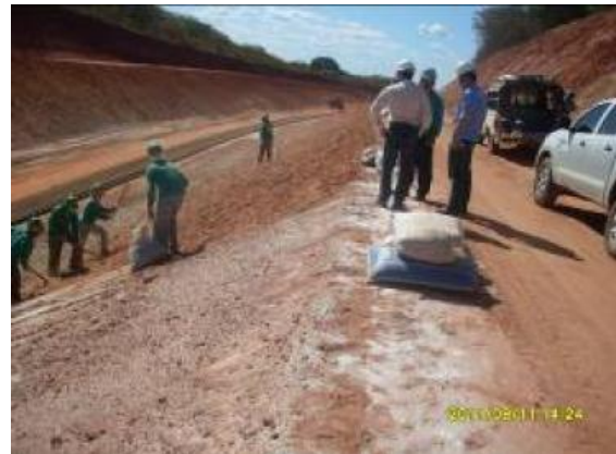
Foto 4.1.237 Trabalhadores realizando o plantio em talude de corte, estacas 16143 - 16151.
