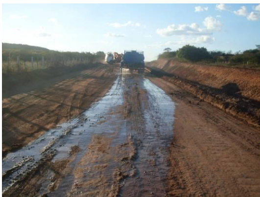
Foto 4.1.227 Caminhão pipa realizando a umectação das vias de acessos, estaca 15784.
