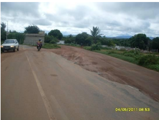
Foto 4.1.62 Desvio da rodovia que dar acesso a cidade de Porteiras/CE, estaca 15436.
