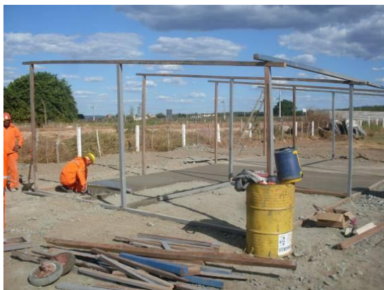
Foto 4.1.37 Colaboradores do consórcio TIISA/CMC preparando Instalações de apoio, estaca 15521.
