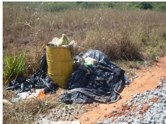
Foto 4.1.118 Resíduos sólidos gerados na obra, estaca 16930.
