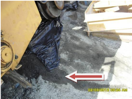
Foto 4.1.185 Máquina em conserto sem a utilização da bandeja de contenção, estaca 15711.
