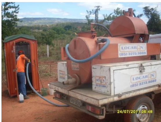
Foto 4.1.55 Limpeza de banheiros no ponto de apoio da POLLIAN, estaca 16086.
