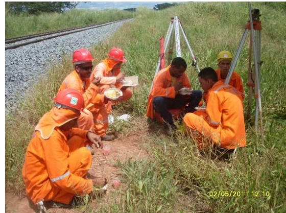
Foto 4.1.22 Colaboradores realizando suas refeições ao céu aberto próximo a estaca 16780, devido não ter ponto de apoio.
