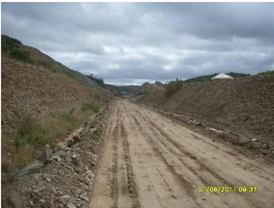
Foto 3.2.9 Retaludamento de corte, próximo às estacas 14340 a 14347.
