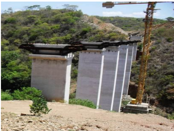
Foto 3.2.19 Instalação dos consoles na ponte sobre o riacho Jardim, estaca 14406.
