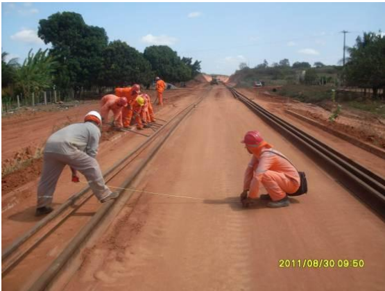
Foto 4.1.203 Colaboradores realizando serviços da superestrutura, estaca 16078.
