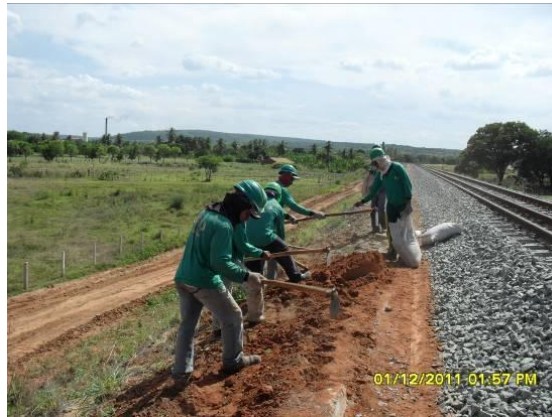
Foto 4.1.242 estabilização dos taludes de cortes e aterros com tratamento através de revegetação, estaca 15358.
