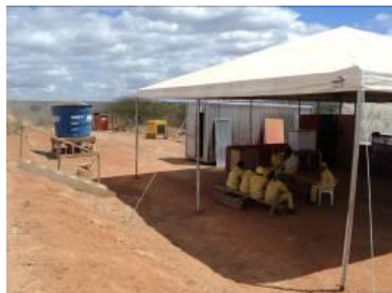
Foto 4.1.56 Instalações sanitárias, estaca 502.
