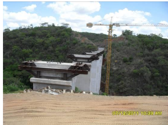
Foto 4.1.18 Ponte sobre o riacho Jardim, estaca 14397.
