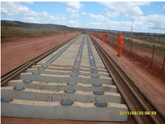
Foto 4.1.205 Colaboradores realizando serviços da superestrutura, estaca 15915.
