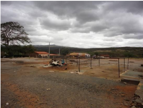
Foto 4.1.127 Canteiro de obras, município de Abaiara/CE (Antiga oficina da SUPEC).
