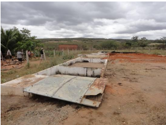
Foto 4.1.129 Canteiro de obras, município de Abaiara/CE (Antiga oficina da SUPEC).
