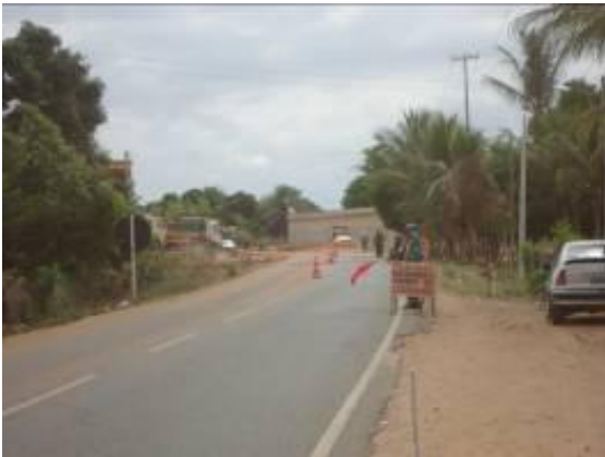
Foto 4.1.77 Desvio da CE que dá acesso à cidade de Porteiras/ CE, estaca 15436.
