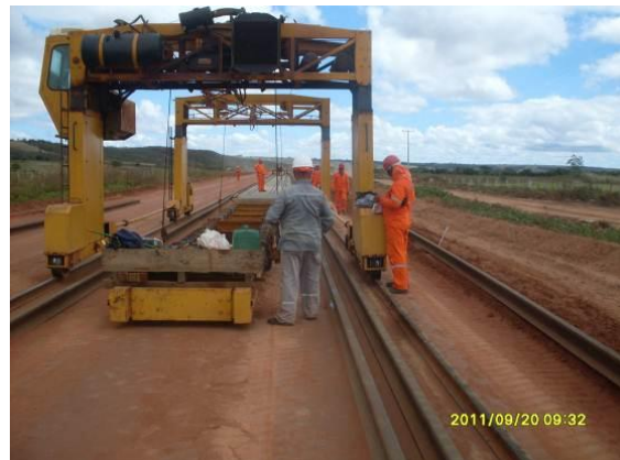
Foto 4.1.206 Frente de serviços da superestrutura, estaca 15911.
