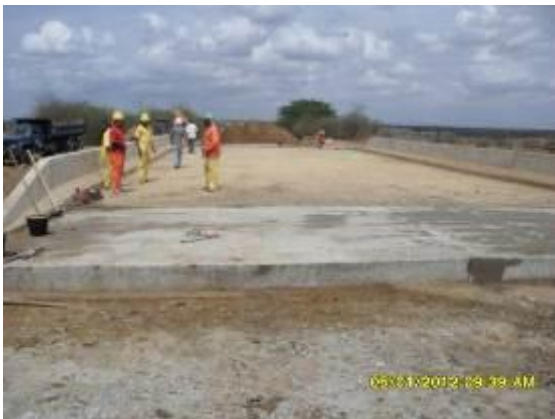
Foto 3.2.28 Conclusão dos serviços de construção do muro de arrimo do viaduto sobre a PE 475, Cedro/PE, estaca 13326.
