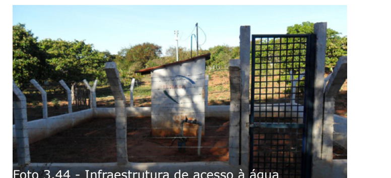
Foto 3.44 - Infraestrutura de acesso à água
