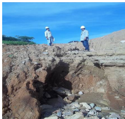
Foto 3-2 Vistoria do Programa de Monitoramento e Controle de Erosões
