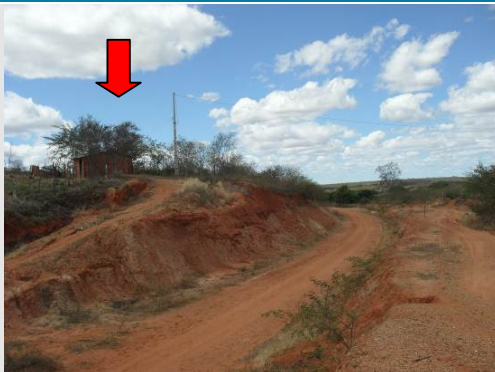
Foto 1 - Vista geral da moradia abandonada, Brejo Santo, setembro de 2011.
