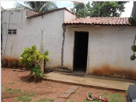
Foto 3 – Vista geral da residência, Brejo Santo/CE, outubro de 2011.
