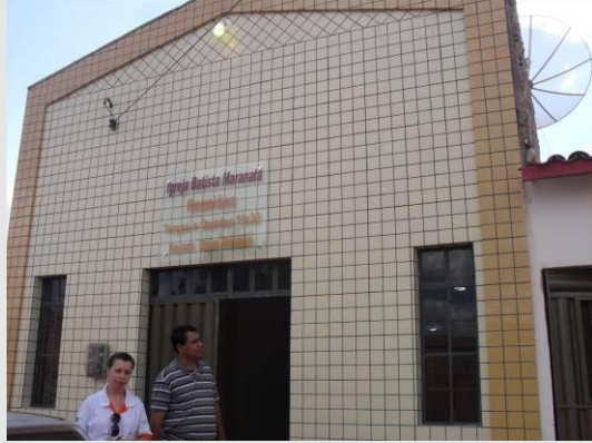
FOTO 1- Vista geral da igreja, Brejo Santo/CE, outubro de 2011.
