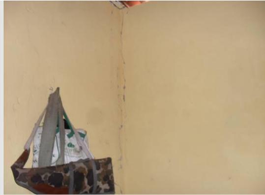
**Foto 4-** Rachaduras nas paredes
