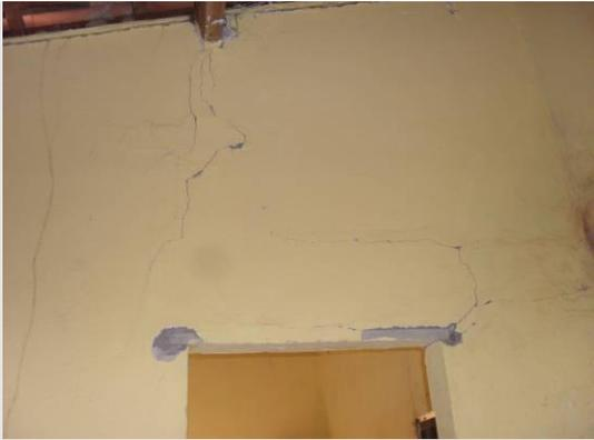
**Foto 3-** Rachaduras nas paredes
