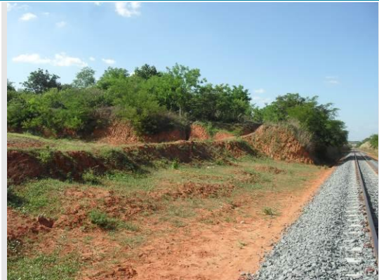
Foto 2- Área de jazida com ausência de cerca, Abaiara/CE, novembro de 2011.
