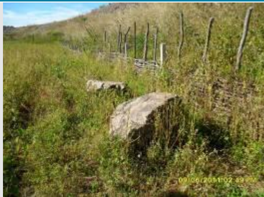
Foto 2 – Pedras do aterro dentro da propriedade
