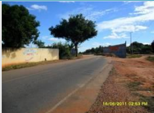
Foto 1 – Proximidade do motel com a faixa de domínio
