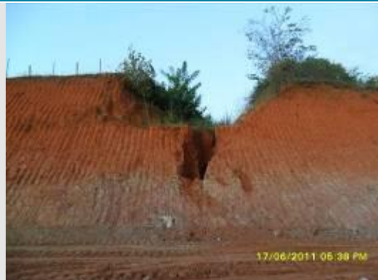
Foto 2 – Erosão no corte
