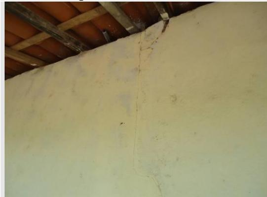
Foto 2 – Rachaduras nas paredes.
