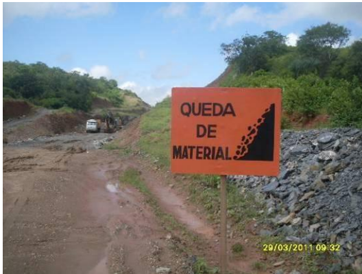
Foto 4-54 Placas de sinalização Estacas 14470 a 14736.
