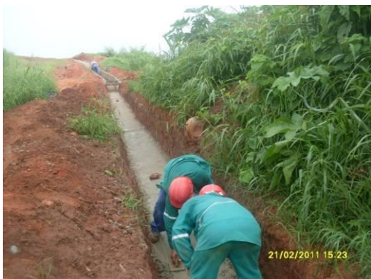
Foto 3-5 Colaboradores confeccionando canaletas nos taludes de aterro, estaca 16335.
