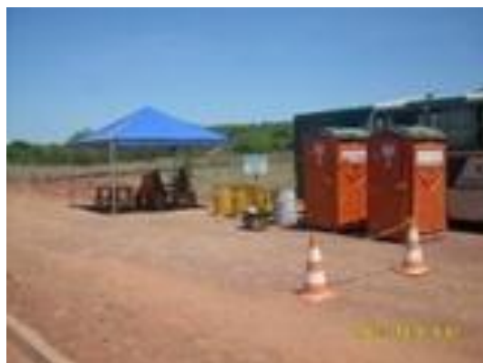
Foto 4-21 Instalação de apoio aos trabalhadores.
