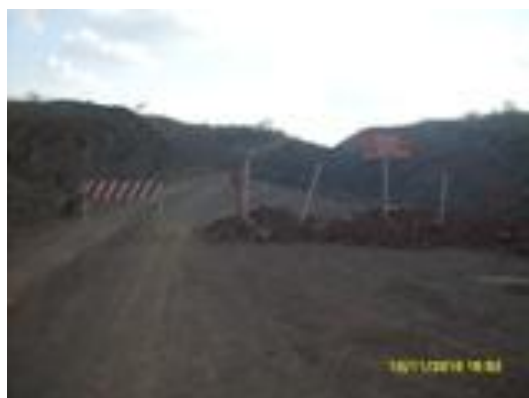
Foto 4-35 Instalação de sinalização no trecho.
