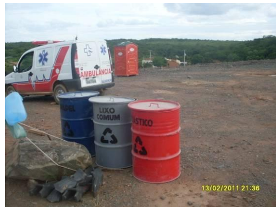
Foto 4-32 As instalações de apoio, banheiros químicos e tambores para coleta seletivas da CNO, estaca 14705.
