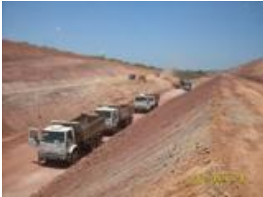
Foto 4-7 Retaludamento de corte.
