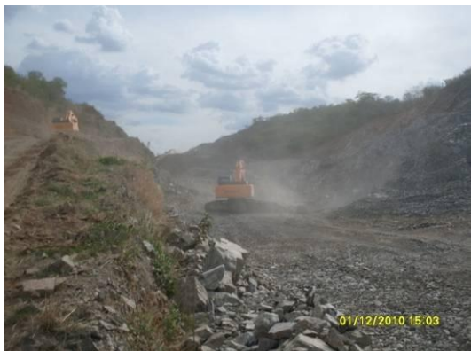
Foto 4-11 Realizando retaludamento de corte.
