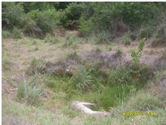
Foto 4-99 Talwegues obstruídos podendo causar degradação da vegetação estaca 13173.
