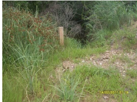
Foto 4-104 Talvegues obstruídos podendo causar degradação da vegetação estaca 12718.
