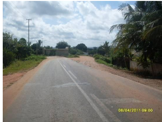
Foto 4-55 Desvio da passagem de Porteiras estaca 15437.
