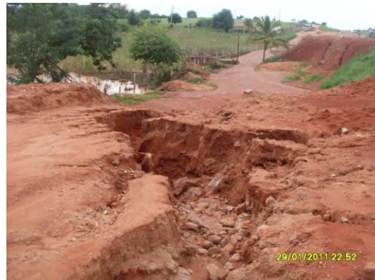
Foto 4-86 Erosão no talude do bota fora próximo o APP, assoreando o mesmo. Estaca 16442.
