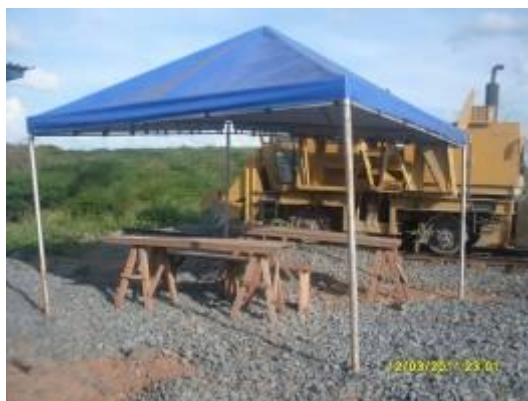
Foto 4-22 Instalação de apoio para refeições dos colaboradores da TIISA, estaca 16934.
