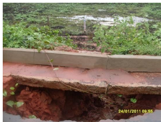
Foto 4-82 Bueiro construído um pouco abaixo do nível do solo apresenta acúmulo de água na estaca 14715.
