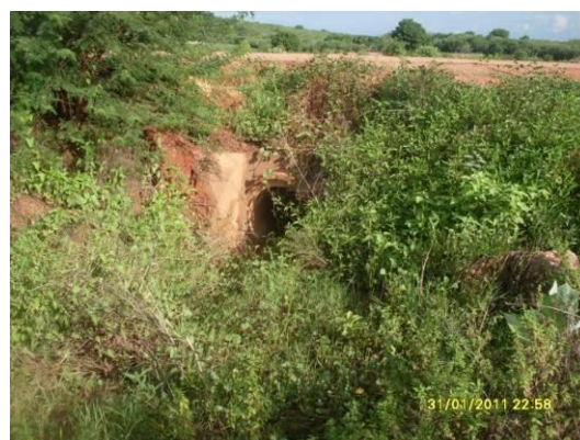
Foto 4-88 Processo erosivo no talude de corte com carregamento de solo para a plataforma da ferrovia. Estaca 15437.
