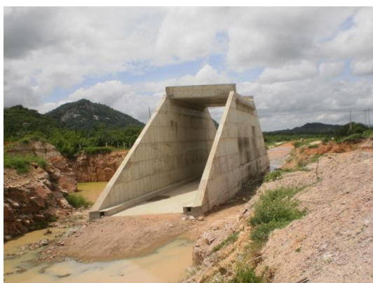
Foto 3-13 Conclusão do viaduto sob a BR 232.
