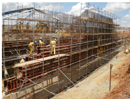
Foto 3-14 Construção de viaduto sob a PE483.
