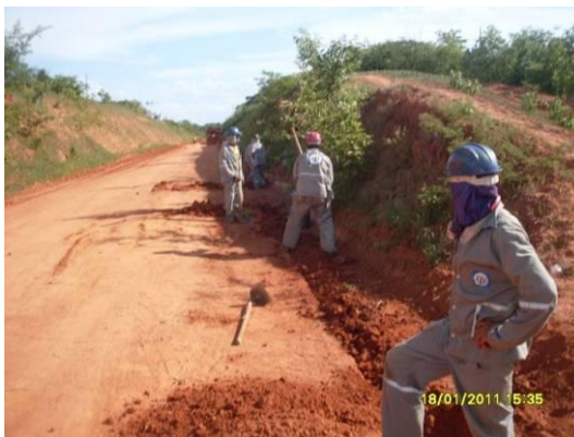
Foto 4-144 Desobstrução de canteiros e drenagens da ferrovia – (estaca 16390).
