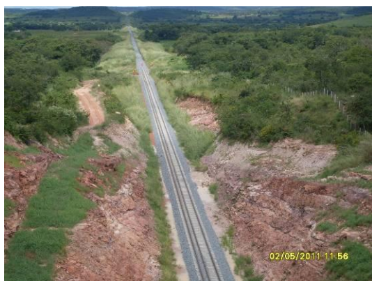
Foto 3-1 Superestrutura com 27 km de trilhos colocados.
