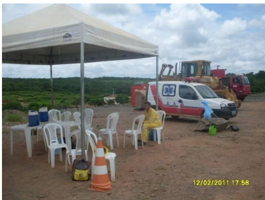
Foto 4-31 As instalações de apoio, banheiros químicos e tambores para coleta seletivas da CNO, estaca 14705.
