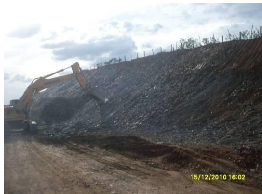
Foto 4-12 Realizando retaludamento de corte.
