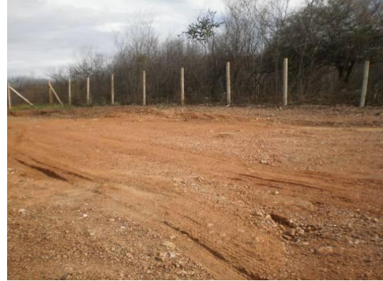
Foto 4-62 Resíduos (resto obra) retirados. Estaca 187
