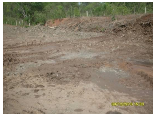
Foto 4-64 Remoção do solo “contaminado”.
