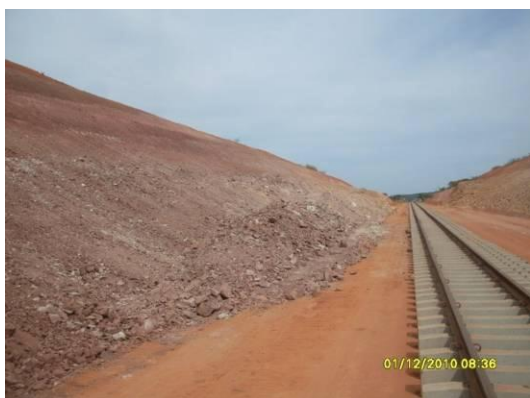
Foto 4-13 Reconformação de corte.
