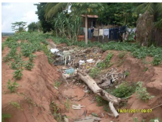
Foto 4-81 Sequências de erosões no talude de corte próximo a residências na estaca 15433.
