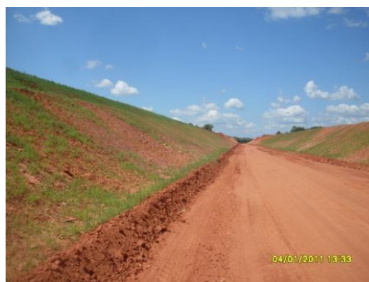
Foto 4-143 cobertura vegetal nos taludes de corte.
