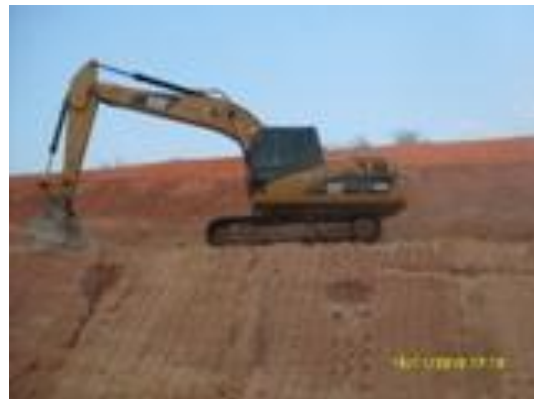
Foto 4-10 Retaludamento de corte.
