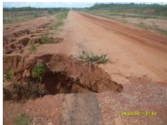
Foto 4-112 Sequências de erosões, estaca 13617.
