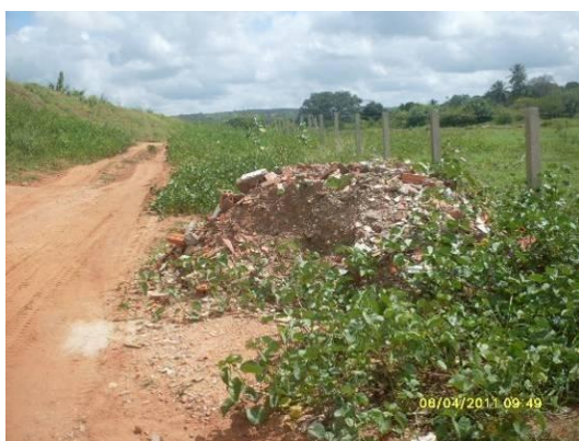
Foto 4-71 Resíduos da construção civil na faixa de domínio estaca 15270.
