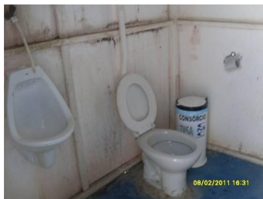
Foto 4-26 Higienização nas instalações sanitárias próximas ao refeitório do consórcio TIISA e CMC.
