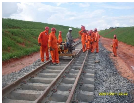
Foto 3-2 Serviços executados com alinhamento de trilhos e complemento de britas.
