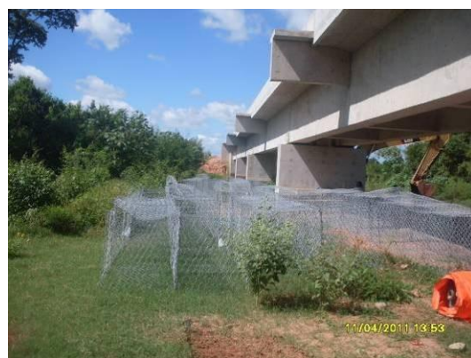
Foto 4-19 Ponte do Riacho de Porteiras, estaca 15362.
