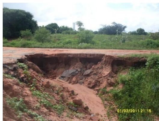
Foto 4-88 Processo erosivo no talude de corte com carregamento de solo para a plataforma da ferrovia. Estaca 15437.
