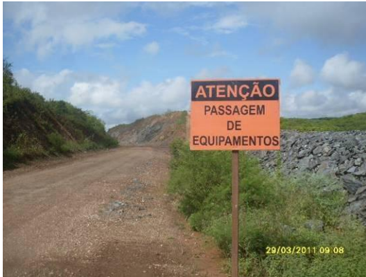
Foto 4-52 Placas de sinalização Estacas 14470 a 14736.
