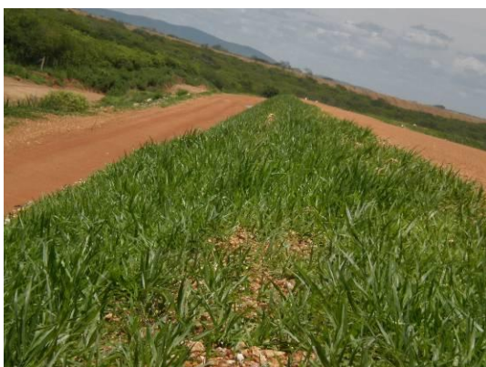
Foto 3-9 Revegetação de talude de aterro.
