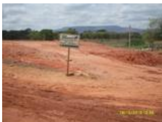
Foto 4-58 Correção da não conformidade.
