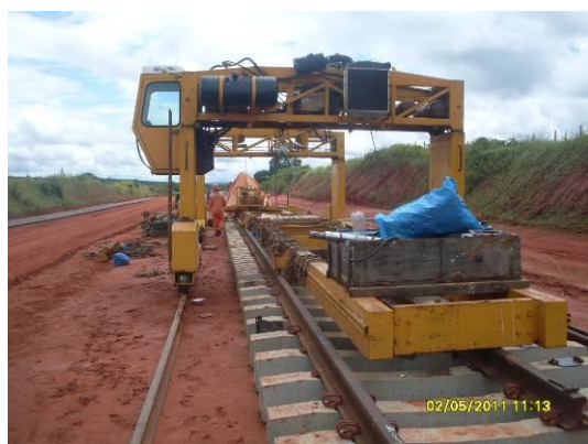
Foto 3-3 Colocação de trilho próximo à estaca 16188.
