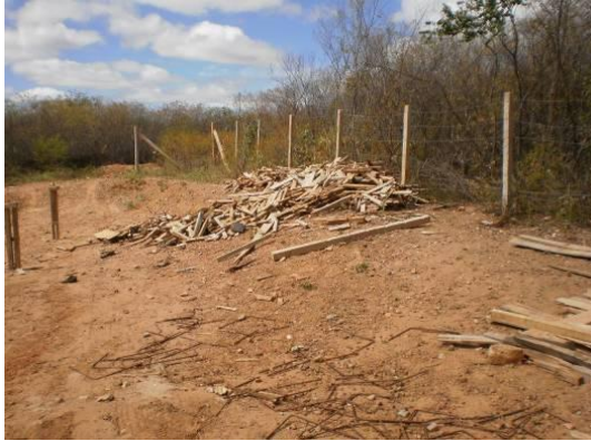
Foto 4-61 Resíduos (resto de obra) espalhados. Estaca 187
