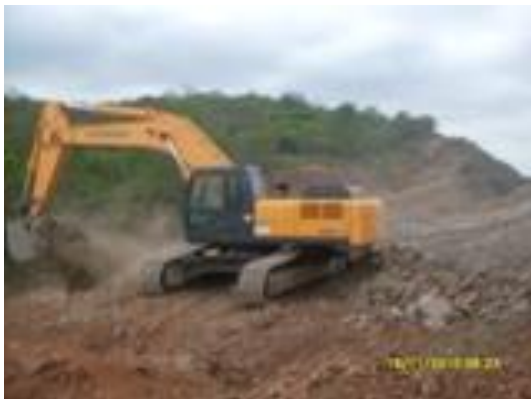
Foto 4-9 Retaludamento de corte.
