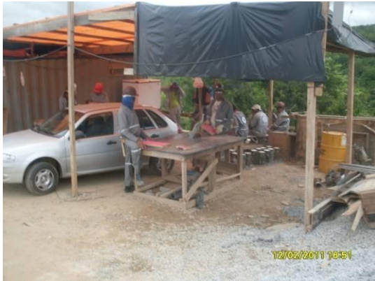
Foto 4-29 A instalação de apoio do canteiro de obra da EIT na ponte do Riacho Jardim, estaca 14405.
