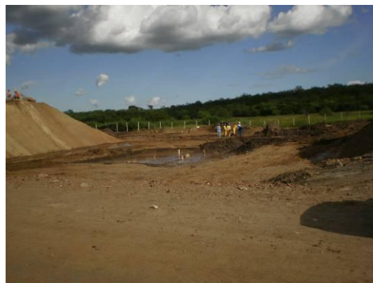
Foto 3-12 Início de construção de ponte.
