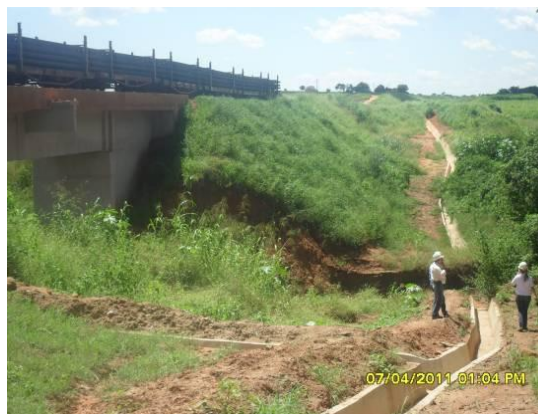
Foto 4-2 Vistoria na obra.
