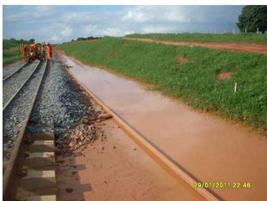
Foto 4-87 Construção do cruzamento de via com a superestrutura na estaca 16451 causou obstrução da drenagem existente.
