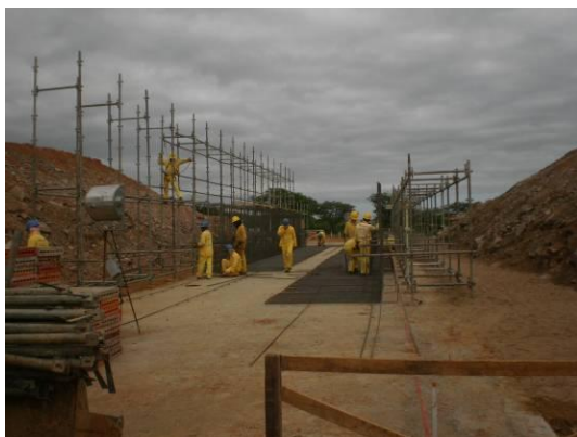
Foto 3-11 Início de construção de passagem inferior.
