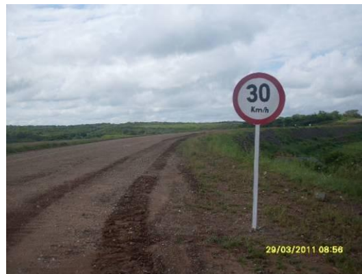
Foto 4-49 Placas de sinalização Estacas 14470 a 14736.
