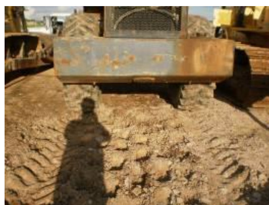
Foto 4-60 Correção do solo contaminado
