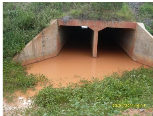
Foto 4-82 Bueiro construído um pouco abaixo do nível do solo apresenta acúmulo de água na estaca 14715.
