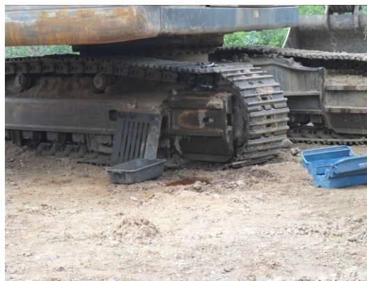
Foto 4-74 Colocação de bandeja após a recomendação
