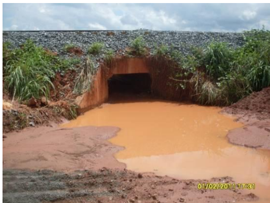
Foto 4-96 BSC - estaca 16932, obstruindo e acumulando água, podendo prejudicar a vegetação.
