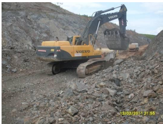
Foto 3-6 Retirada de solo proveniente do retaludamento dos cortes, estaca 14712.
