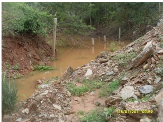
Foto 4-85 Corpo hídrico obstruído proveniente de material carregado do talude de corte estaca 14348.
