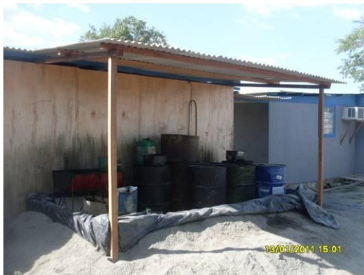
Foto 4-67 Baias para o armazenamento de resíduos oleosos.
