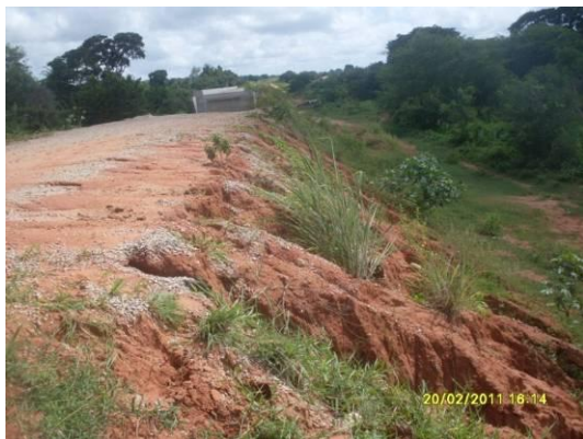
Foto 4-111 Sequência de erosões bem avançadas estacas 15358 á 15360.
