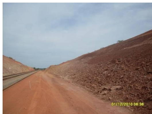
Foto 4-14 Reconformação de corte.
