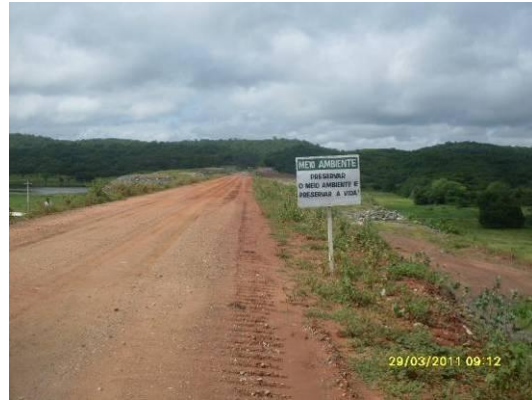
Foto 4-53 Placas de sinalização Estacas 14470 a 14736.
