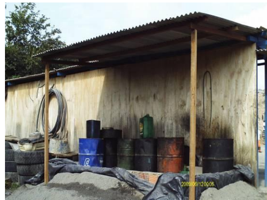
Foto 4-68 Solo contaminado mesmo depois da construção da baia.
