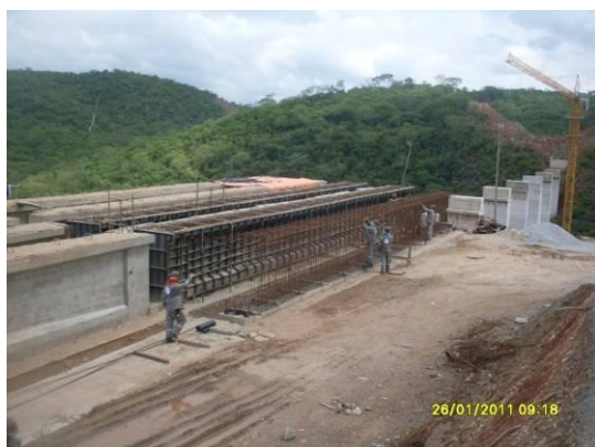
Foto 4-17 Serviços de construção das vigas da ponte do riacho Jardim, estaca 14405.
