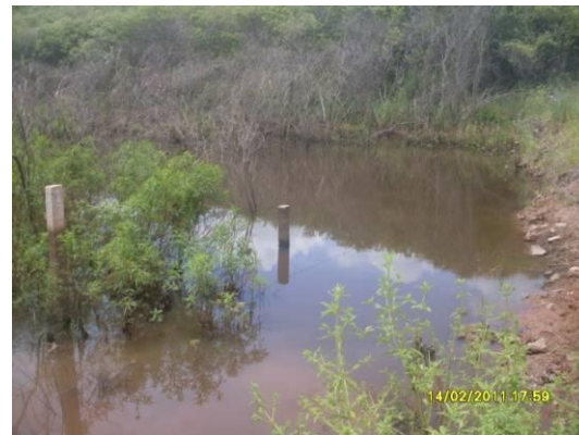
Foto 4-100 Talwegues obstruídos podendo causar degradação da vegetação estaca 13125.
