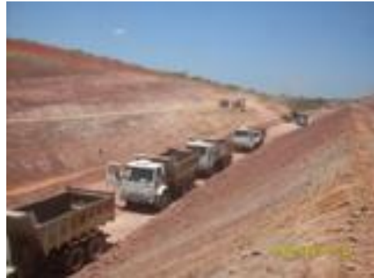
Foto 4-8 Retaludamento de corte.
