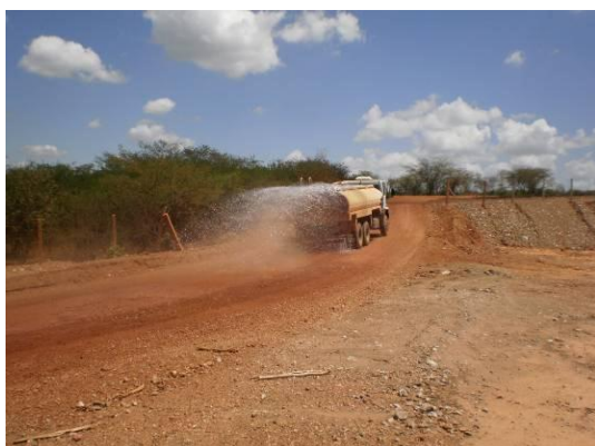
Foto 4-78 Via de acesso sendo umectada.
