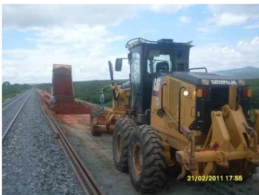
Foto 3-7 Reparos no sublastro.
