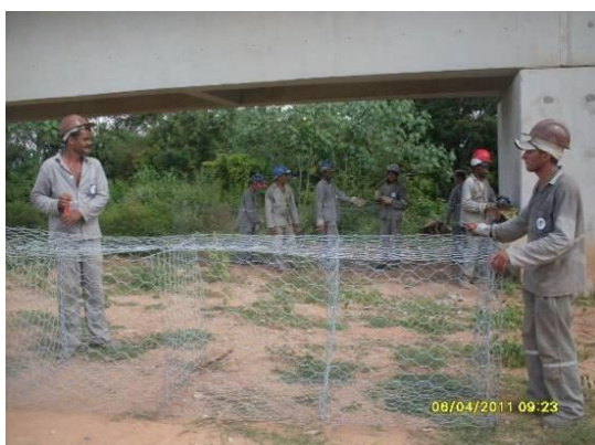
Foto 4-18 Colaboradores da EIT trabalhando na montagem do muro de gabião da ponte do riacho de Porteiras estaca 15362.
