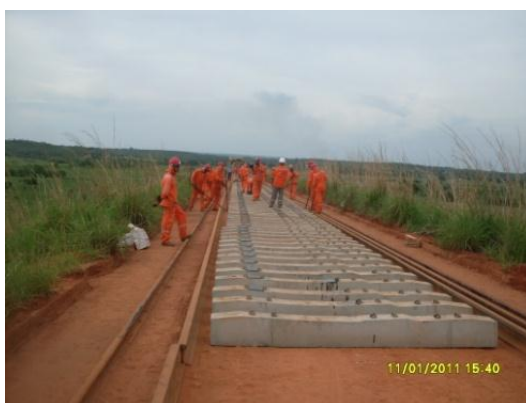
Foto 3-4 Colocação de dormente, estaca 16446.
