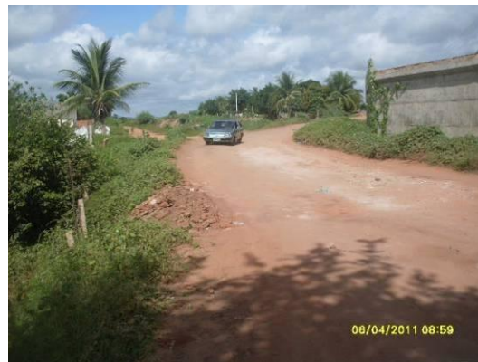
Foto 4-56 Desvio da passagem de Porteiras estaca 15437.
