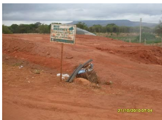
Foto 4-57 Correção da não conformidade.
