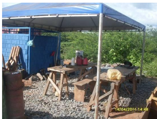
Foto 4-23 Instalação de Apoio aos colaboradores do consórcio TIISA e CMC estaca 16934.
