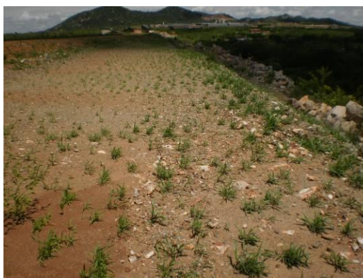
Foto 3-10 Revegetação de talude de aterro.
