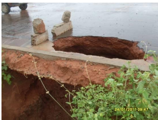
Foto 4-81 Sequências de erosões no talude de corte próximo a residências na estaca 15433.
