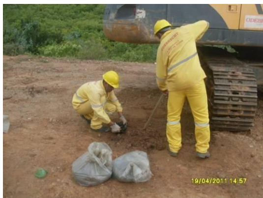
Foto 4-75 Colaboradores recolhendo o solo contaminado, estaca 14329.
