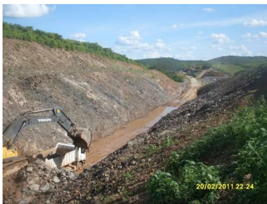
Foto 3-8 Retirada de solo da plataforma proveniente do retaludamento, estaca 14475.
