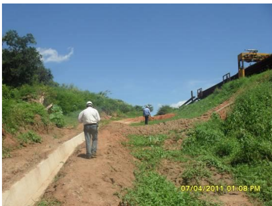
Foto 4-1 Vistoria na obra.
