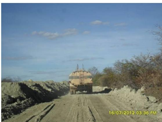
Foto 3-69 Caminhão pipa realizando umectação de via, estaca 61337.
