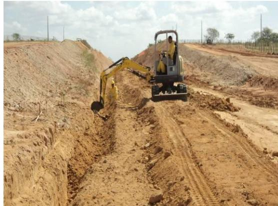
Foto 3-37 Escavação da calha para construção do sistema de drenagem do corte 64, estaca 73063.
