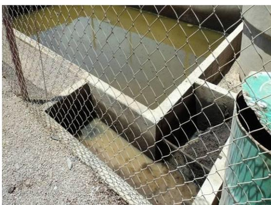
Foto 3-89 Separador de óleo e água – SAO da rampa de lavagem de veículos, canteiro de obras central, Nascente-PE.
