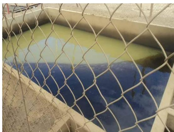
Foto 3-90 Caixa de decantação de óleos do SAO no canteiro de obras central, Nascente-PE.
