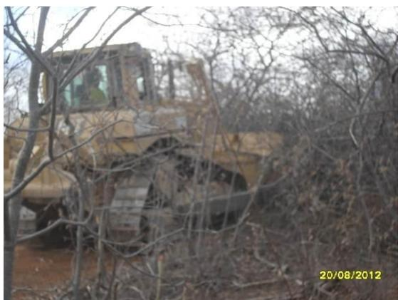
Foto 3-100 Supressão vegetal e limpeza do solo com trator de esteira, estaca 70680.
