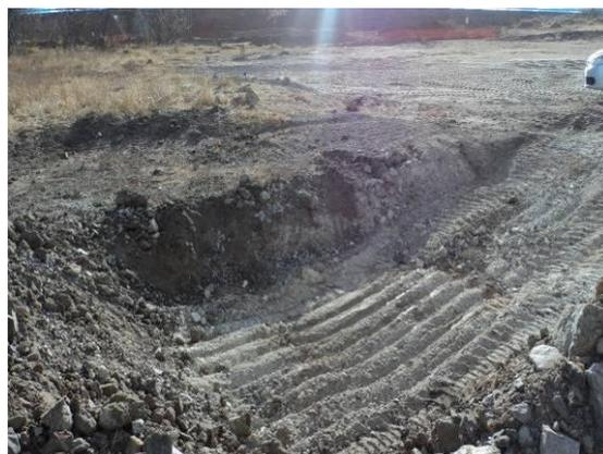
Foto 3-86 Resíduos de concreto removidos do solo, estaca 72170.
