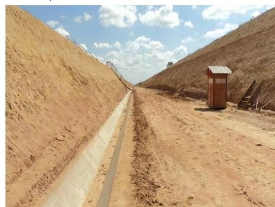
Foto 3-38 Execução do sistema de drenagem do corte 64, estaca 73070.
