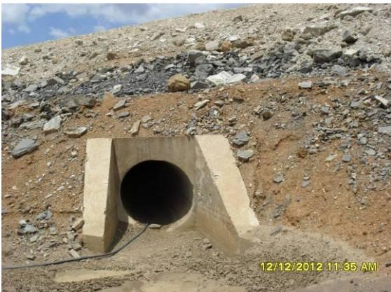
Foto 2-3 – Bueiro simples tubular desobstruído, estaca 61601.
