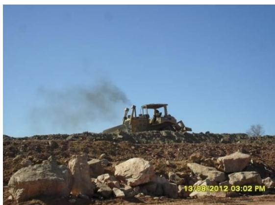
Foto 3-15, Execução do aterro para o encabeçamento da ponte Pilões, estaca 60560.
