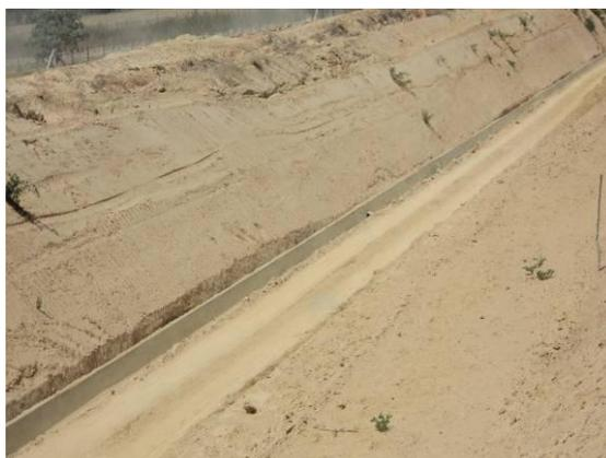
Foto 3-26 Corte 64, estaca 73080, com sistema de drenagem concluído.
