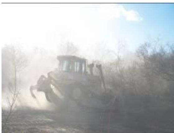
Foto 3-102 Supressão vegetal e limpeza do solo com trator de esteira, estaca 70930.
