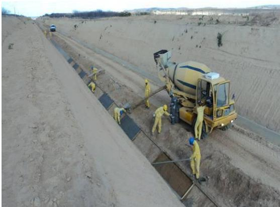
Foto 3-36 Execução do sistema de drenagem do corte 64, estaca 73080.
