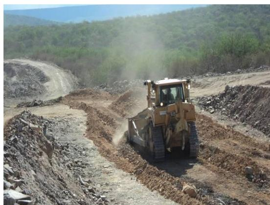
Foto 2-11 Execução de corte, estaca 70780.
