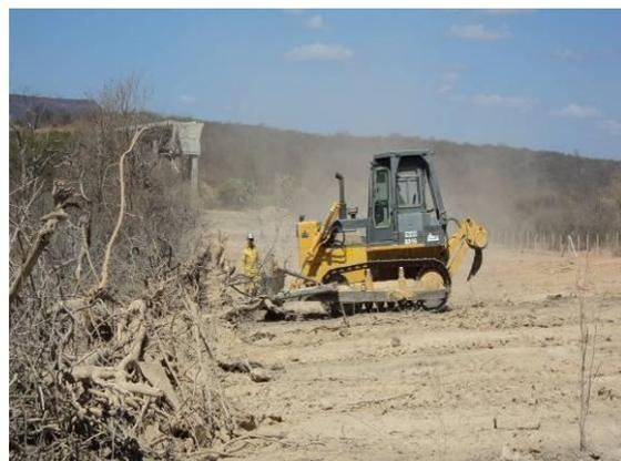
Foto 3-10 Supressão vegetal e limpeza do solo com trator de esteira, estaca 70615.
