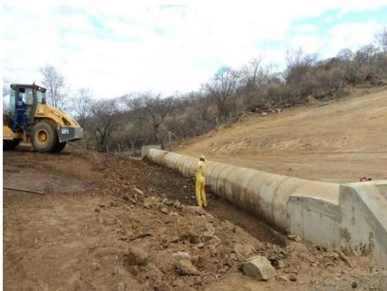
Foto 3-23 Execução de aterro da base do bueiro, estaca 70973.
