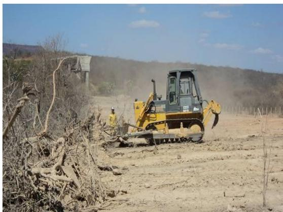
Foto 3-104 Supressão vegetal e limpeza do solo com trator de esteira, estaca 70615.
