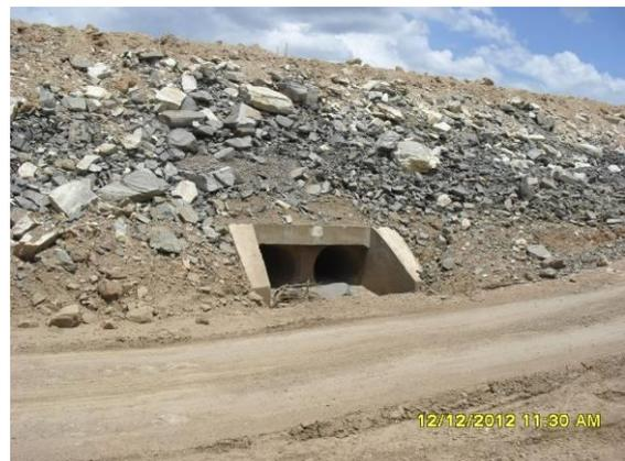
Foto 2-2 Bueiro tubular duplo concluído e desobstruído, estaca 63246.
