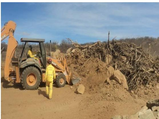
Foto 3-112 Remoção de material lenhoso da APP 12, estaca 71170.
