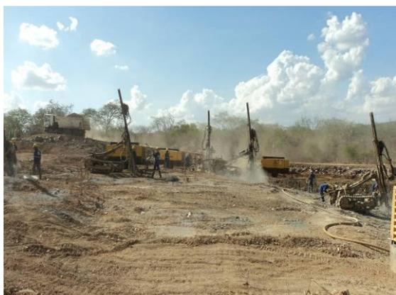
Foto 2-12 Perfuração para desmonte de rocha, estaca 70748.
