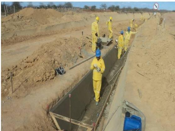
Foto 3-34 Execução do sistema de drenagem do corte 66, estaca 73210.
