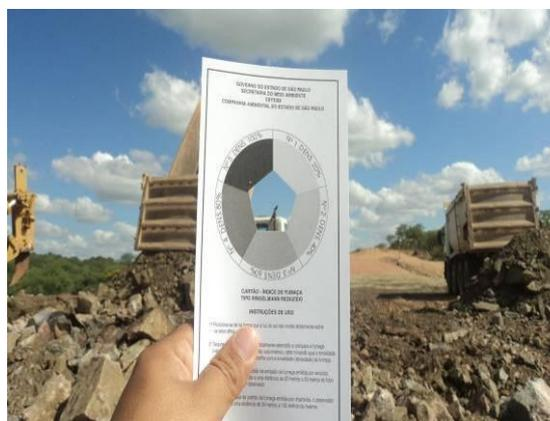
Foto 3-74 Aferição de fumaça negra em caminhão basculante, estaca 71454.
