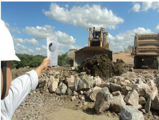
Foto 3-75 Técnico realizando aferição de fumaça negra, estaca 71454.
