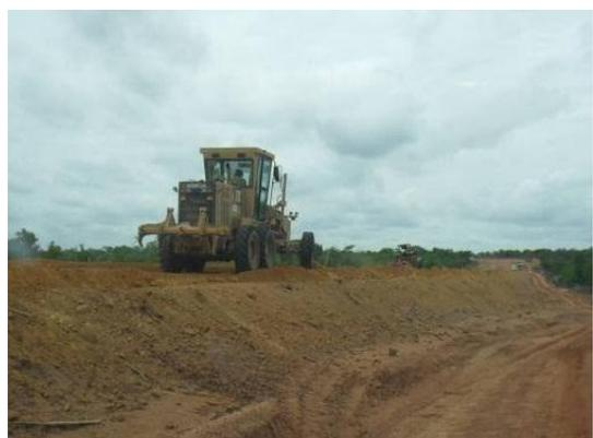
Foto 3-33 Nivelamento de aterro estaca 12460, lote 1.
