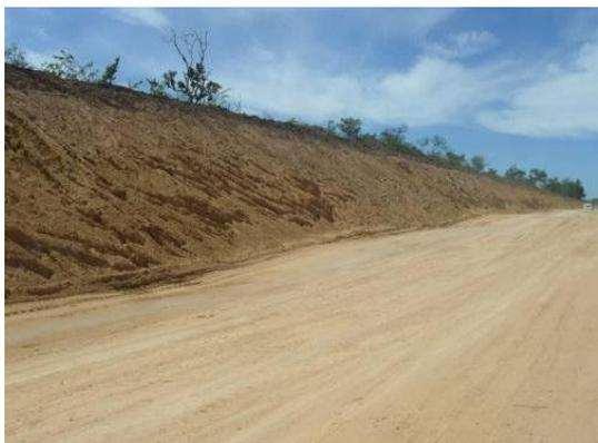
Foto 3-19 Vista de talude de corte não reconformado (lado direito), próximo à estaca 12175, lote 1.
