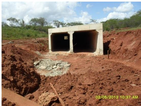
Foto 2-10 Bueiro e fase de construção, estaca 20552.
