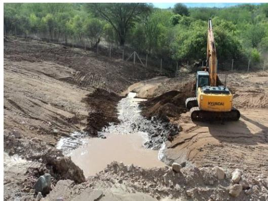
Foto 3-111 Limpeza de corpo hídrico, estaca 71469.
