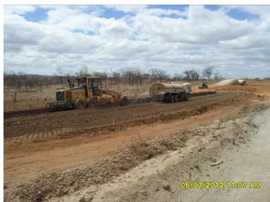
Foto 2-18 Atividade de terraplanagem, estaca 61469.
