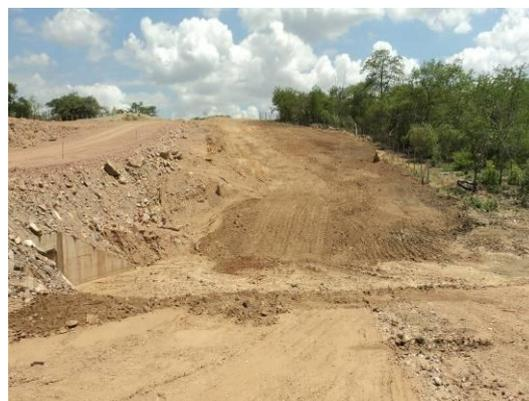
Foto 3-115 Corpo hídrico da APP 16 desobstruído e APP reconformada, estaca 71570.
