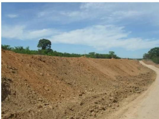
Foto 3-29 Talude de aterro com processo erosivo corrigido, estaca 12390, lote 1.
