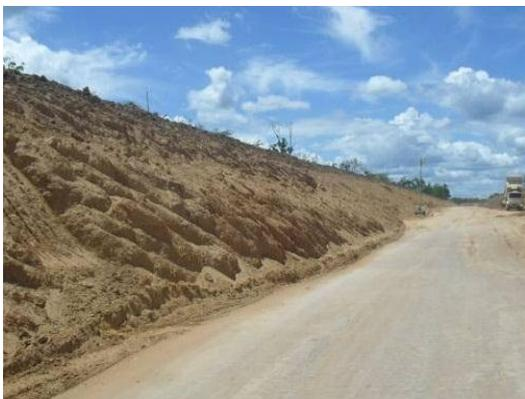
Foto 3-15 Vista de talude de corte não reconformado, estaca 12180, lote 1.
