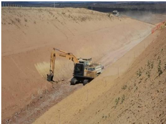
Foto 2-27 Execução de corte, estaca 73070.
