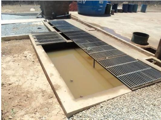
Foto 3-92 Caixa de SAO em funcionamento, no canteiro de obra avançado lote 6.
