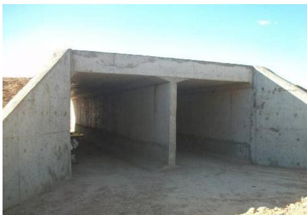
Foto 2-3 – Bueiro triplo com duas unidades de vazão obstruída formando ponto de armazenamento e captação de água, estaca 12401 + 12,00.
