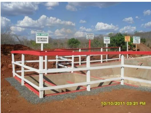
Foto 3-90 Decantador para lavagem de autobetoneira e reutilização da água estaca 20472.
