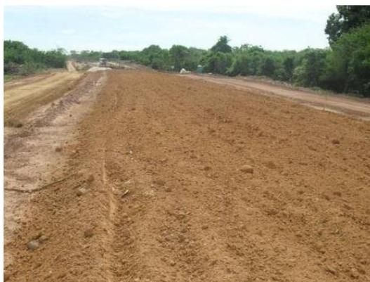
Foto 3-30 Material espalhado para compactação e elevação de aterro, estaca 12690, lote 1.
