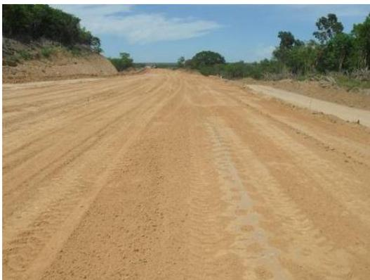
Foto 3-28 Aterro compactado, após raspagem de material não consolidado, estaca 12400, lote 1.
