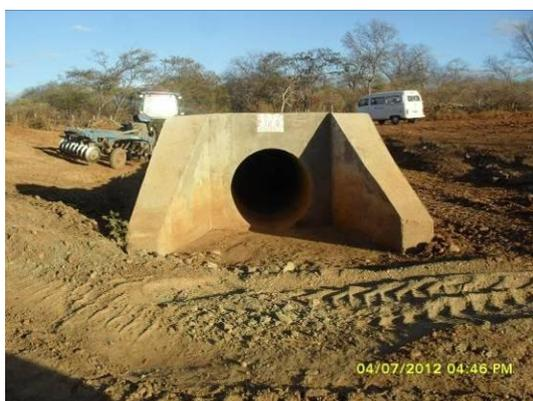
Foto 2-16 – Bueiro simples tubular desobstruído, estaca 61601.
