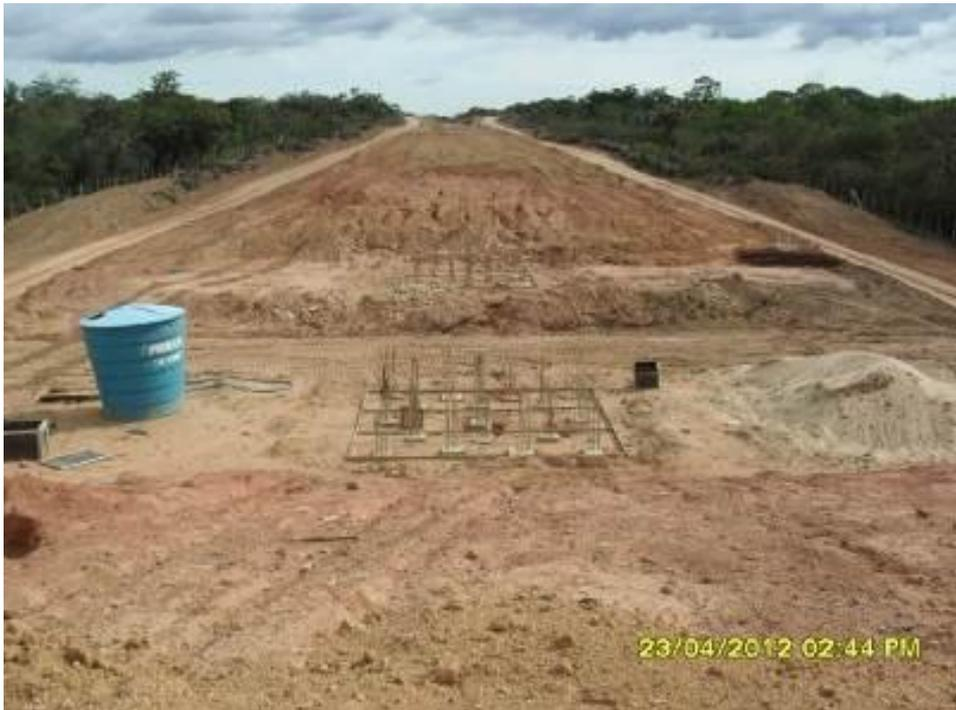
Foto 2-6 Instalação de estaca raiz, pontilhão, 11698.
