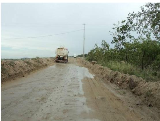
Foto 3-77 Caminhão tanque realizando umectação de vias, estaca 72200.
