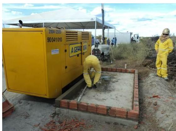
Foto 3-53 Construção da baia e contenção para unidade geradora, estaca 63368.
