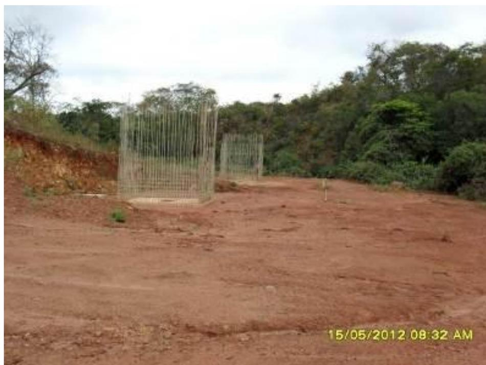
Foto 2-13 Construção dos pilares da ponte sobre o rio Itaueira, estaca 20460.
