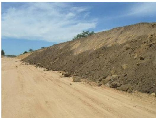
Foto 3-20 Vista de talude de corte não reconformado (lado esquerdo), próximo à estaca 12175, lote 1.
