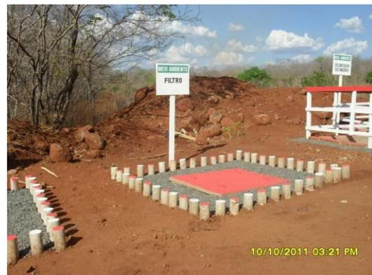
Foto 3-91 Filtro do decantador para lavagem de autobetoneiras, estaca 20472, lote 2.
