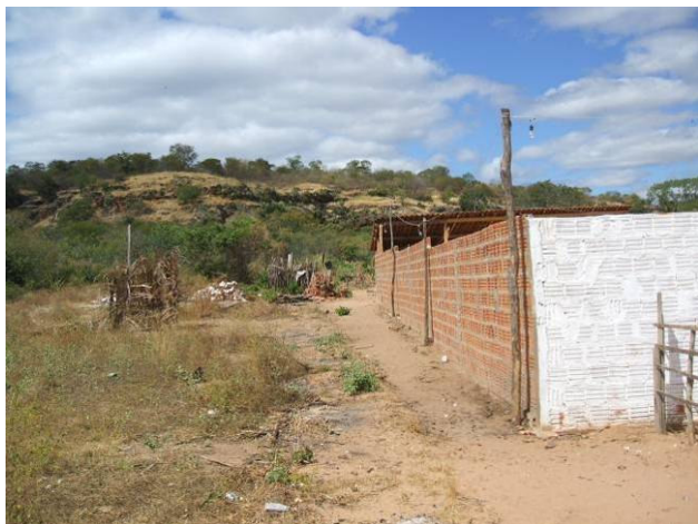
Foto 4.1-37 – ADA – Vista do traçado da ferrovia para leste, observando-se em primeiro plano terrenos planos arenosos de cobertura cenozóica com edificação a ser afetada e, ao fundo, tabuleiro suportado por arenitos e siltitos.
