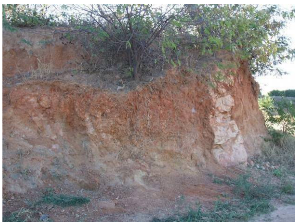
Foto 4.1-71 – AID – Talude de corte de estrada exibindo solos residuais de biotita gnaiesses envolvendo veio de quartzo.
