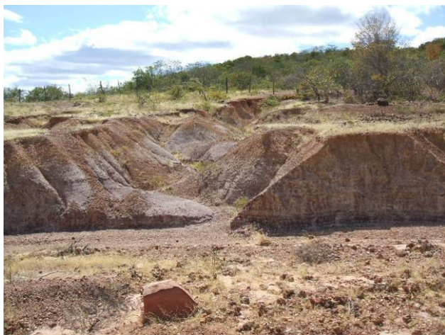
Foto 4.1-41 – ADA – Erosão laminar, em sulcos e ravinas desenvolvida em pelitos da Formação Pimenteiras, provocada por sua exposição em decorrência de exploração dos solos superficiais.
