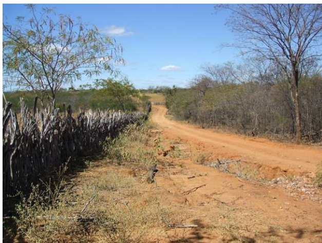
Foto 4.1-47– ADA – Vista do traçado da ferrovia na direção oeste, observando-se desenvolvimento de ravina em ponto baixo da estrada vicinal.
