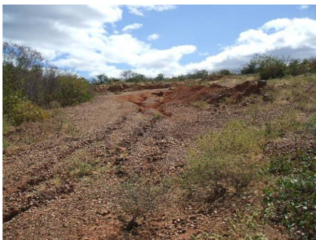
Foto 4.1-39 – ADA – Vista de área de empréstimo abandonada em terrenos ao lado da rodovia, observando-se a instalação de processos erosivos.
