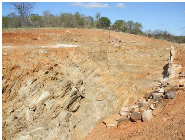
Foto 4.1-46– AID – Exposição de micaxistos de foliação subvertical em escavação feita para construção da barragem de abastecimento Poço Juá, ora rompida.
