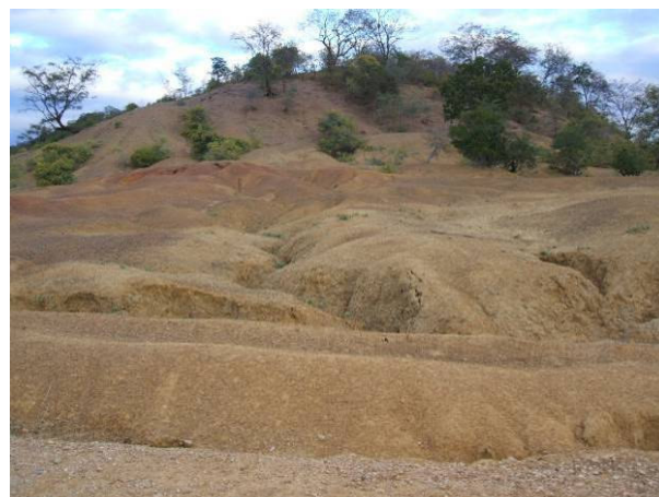
Foto 4.1-28 – AID – Erosão laminar e em sulcos em pelitos da Formação Pimenteiras.
