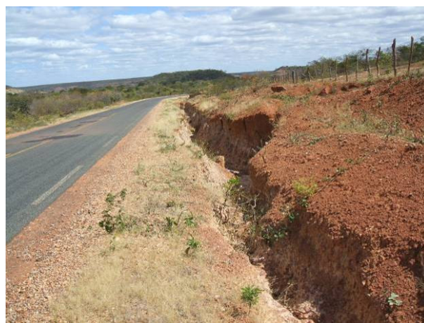
Foto 4.1-40 – ADA – Ravina desenvolvida em pelitos da Formação Pimenteiras por escoamento concentrado lateral ao leito da rodovia.
