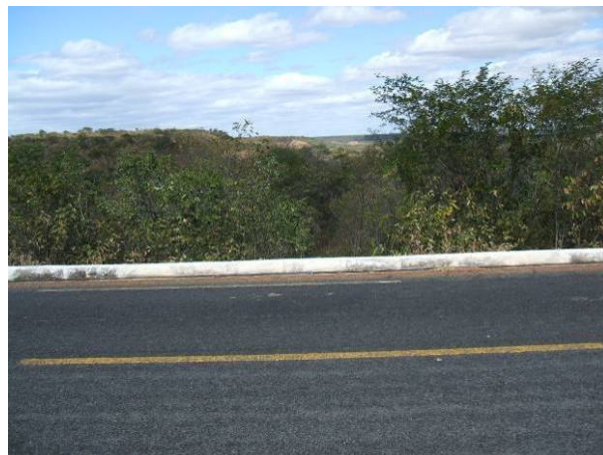
Foto 4.1-38 – ADA - Vista do traçado da ferrovia para oeste, a partir de sua transposição sobre a PI-?, observando-se sucessão de tabuleiros a serem vencidos.
