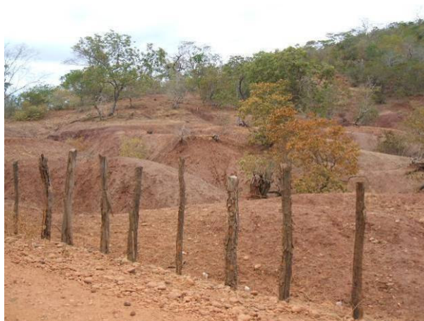
Foto 4.1-20 – AID – Erosão laminar e em sulcos provocada por escoamento difuso de águas pluviais em pelitos da Formação Longá.
