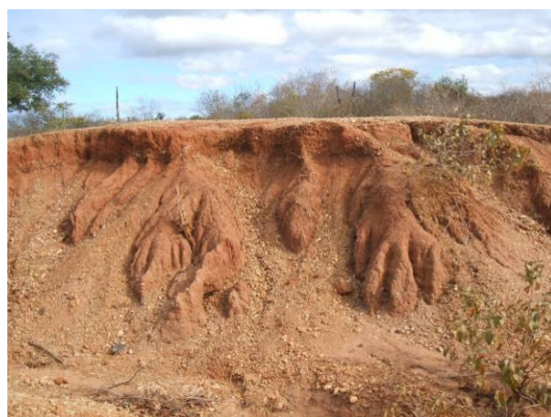
Foto 4.1-26 – AID – Erosão laminar em solos residuais de pelitos da Formação Longá subjacentes a camada de solos coluvionares argilosos com cascalho.
