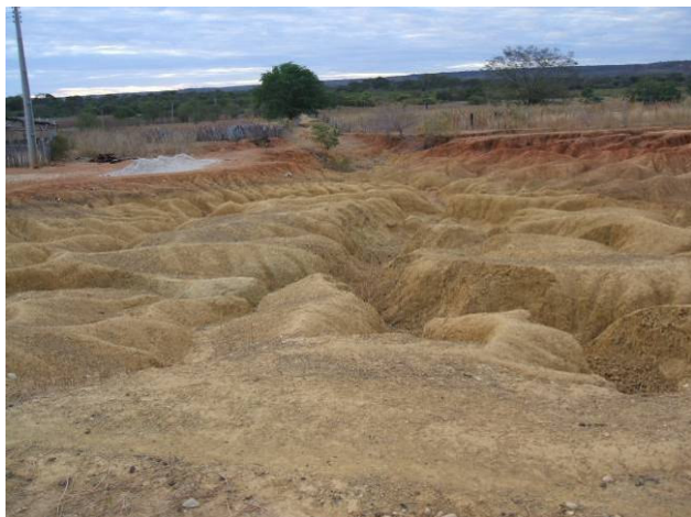
Foto 4.1-29 – AID – Erosão laminar e em sulcos em pelitos da Formação Pimenteiras.
