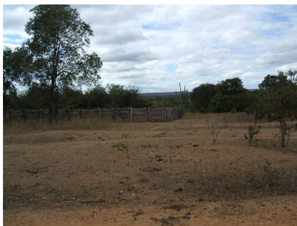
Foto 4.1-22 – ADA – Vista do traçado da ferrovia para leste, observando-se em primeiro plano terrenos aplanados afetados por erosão laminar e, ao fundo, a chapada da Sambaíba, sustentada por arenitos e siltitos da Formação Cabeças.
