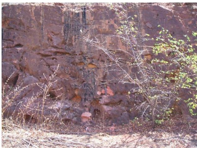
Foto 4.1-9 – ADA – Talude de corte da PI-140, próximo ao eixo de traçado, exibindo arenitos avermelhados da Formação Poti.
