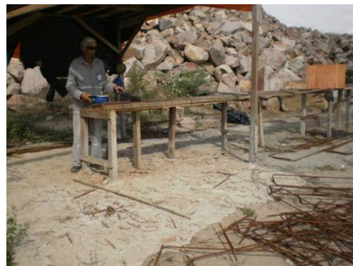
Foto 4-23 Resíduos coletados. Estaca 619 ponte sobre o Rio Miguel.
