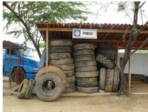
Foto 4-31 Armazenamento de resíduos (pneu) em baias no canteiros de obras de Parnamirim-PE
