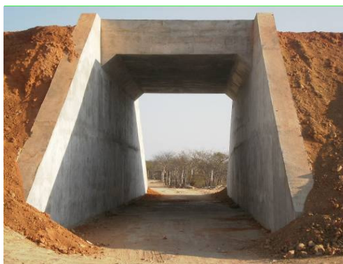
Foto 3-85 Passagem em Desnível. Estaca 900
