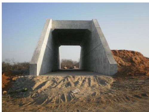
Foto 3-86 Passagem em Desnível. Estaca 1012
