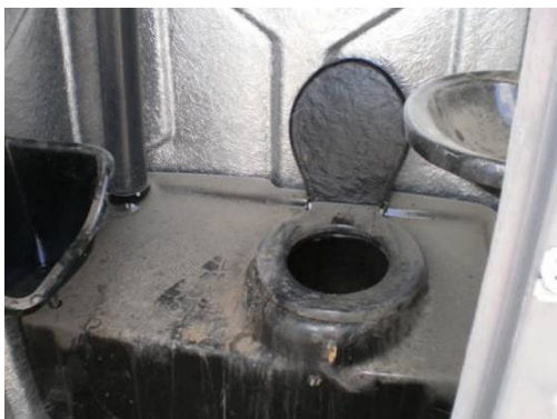
Foto 4-40 Banheiro não higienizado. Estaca - 3032
