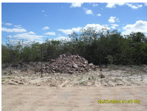
Foto 4-26 Material de escavação fora da faixa. Estaca 783
