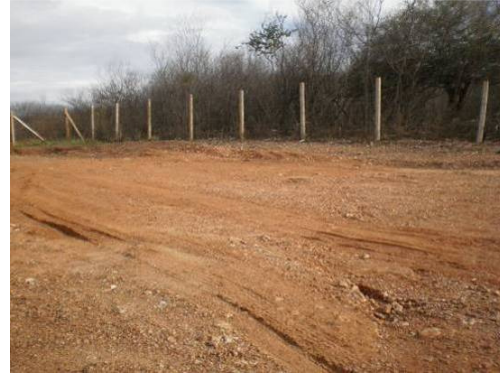
Foto 4-29 Resíduos (resto obra) retirados. Estaca – 187
