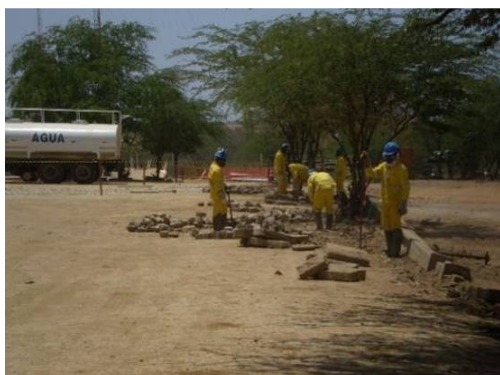
Foto 4-51 Reforma do pavimento exterior.
