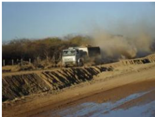
Foto 4-54 Frente de serviço com poeira devido a falta de umectação
