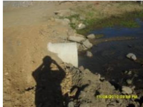
Foto 4-68 Rio Gravatá sem drenagem provisória. Estaca 1768 Lote III. Foto 4-69 Drenagem provisória no Rio Gravatá. Estaca 1768 Lote III.
