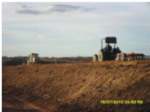
Foto 3-1 Lançamento de material para composição de sub-lastro. Estaca 4690.
