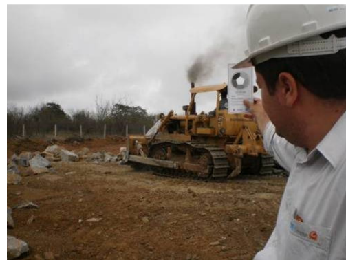
Foto 4-57 – Técnico realizando o monitoramento de fumaça negra trator esteira (estaca 2785 Lote 2).
