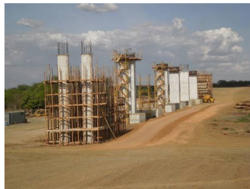
Foto 3-82 Ponte Rio Traíras. Estaca - 1909
