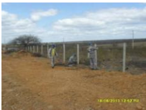
Foto 4-52 Reparos em cercas.
