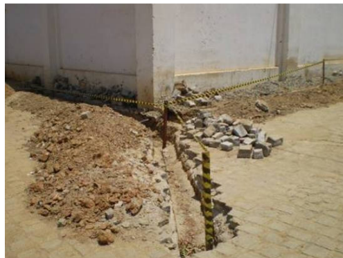
Foto 4-50 Instalação de rede de água e esgoto
