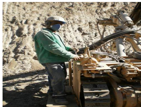
Foto 4-14 Colaborador usando EPI. Estaca 47 (Parnamirim/Trindade)
