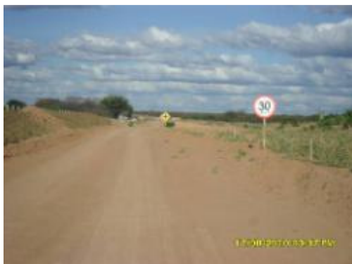
Foto 4-15 Sinalização de cruzamento de vicinal com obra da Transnordestina.
