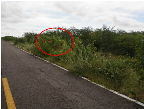
Foto 4-10 Falta de manutenção nas placas de sinalização.
