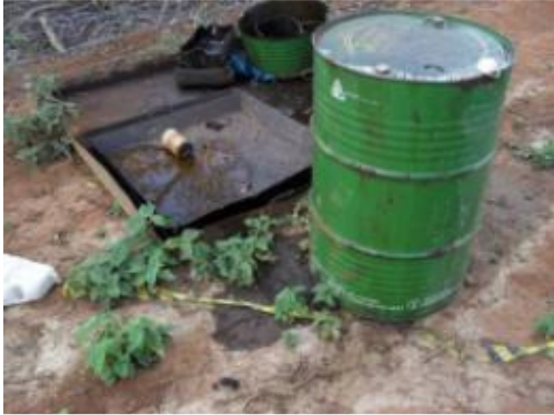
Foto 4-35 Armazenamento de óleo fora de bandeja
