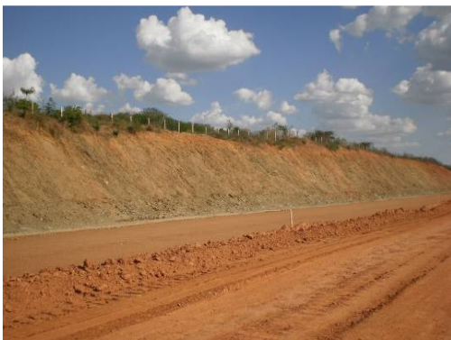
Foto 4-65 reconformação de talude (estaca 245, lote II).
