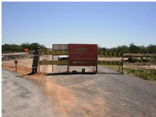
Foto 4-12 Desvio para construção do viaduto
