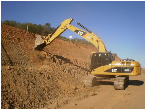
Foto 4-63 reconformação de talude (estaca 650).
