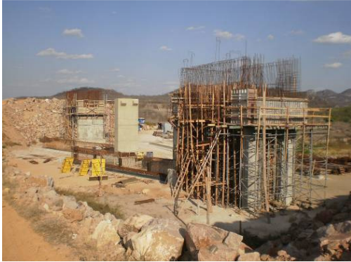
Foto 3-79 Ponte Riacho do Miguel. Estaca – 619
