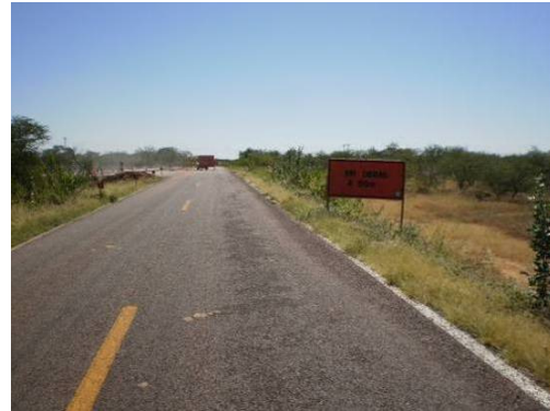
Foto 4-11 Realização de manutenção nas placas de sinalização.
