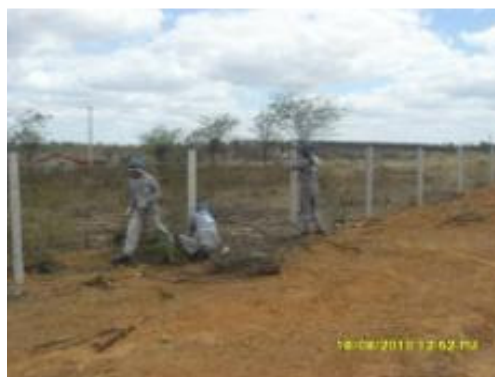
Foto 4-53 Reparos em cercas.
