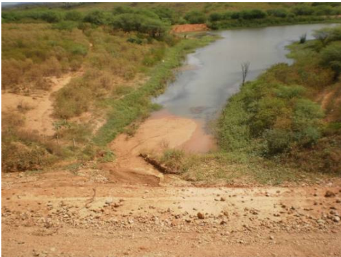
Foto 4-70 Açude assoreado. Estaca 166, Lote II.
