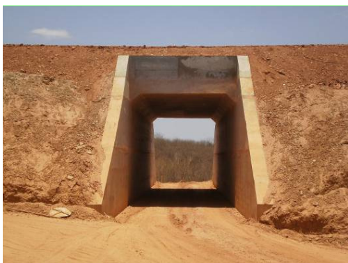
Foto 3-84 Passagem em Desnível. Estaca 187
