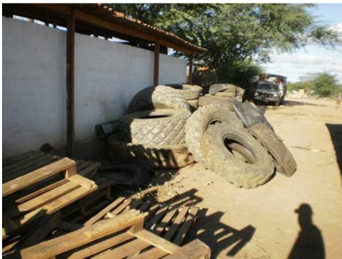
Foto 4-30 – Armazenamento de resíduos (pneus) de forma irregular no canteiro de obras em Parnamirim-PE.
