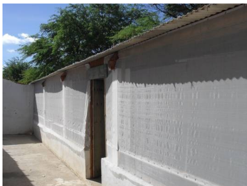
Foto 4-46 Refeitório da Central de Concreto. Sítio Bode Assado/Salgueiro-PE.
