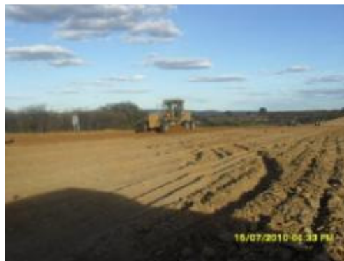
Foto 3-2 Lançamento de material para composição de sub-lastro. Estaca 4714.
