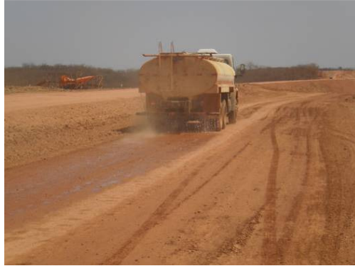
Foto 4-55 Via de serviço umidificada. Estaca-62
