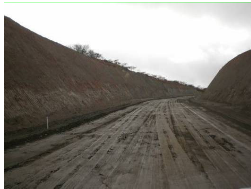
Foto 4-64 reconformação de talude (estaca 3130).
