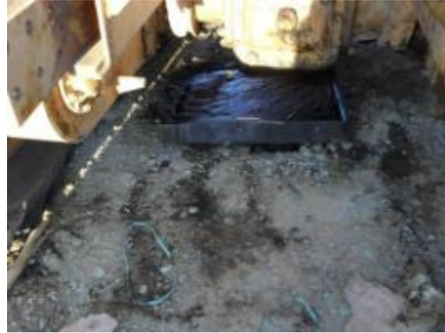
Foto 4-36 Solo contaminado por óleo
