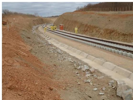
Foto 2-9 Construção de canaletas, estaca 27 Lote 3.
