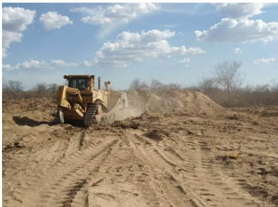
Foto 3-11 Instalação de caixa de empréstimo em local autorizado pela GEMAB, entre as estacas 1452 a 1457 Lote 2.
