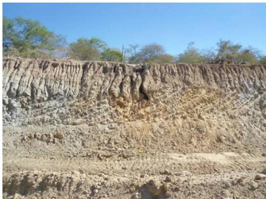
Foto 3-9 Erosão (ravinas) em talude de corte, estaca 239 - Lote 3 (Antes).
