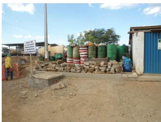
Foto 3-32 Acondicionamento de resíduos contaminados, Canteiro Central em Parnamirim – PE.
