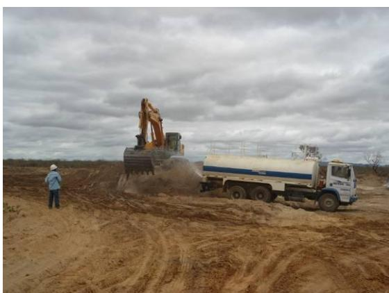
Foto 3-19 Instalação de caixa de empréstimo dentro da faixa de domínio, estaca 1435 LE Lote 2.
