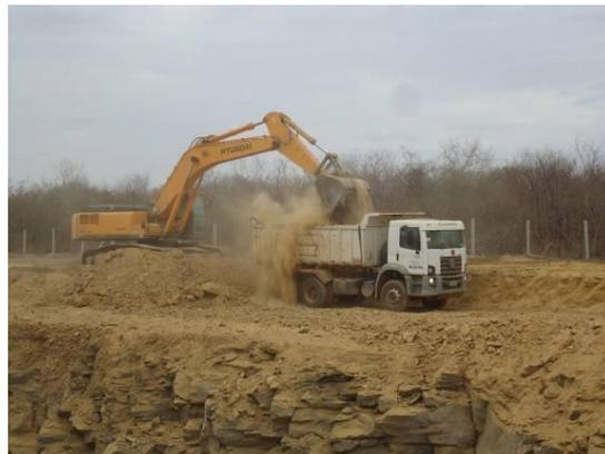
Foto 3-12 Instalação de caixa de empréstimo em local autorizado pela GEMAB, entre as estaca 1044 a 1046 Lote 3.
