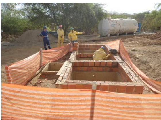
Foto 3-33 Construção do novo Separador de Água e Óleo - SAO, Canteiro Central em Parnamirim – PE.
