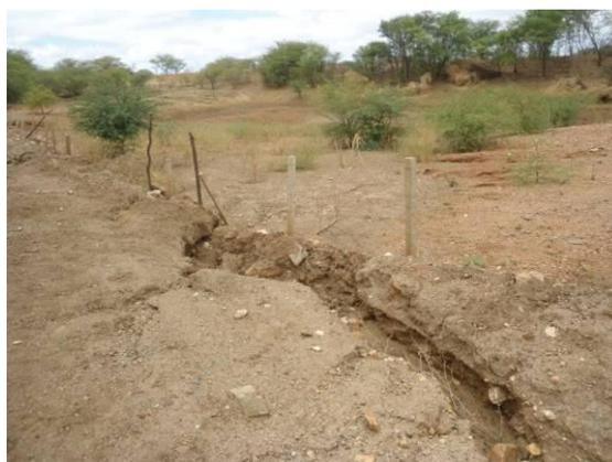
Foto 3-120 Erosão com carreamento de solo para corpo hídrico, estaca 3094 – Lote 2.
