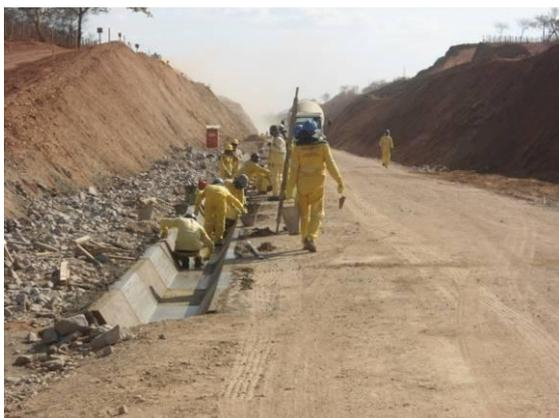
Foto 2-8 Construção de canaletas, estaca 3137 Lote 2.
