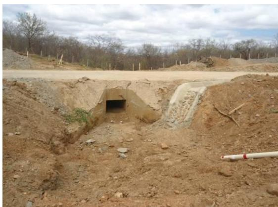
Foto 3-21 Ponto de descarga necessitando de adequação, estaca 2406.
