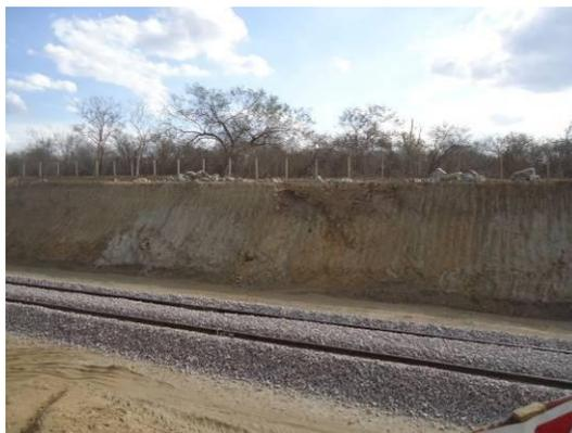
Foto 3-10 Talude de corte reconformado, estaca 239 - Lote 3 (Depois)
