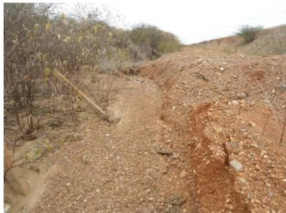
Foto 3-116 Carreamento de solo para corpo hídrico, estaca 92.
