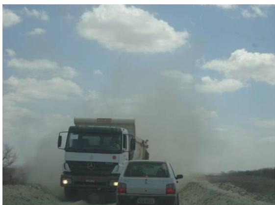
Foto 3-65 Emissão de partículas em suspensão por falta de umectação, estaca 2480.
