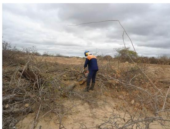
Foto 3-107 Corte de vegetação com DAP de 15 cm acima com motosserra, estaca 1453 – Lote 2.
