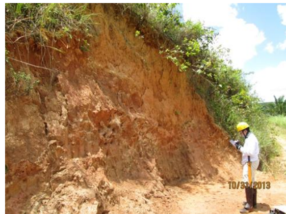
Foto 7.1-121 - Perfil de solo em acesso, sem afloramento rochoso.
