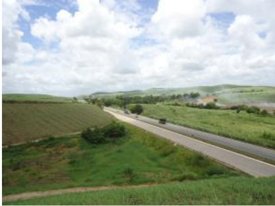
Foto 7.1-170 - Vista para colinas médias que denotam baixa fragilidade aos processos do meio físico, às margens da Rodovia BR-101. Área de cultivo de cana-de-açúcar (Ponto 93).
