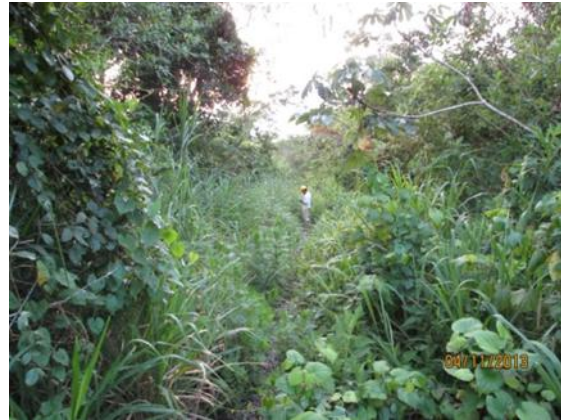
Foto 7.1-159 - Ponto em linha férrea abandonada.
