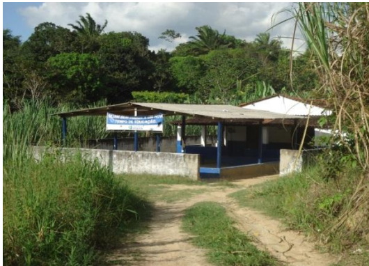
Foto 7.3-13 - Equipamento público no Assentamento Fortaleza.
