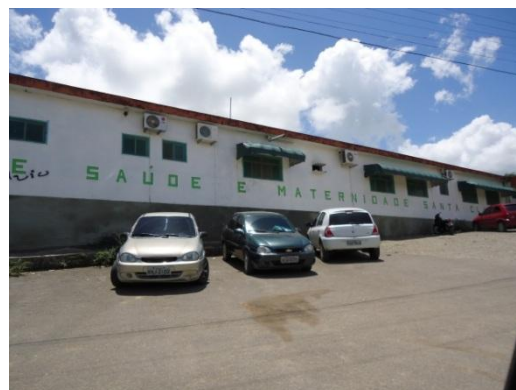
Foto 7.3-20 - Casa de Saúde e Maternidade Santa Clara, município de Escada.
