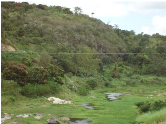
Foto 7.1-162 - Vista para vertente com declividade superior a 30%, no município de Belém de Maria (Ponto 27).
