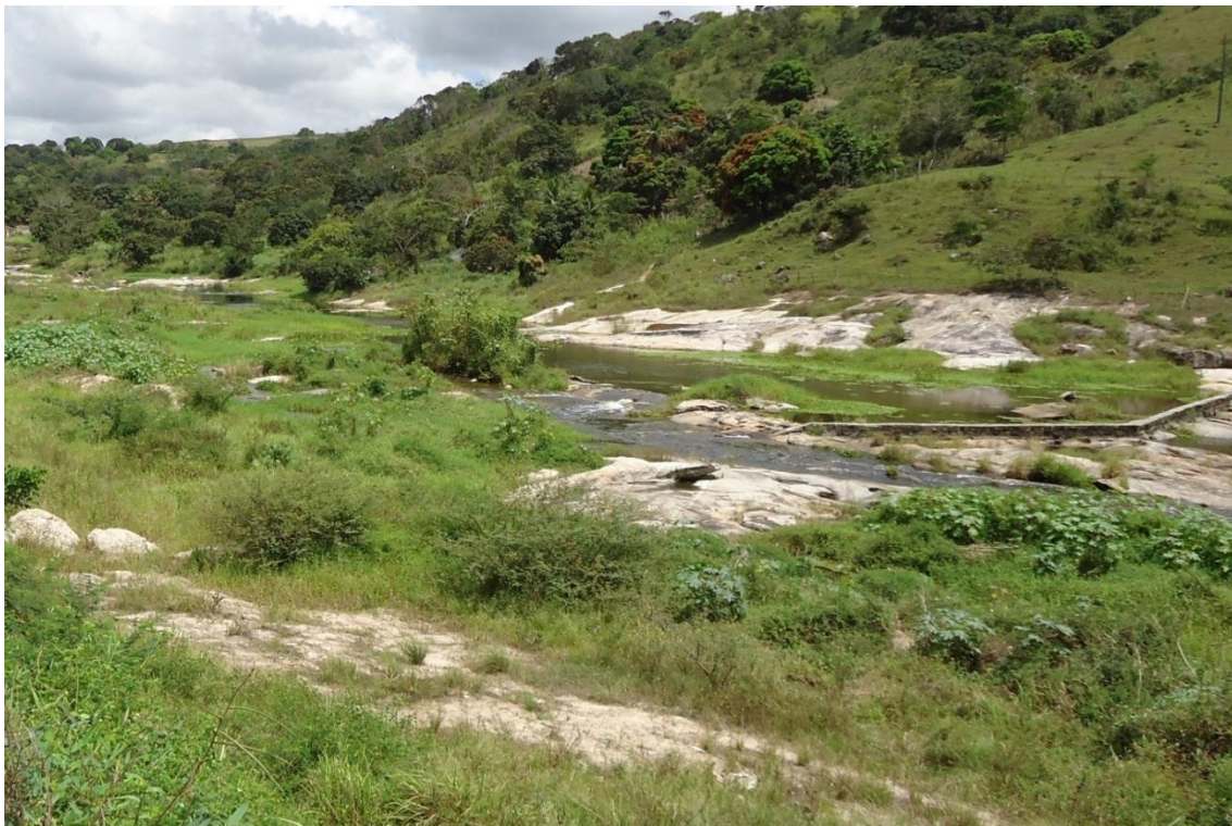
Foto 7.1-1 - Barramento observado no rio Una, em novembro de 2013.
