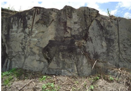
Foto 7.1-49 - Anfibólio do Complexo Belém do São Francisco em talude de corte na BR - 101. Município de Escada.
