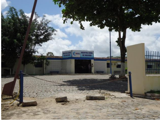
Foto 7.3-21 - Hospital Geral de Ribeirão, município de Ribeirão.
