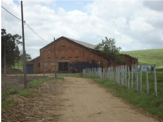
Foto 7.1-183 - Usina abandonada próxima a curso hídrico.
