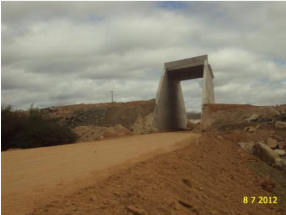
Foto 2-69 Viaduto rodoviário da rodovia PE-340 concluído.
