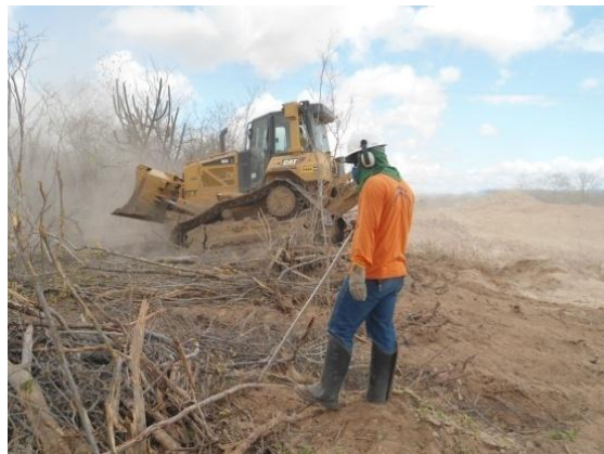
Foto 3-100 Técnico de afugentamento acompanhando a supressão com trator de esteira – Lote 3.
