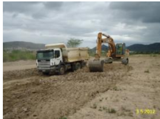
Foto 2-99 Escavação de material (escavação de 1ª e 2ª categoria).
