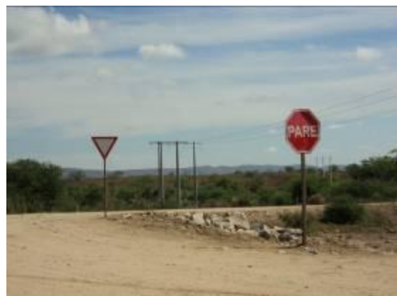
Foto 3-18 Via de acesso do Pátio de Pré-moldados a Rodovia Federal BR-232.
