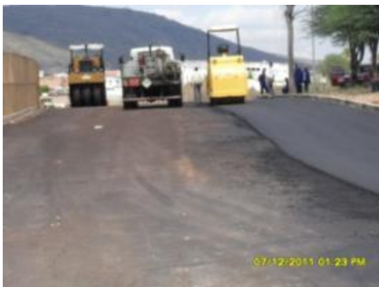
Foto 2-104 Construção do desvio da rodovia PE-232.
