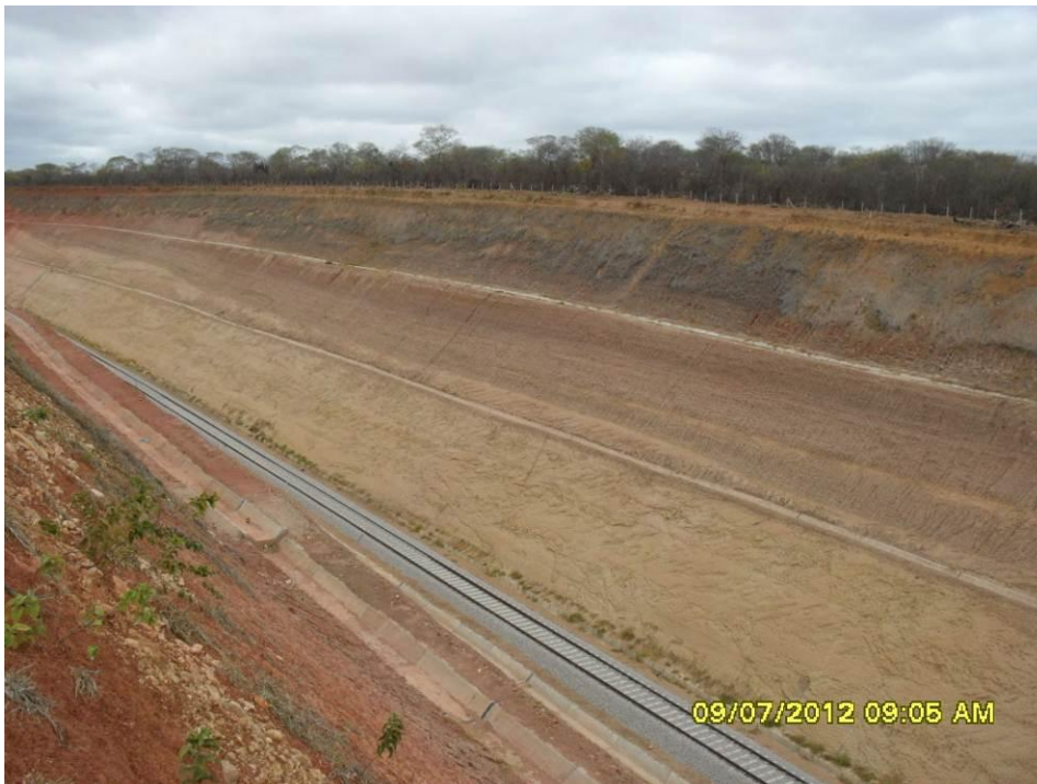
Foto 2-22 Talude do corte C-40, estaca 11518.
