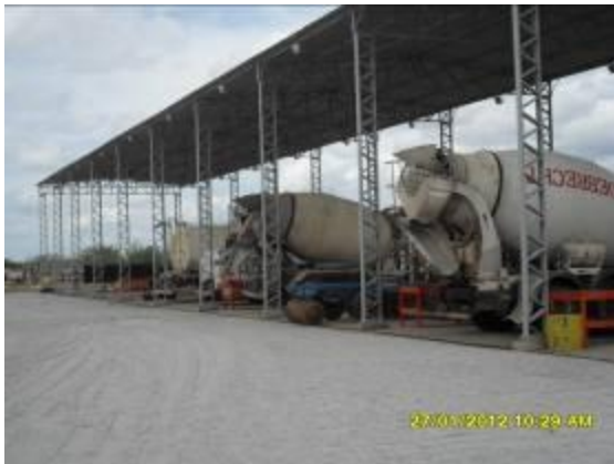
Foto 3-35 Oficina mecânica com piso impermeável na fábrica de pré-moldados – Lote 5.
