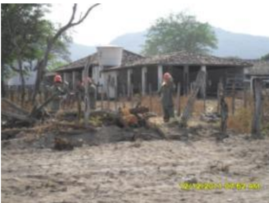
Foto 2-98 Instalação de cerca.
