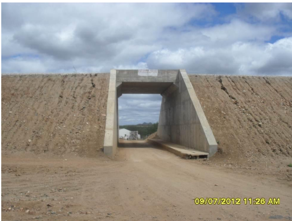
Foto 2-34 Passagem de nível inferior na estaca 20137.
