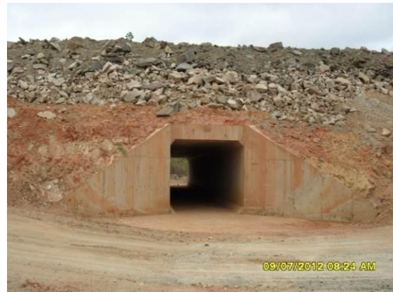
Foto 2-4 Bueiro Simples Celular de Concreto (BSCC) 3,00x3,00m - estaca 10997.
