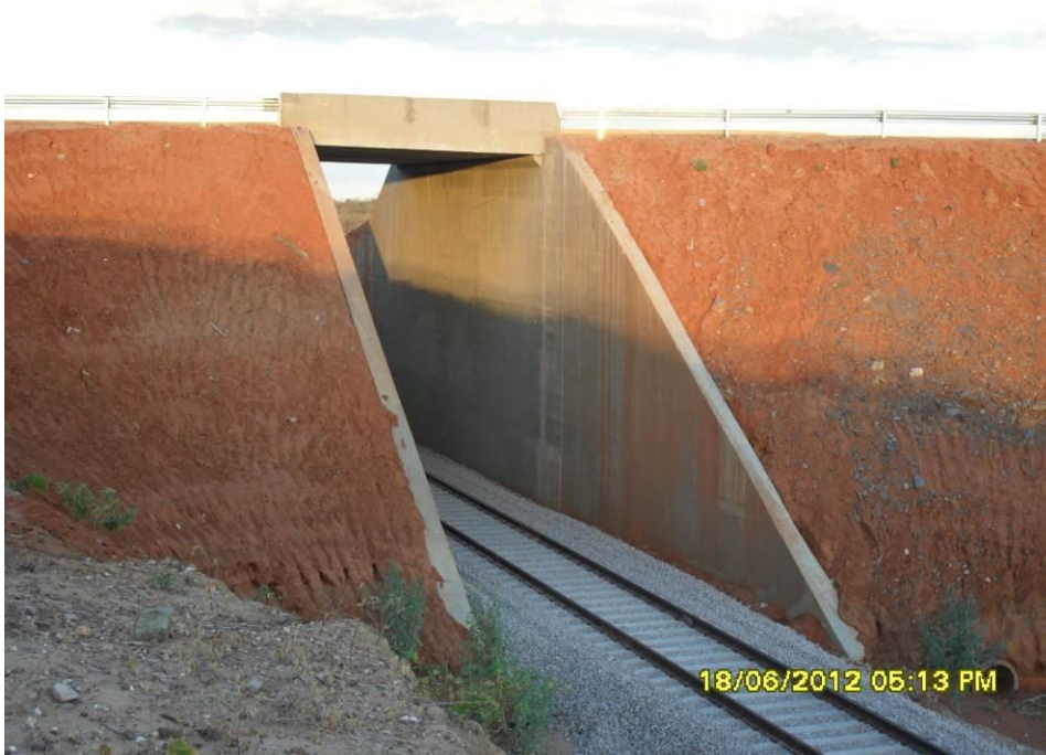
Foto 2-12 Viaduto sob a Rodovia Estadual PE-450, Verdejante.
