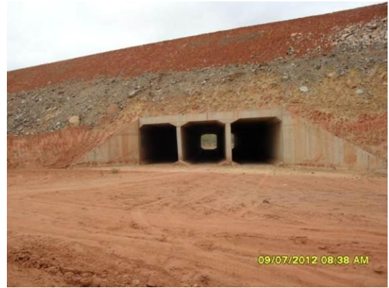
Foto 2-6 Bueiro Triplo Celular de Concreto (BTCC) 3,00x3,00m - estaca 11253.
