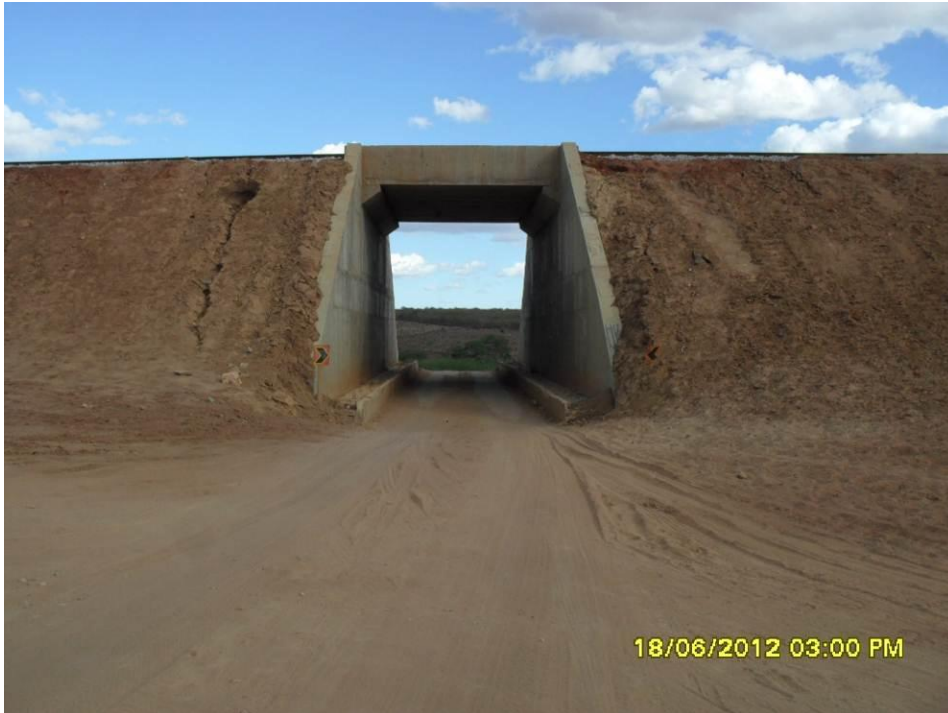
Foto 2-16 Passagem de nível inferior Sítio Barreiros, estaca 12220.
