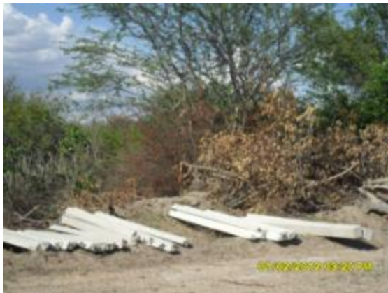
Foto 2-43 Instalação de cerca.
