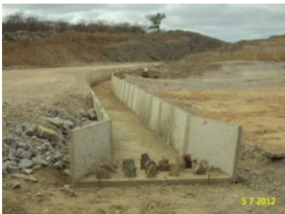
Foto 2-51 Decida d'água da valeta do leito estradal com dissipador de energia.
