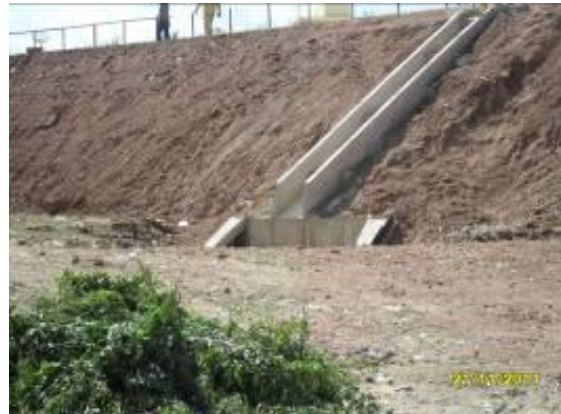
Foto 3-22 Drenagem finalizada no desvio da BR 23 – Lote 5.
