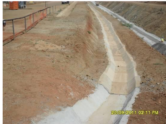
Foto 3-28 Construção das canaletas de drenagem na berma da ferrovia – Lote 2.
