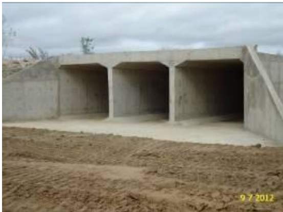
Foto 2-81 Bueiro triplo celular de concreto (BTCC).
