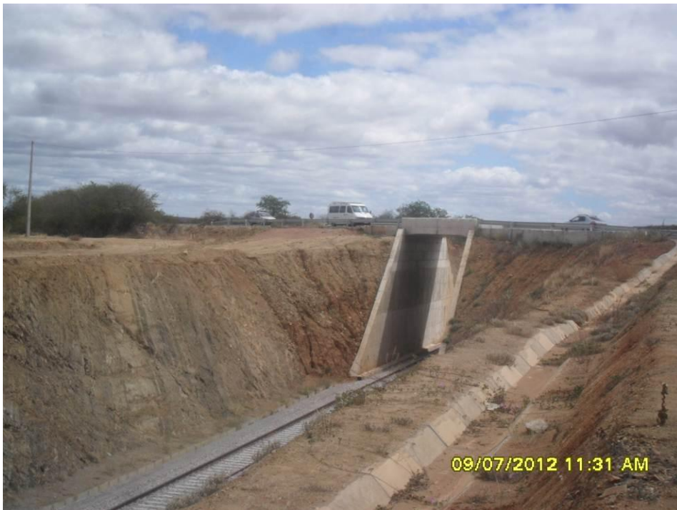
Foto 2-30 Viaduto sob a rodovia federal BR 232.
