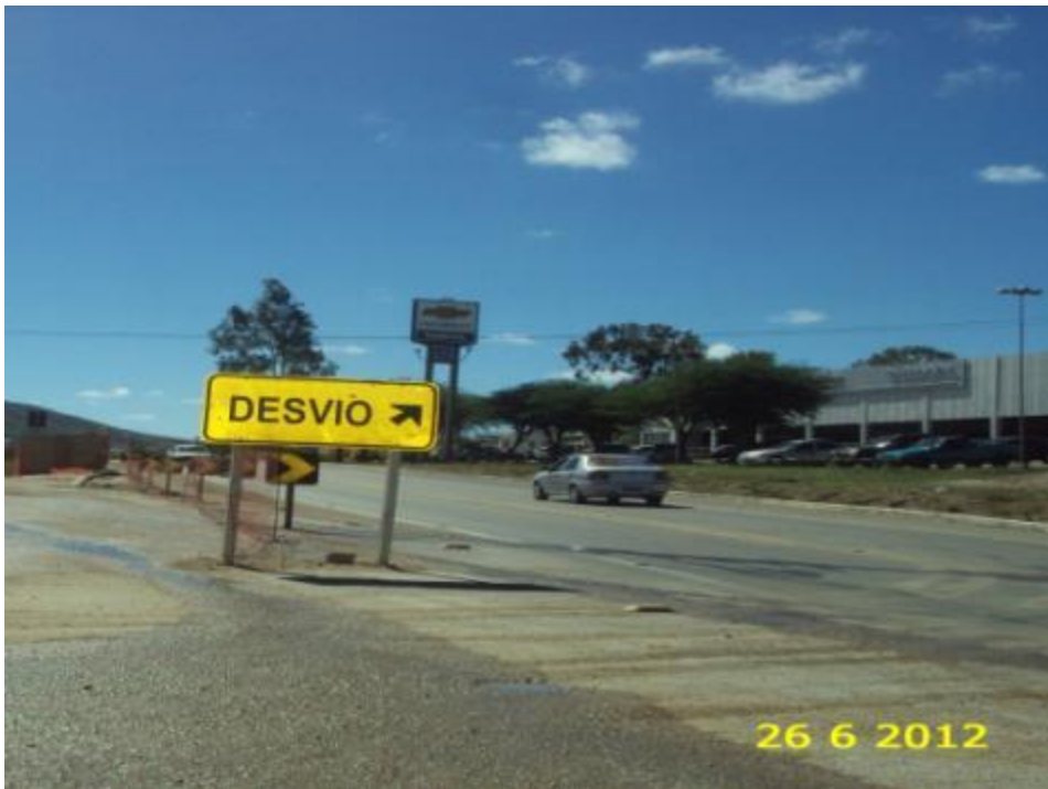
Foto 2-117 Desvio da rodovia BR-232 para a construção do túnel.
