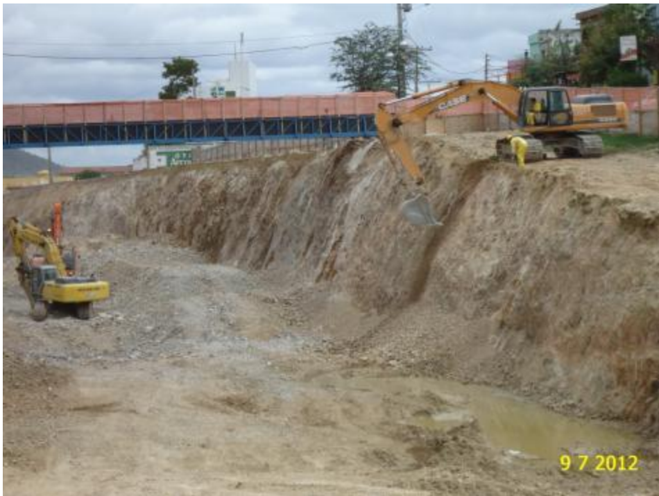
Foto 2-115 reconformação das bermas.
