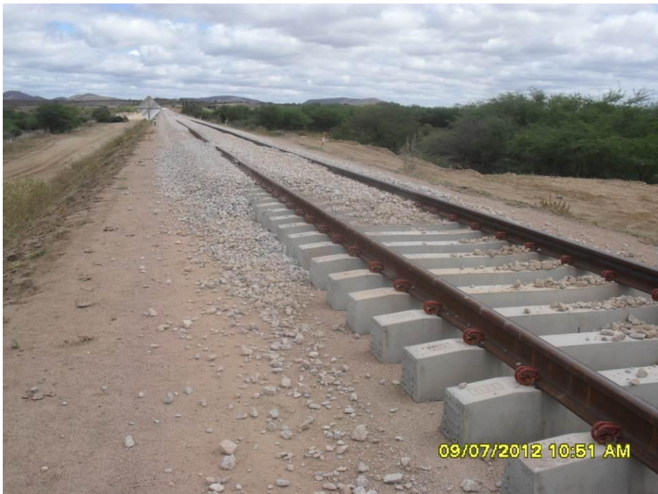
Foto 2-40 Superestrutura com e sem brita na estaca 21040.
