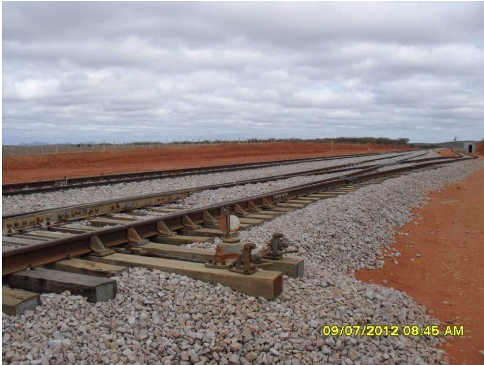
Foto 2-18 Aparelho de Mudança de Via (AMV), estaca 11349.
