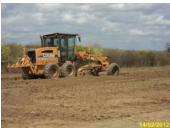
Foto 2-77 Terraplanagem, aterro.
