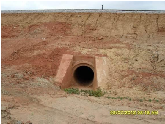
Foto 2-1 Bueiro Simples Tubular de Concreto (BSTC) 1,00m de diâmetro, estaca 10946.
