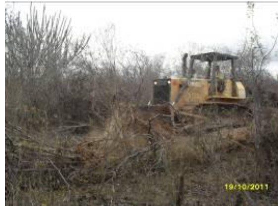
Foto 3-90 Trator de esteira iniciando supressão vegetal do material lenhoso menos que 15 cm de diâmetro – Lote 4.
