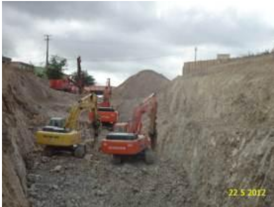
Foto 2-100 Escavação de corte (escavação de 3ª categoria).
