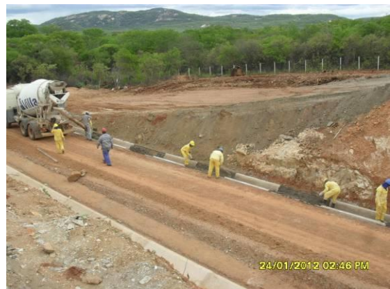
Foto 3-24 - Construção de canaletas – Lote 2.
