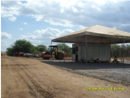
Foto 3-29 Vista geral do ponto de apoio Lote 2 – setembro de 2011.
