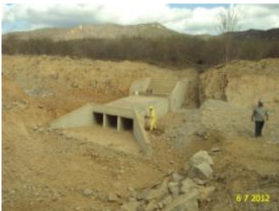
Foto 2-57 Bueiro triplo celular de concreto (BTCC) com caixa colete e degraus.
