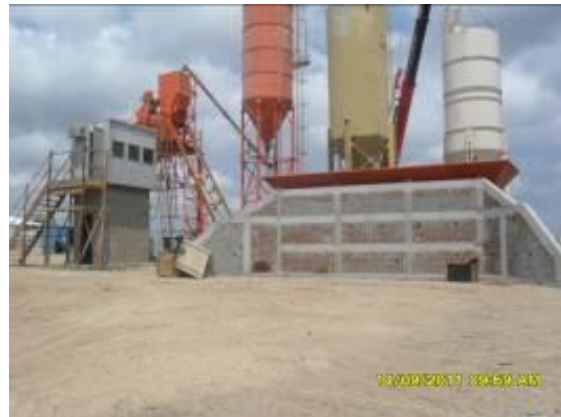
Foto 3-30 Fabrica de pré-moldados para construção do túnel do Lote 5.
