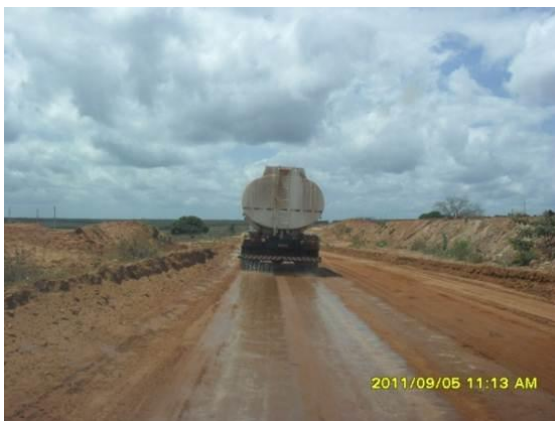
Foto 3-63 Caminhão, em uma das raras vezes, realizando a umectação nas vias de acessos.
