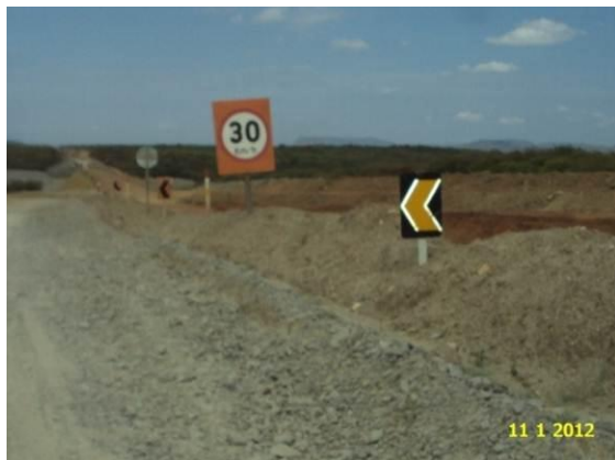
Foto 3-17 Sinalização advertência e de atenção – Lote 3.
