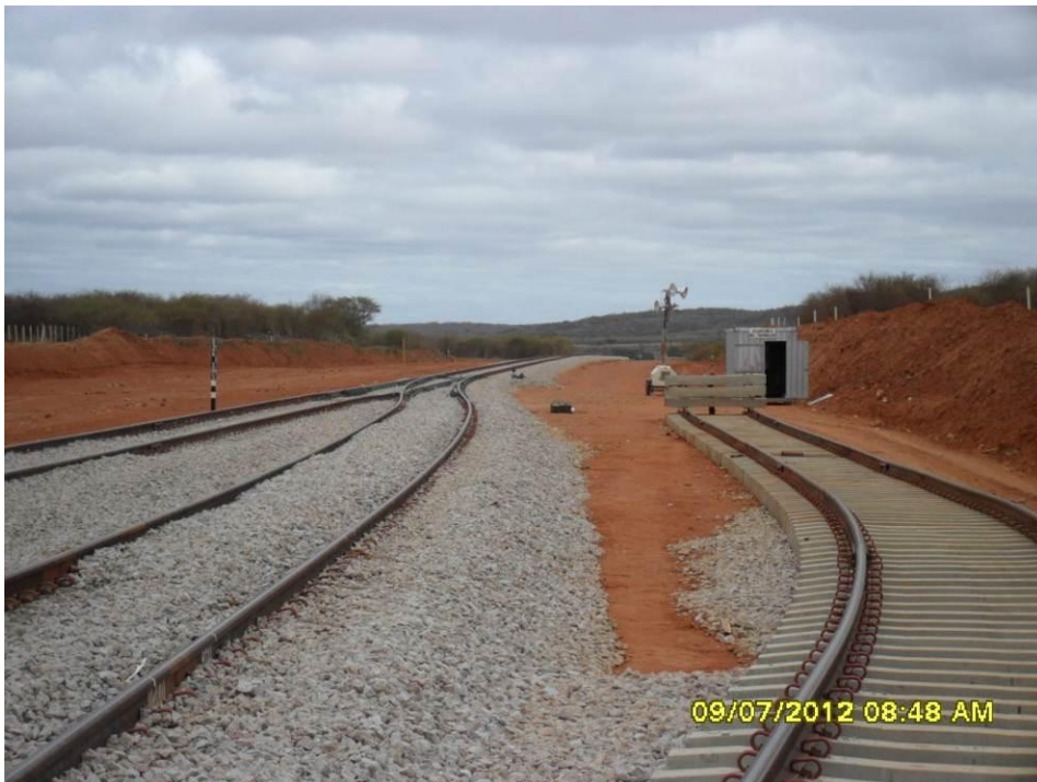
Foto 2-19 Pátio de manobras localizado na estaca 11347.
