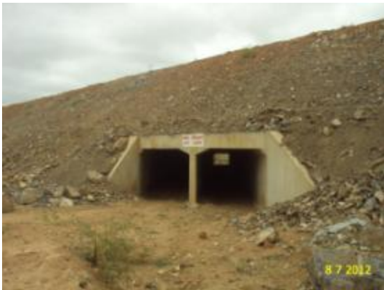
Foto 2-55 Bueiro duplo celular de concreto (BDCC).
