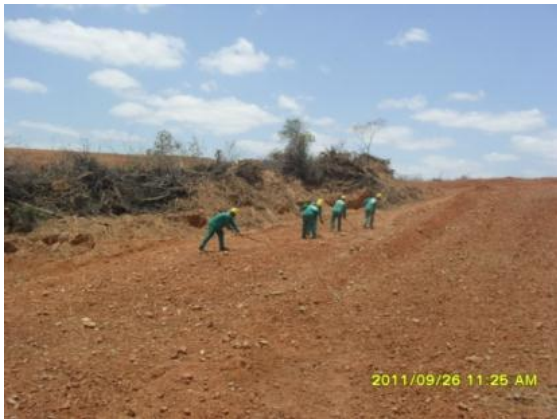
Foto 3-81 Colaboradores no processo de revegetação da jazida de empréstimo – Lote 1.
