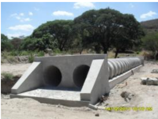
Foto 2-110 Bueiro duplo tubular de concreto (BDTC).
