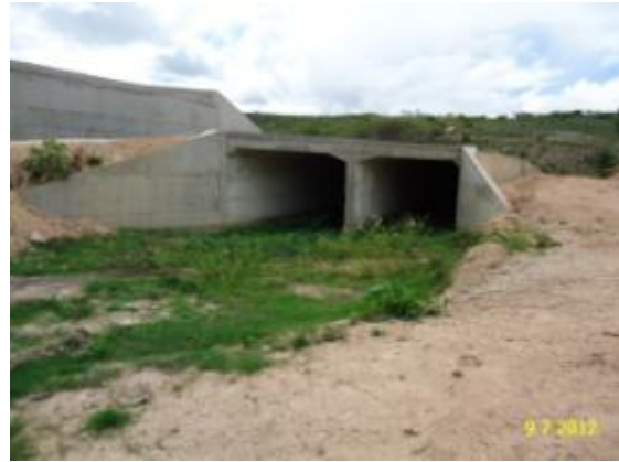
Foto 2-107 Bueiro duplo celular de concreto (BDCC).
