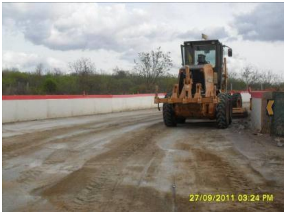
Foto 3-15 Recuperação do desvio do viaduto da Caxixola – Lote 2.
