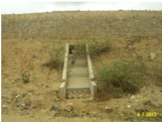
Foto 2-49 Valeta de proteção de aterro (VPA) com dissipador de energia.
