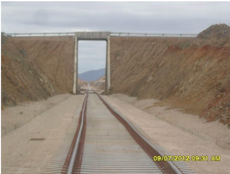
Foto 2-32 Viaduto sob a rodovia estadual PE-390.
