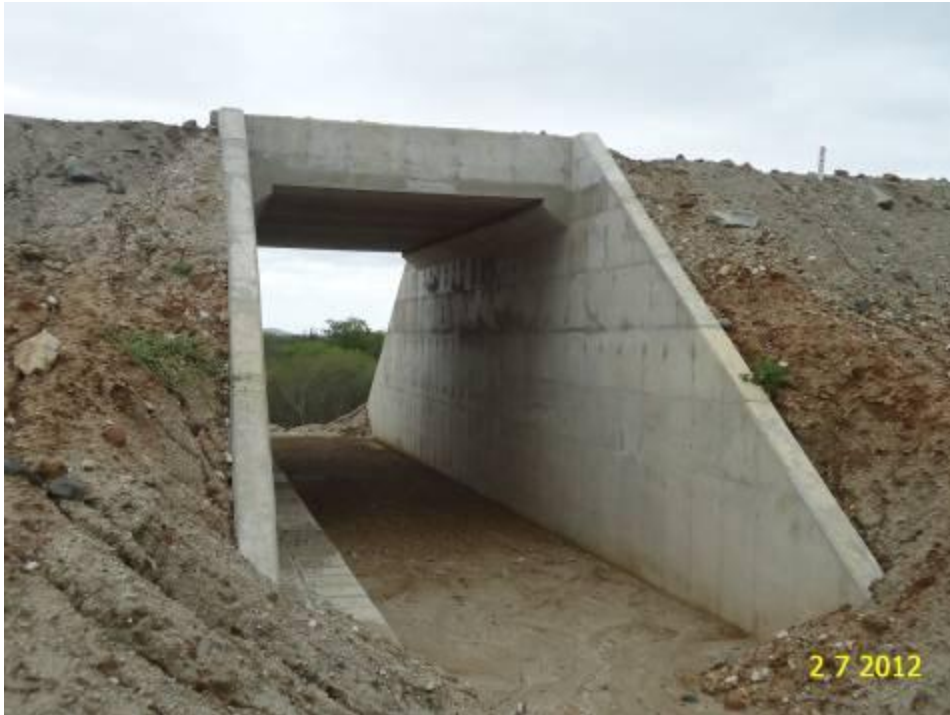
Foto 2-87 Passagem inferior restrita na estaca 40322 concluída.
