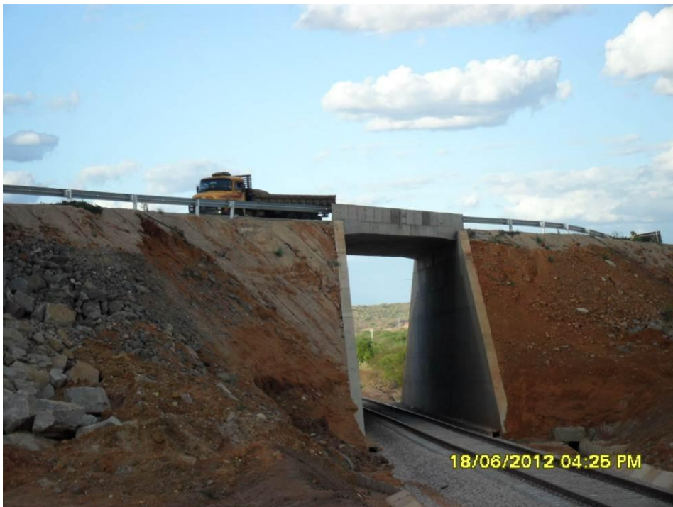
Foto 2-13 Viaduto sob a Rodovia Estadual PE-430, São José do Belmonte.
