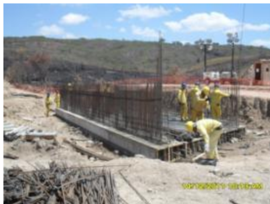
Foto 2-105 Construção de obra de arte corrente.
