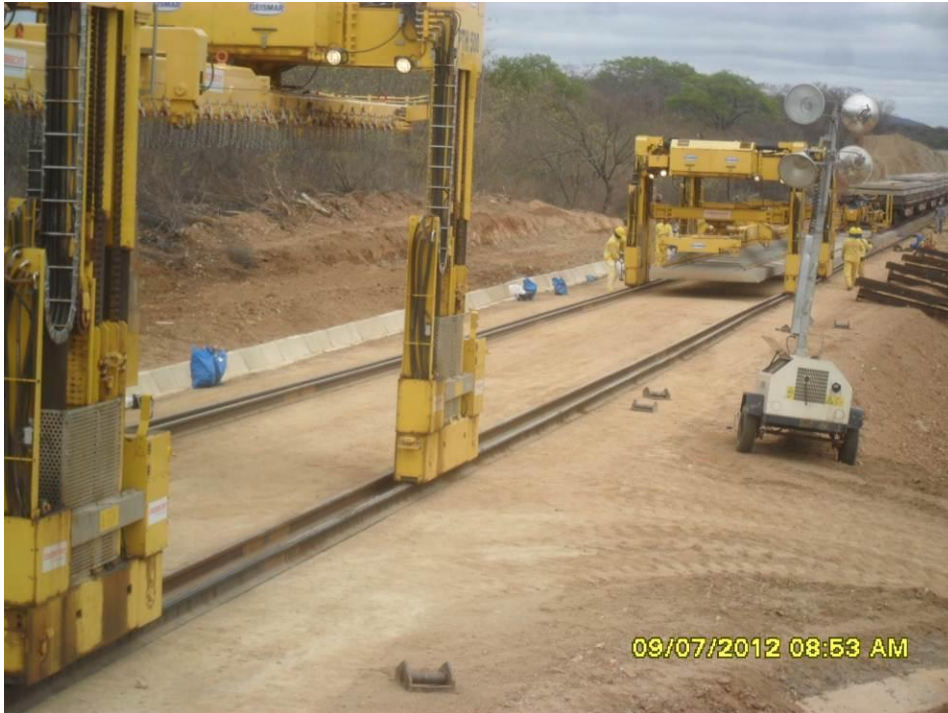
Foto 2-35 Implantação de dormentes na estaca 22670.
