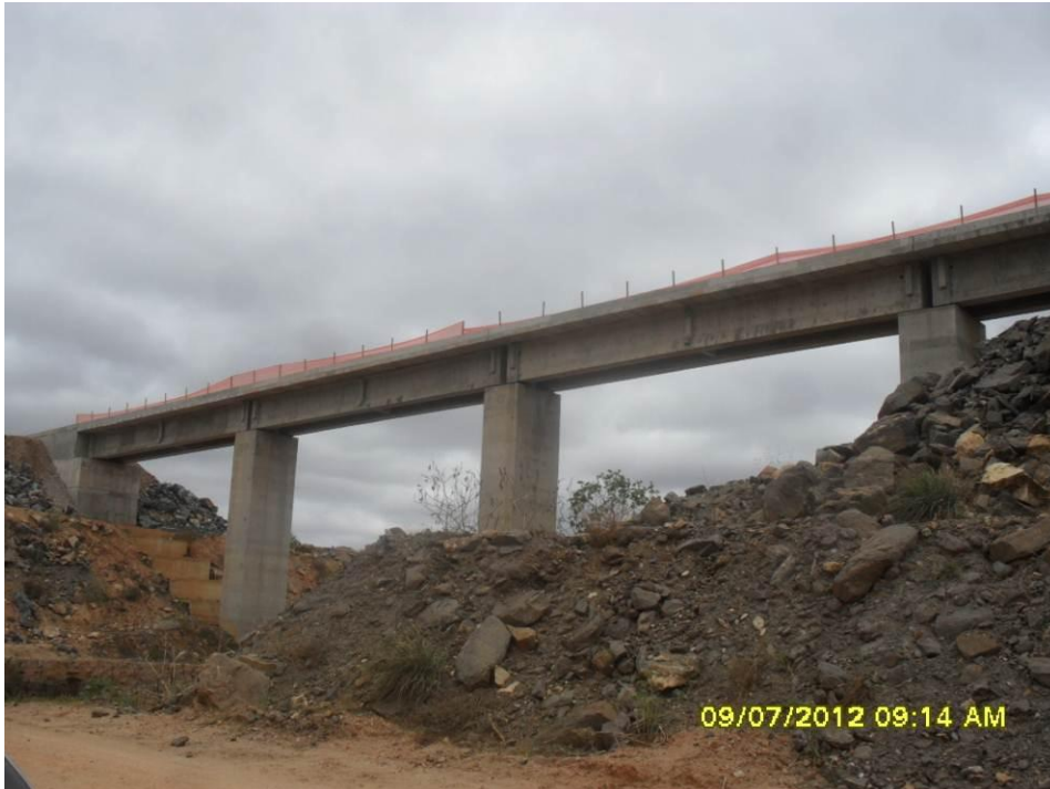
Foto 2-29 Ponte sobre o rio Saco da Roça.
