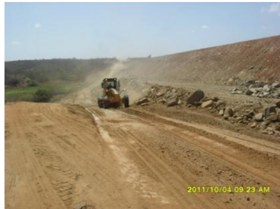
Foto 3-16 Terraplanagem no caminho de serviço próximo à estaca 10.835 – Lote 1.
