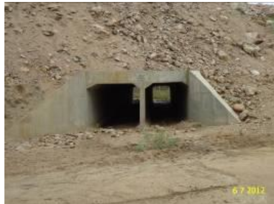
Foto 2-82 Bueiro duplo celular de concreto (BDCC).
