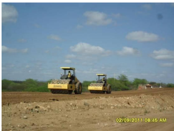
Foto 3-11 Terraplanagem na área do traçado da ferrovia, Lote 2 – setembro 2011.
