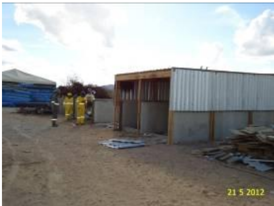
Foto 3-37 Manutenção na baia de recebimento dos resíduos – Lote 4.
