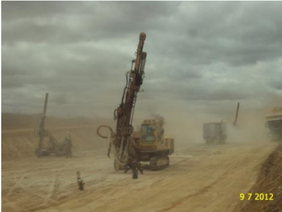
Foto 2-61 Perfuração para desmonte de rocha.
