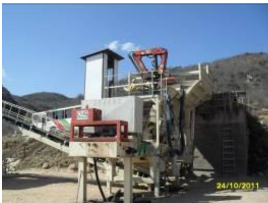
Foto 3-33 Britador mobilizado – Lote 5.
