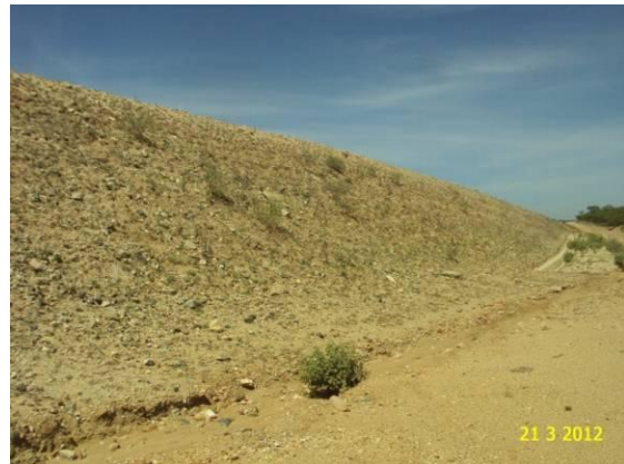
Foto 3-86 Talude de aterro com cobertura vegetal por hidrossemeadura – Lote 3.
