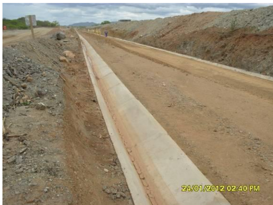
Foto 3-23 Canaletas construídas no leito estradal.
