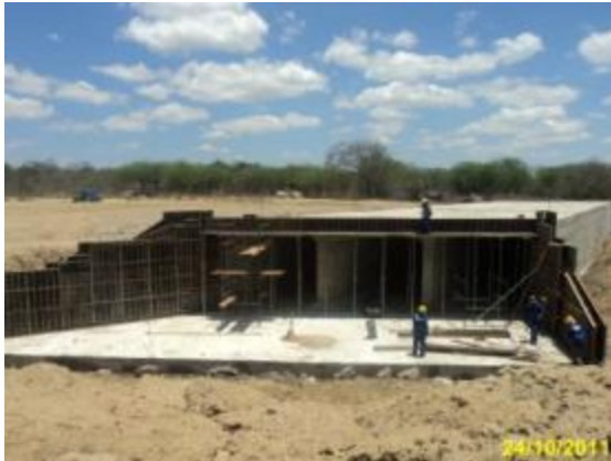
Foto 2-79 Construção de obra de arte corrente.
