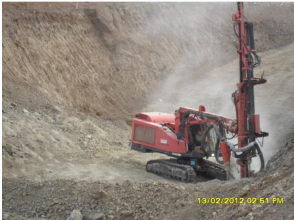
Foto 2-113 Perfuração para desmonte de rocha.
