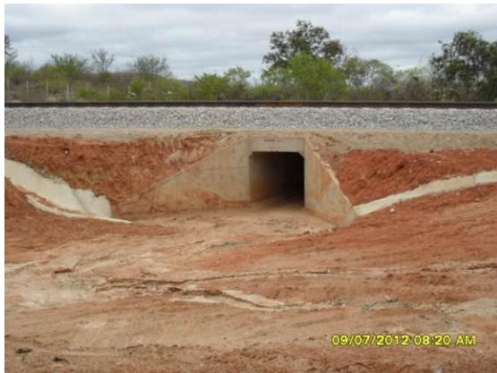
Foto 2-3 Bueiro Simples Celular de Concreto (BSCC) 1,50x1,50m - estaca 10968.
