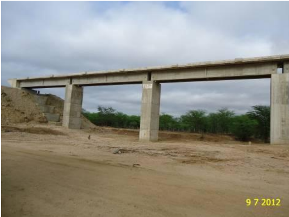
Foto 2-91 Ponte concluída sobre o riacho Feliciano.
