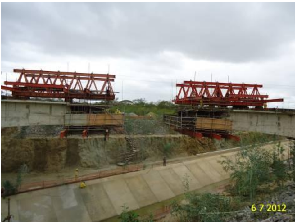
Foto 2-88 Ponte em construção sobre a transposição do rio São Francisco.
