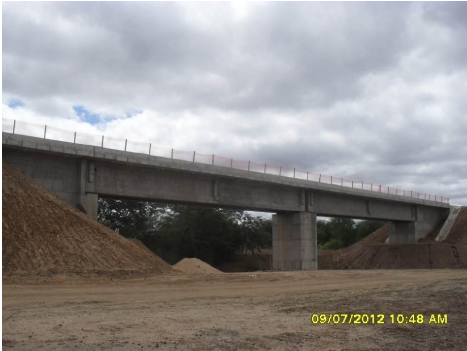
Foto 2-27 Ponte sobre o rio Exú Velho.
