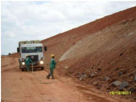
Foto 3-85 Naqueles taludes já preparados para receber os procedimentos de revegetação, a hidrossemeadura é o método utilizado.
