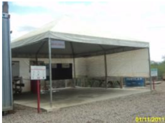
Foto 3-34 Área de vivência ponto de apoio operacional – Lote 4.
