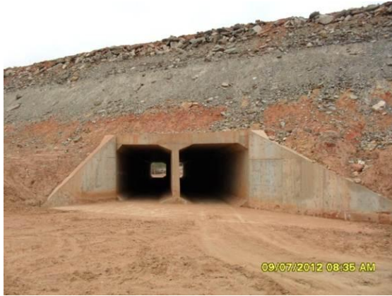
Foto 2-5 Bueiro Duplo Celular de Concreto (BDCC) 3,00x3,00m - estaca 11174.
