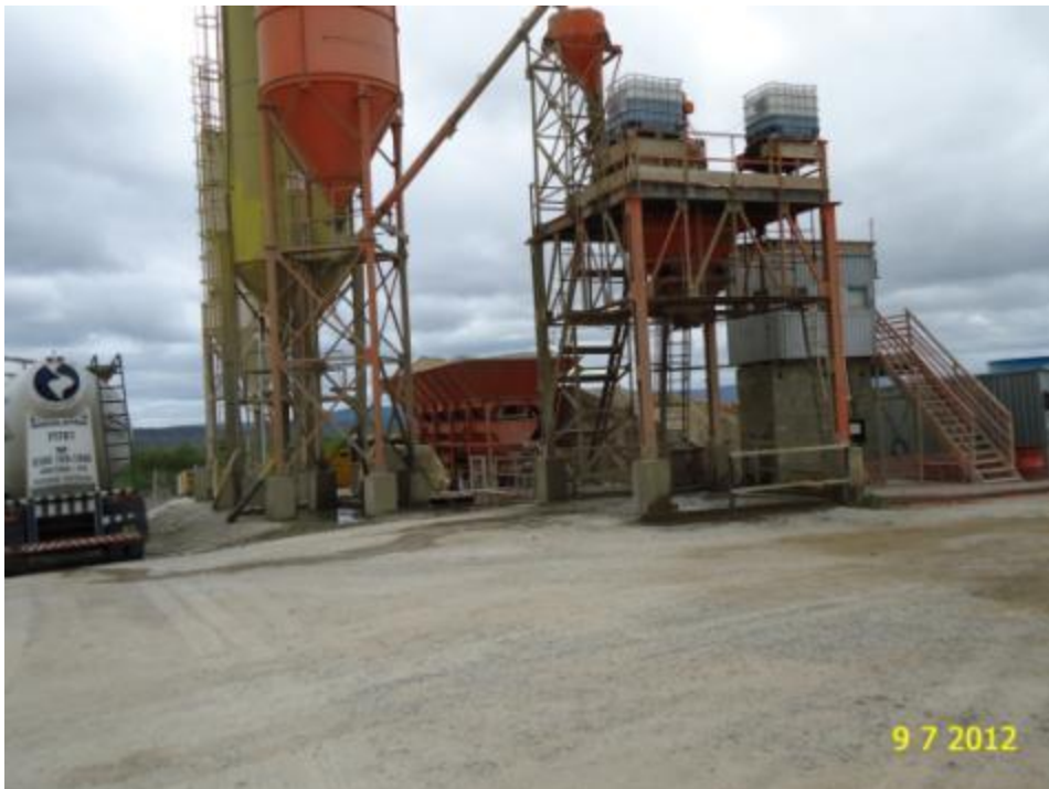
Foto 2-94 Úsina de concreto no pátio de pré-moldados.
