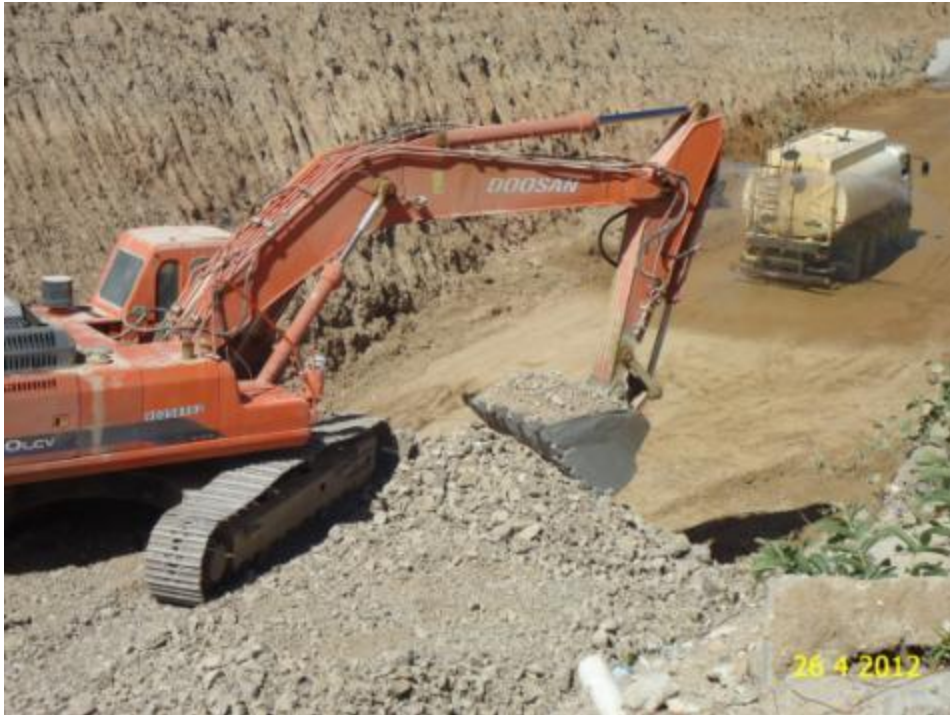
Foto 2-114 Escavação para construção do túnel.
