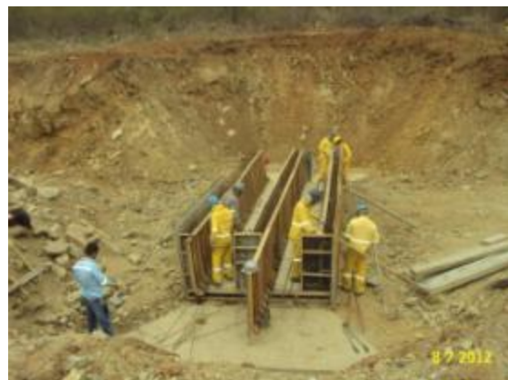
Foto 2-52 Construção de obra de arte corrente.
