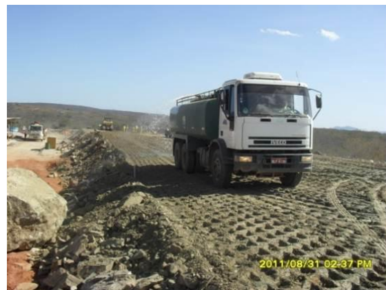
Foto 3-64 Umectação para a realização da terraplanagem.
