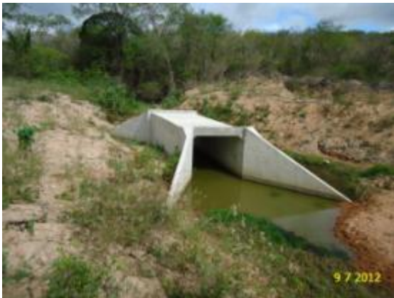
Foto 2-108 Bueiro simples celular de concreto (BSCC).
