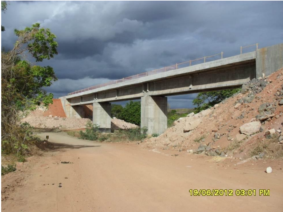
Foto 2-10 Ponte sobre o riacho São Cristóvão.
