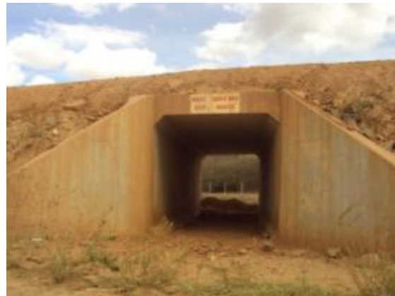
Foto 2-56 Bueiro simples celular de concreto (BSCC).
