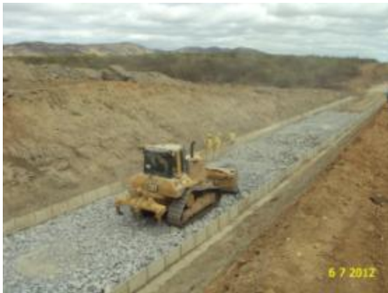
Foto 2-47 Terraplanagem, sublastro.
