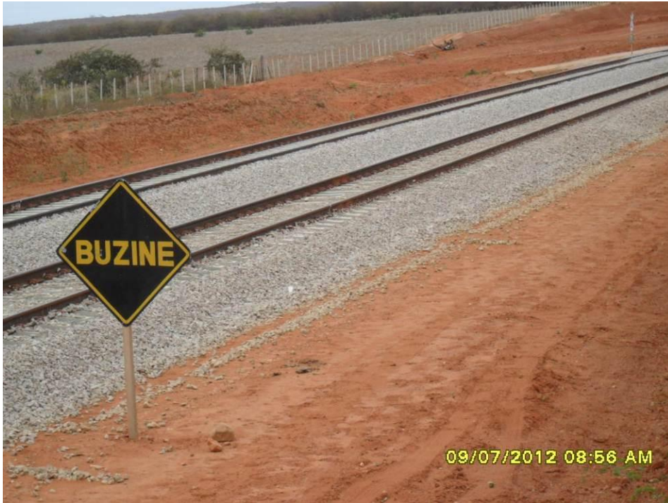
Foto 2-20 Placa indicativa para acionamento de sinal sonoro antes de uma passagem de nível, estaca 11363.
