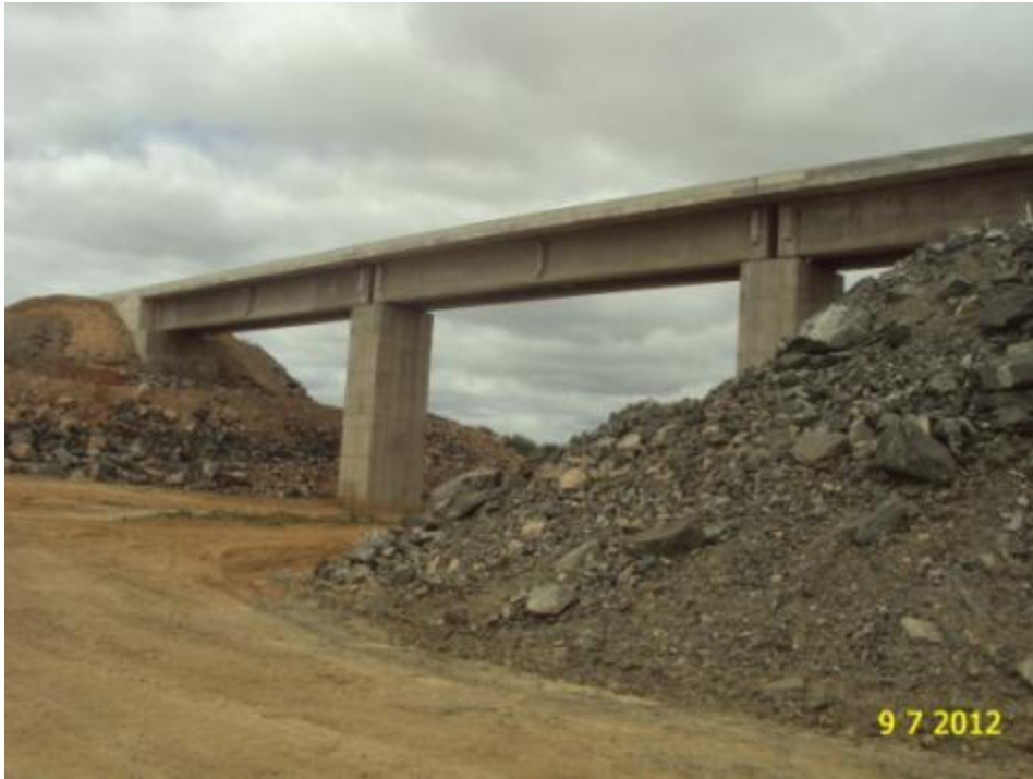
Foto 2-65 Ponte concluída sobre o riacho Lagamar.
