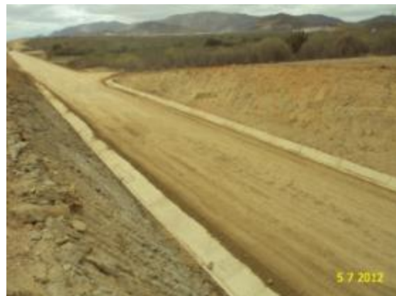
Foto 2-50 Valeta de proteção do leito estradal.
