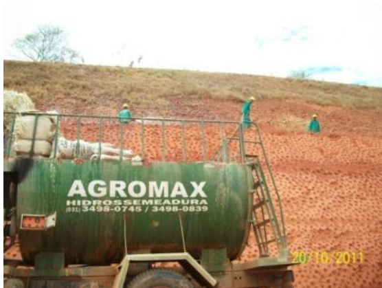
Foto 3-83 Empresa responsável pelo processo de hidrossemeadura nos talude.
