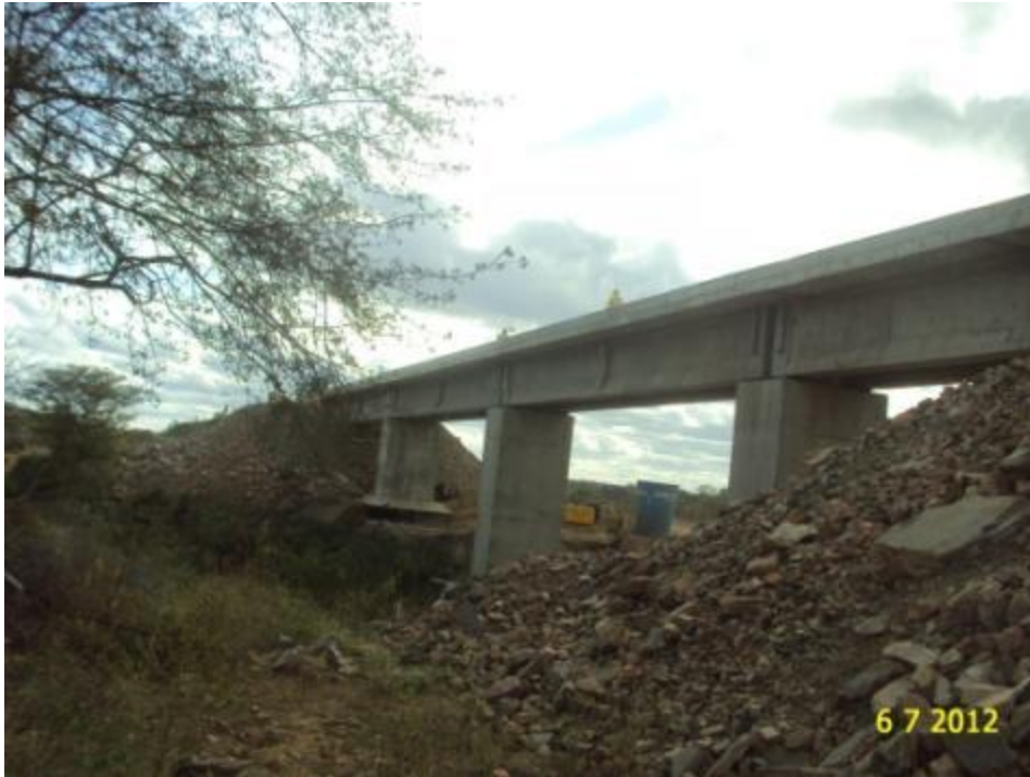
Foto 2-67 Ponte concluída sobre o rio Bom Jesus.
