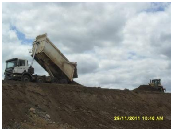
Foto 3-12 Implantação do aterro, Lote 1 – novembro de 2011.
