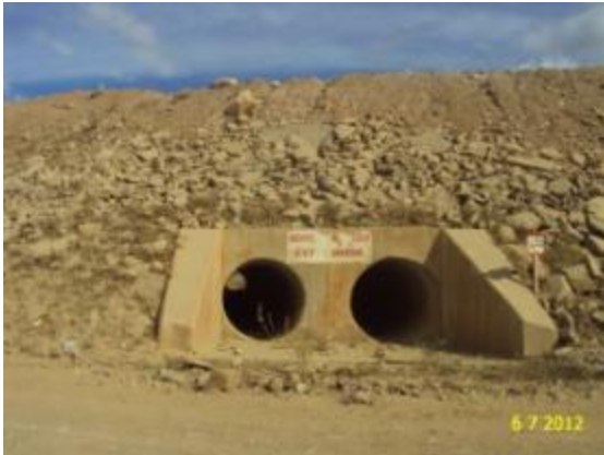
Foto 2-59 Bueiro duplo tubular de concreto (BDTC).
