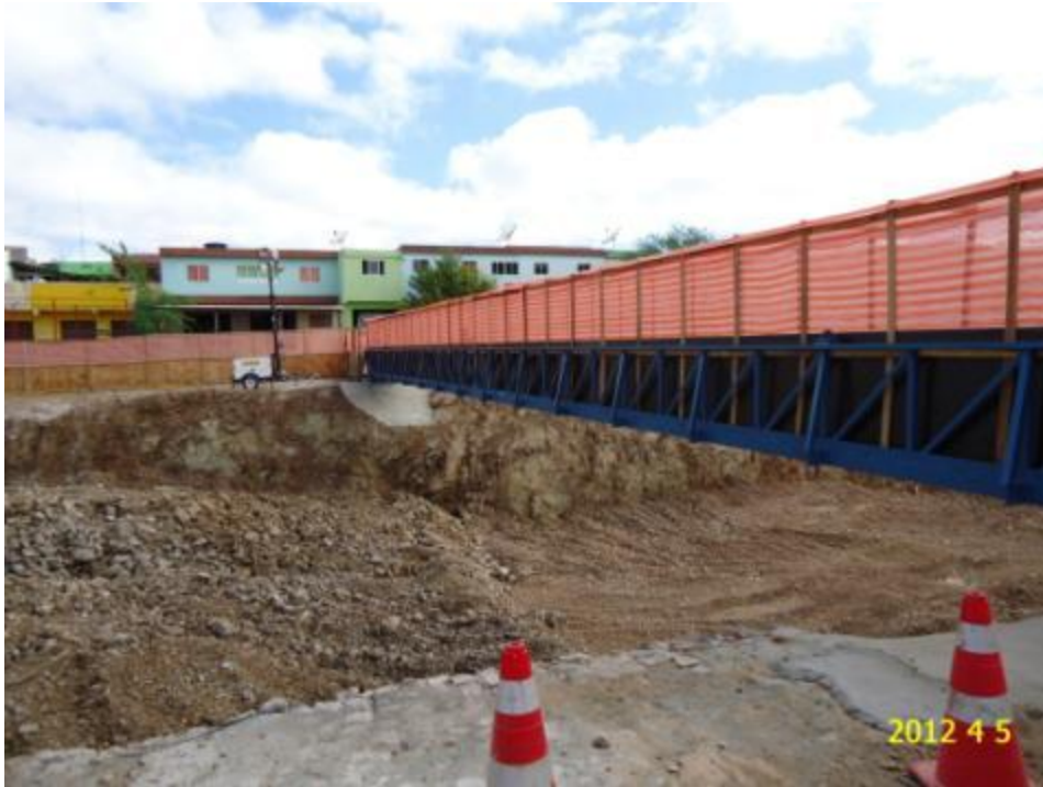
Foto 2-116 Passarela para transposição de pedestres sobre a construção do túnel.
