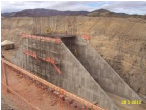
Foto 2-53 Construção de obra de arte especial.
