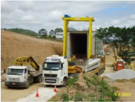
Foto 2-106 Construção de obra de arte especial.
