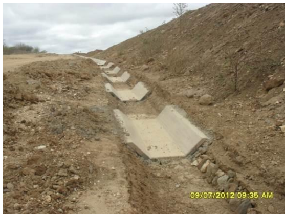
Foto 2-25 Drenagem superficial, Canaletas em construção na estaca 21858.
