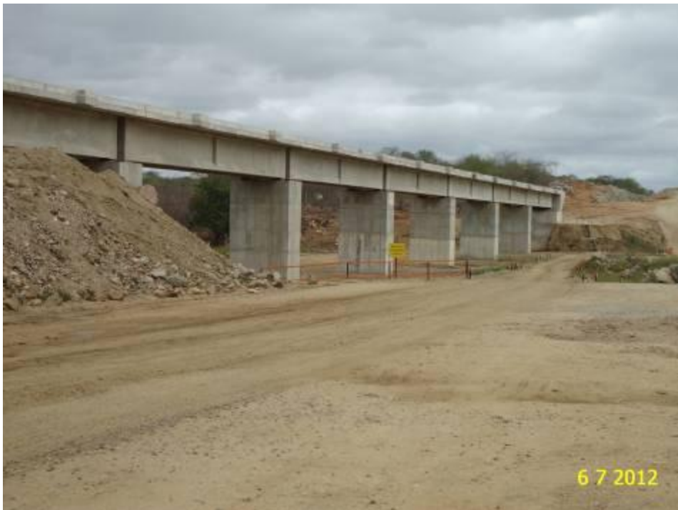
Foto 2-90 Ponte concluída sobre o rio Moxotó.
