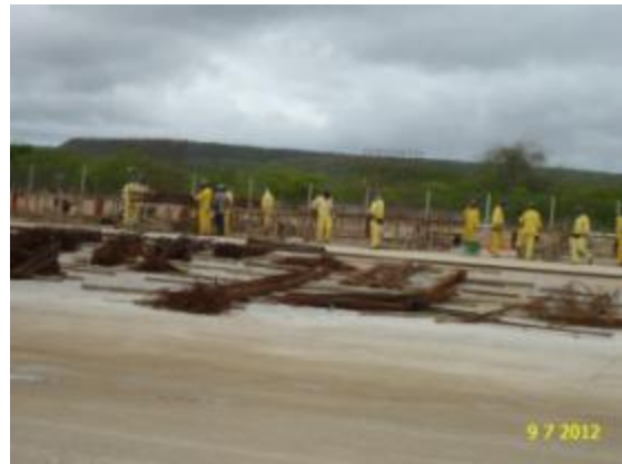
Foto 2-80 Construção de placas de pré-moldado para túnel do Lote 5.
