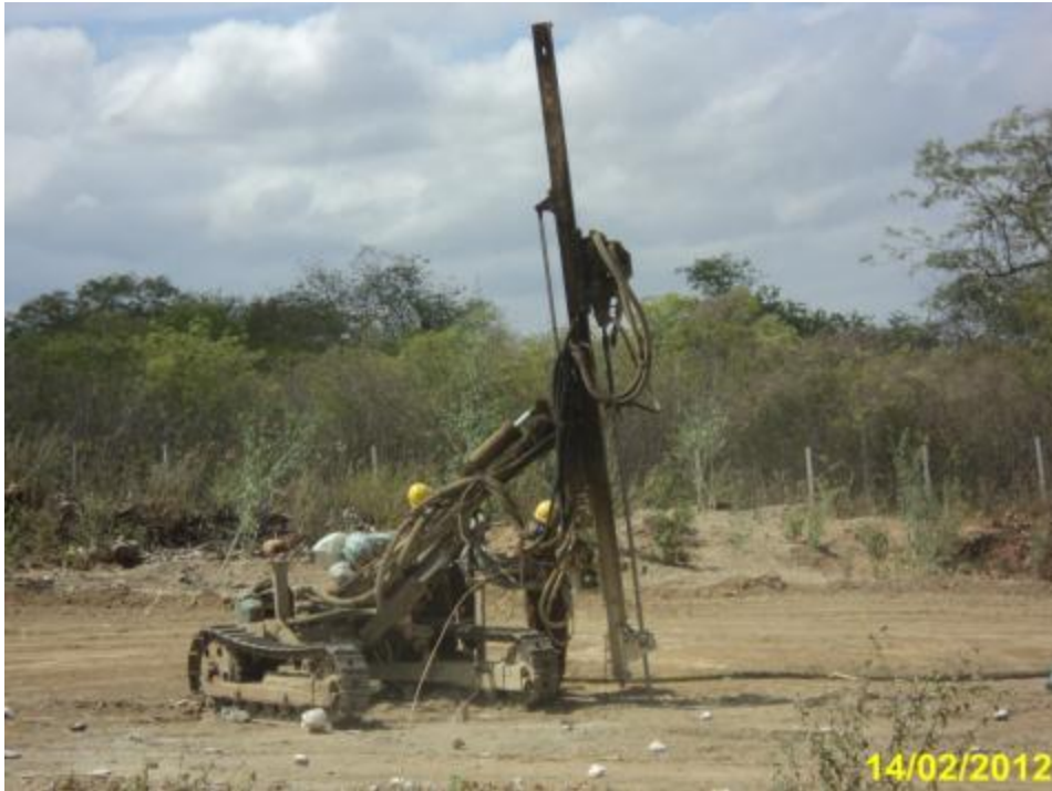
Foto 2-85 Perfuração para desmonte de rocha.
