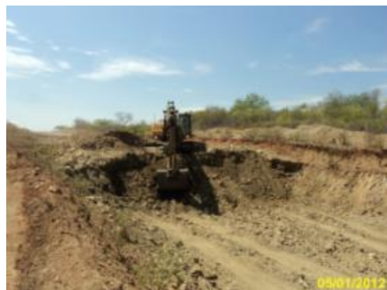
Foto 2-76 Escavação de material (escavação de 1ª e 2ª categoria).
