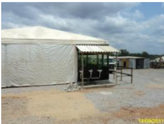
Foto 3-47 Refeitórios foram distribuídos de maneira a atender todas as frentes de serviços.
