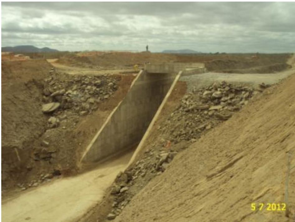
Foto 2-66 Viaduto rodoviário de Varzinha concluído.
