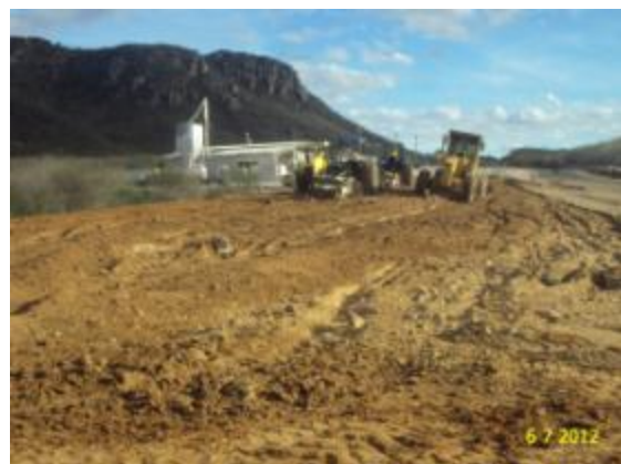
Foto 2-46 Terraplanagem, aterro.
