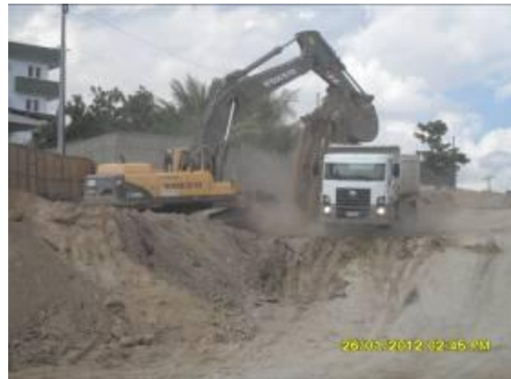
Foto 3-14 Corte e retirada de material para construção do túnel, Lote 5 – janeiro 2012.
