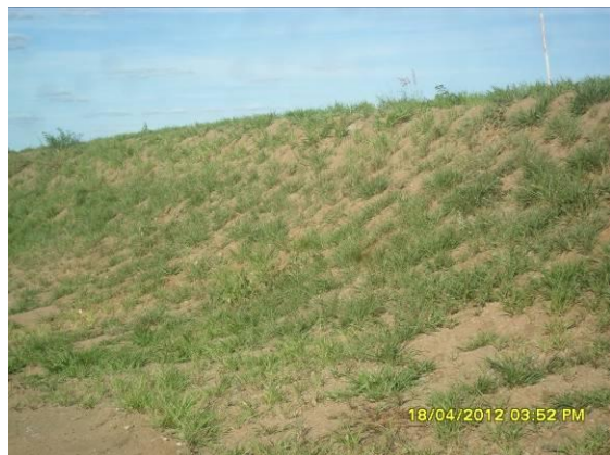
Foto 3-88 Vegetação germinada em talude de aterro.
