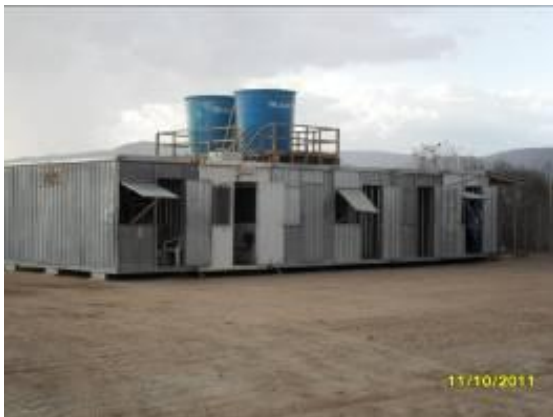
Foto 3-31 Instalação de contêineres na fabrica de pré-moldados.
