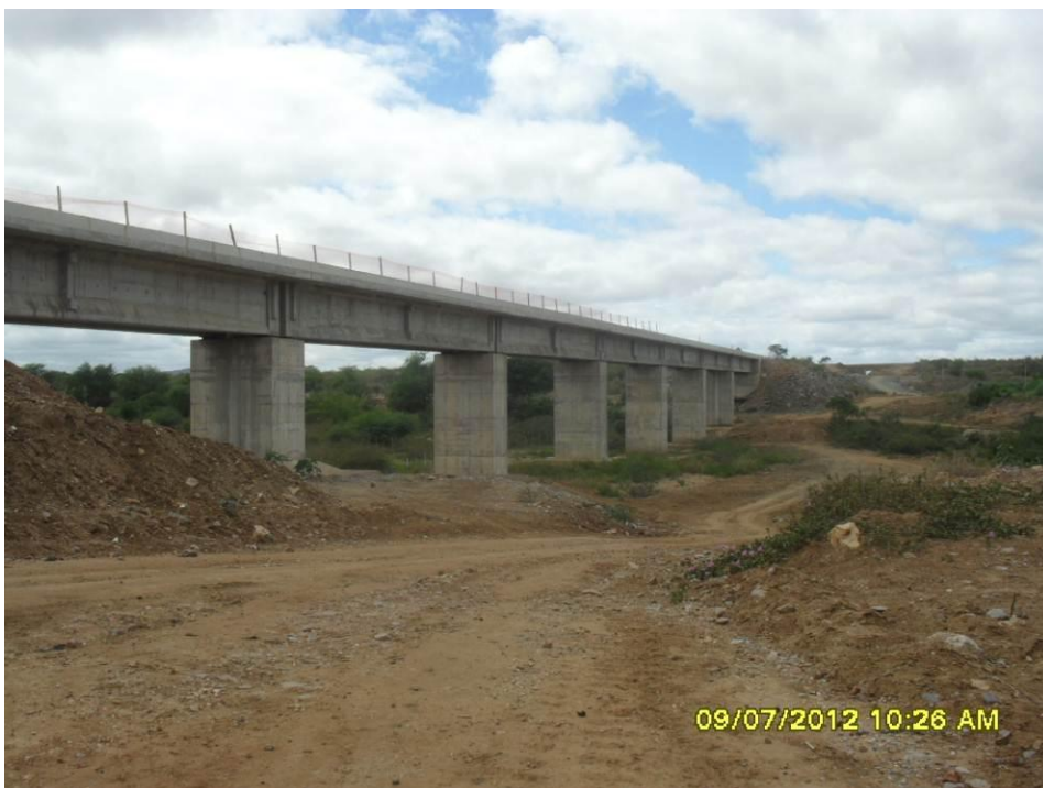
Foto 2-28 Ponte sobre o rio Pajeú.
