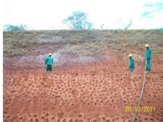
Foto 3-84 Hidrosemeadura no talude próximo a estaca 11572 – Lote 1.
