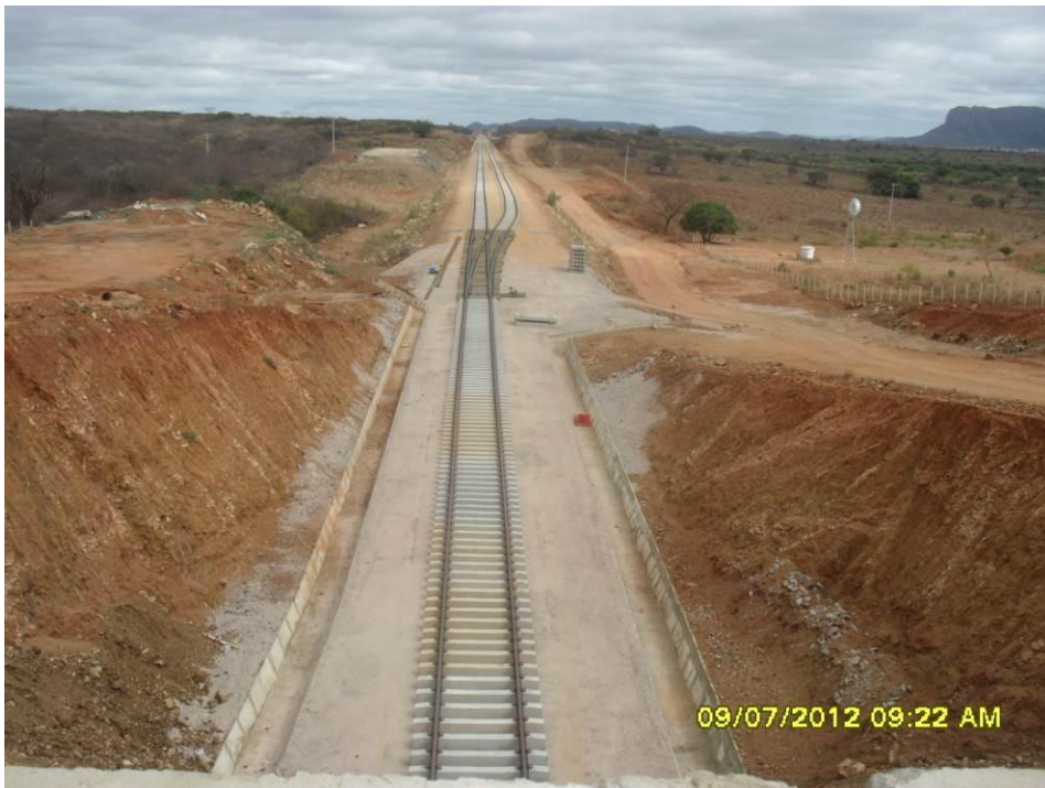
Foto 2-38 Superestrutura concluída, vista de cima do viaduto do corte 44 na estaca 22115.
