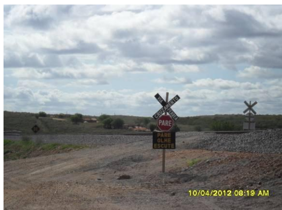
Foto 3-20 Sinalização de advertência localizada nos cruzamentos da linha férrea – Lote 1.
