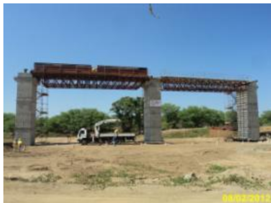
Foto 2-78 Construção de obra de arte especial.
