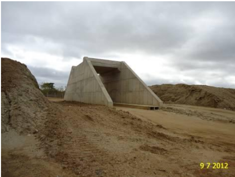
Foto 2-92 Passagem inferior restrita na estaca 41215 concluída.
