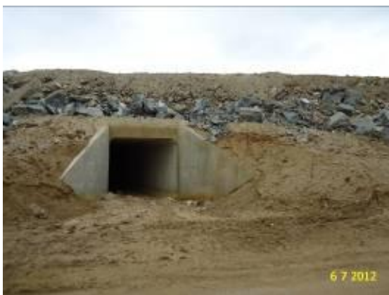
Foto 2-83 Bueiro simples celular de concreto (BSCC).
