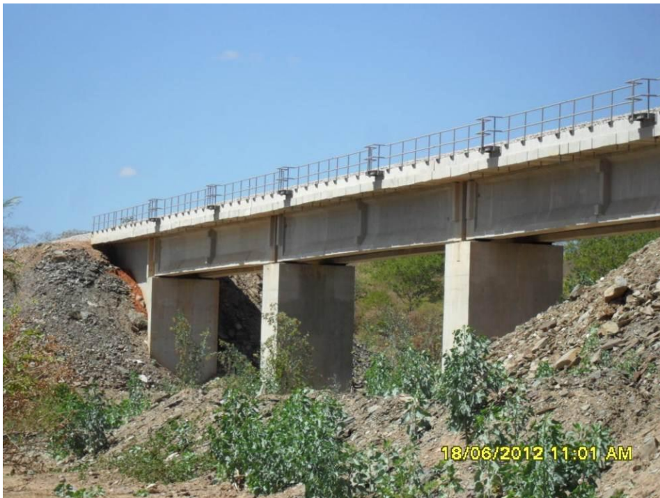
Foto 2-9 Ponte sobre o riacho São José.
