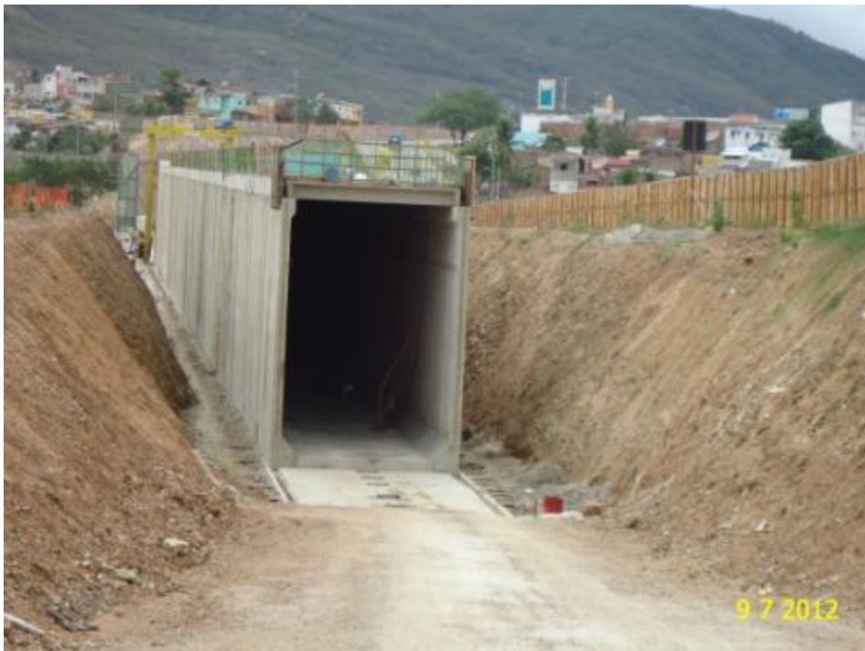
Foto 2-119 Túnel de Arcoverde em construção.
