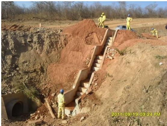
Foto 3-27 Construção de escada d'água na estaca 10.425 – Lote 1.
