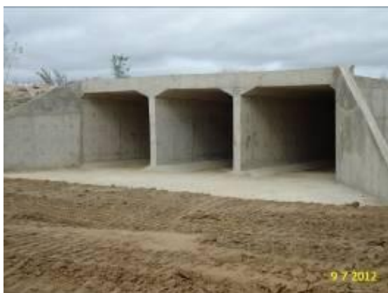
Foto 3-25 Bueiro triplo celular de concreto.
