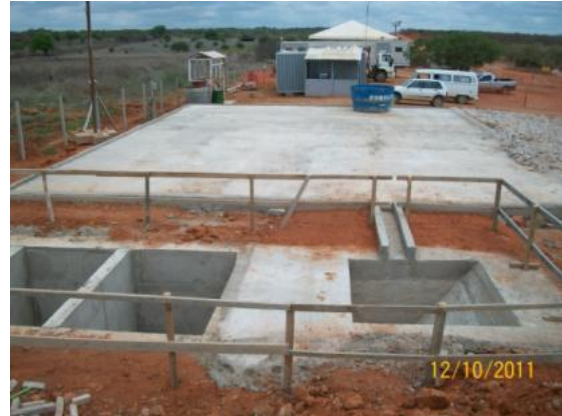
Foto 3-68 Construção de rampa de lavagem de caminhões. – Lote 1.
