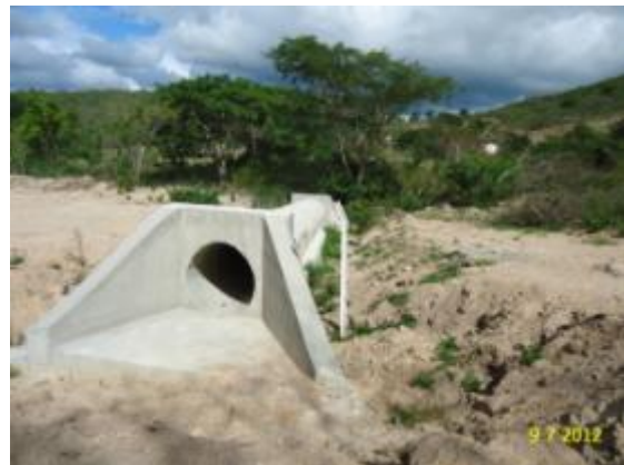
Foto 2-111 Bueiro simples tubular de concreto (BSTC).
