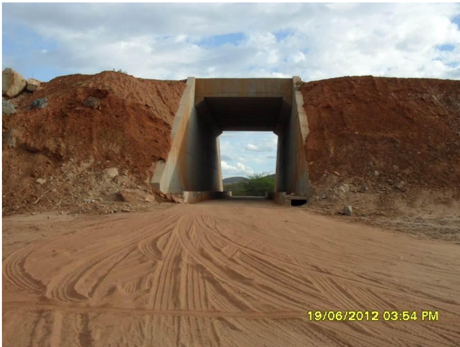
Foto 2-17 Passagem de nível inferior Sítio Boa Vista, estaca 13140.
