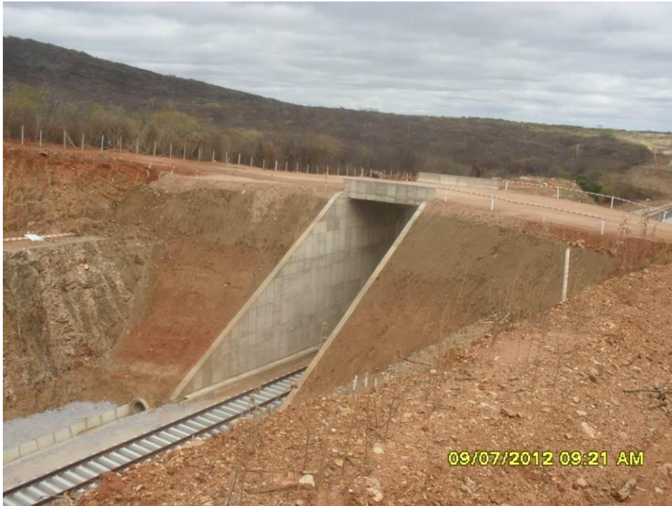
Foto 2-33 Viaduto sob estrada de acesso a comunidades lindeiras da ferrovia na estaca 22115.
