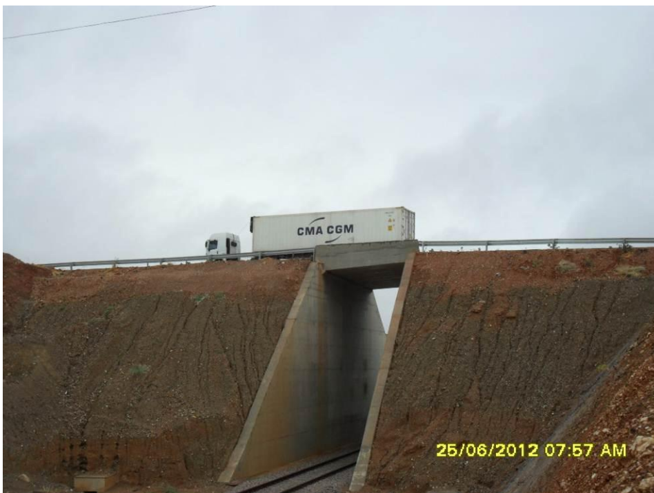
Foto 2-11 Viaduto sob a rodovia federal BR 116, Salgueiro.
