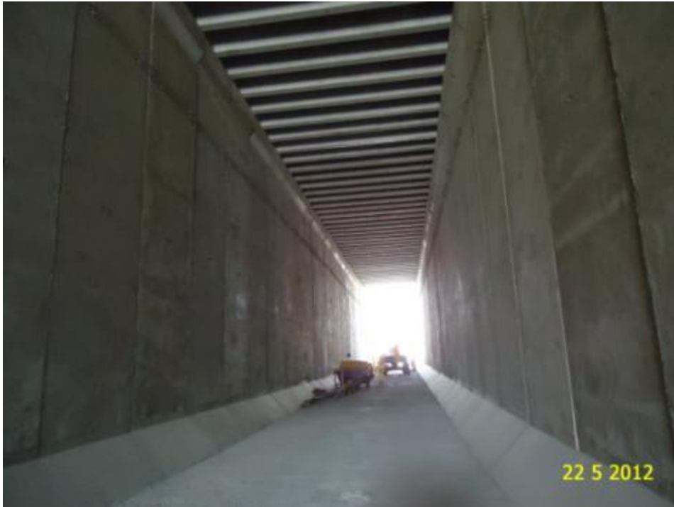
Foto 2-120 Visão interna do túnel de Arcoverde em construção.
