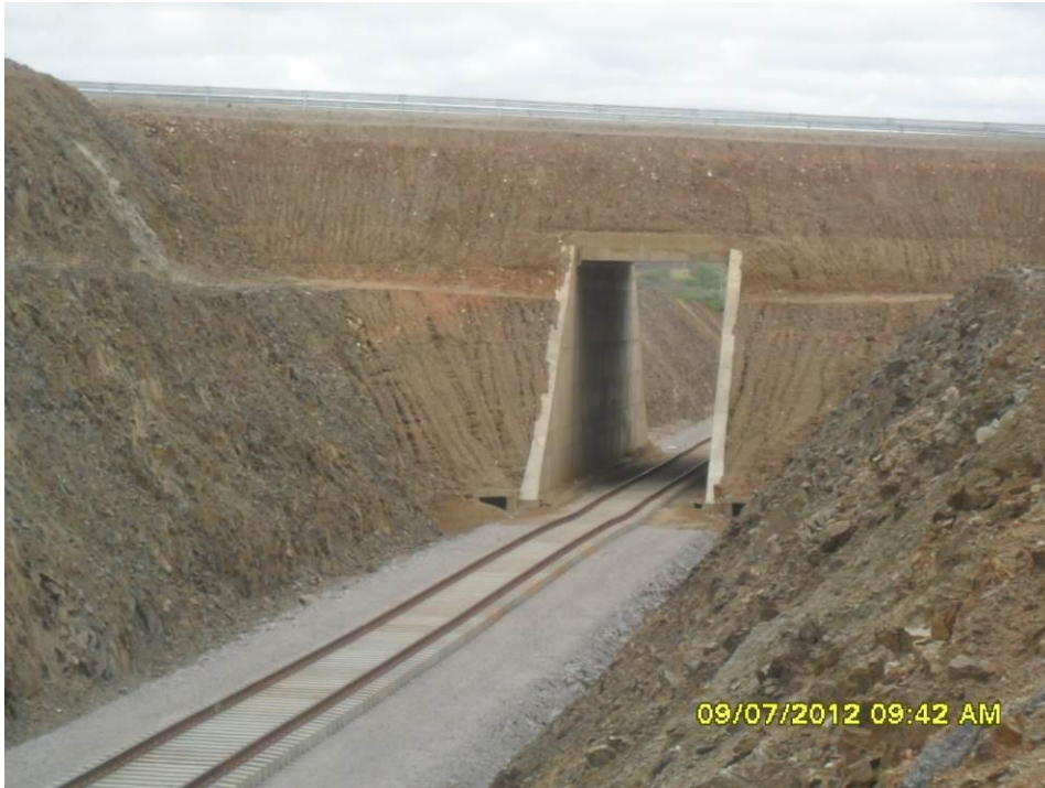
Foto 2-31 Viaduto da Caxixola.
