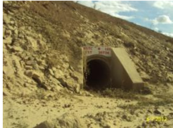
Foto 2-60 Bueiro simples tubular de concreto (BSTC).
