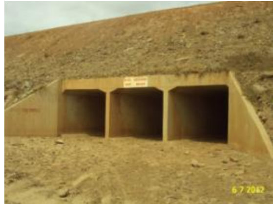
Foto 2-54 Bueiro triplo celular de concreto (BTCC).
