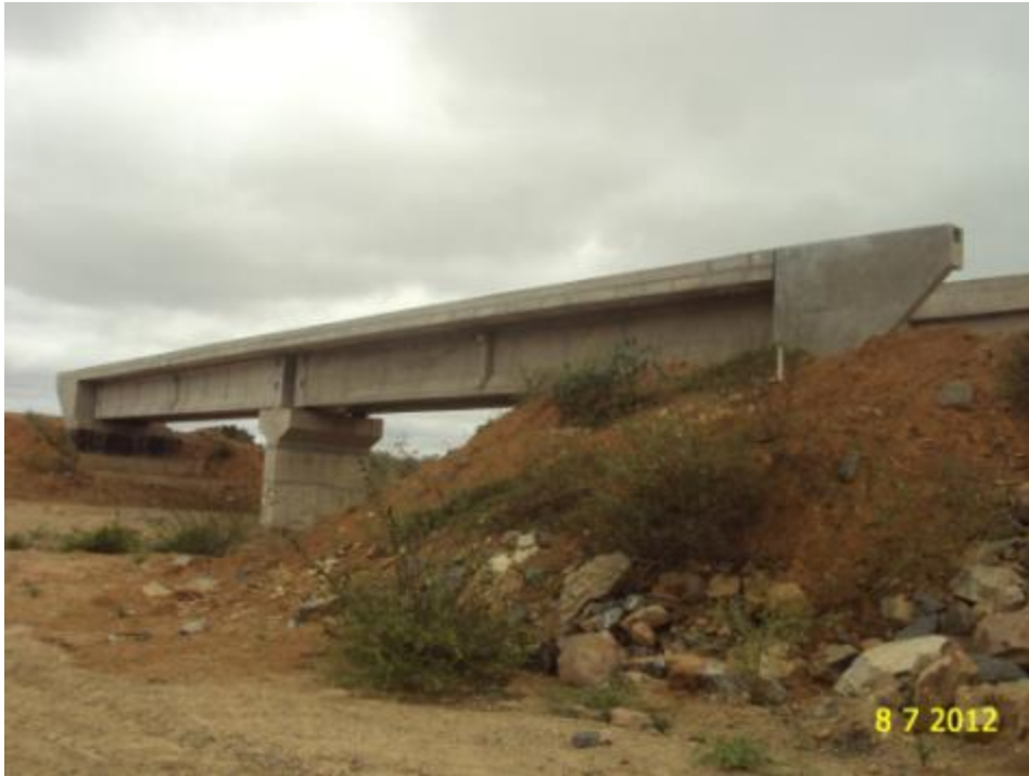
Foto 2-71 Ponte concluída sobre o riacho do Gado.
