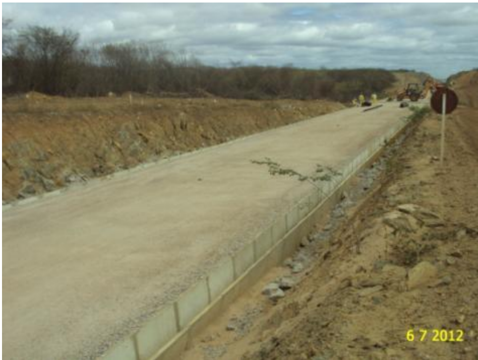
Foto 2-64 Instalação de canaletas para drenagem superficial do leito estradal.
