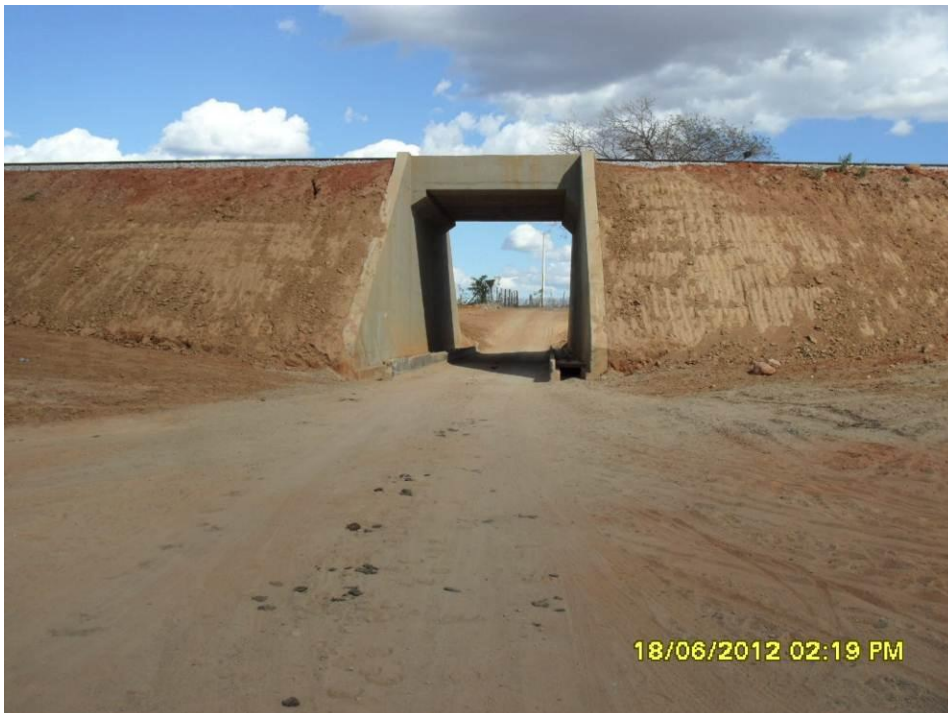
Foto 2-15 Passagem de nível inferior Sítio Posses I, estaca 11620.
