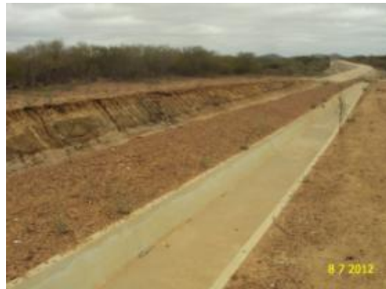
Foto 2-48 Valeta de proteção de corte (VPC).
