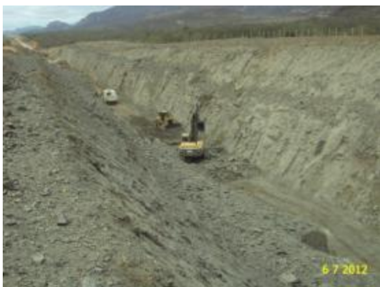
Foto 2-45 Escavação de corte (escavação de 3ª categoria).
