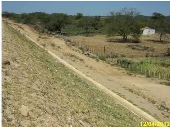
Foto 3-21 - Canaleta de drenagem construídas – Lote 3.
