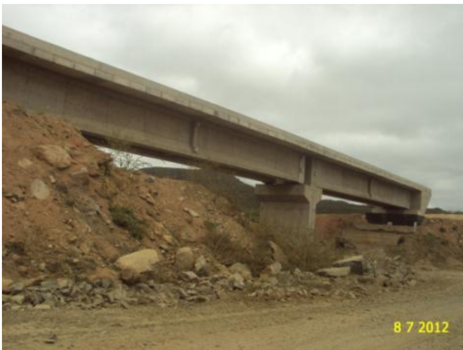
Foto 2-70 Ponte concluída sobre o rio Pitombeira.
