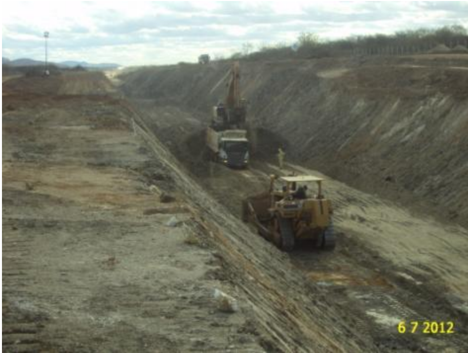
Foto 2-63 Reconformação das bermas.
