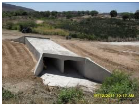
Foto 3-26 Drenagem finalizada no novo acesso para o município de Arcoverde na BR 232 – Lote 5.
