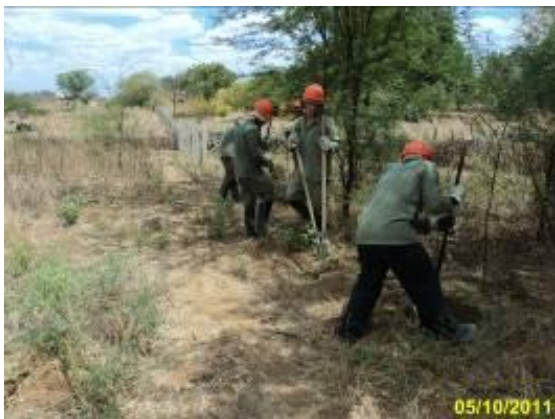
Foto 2-75 Instalação de cerca.
