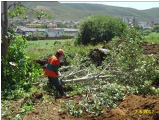
Foto 3-93 O material lenhoso com mais de 15 cm de diâmetro é suprimido com utilização de motosserra.
