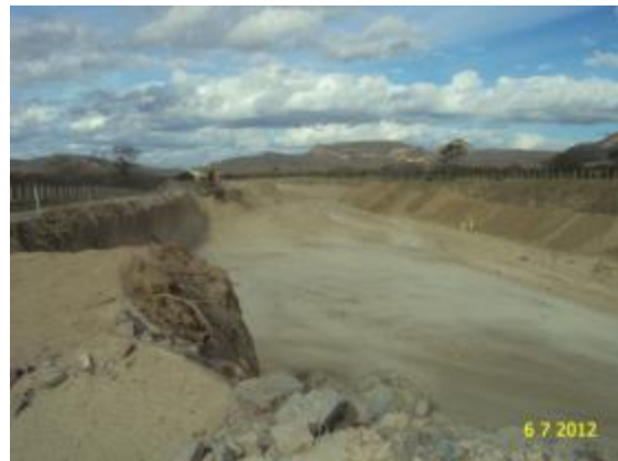
Foto 2-44 Escavação de área de empréstimo (escavação de 1ª e 2ª categoria).
