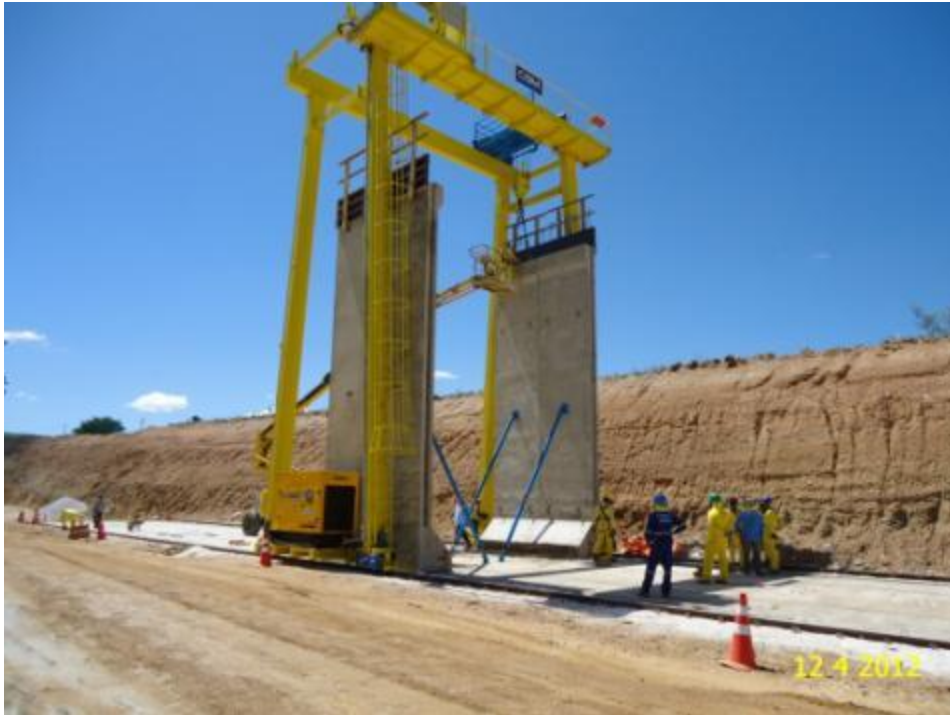
Foto 2-118 Primeiras placas de pré-moldadas instaladas na edificação do túnel.
