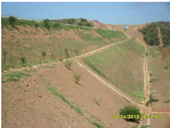
Foto 3-87 Taludes que já receberam a hidrossemeadura.
